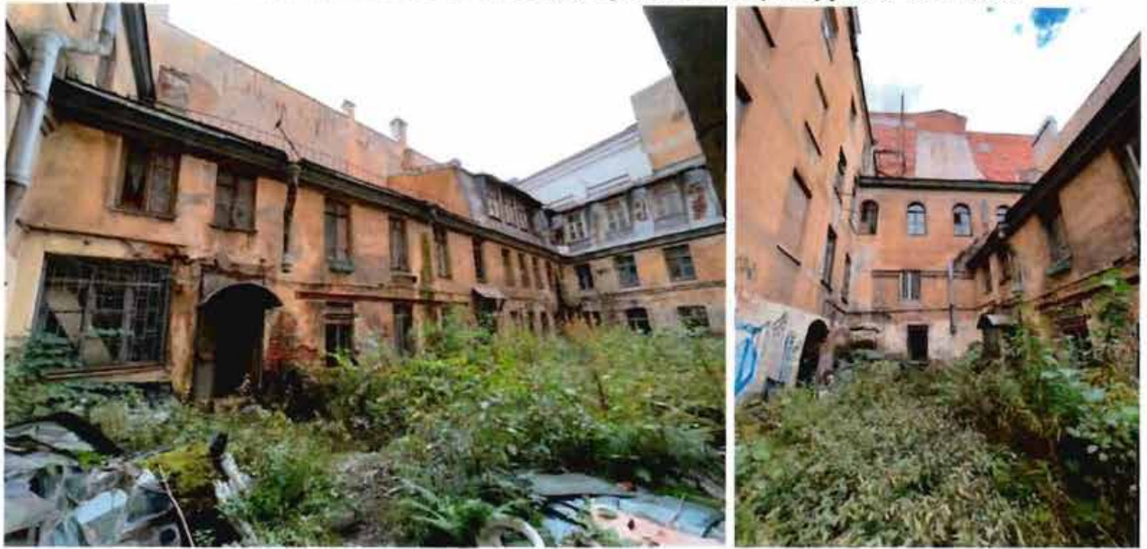
8, 9. Фасады флигеля хозяйственного (второго) двора объекта культурного наследия.
