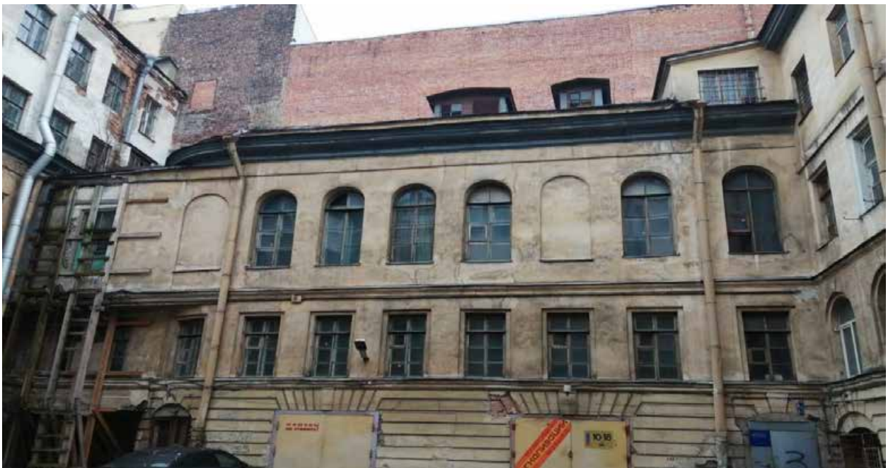
Фото 4. Объект культурного наследия регионального значения «Дом жилой И.Форша. Здесь в музыкальном салоне Ю.Ф.Абаза состоялось первое исполнение оперы П.И.Чайковского "Евгений Онегин"»: Санкт-Петербург, набережная реки Фонтанки, дом 23, литера А. Фасад южного продольного флигеля.
