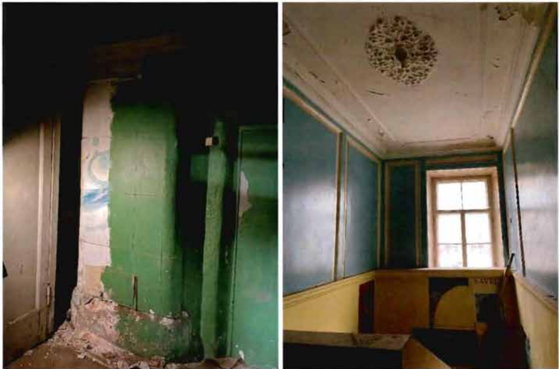
10, 11. Интерьер парадной лестницы Л-2 главного дома объекта культурного наследия по наб. реки Фонтанки.
