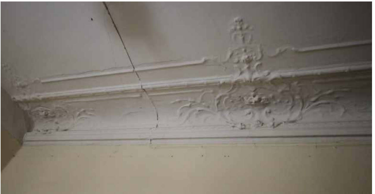
Фото 16. Объект культурного наследия регионального значения «Дом жилой И.Форша. Здесь в музыкальном салоне Ю.Ф.Абаза состоялось первое исполнение оперы П.И.Чайковского "Евгений Онегин"»: Санкт-Петербург, набережная реки Фонтанки, дом 23, литера А. Помещение 15Н. Исторический рисунок лепного декора в виде профилированной штукатурной рамы.
