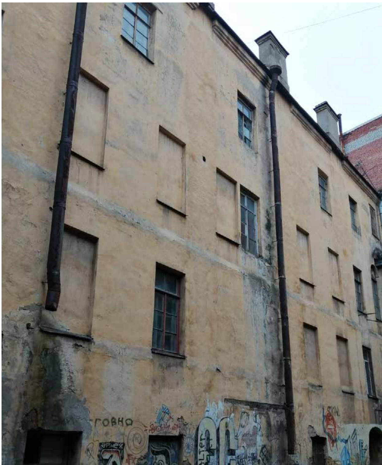
Фото 7. Объект культурного наследия регионального значения «Дом жилой И.Форша. Здесь в музыкальном салоне Ю.Ф.Абаза состоялось первое исполнение оперы П.И.Чайковского "Евгений Онегин"»: Санкт-Петербург, набережная реки Фонтанки, дом 23, литера А. Западный фасад поперечного флигеля.
