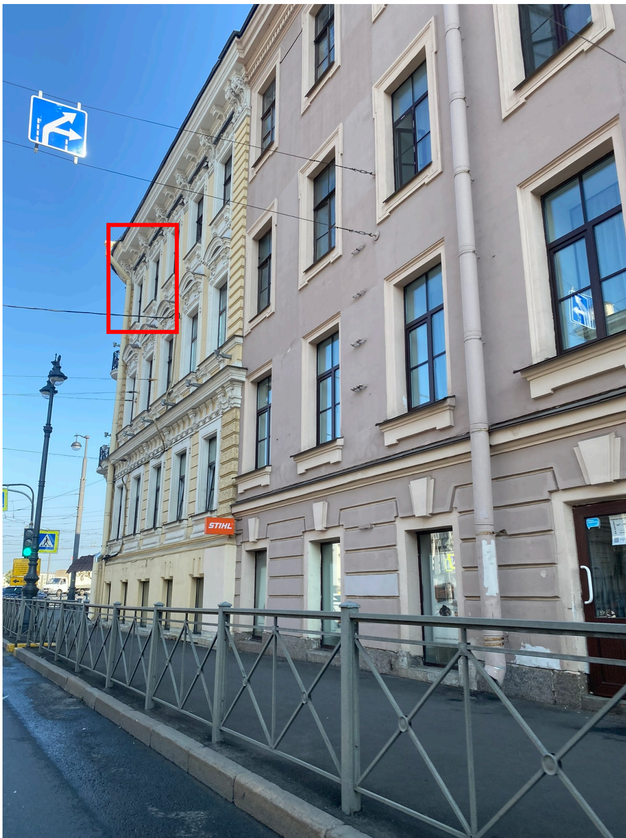
3. Вид на главный фасад здания с Кадетской линии. (Дата фотофиксации 16.06.2022 г.).
