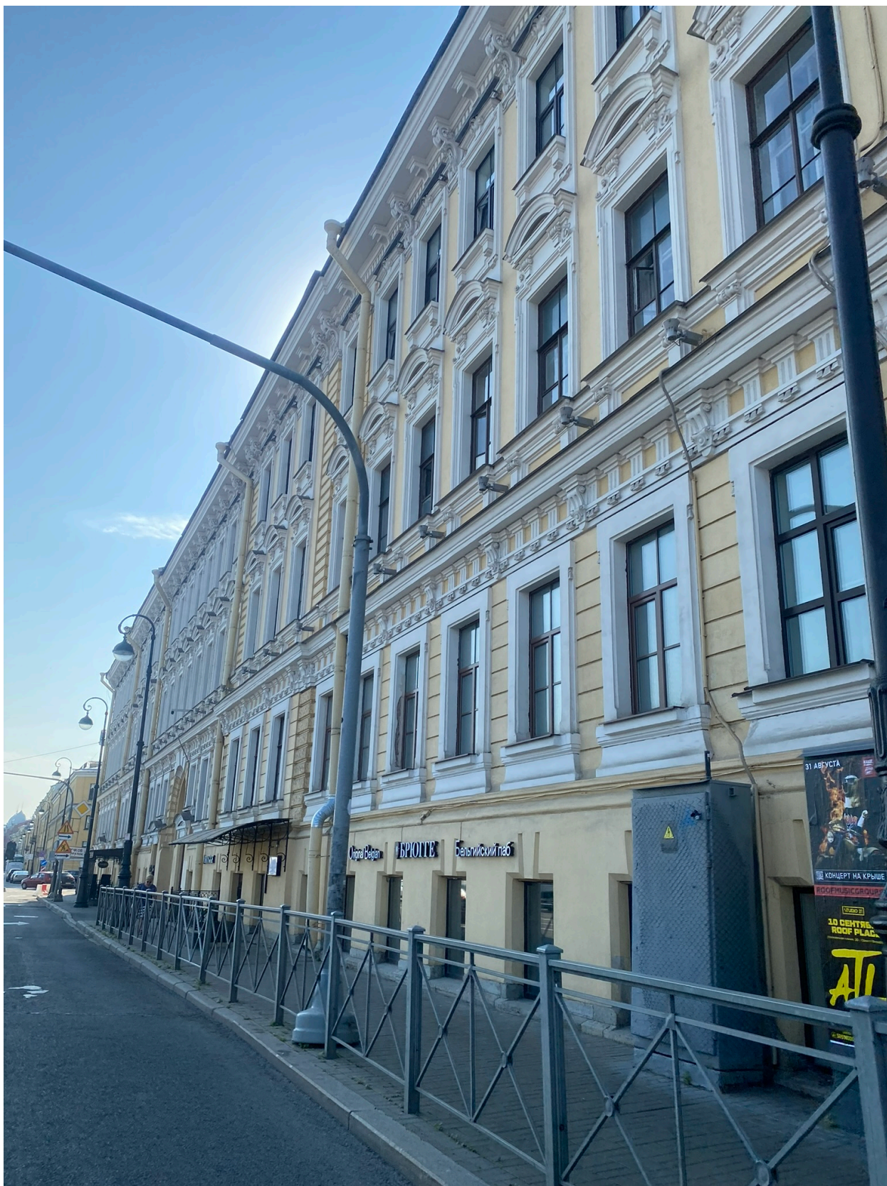
7. Вид на главный фасад здания с набережной Макарова; (Дата фотофиксации 16.06.2022 г.).
