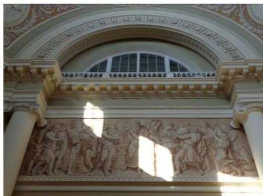
лепной раскрепованный антаблемент, опоясывающий зал, с профилированным архитравом, гладким фризом, профилированным карнизом с иониками и розетками, на модульонах;
