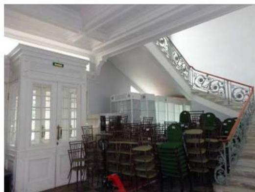
площадки второго этажа завершены профилированным карнизом значительного выноса на кронштейнах; потолки с высокой штукатурной падугой оформлены профилированными тягами;
