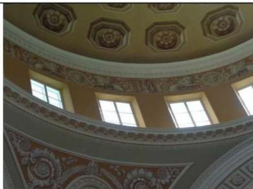
широкий лепной профилированный карниз с иониками и дентикулами, на модульонах - в основании светового барабана;
