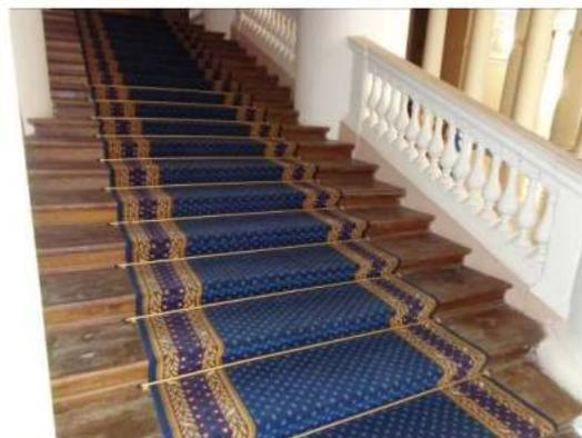
6. четыре деревянные лестницы, ведущие в «Думский зал» из помещений 1-Н(80) и 1-Н(118): расположены в юго-восточной и юго-западной частях центральной части здания: дубовые, в один марш, ограждение выполнено в виде резной балюстрады под профилированным поручнем;
