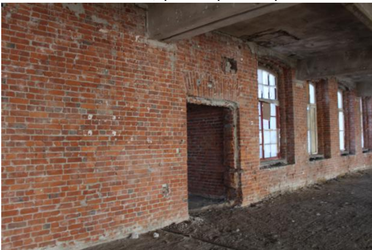
Фото 38. 5 этаж, вид на вход в помещение 6.
