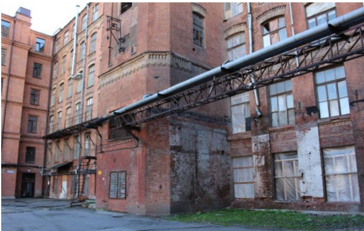
Фото 5. Вид на основание башни с северо-востока.
