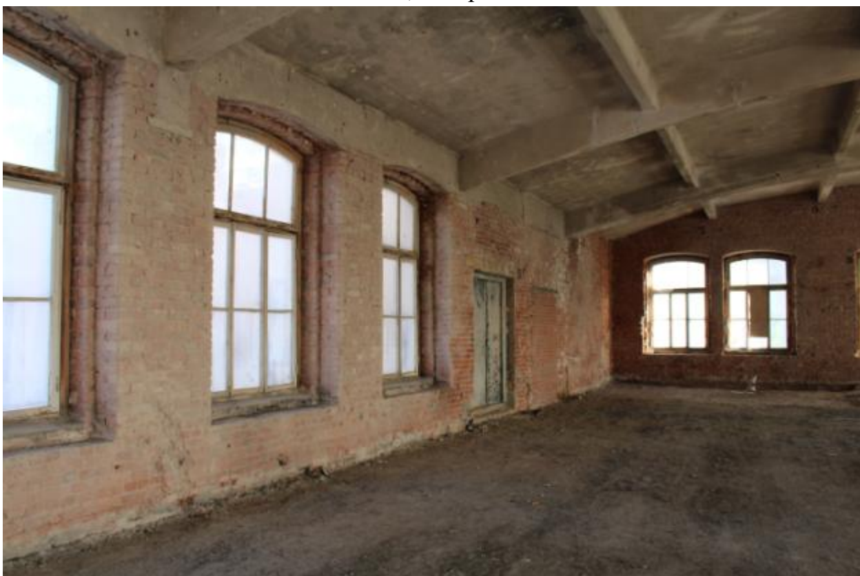
Фото 48. 6 этаж, юго-восточная часть.
