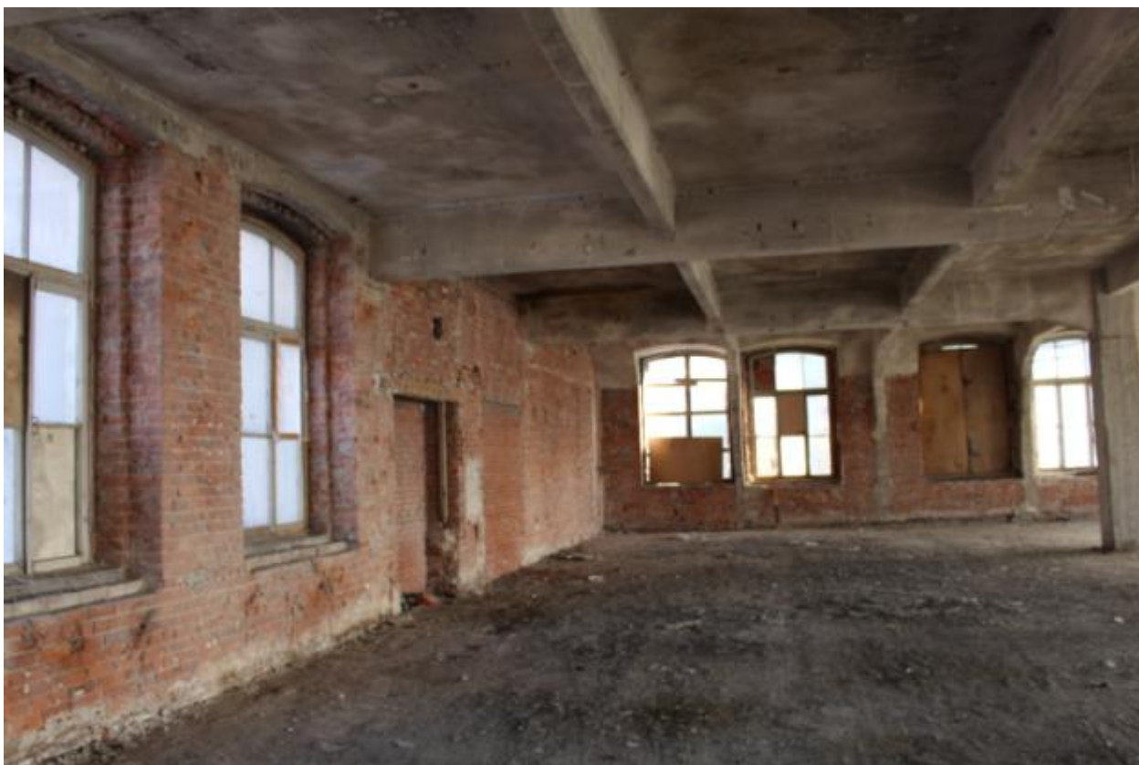
Фото 41. 5 этаж, юго-восточная часть.
