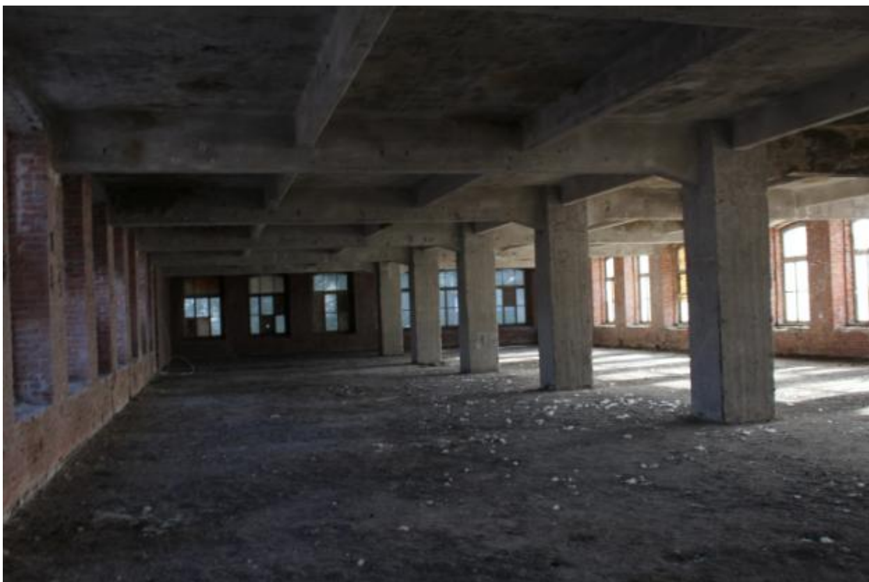
Фото 23. 3 этаж, вид на юг
