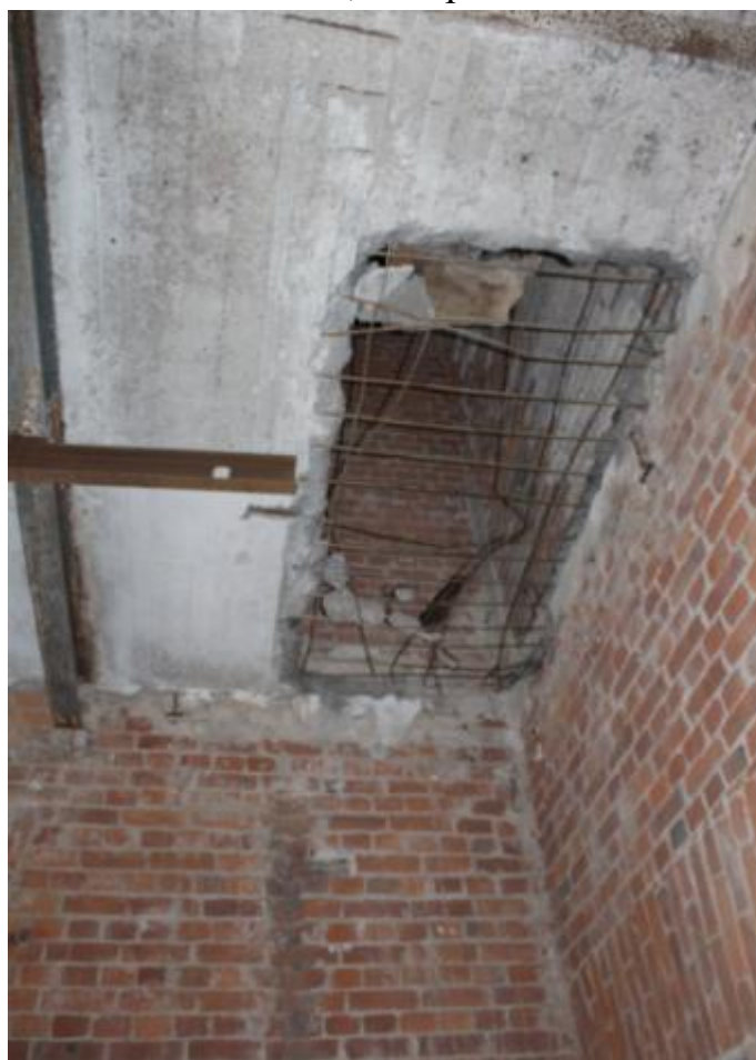
Фото 14. 2 этаж, фрагмент перекрытия.
