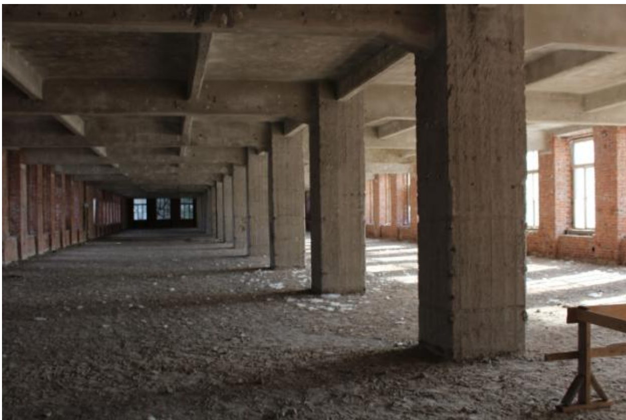
Фото 11. 2 этаж, общий вид.
