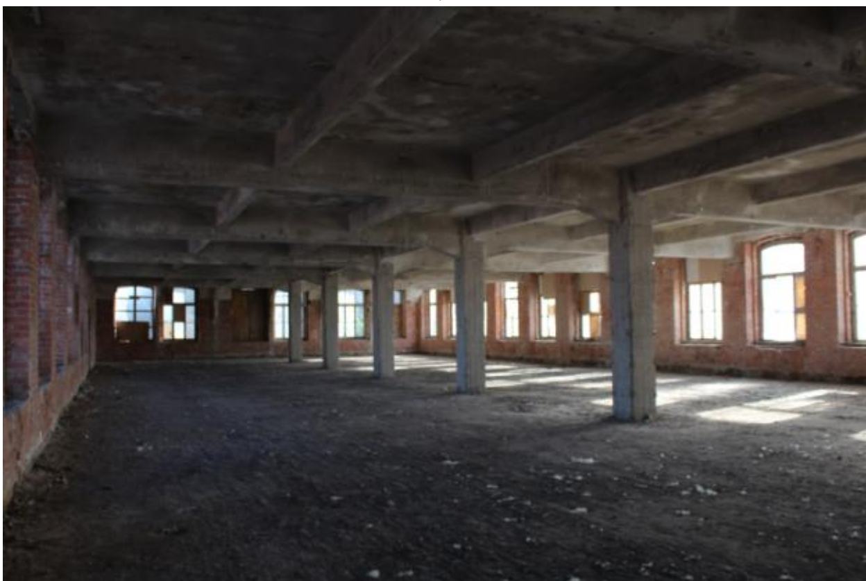
Фото 40. 5 этаж, вид на юг.
