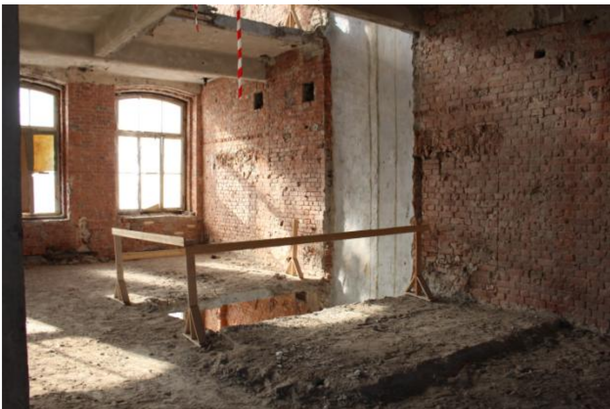
Фото 36. 5 этаж, вид на северную лифтовую шахту.
