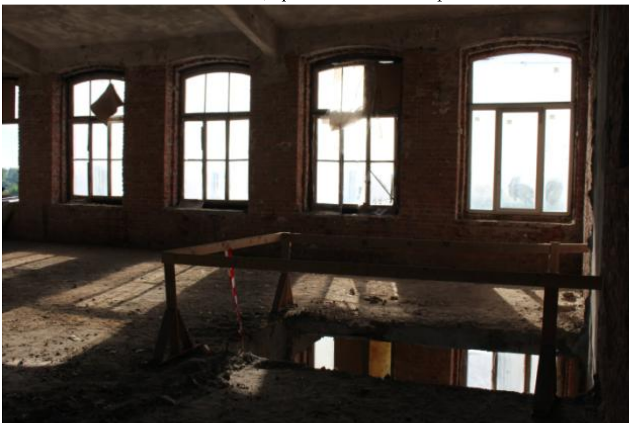
Фото 46. 6 этаж, лифтовой проем.
