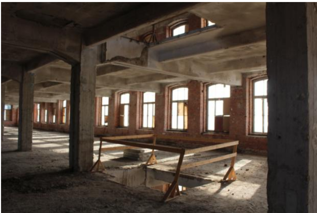
Фото 37. 5 этаж, проемы центрального лифта.
