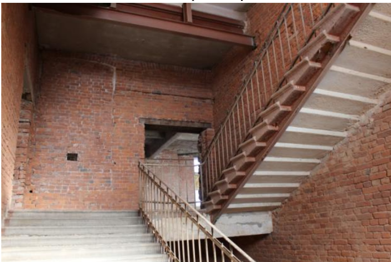
Фото 34. Лестница на 5 этаж.
