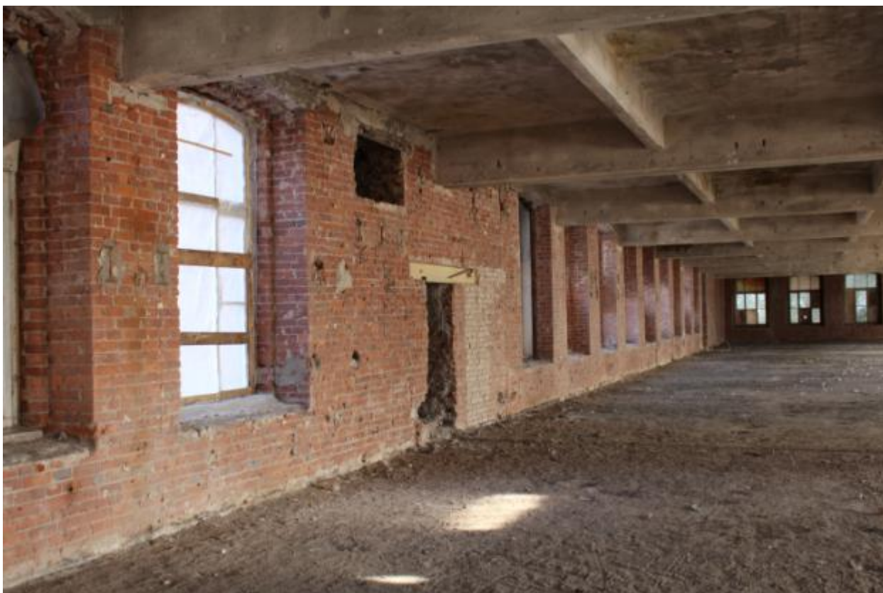
Фото 21. 3 этаж, восточная стена.
