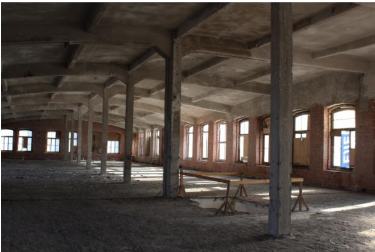
Фото 47. 6 этаж, центральная часть.
