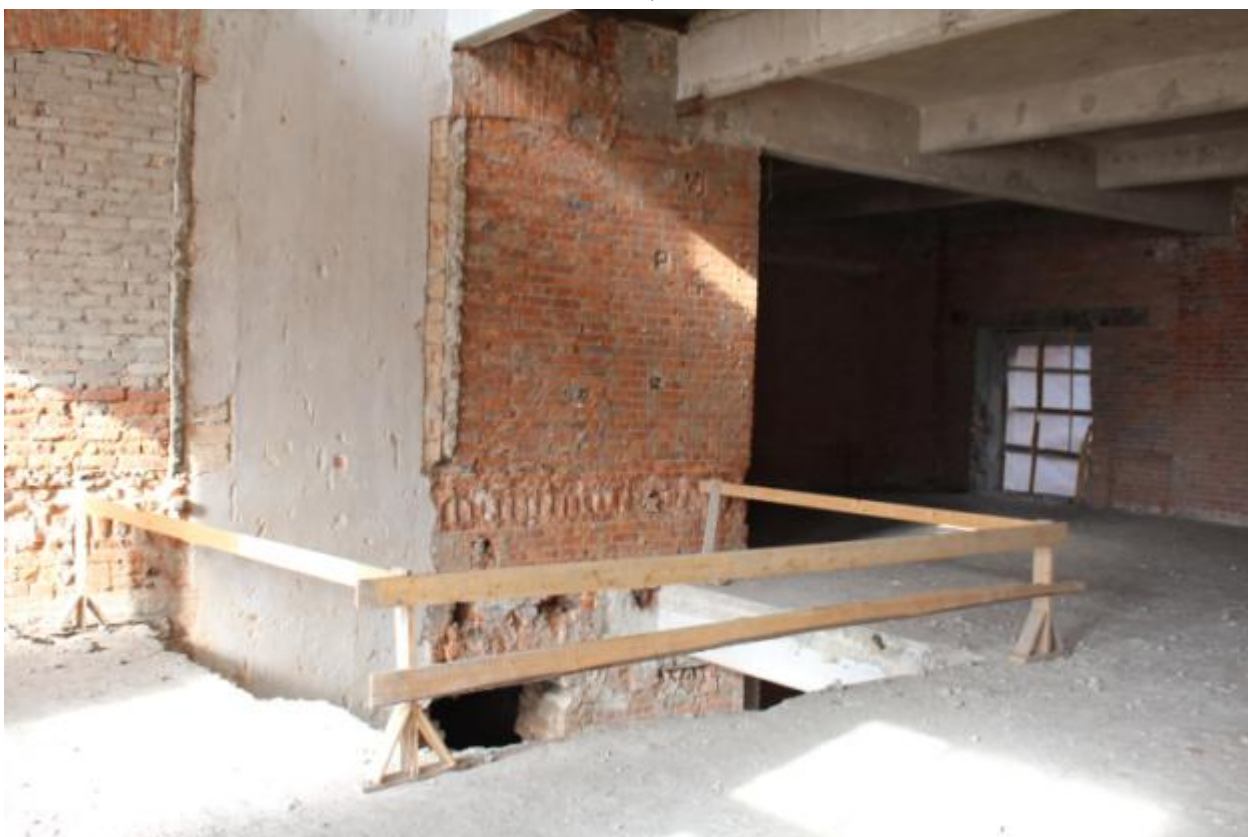
Фото 12. 2 этаж, проем лифтовой шахты.
