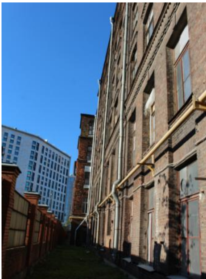
Фото 11. Вид вдоль западного фасада.
