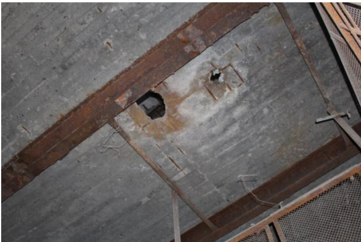
Фото 3. Перекрытие в помещении 1, 1 этаж.
