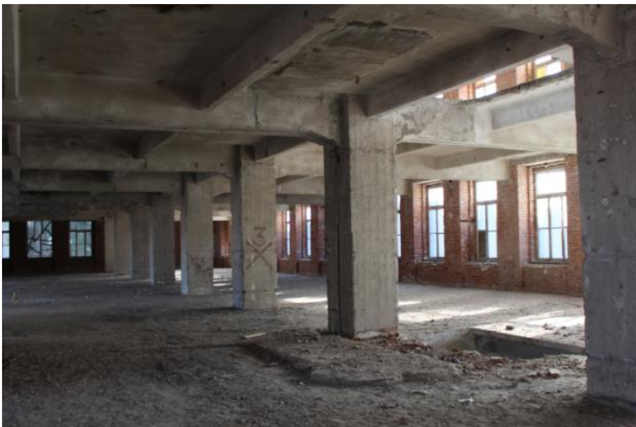
Фото 13. 2 этаж, центральная часть.
