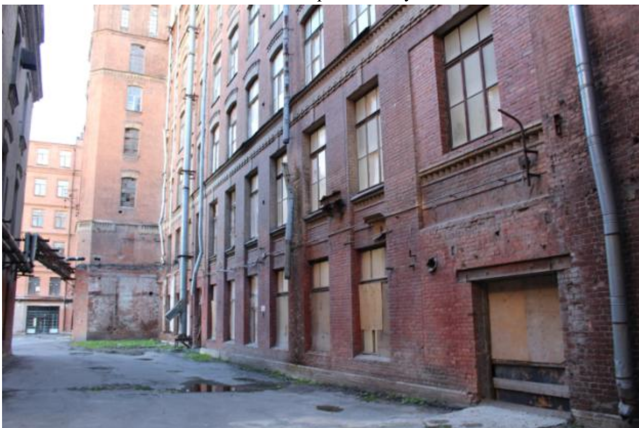
Фото 8. Фрагмент восточного фасада.
