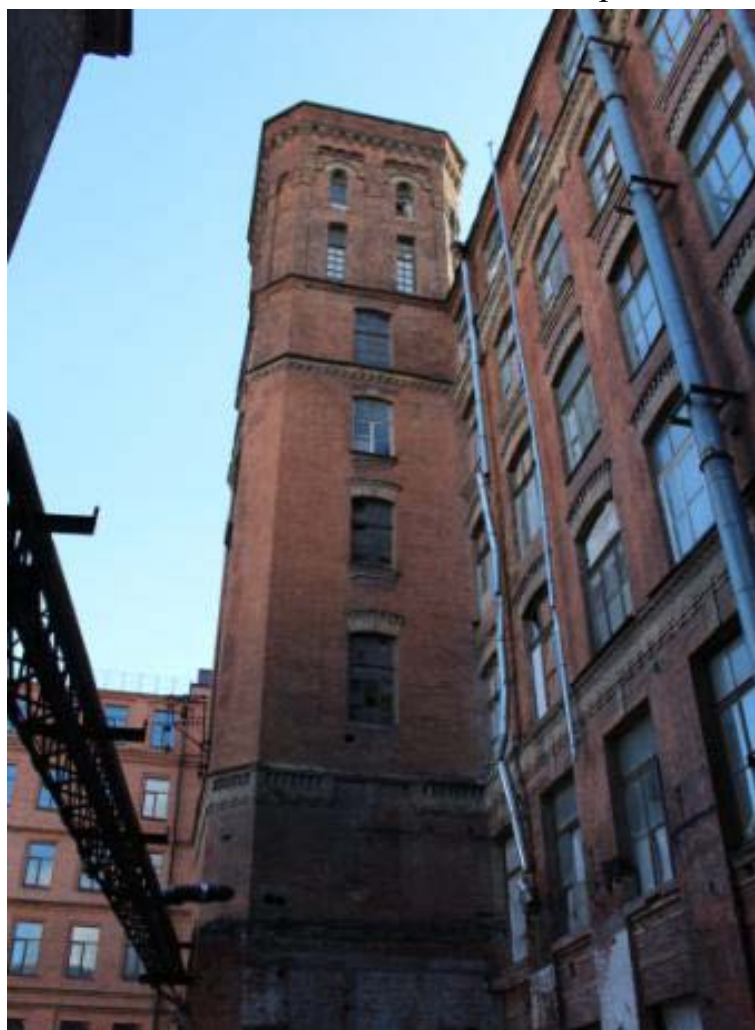
Фото 6. Вид северного фасада башни.
