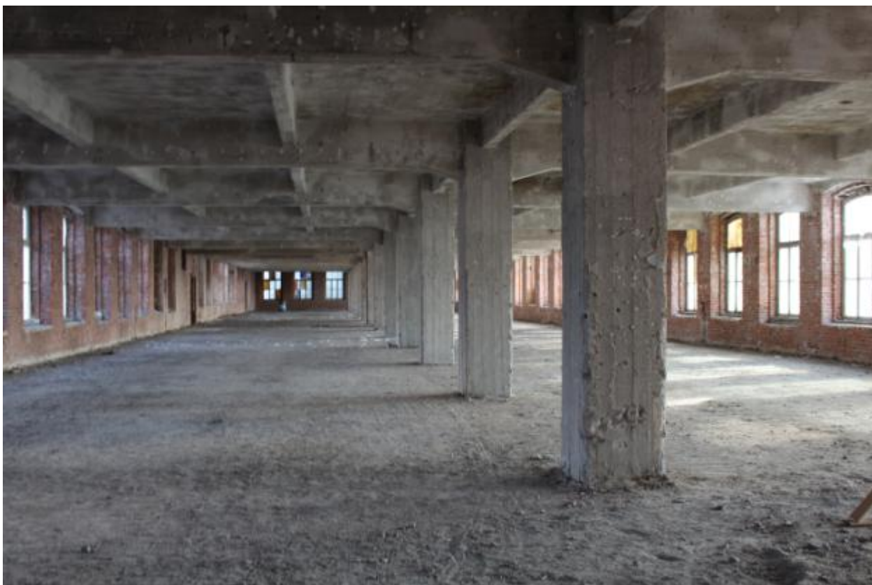
Фото 27. 4 этаж, общий вид.
