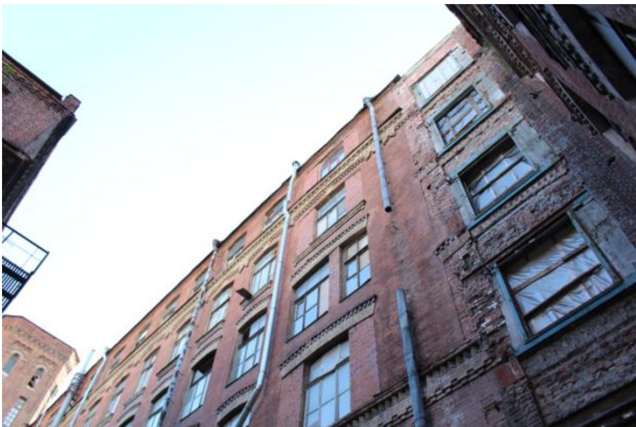
Фото 9. Фрагмент северной части восточного фасада.
