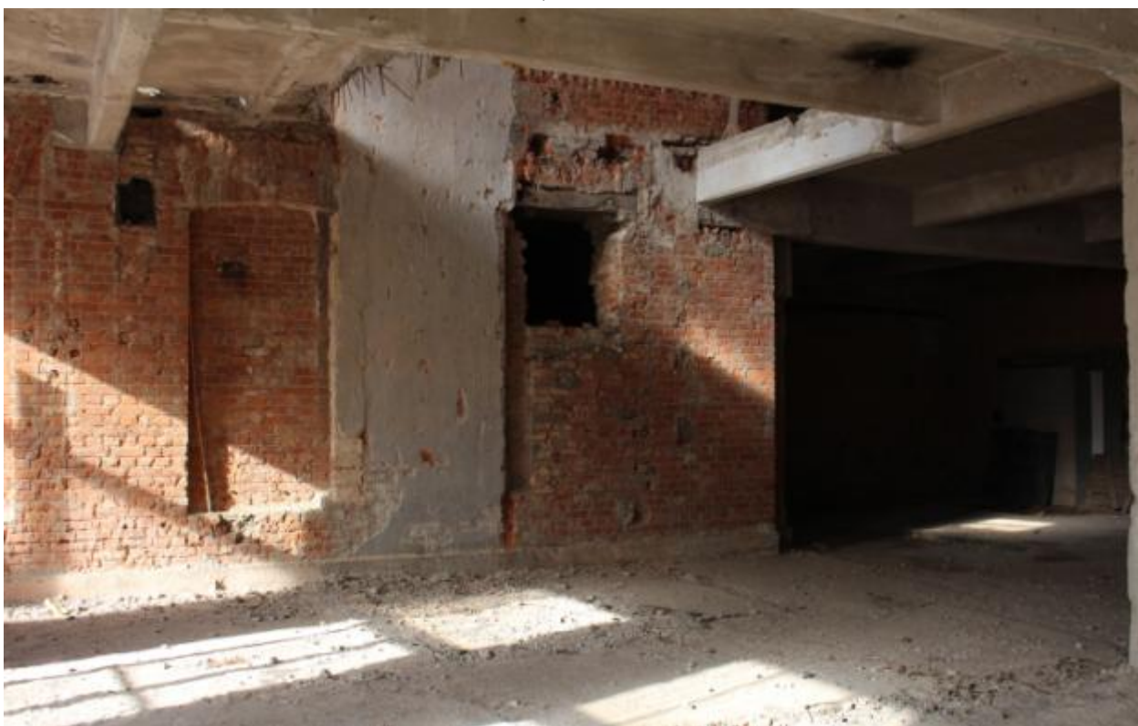
Фото 8. 1 этаж, стена лестничной клетки.
