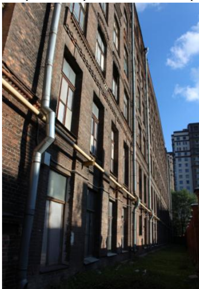
Фото 10. Вид на западный фасад с севера.
