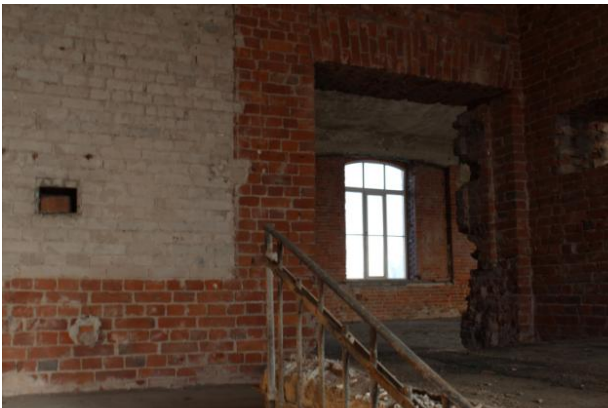
Фото 43. Лестничная площадка 6 этажа.
