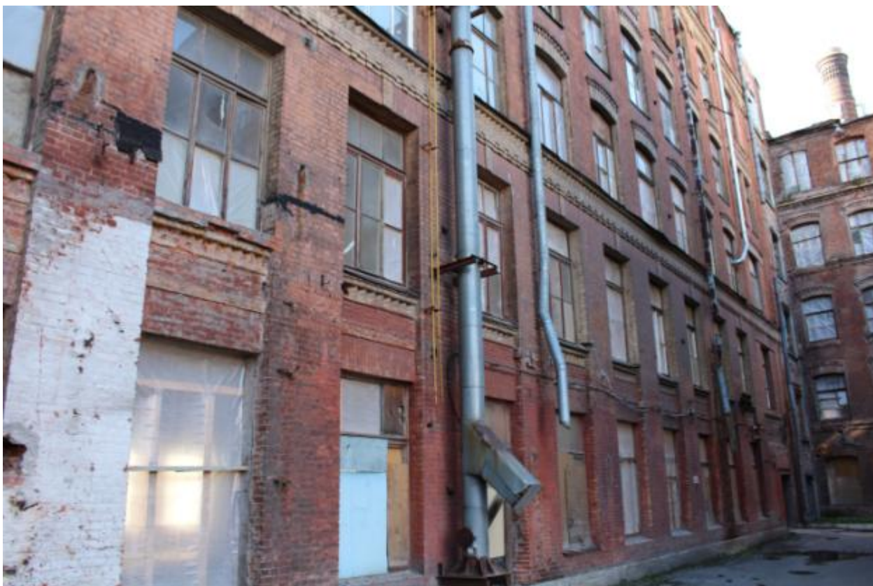
Фото 7. Вид на северо-восточную часть.
