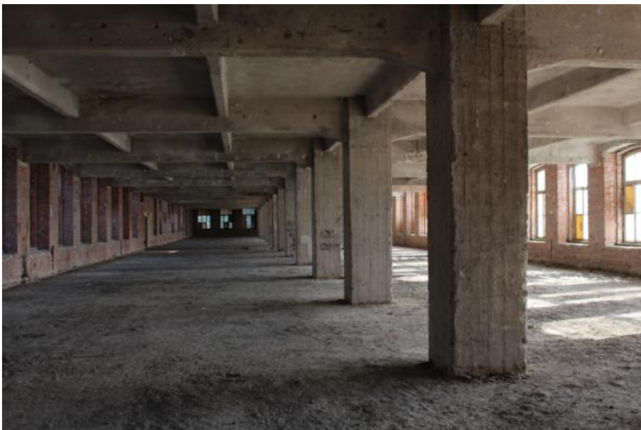
Фото 20. 3 этаж, общий вид.
