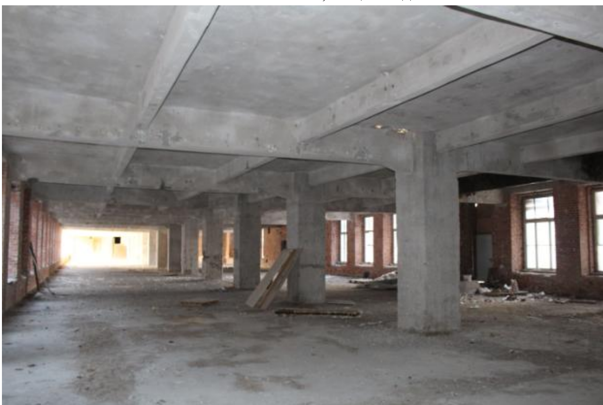
Фото 6. 1 этаж, вид на север.
