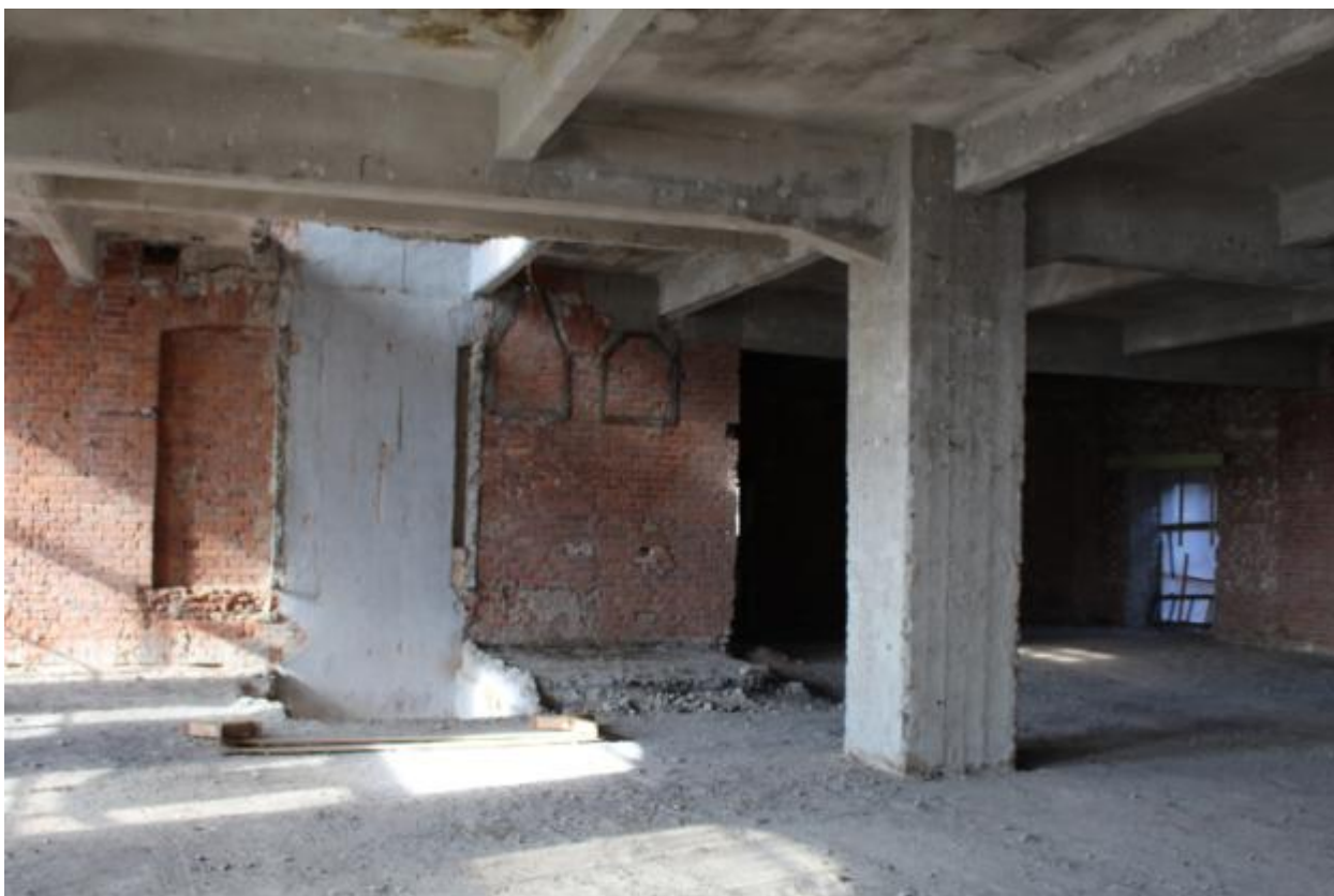
Фото 25. 3 этаж, стена лестничной клетки.
