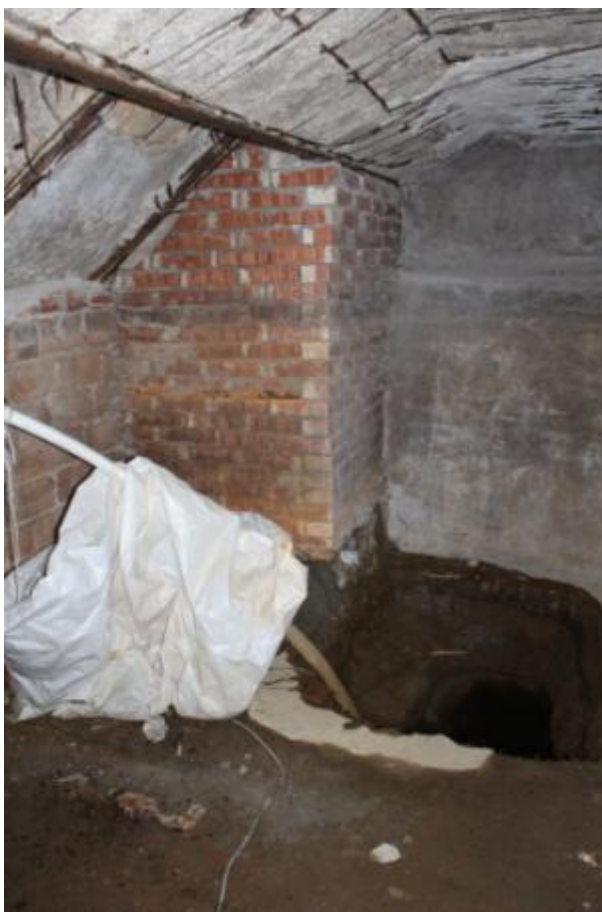
Фото 1. Подвал, помещение у лестницы.
