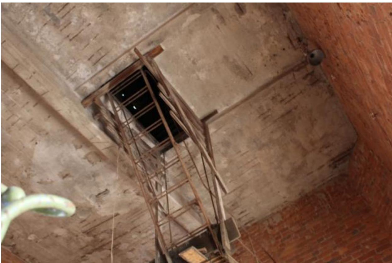
Фото 57. Перекрытие 2 уровня мезонина.
