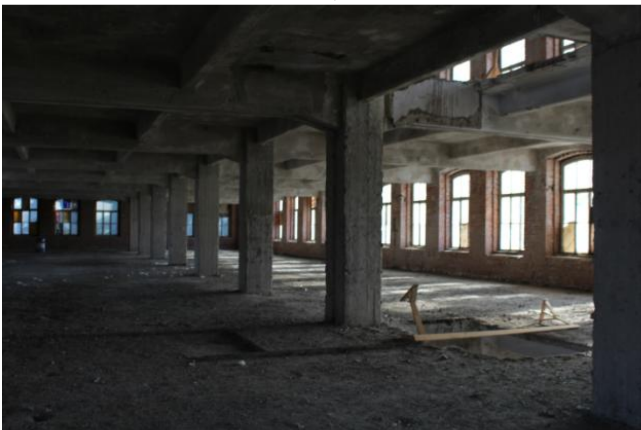
Фото 28. 4 этаж, общий вид центральной части.
