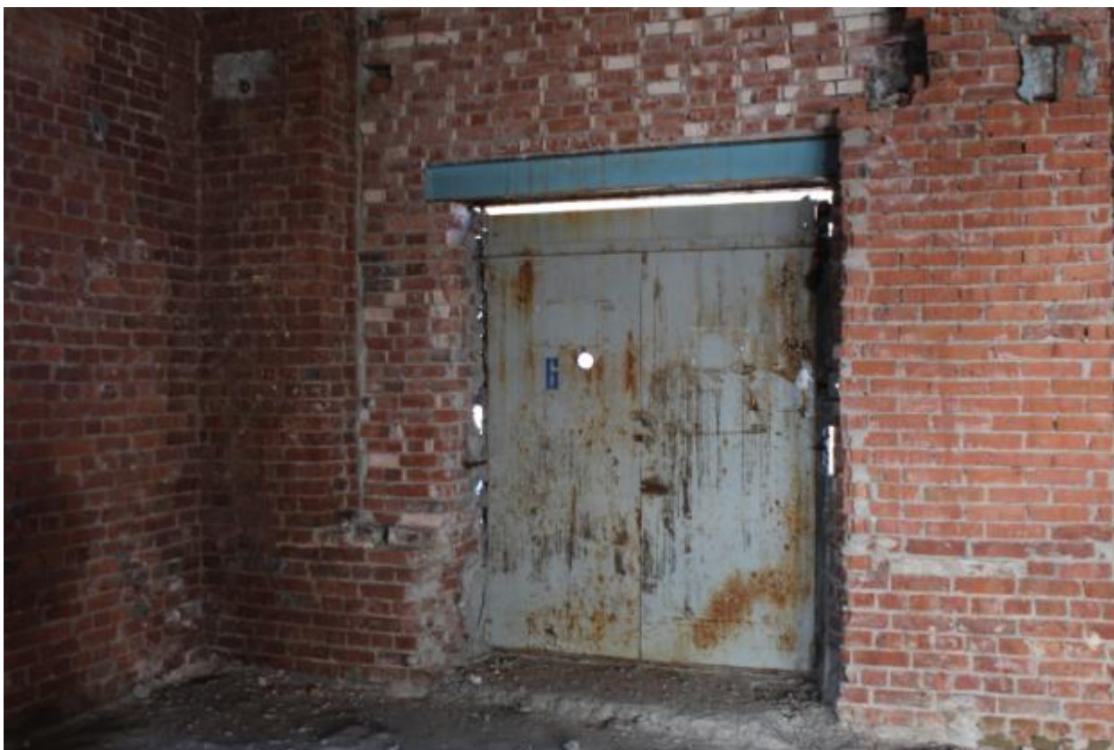
Фото 45. 6 этаж, проем на восточном фасаде.
