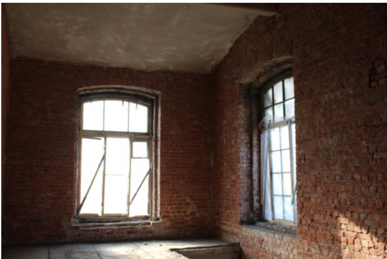
Фото 44. 6 этаж, площадка в лестничной клетке.
