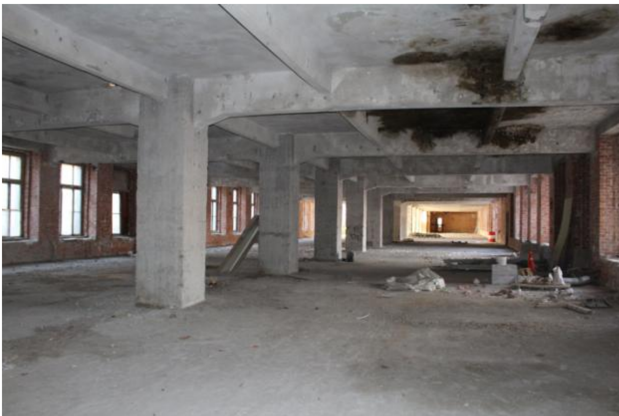
Фото 5. 1 этаж, общий вид.
