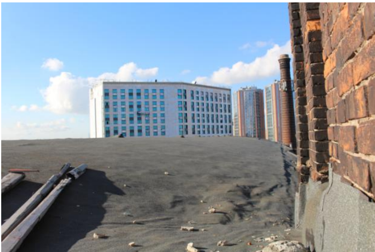
Фото 55. Вид кровли на север.
