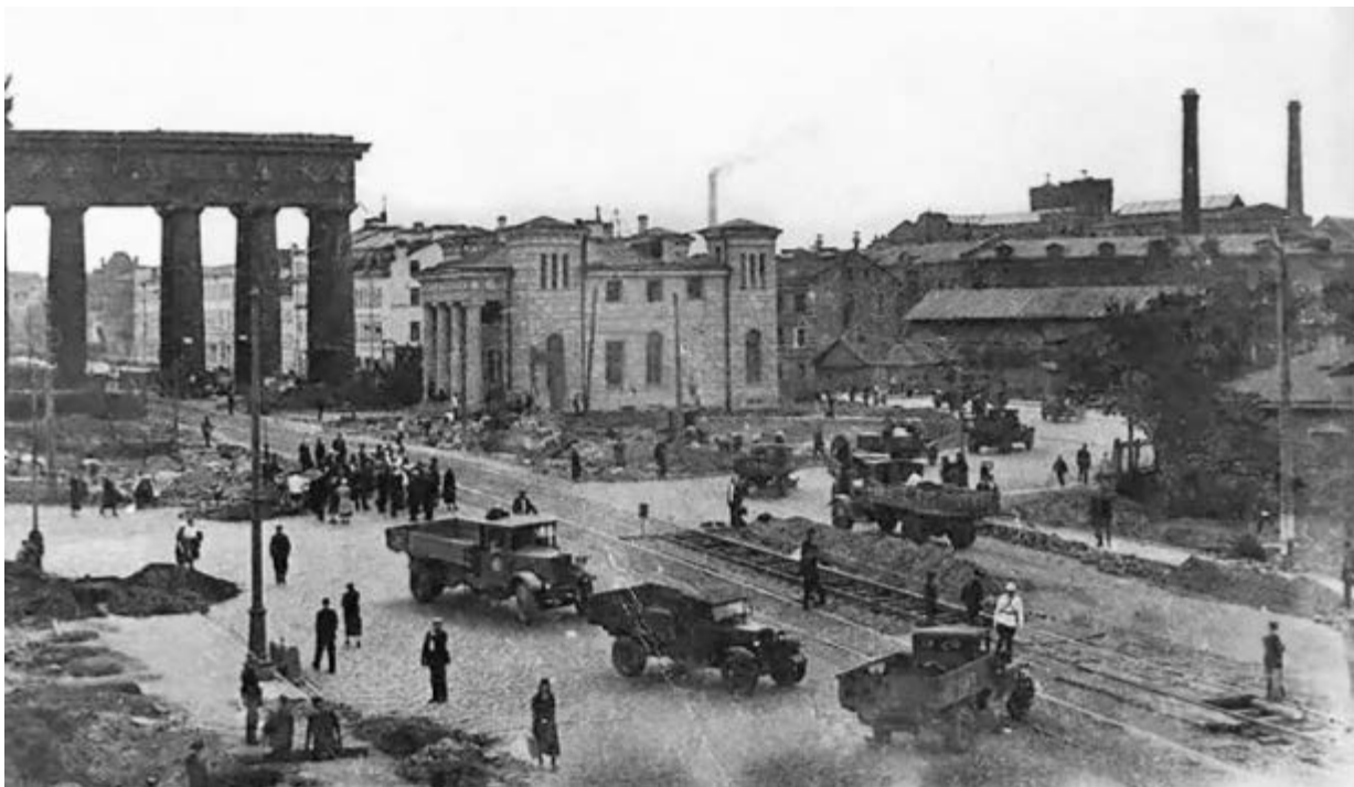
Илл. 86. Ремонтные работы у Московских триумфальных ворот на Международном проспекте. 1930-е гг. ЦГАКФФД СПб. Фотодокумент Ар 153338.
