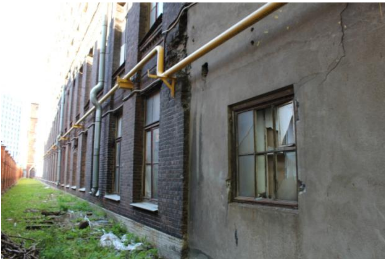
Фото 15. Вид с юга, западный фасад.
