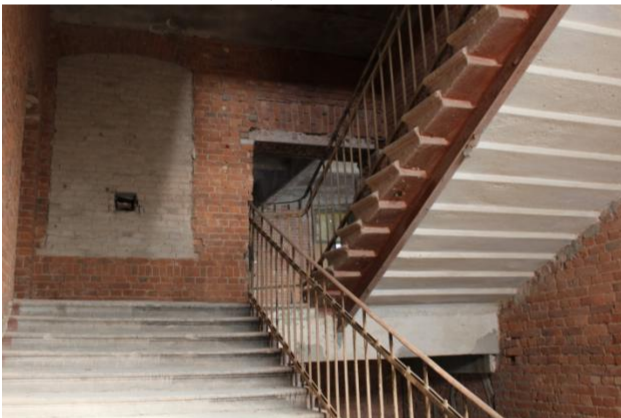
Фото 26. Лестница на 4 этаж.
