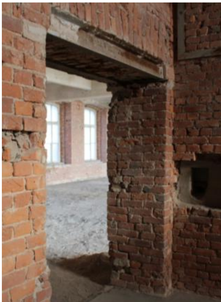
Фото 19. Вход на 3 этаж с лестницы.
