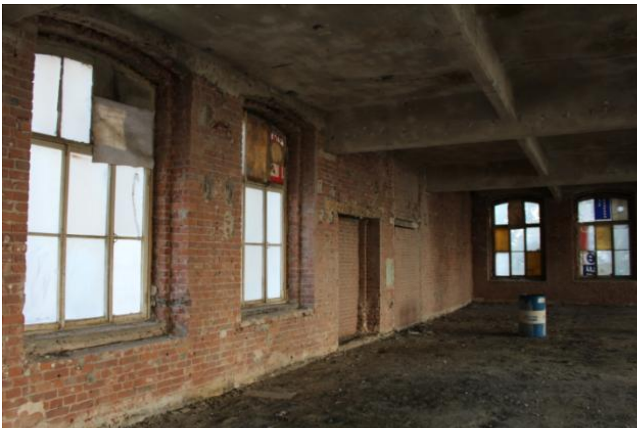
Фото 31. 5 этаж, вид на юго-восток.
