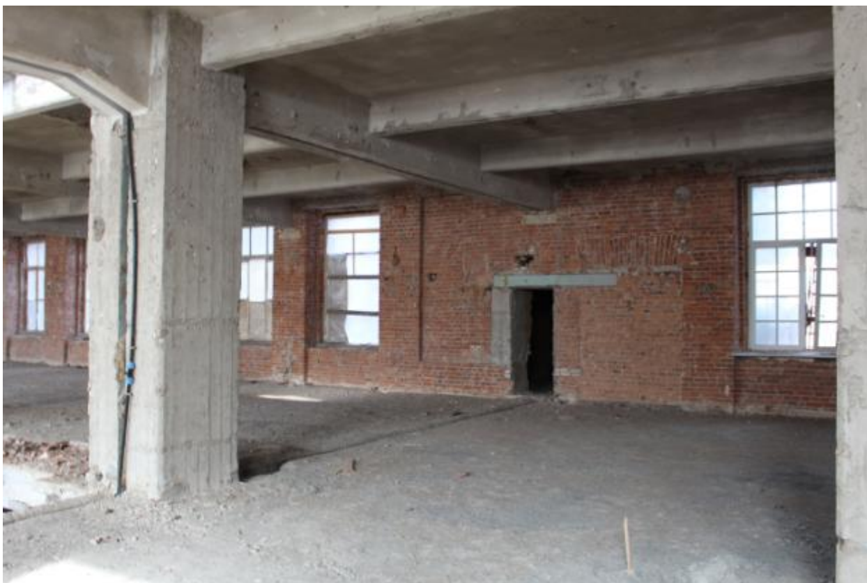
Фото 17. 2 этаж, центральная часть восточной стены.
