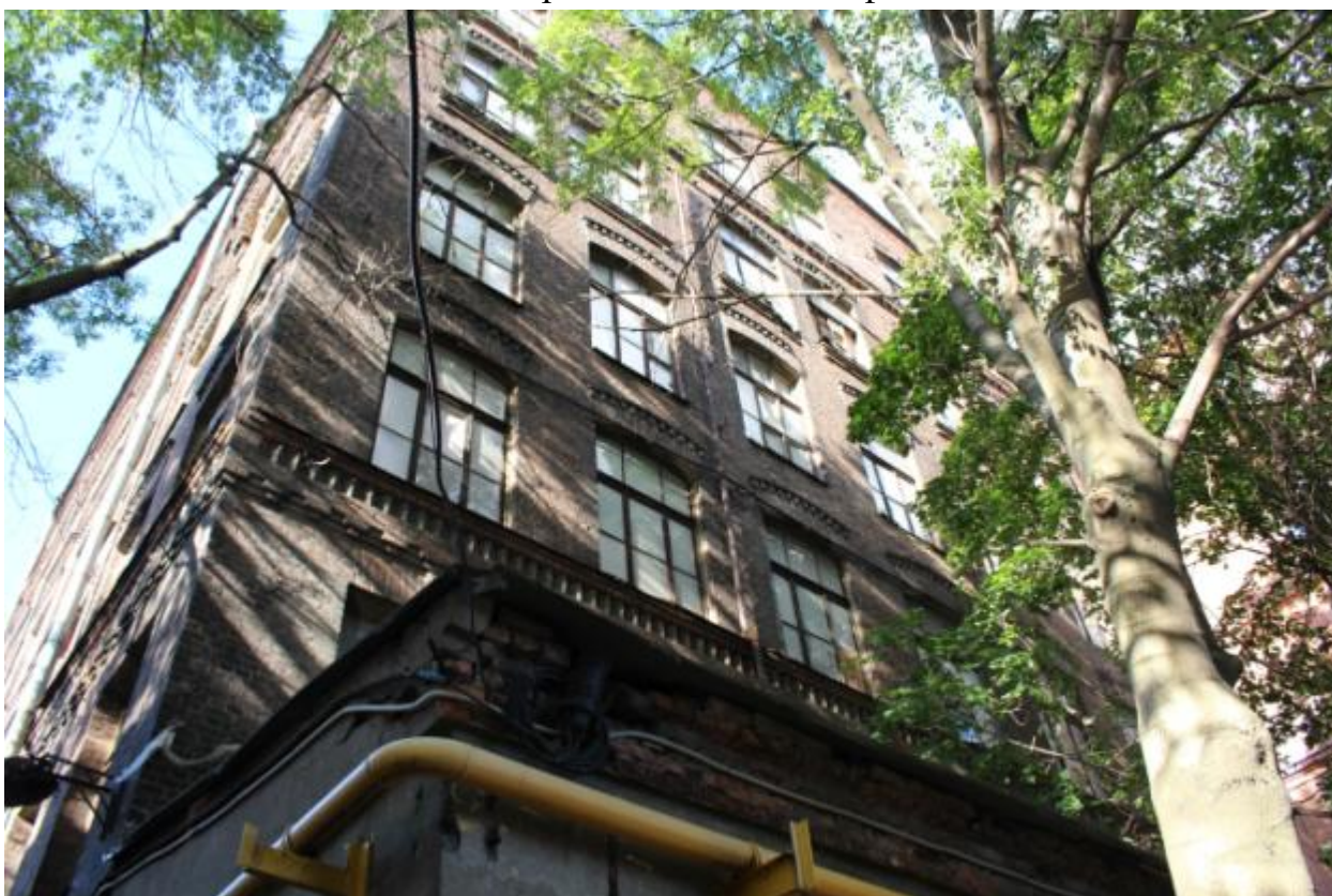
Фото 14. Вид с юго-запада, южный фасад.
