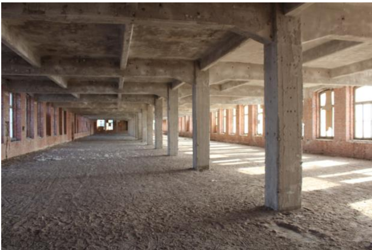
Фото 35. 5 этаж, общий вид.
