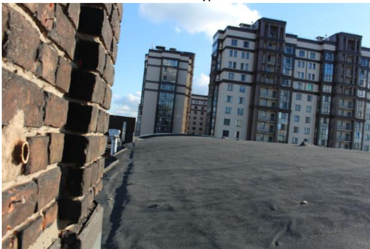
Фото 54. Вид кровли на юг.
