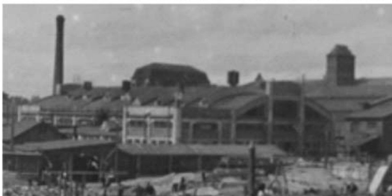
Ил. 20 Вид строительства на территории Ленинградского механического завода им. Карла Маркса, 1930 г. ЦГАКФФД СПб., Гр 84306
