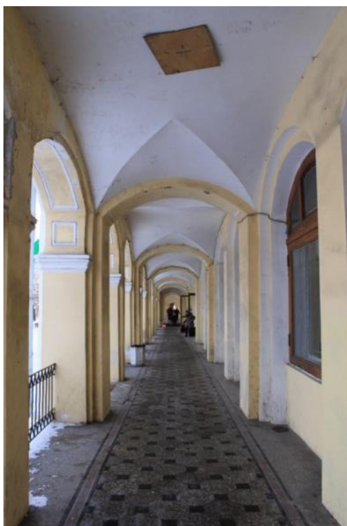
Фото 59. Объект культурного наследия федерального значения «Гостиный двор», по адресу: Санкт-Петербург, г. Пушкин, Московская ул., д. 25; Оранжерейная ул.; Леонтьевская ул. Вид вдоль открытой галереи Гостиного двора со стороны Московской улицы. Дата: 01.12.2021г.
