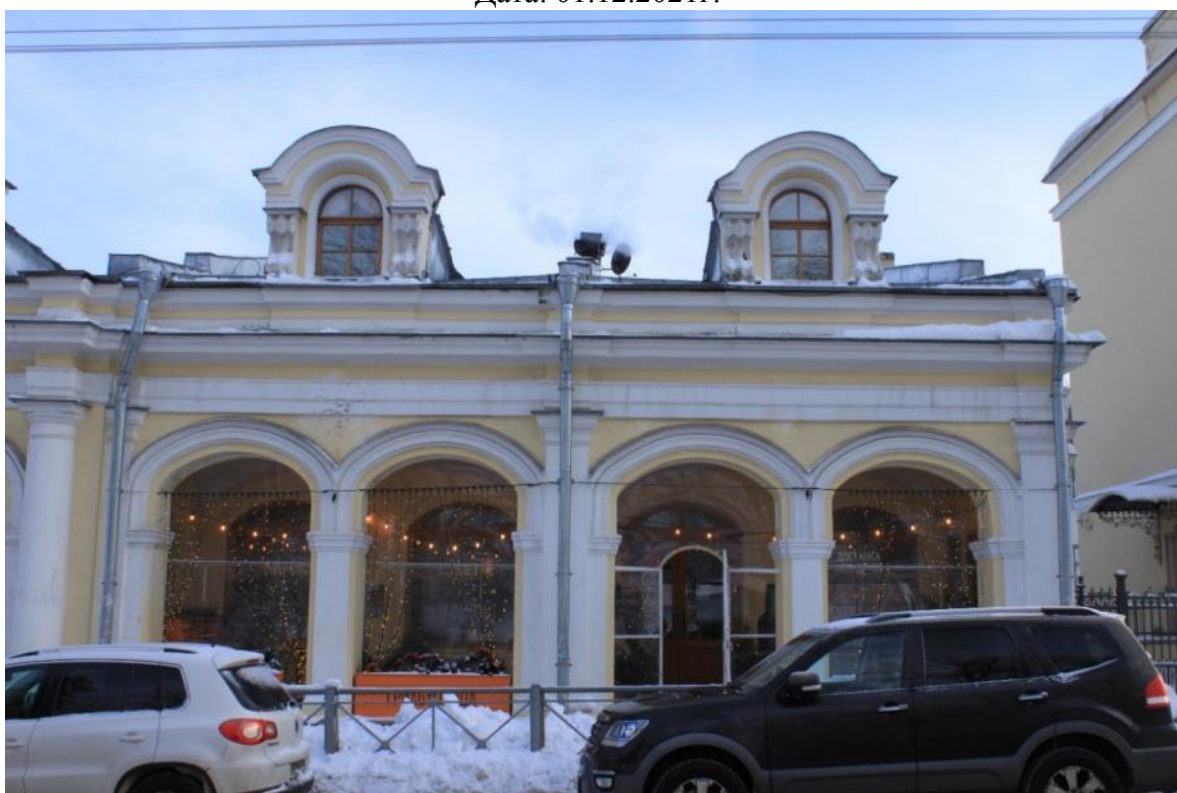
Фото 4. Объект культурного наследия федерального значения «Гостиный двор», по адресу: Санкт-Петербург, г. Пушкин, Московская ул., д. 25; Оранжерейная ул.; Леонтьевская ул. Фрагмент фасада Гостиного двора с Леонтьевской улицы Дата: 01.12.2021г.
