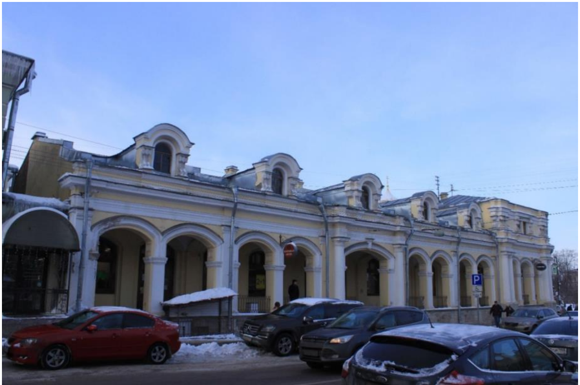
Фото 29. Объект культурного наследия федерального значения «Гостинный двор», по адресу: Санкт-Петербург, г. Пушкин, Московская ул., д. 25; Оранжерейная ул.; Леонтьевская ул. Фрагмент фасада Гостиного двора с Оранжерейной улицы Дата: 01.12.2021г.
