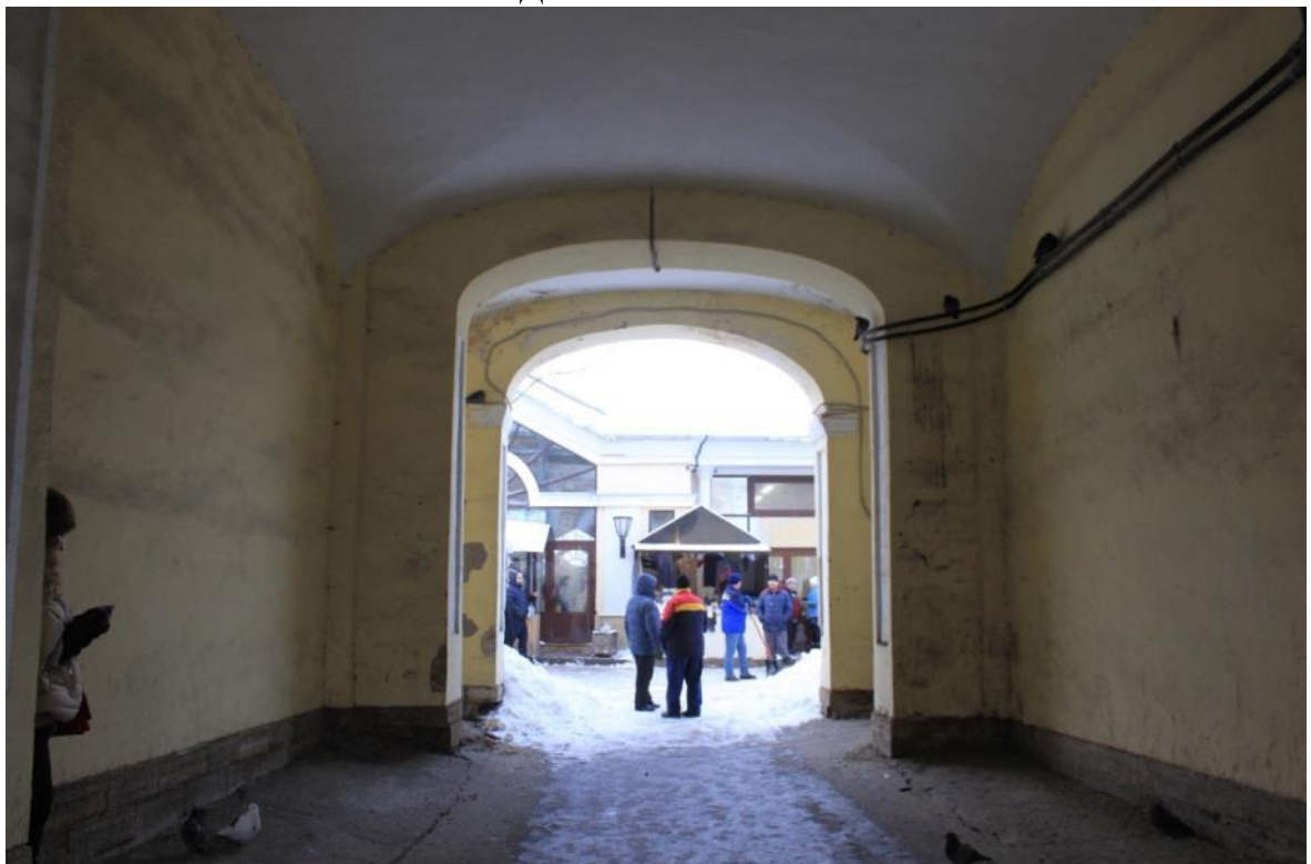
Фото 30. Объект культурного наследия федерального значения «Гостинный двор», по адресу: Санкт-Петербург, г. Пушкин, Московская ул., д. 25; Оранжерейная ул.; Леонтьевская ул. Вид на проездную арку Гостиного двора с Оранжерейной улицы Дата: 01.12.2021г.
