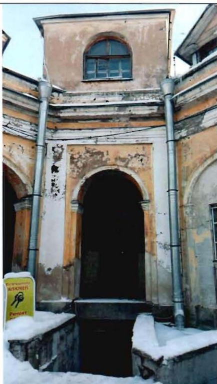
7. Фрагмент дворового фасада
