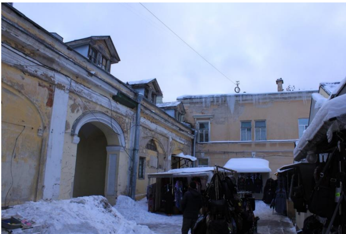
Фото 35. Объект культурного наследия федерального значения «Гостиный двор», по адресу: Санкт-Петербург, г. Пушкин, Московская ул., д. 25; Оранжерейная ул.; Леонтьевская ул. Фрагмент внутреннего фасада Гостиного двора с дворовой территории Царскосельского рынка Дата: 01.12.2021г.
