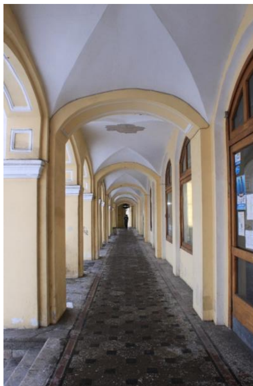
Фото 69. Объект культурного наследия федерального значения «Гостиный двор», по адресу: Санкт-Петербург, г. Пушкин, Московская ул., д. 25; Оранжерейная ул.; Леонтьевская ул. Вид вдоль открытой галереи Гостиного двора со стороны Московской улицы. Дата: 01.12.2021г.
