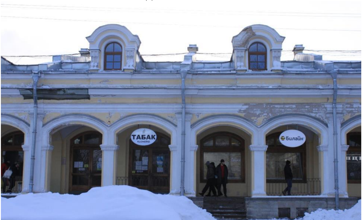
Фото 20. Объект культурного наследия федерального значения «Гостиный двор», по адресу: Санкт-Петербург, г. Пушкин, Московская ул., д. 25; Оранжерейная ул.; Леонтьевская ул. Фрагмент фасада Гостиного двора с Московской улицы Дата: 01.12.2021г.
