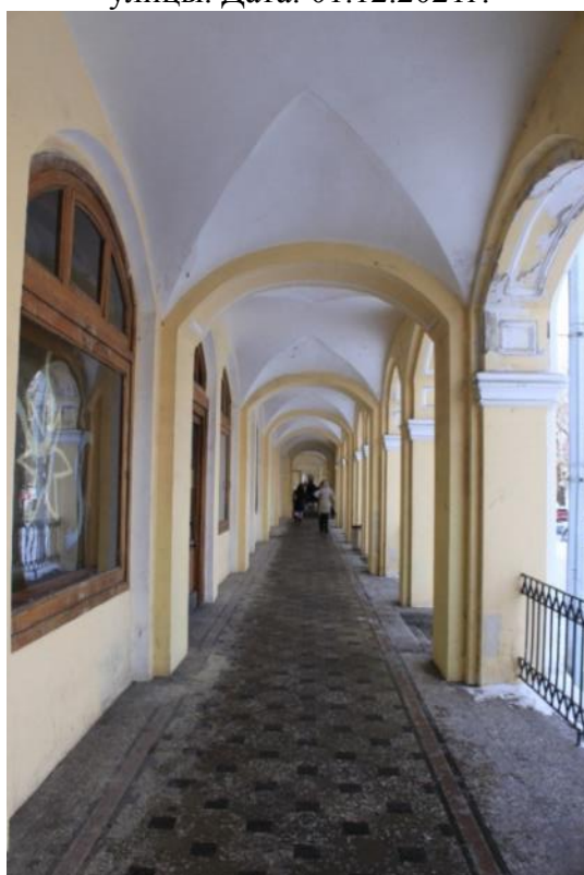
Фото 64. Объект культурного наследия федерального значения «Гостиный двор», по адресу: Санкт-Петербург, г. Пушкин, Московская ул., д. 25; Оранжерейная ул.; Леонтьевская ул. Вид вдоль открытой галереи Гостиного двора со стороны Московской улицы. Дата: 01.12.2021г.
