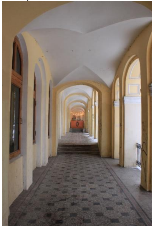
Фото 50. Объект культурного наследия федерального значения «Гостиный двор», по адресу: Санкт-Петербург, г. Пушкин, Московская ул., д. 25; Оранжерейная ул.; Леонтьевская ул. Вид вдоль открытой галереи Гостиного двора со стороны Леонтьевской улицы. Дата: 01.12.2021г.
