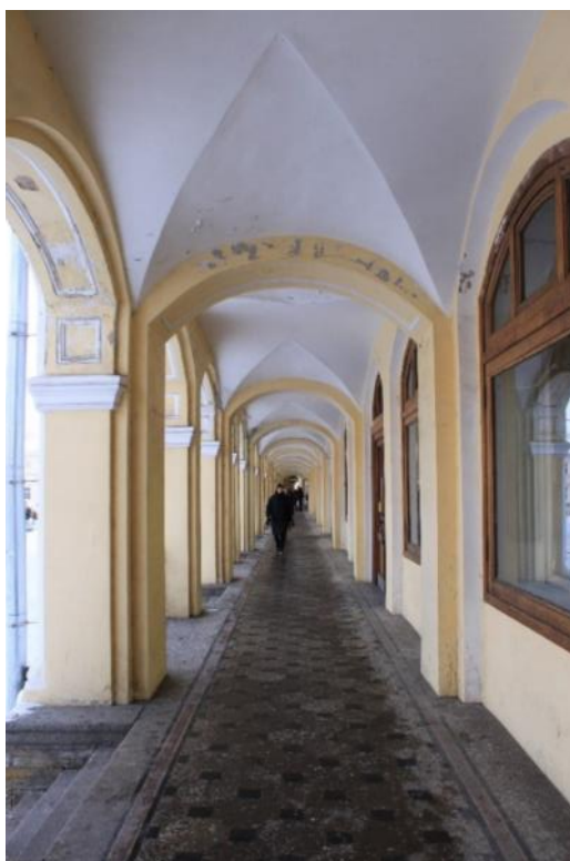
Фото 65. Объект культурного наследия федерального значения «Гостиный двор», по адресу: Санкт-Петербург, г. Пушкин, Московская ул., д. 25; Оранжерейная ул.; Леонтьевская ул. Вид вдоль открытой галереи Гостиного двора со стороны Московской улицы. Дата: 01.12.2021г.
