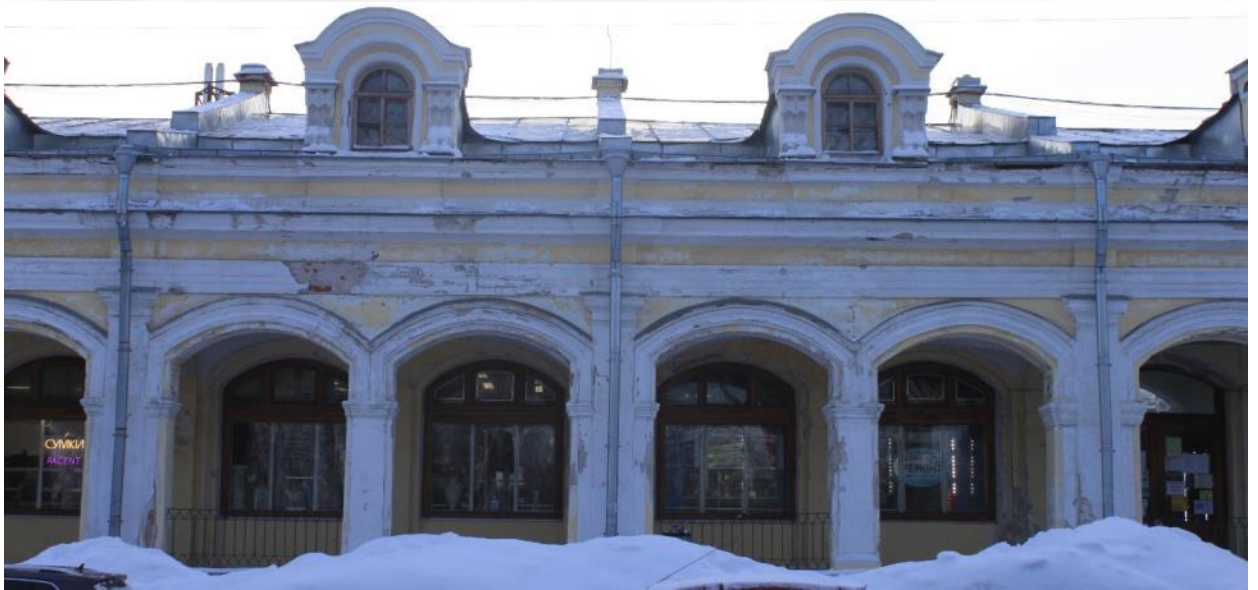
Фото 11. Объект культурного наследия федерального значения «Гостиный двор», по адресу: Санкт-Петербург, г. Пушкин, Московская ул., д. 25; Оранжерейная ул.; Леонтьевская ул. Фрагмент фасада Гостиного двора с Московской улицы Дата: 01.12.2021г.
