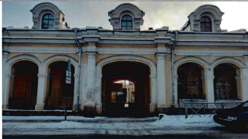
1. Фрагмент северо-западного фасада
