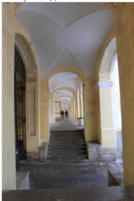
Фото 62. Объект культурного наследия федерального значения «Гостиный двор», по адресу: Санкт-Петербург, г. Пушкин, Московская ул., д. 25; Оранжерейная ул.; Леонтьевская ул. Вид вдоль открытой галереи Гостиного двора со стороны Московской улицы. Дата: 01.12.2021г.
