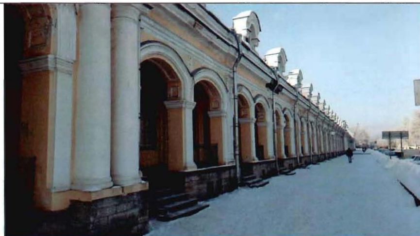
2. Фрагмент северного фасада
