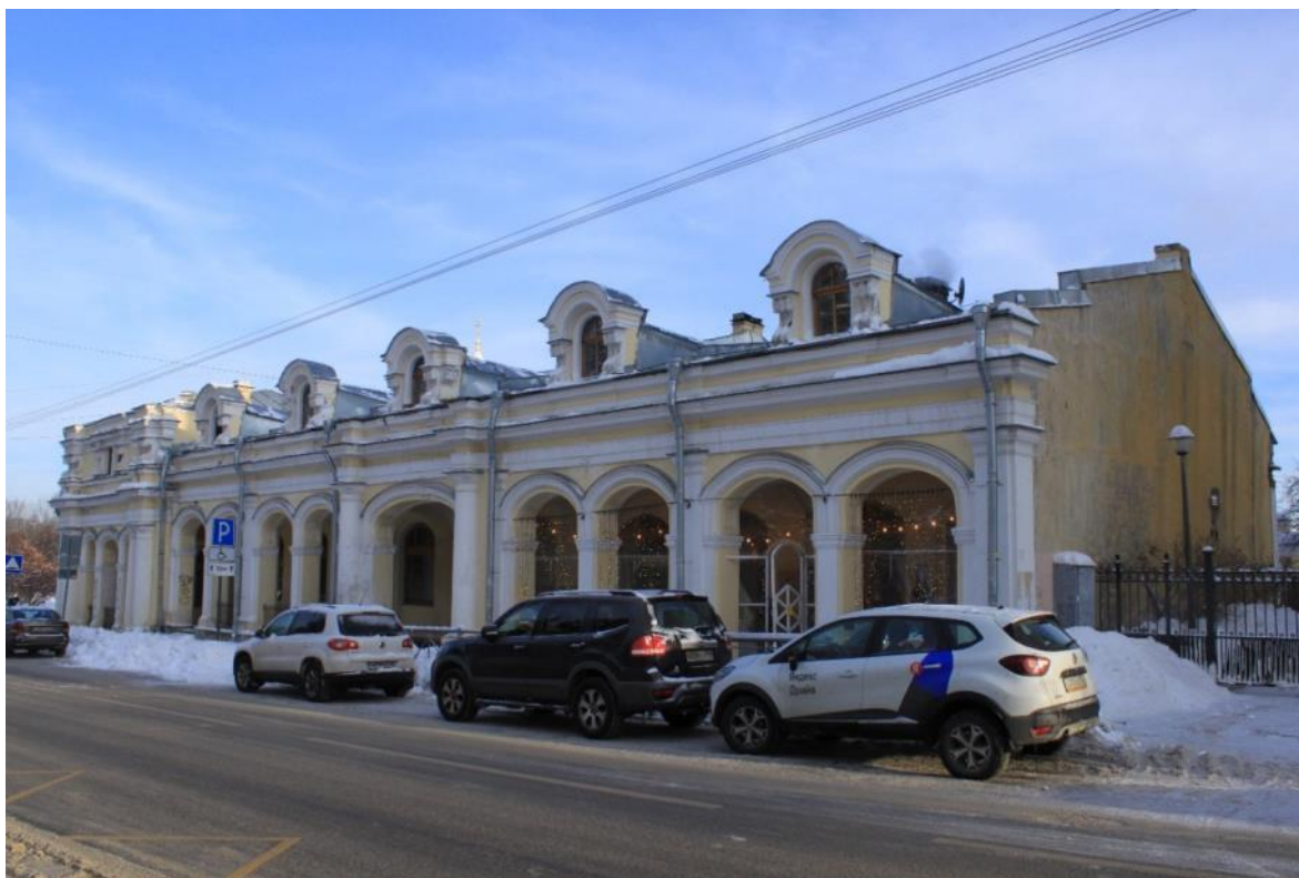
Фото 3. Объект культурного наследия федерального значения «Гостиный двор», по адресу: Санкт-Петербург, г. Пушкин, Московская ул., д. 25; Оранжерейная ул.; Леонтьевская ул. Общий вид фасада Гостиного двора с Леонтьевской улицы Дата: 01.12.2021г.
