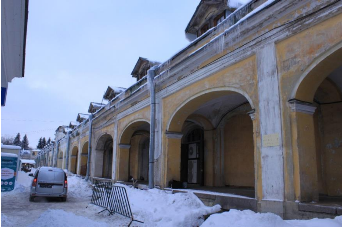
Фото 37. Объект культурного наследия федерального значения «Гостиный двор», по адресу: Санкт-Петербург, г. Пушкин, Московская ул., д. 25; Оранжерейная ул.; Леонтьевская ул. Фрагмент внутреннего фасада Гостиного двора с дворовой территории Царскосельского рынка Дата: 01.12.2021г.
