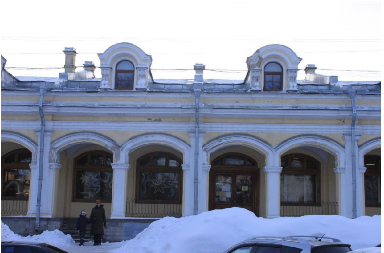
Фото 17. Объект культурного наследия федерального значения «Гостинный двор», по адресу: Санкт-Петербург, г. Пушкин, Московская ул., д. 25; Оранжерейная ул.; Леонтьевская ул. Фрагмент фасада Гостиного двора с Московской улицы Дата: 01.12.2021г.
