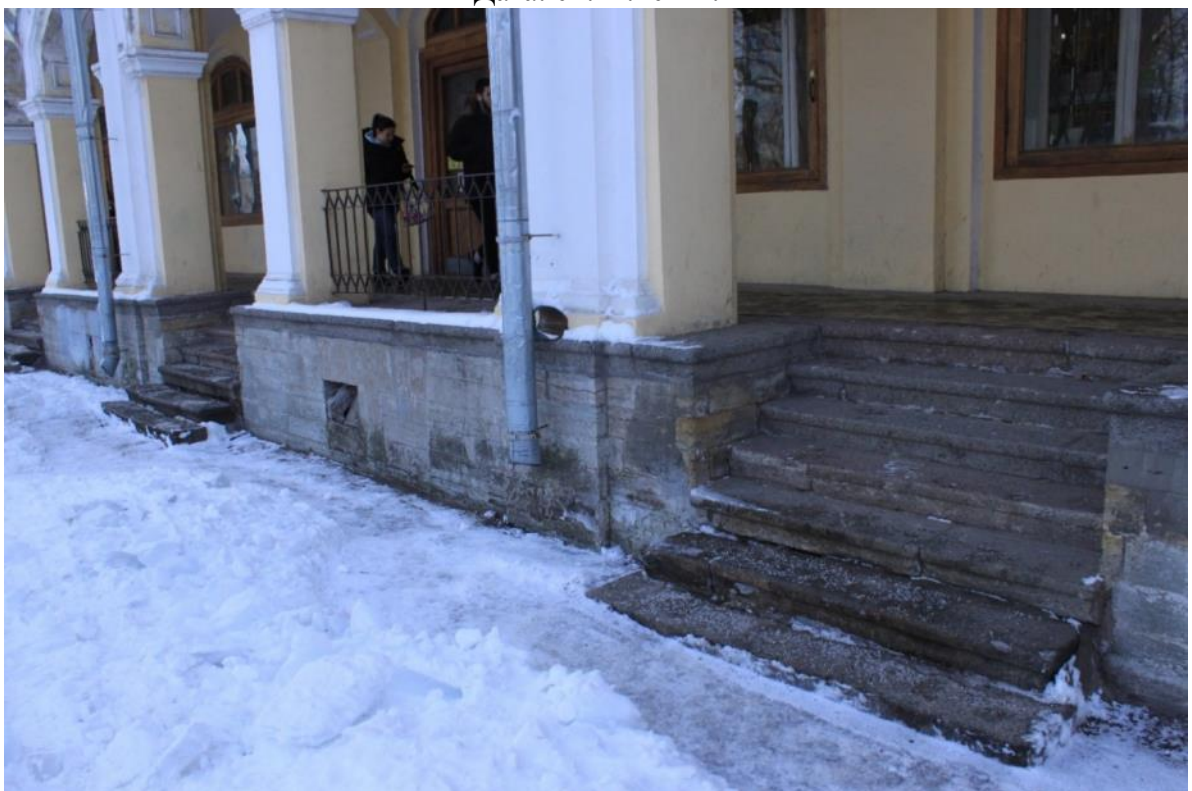
Фото 84. Объект культурного наследия федерального значения «Гостинный двор», по адресу: Санкт-Петербург, г. Пушкин, Московская ул., д. 25; Оранжерейная ул.; Леонтьевская ул. Вид на крыльцо Гостиного двора с Московской улицы Дата: 01.12.2021г.
