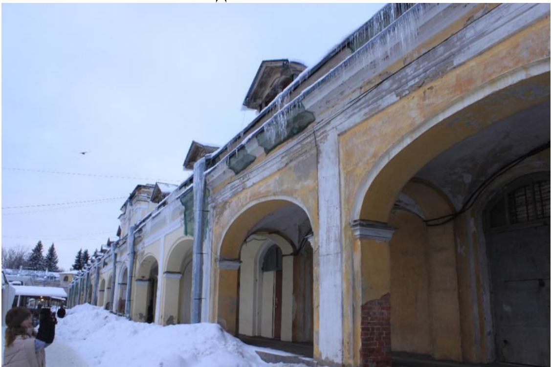
Фото 38. Объект культурного наследия федерального значения «Гостиный двор», по адресу: Санкт-Петербург, г. Пушкин, Московская ул., д. 25; Оранжерейная ул.; Леонтьевская ул. Фрагмент внутреннего фасада Гостиного двора с дворовой территории Царскосельского рынка Дата: 01.12.2021г.
