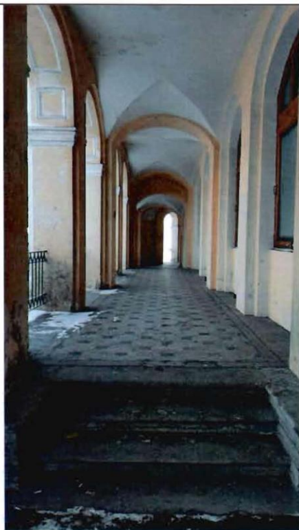
4. Фрагмент обходной галереи со стороны лицевого фасада
