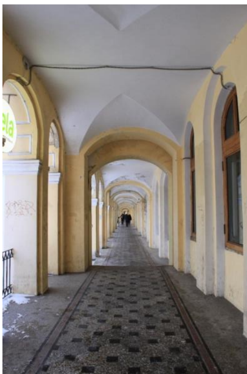
Фото 53. Объект культурного наследия федерального значения «Гостиный двор», по адресу: Санкт-Петербург, г. Пушкин, Московская ул., д. 25; Оранжерейная ул.; Леонтьевская ул. Вид вдоль открытой галереи Гостиного двора со стороны Московской улицы. Дата: 01.12.2021г.
