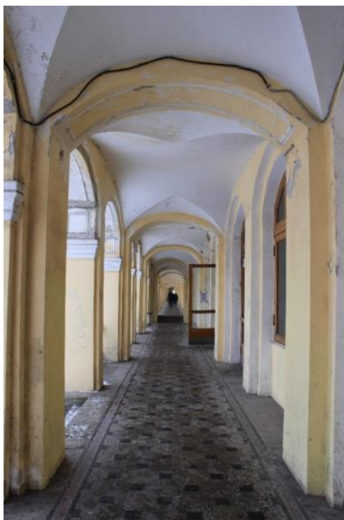
Фото 61. Объект культурного наследия федерального значения «Гостиный двор», по адресу: Санкт-Петербург, г. Пушкин, Московская ул., д. 25; Оранжерейная ул.; Леонтьевская ул. Вид вдоль открытой галереи Гостиного двора со стороны Московской улицы. Дата: 01.12.2021г.
