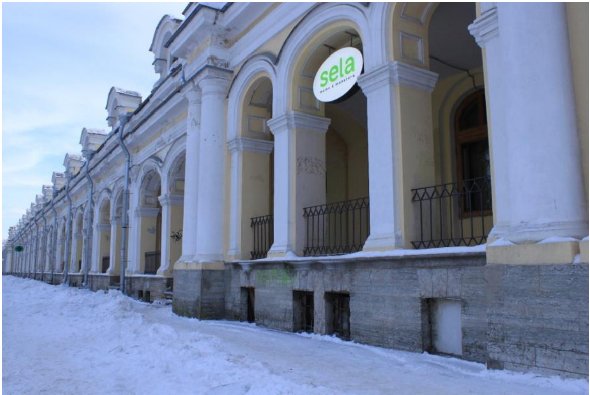
Фото 75. Объект культурного наследия федерального значения «Гостиный двор», по адресу: Санкт-Петербург, г. Пушкин, Московская ул., д. 25; Оранжерейная ул.; Леонтьевская ул. Вид на цоколь фасада Гостиного двора с Московской улицы Дата: 01.12.2021г.
