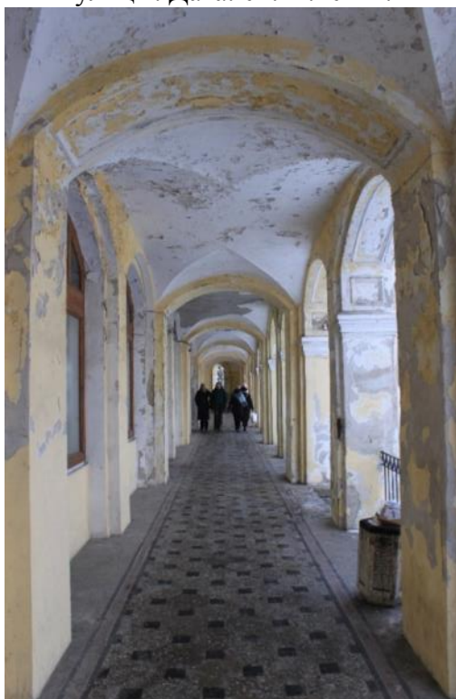
Фото 56. Объект культурного наследия федерального значения «Гостиный двор», по адресу: Санкт-Петербург, г. Пушкин, Московская ул., д. 25; Оранжерейная ул.; Леонтьевская ул. Вид вдоль открытой галереи Гостиного двора со стороны Московской улицы. Дата: 01.12.2021г.
