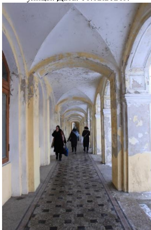
Фото 58. Объект культурного наследия федерального значения «Гостиный двор», по адресу: Санкт-Петербург, г. Пушкин, Московская ул., д. 25; Оранжерейная ул.; Леонтьевская ул. Вид вдоль открытой галереи Гостиного двора со стороны Московской улицы. Дата: 01.12.2021г.
