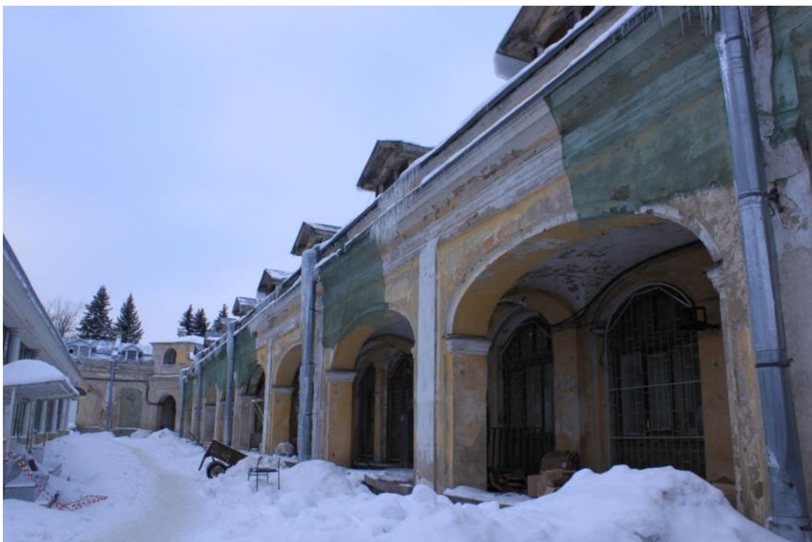
Фото 39. Объект культурного наследия федерального значения «Гостиный двор», по адресу: Санкт-Петербург, г. Пушкин, Московская ул., д. 25; Оранжерейная ул.; Леонтьевская ул. Фрагмент внутреннего фасада Гостиного двора с дворовой территории Царскосельского рынка Дата: 01.12.2021г.
