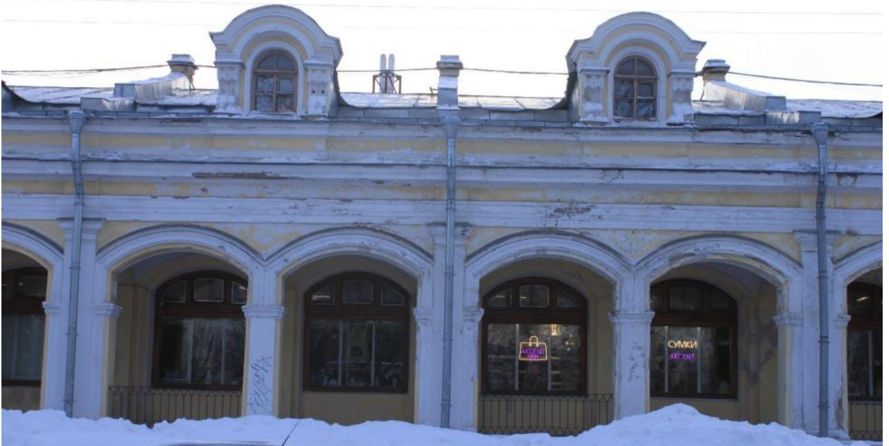
Фото 12. Объект культурного наследия федерального значения «Гостиный двор», по адресу: Санкт-Петербург, г. Пушкин, Московская ул., д. 25; Оранжерейная ул.; Леонтьевская ул. Фрагмент фасада Гостиного двора с Московской улицы Дата: 01.12.2021г.
