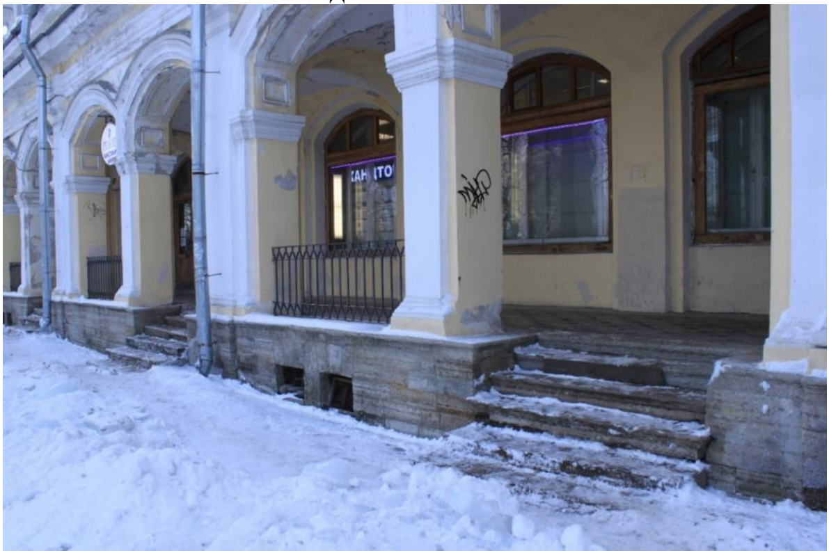
Фото 76. Объект культурного наследия федерального значения «Гостиный двор», по адресу: Санкт-Петербург, г. Пушкин, Московская ул., д. 25; Оранжерейная ул.; Леонтьевская ул. Вид на крыльца Гостиного двора с Московской улицы Дата: 01.12.2021г.
