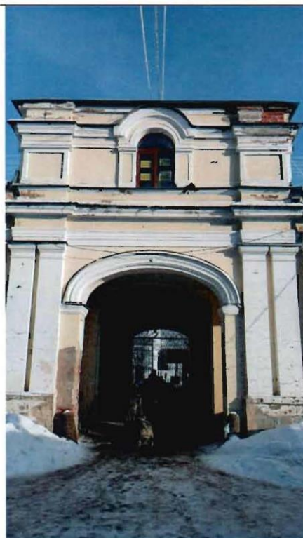
8. Фрагмент дворового фасада
