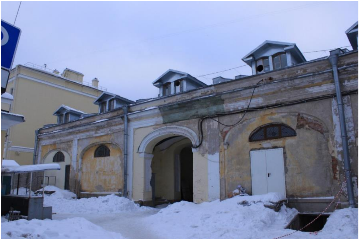
Фото 41. Объект культурного наследия федерального значения «Гостиный двор», по адресу: Санкт-Петербург, г. Пушкин, Московская ул., д. 25; Оранжерейная ул.; Леонтьевская ул. Фрагмент внутреннего фасада Гостиного двора с дворовой территории Царскосельского рынка. Дата: 01.12.2021г.
