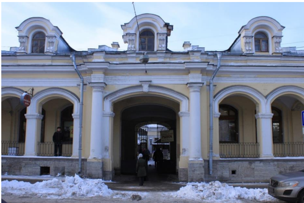
Фото 27. Объект культурного наследия федерального значения «Гостинный двор», по адресу: Санкт-Петербург, г. Пушкин, Московская ул., д. 25; Оранжерейная ул.; Леонтьевская ул. Фрагмент фасада Гостиного двора с Оранжерейной улицы Дата: 01.12.2021г.
