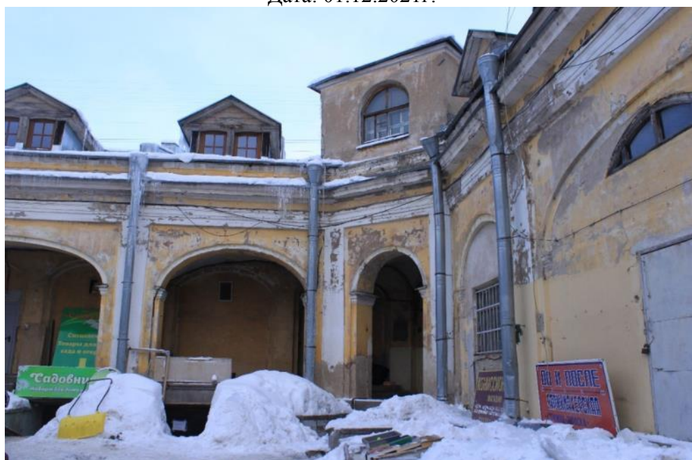
Фото 34. Объект культурного наследия федерального значения «Гостиный двор», по адресу: Санкт-Петербург, г. Пушкин, Московская ул., д. 25; Оранжерейная ул.; Леонтьевская ул. Фрагмент внутреннего фасада Гостиного двора с дворовой территории Царскосельского рынка Дата: 01.12.2021г.
