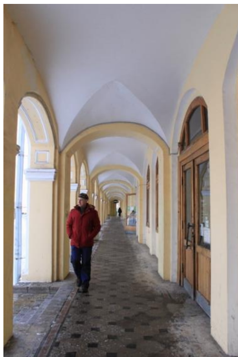
Фото 67. Объект культурного наследия федерального значения «Гостиный двор», по адресу: Санкт-Петербург, г. Пушкин, Московская ул., д. 25; Оранжерейная ул.; Леонтьевская ул. Вид вдоль открытой галереи Гостиного двора со стороны Московской улицы. Дата: 01.12.2021г.
