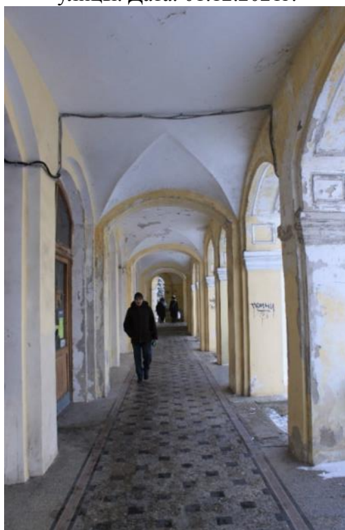
Фото 54. Объект культурного наследия федерального значения «Гостиный двор», по адресу: Санкт-Петербург, г. Пушкин, Московская ул., д. 25; Оранжерейная ул.; Леонтьевская ул. Вид вдоль открытой галереи Гостиного двора со стороны Московской улицы. Дата: 01.12.2021г.
