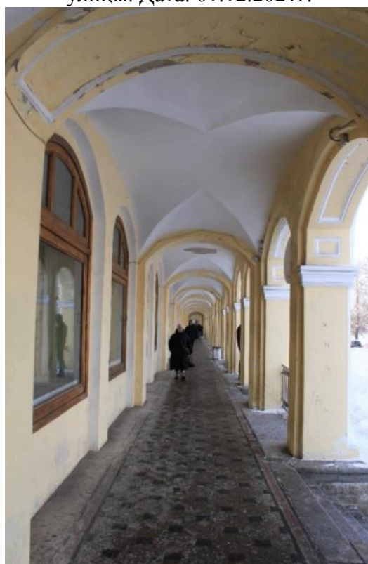
Фото 68. Объект культурного наследия федерального значения «Гостиный двор», по адресу: Санкт-Петербург, г. Пушкин, Московская ул., д. 25; Оранжерейная ул.; Леонтьевская ул. Вид вдоль открытой галереи Гостиного двора со стороны Московской улицы. Дата: 01.12.2021г.
