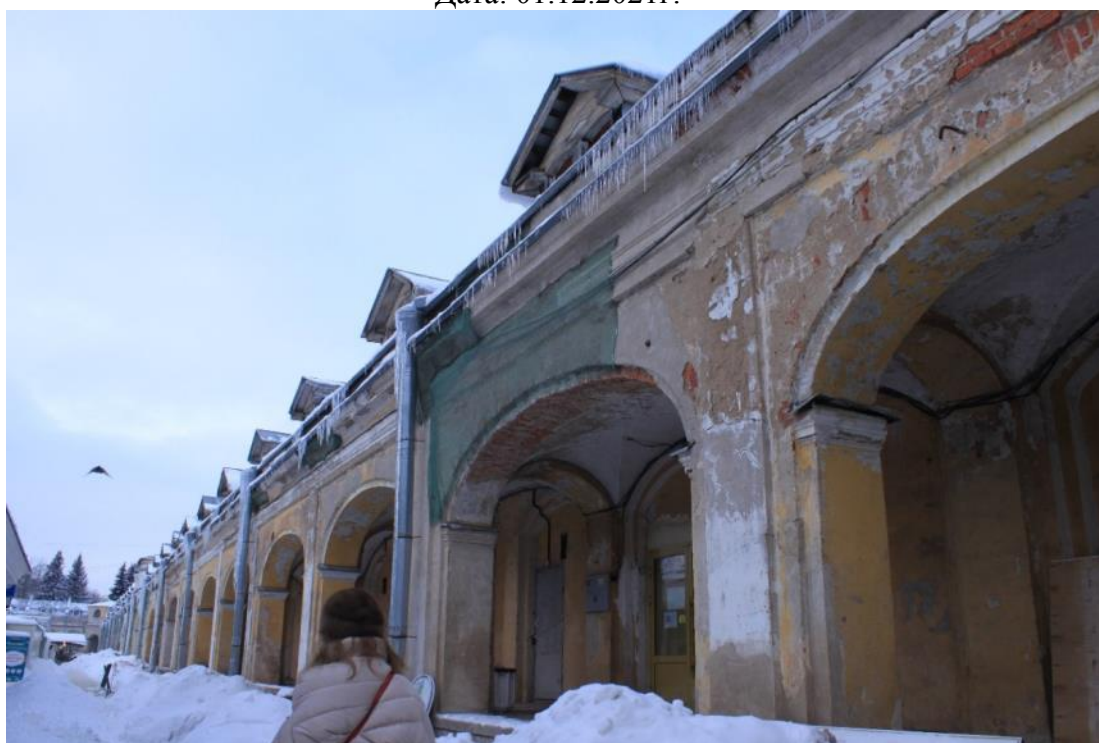
Фото 36. Объект культурного наследия федерального значения «Гостиный двор», по адресу: Санкт-Петербург, г. Пушкин, Московская ул., д. 25; Оранжерейная ул.; Леонтьевская ул. Фрагмент внутреннего фасада Гостиного двора с дворовой территории Царскосельского рынка Дата: 01.12.2021г.
