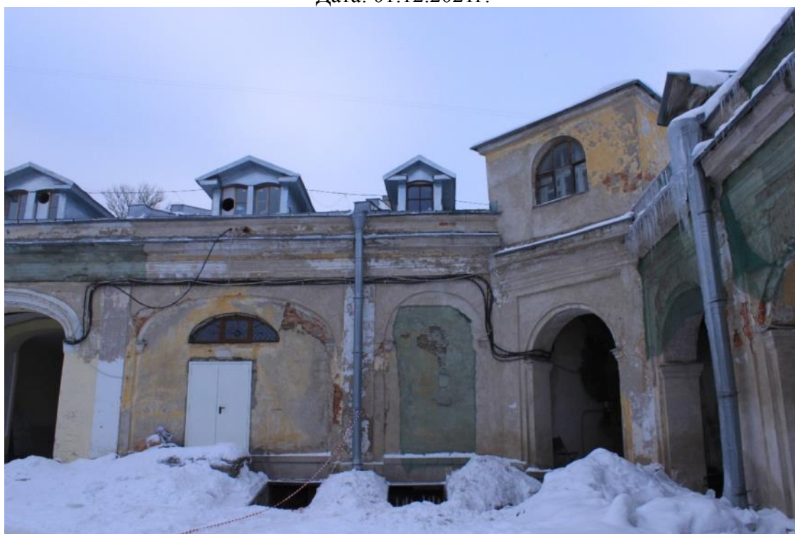
Фото 40. Объект культурного наследия федерального значения «Гостиный двор», по адресу: Санкт-Петербург, г. Пушкин, Московская ул., д. 25; Оранжерейная ул.; Леонтьевская ул. Фрагмент внутреннего фасада Гостиного двора с дворовой территории Царскосельского рынка Дата: 01.12.2021г.
