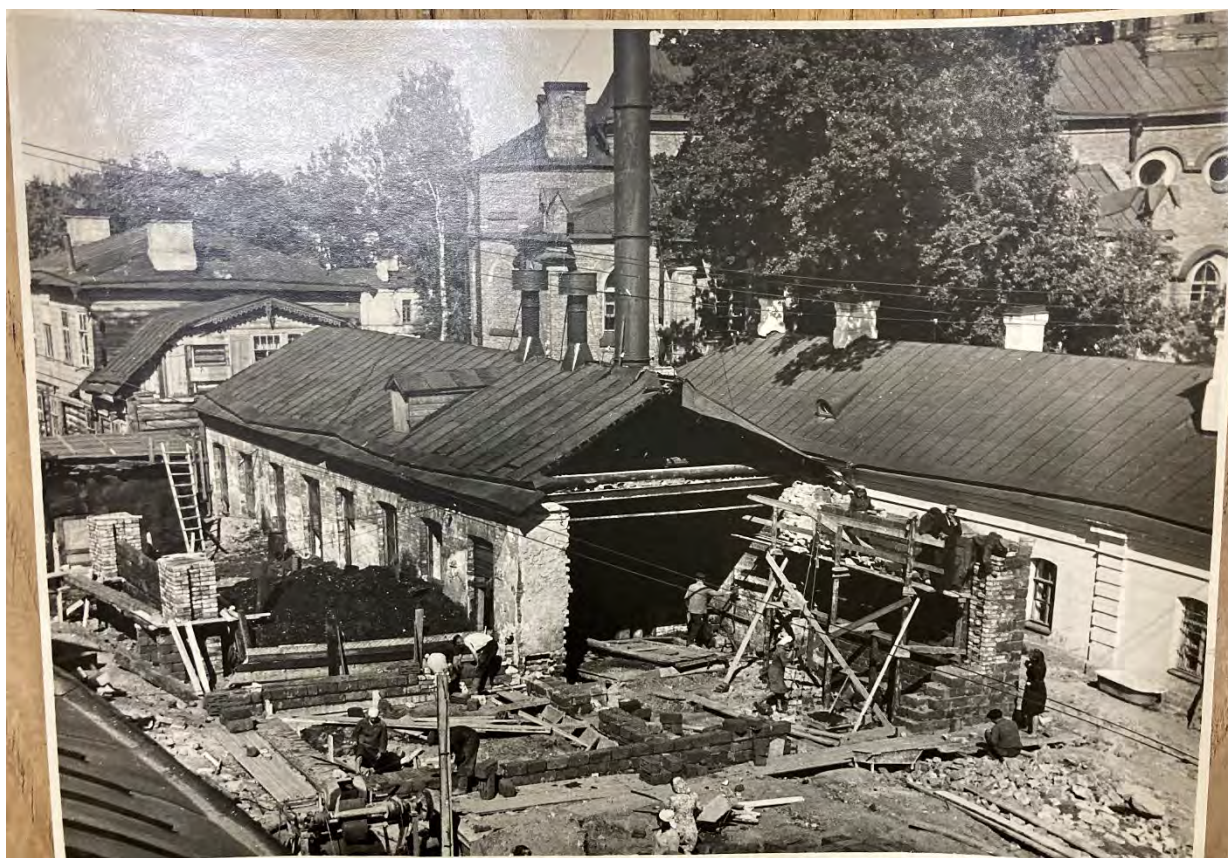
Иллюстрация 57. «Нижние конюшни». Котельная. Фото 1948 г. Архив КГИОП.
