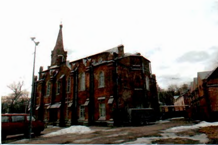
Фото 4. Вид с севера.
