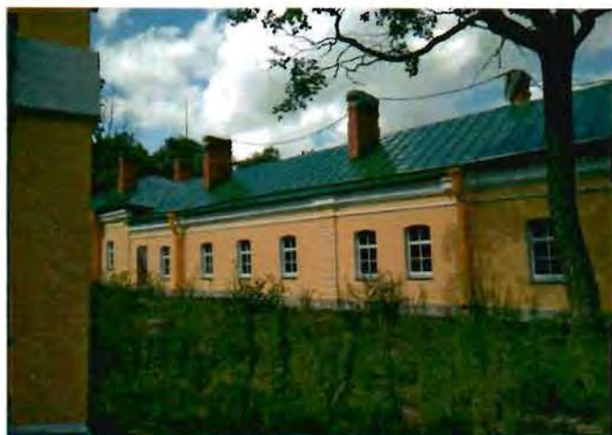
3. Вид на восточный фасад объекта культурного наследия.
