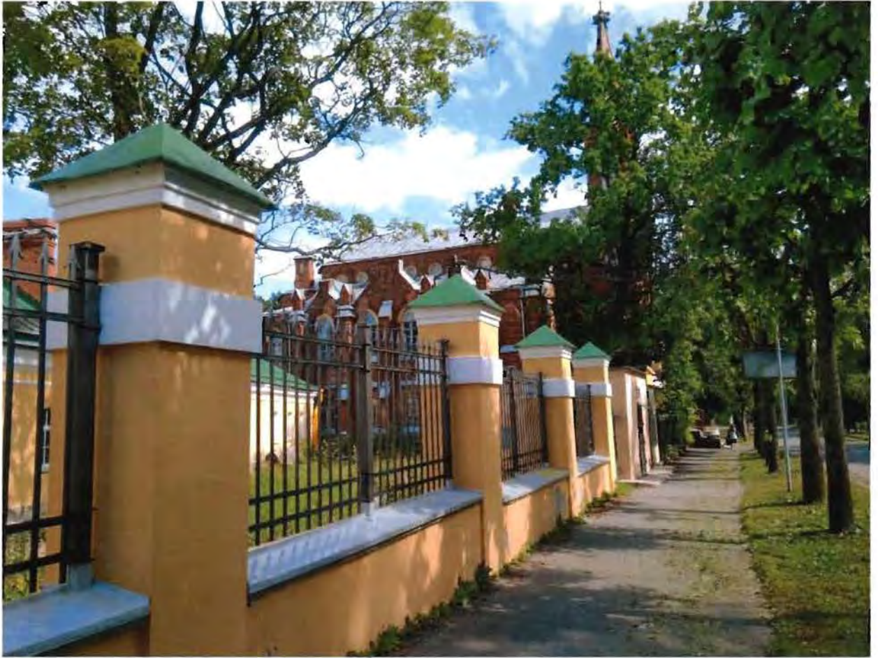
2. Ограда палисадника. Вид с юго-западной стороны.
