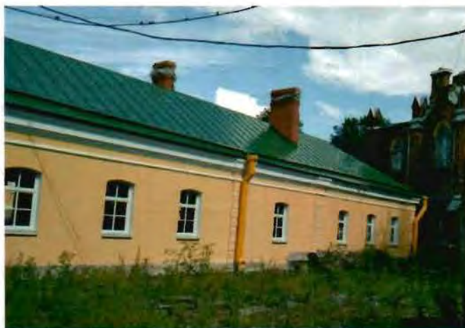
4. Вид на восточный фасад объекта культурного наследия.
