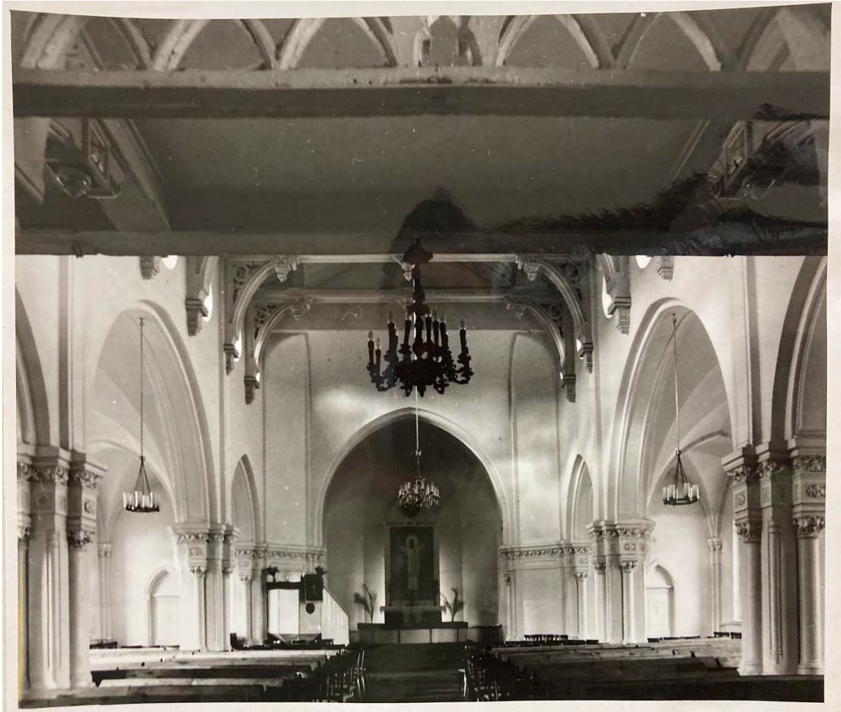
Иллюстрация 83. В. И. Шлакан. Лютеранская церковь 1865 г., арх. А. Ф. Видов. Интерьер II этажа. Центральный неф, вид на алтарь. Фото 1985 г. Архив КГИОП.
