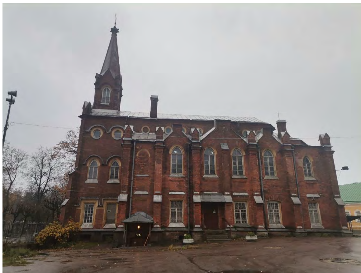
Фото 01. Объект культурного наследия федерального значения «Церковь лютеранская Воскресения Христова». Северо-восточный фасад. Общий вид. Съёмка 31.10.2022 г.
