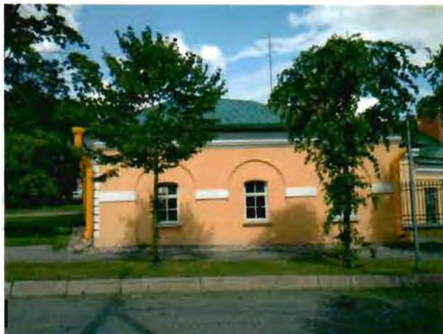
2. Вид на восточный фасад объекта культурного наследия.
