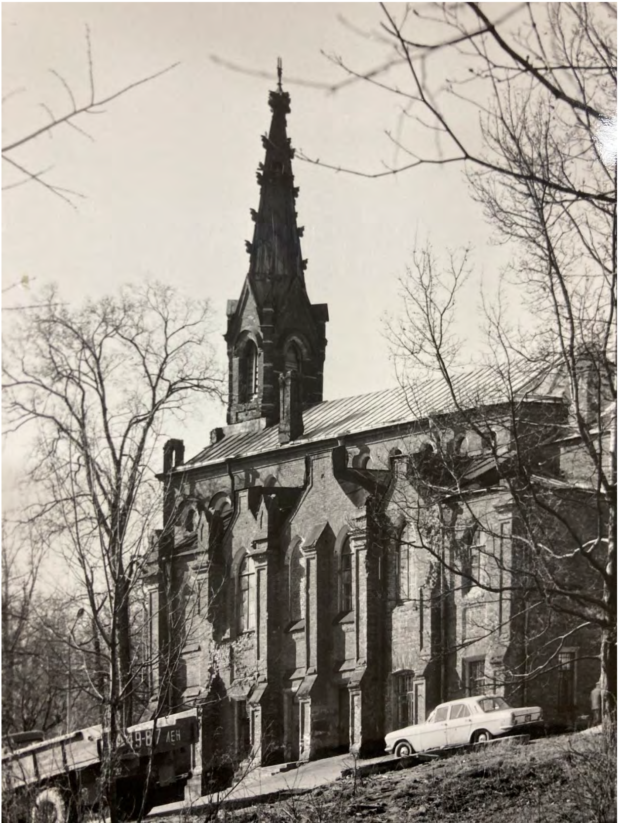
Иллюстрация 71. г. Пушкин. Б. Лютеранская церковь. Фасад со стороны ул. Революции. Фото 1977 г. Архив КГИОП.
