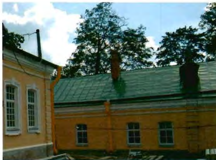
6. Вид на западный фасад объекта культурного наследия.
