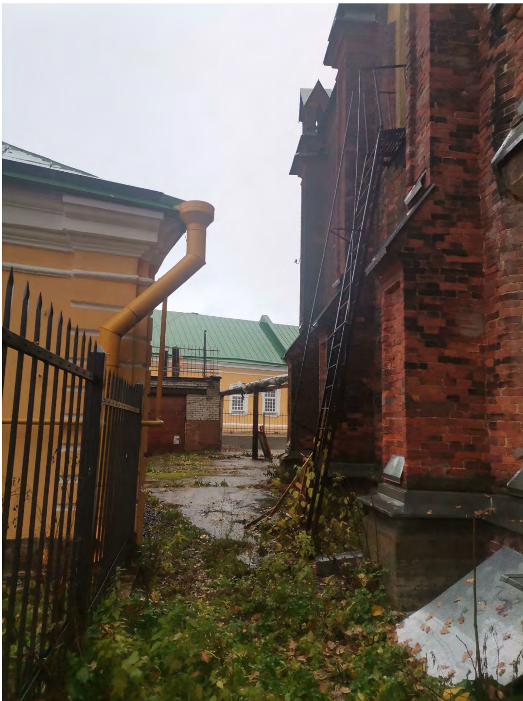
Фото 06. Объект культурного наследия федерального значения «Церковь лютеранская Воскресения Христова». Юго-западный фасад. Объект культурного наследия федерального значения «Флигель жилой». Фрагмент. Съёмка 31.10.2022 г.
