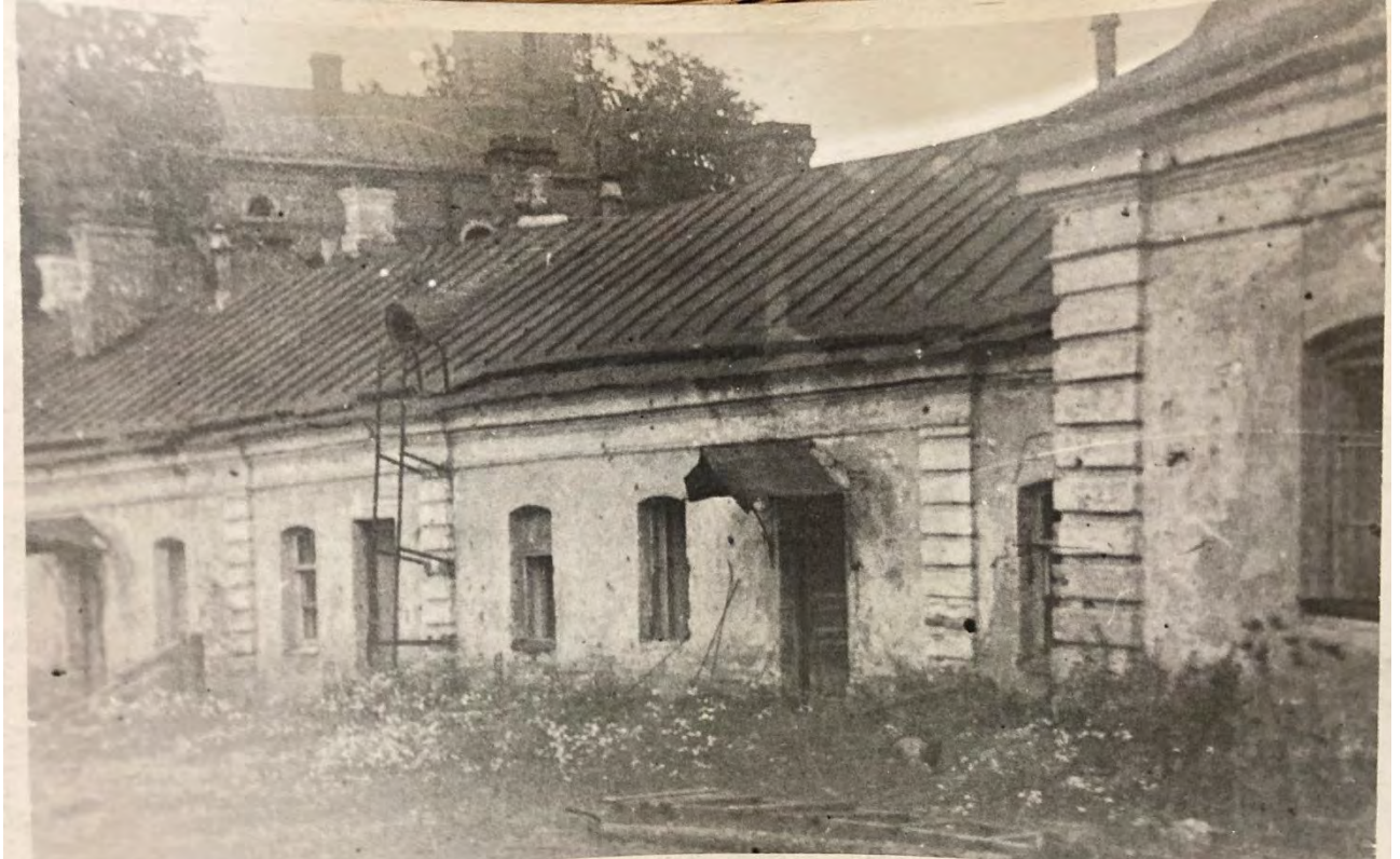
Иллюстрация 54. Вид из двора комплекса Нижних конюшен, на заднем плане – боковой фасад лютеранской церкви. Фото 1945 г. Архив КГИОП.
