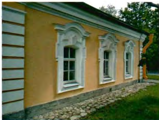
5. Вид на южный фасад объекта культурного наследия.
