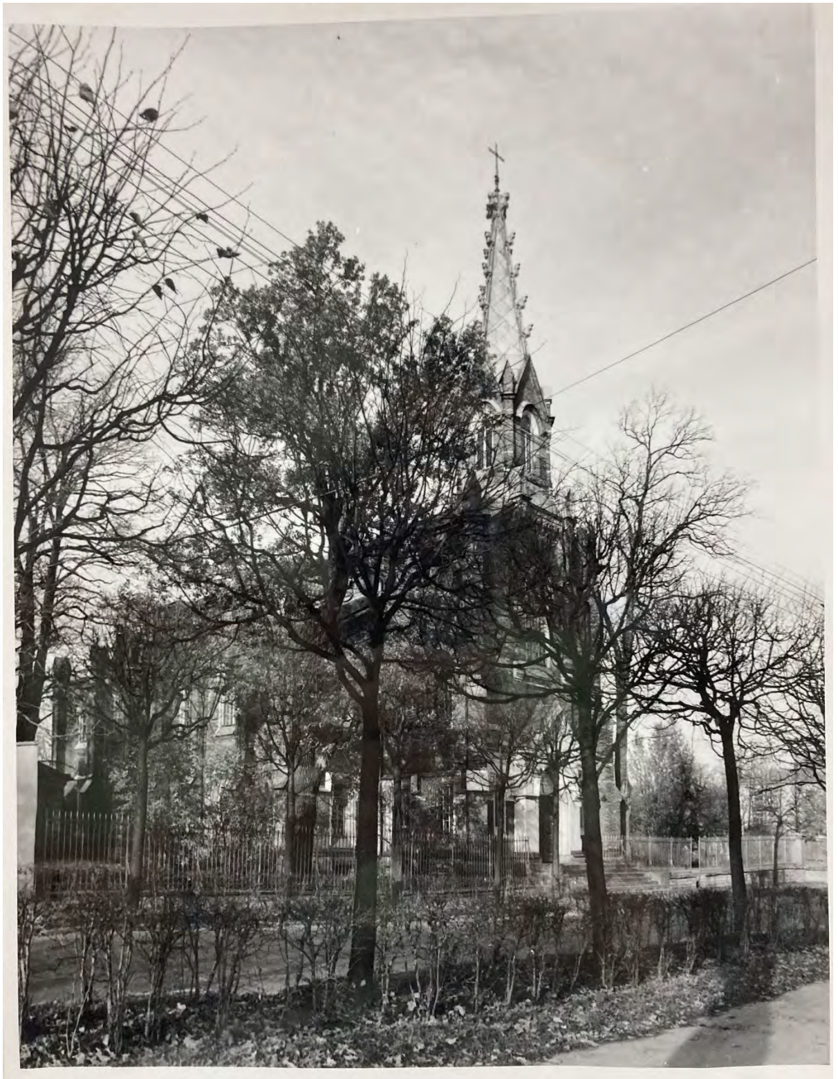
Иллюстрация 77. В. И. Шлакан. Лютеранская церковь 1865 г., архитектор А. Ф. Видов. Фото 1985 г. Архив КГИОП.
