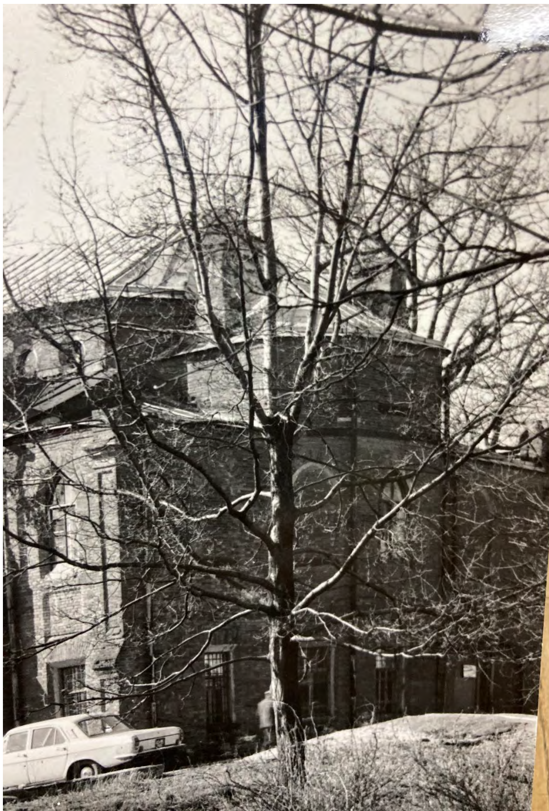
Иллюстрация 72. Лютеранская церковь. Фрагмент фасада с алтарной апсидой. Фото 1977 г. Архив КГИОП.
