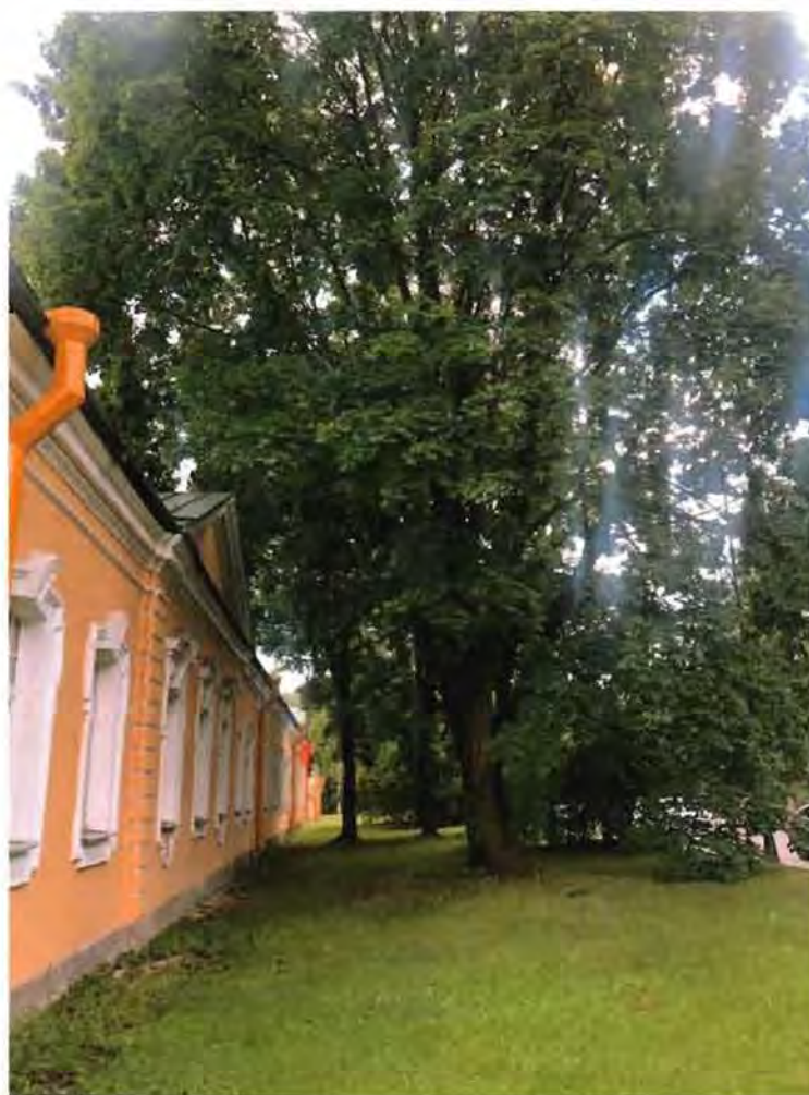
1. Палисадник. Вид с юго-восточной стороны.
