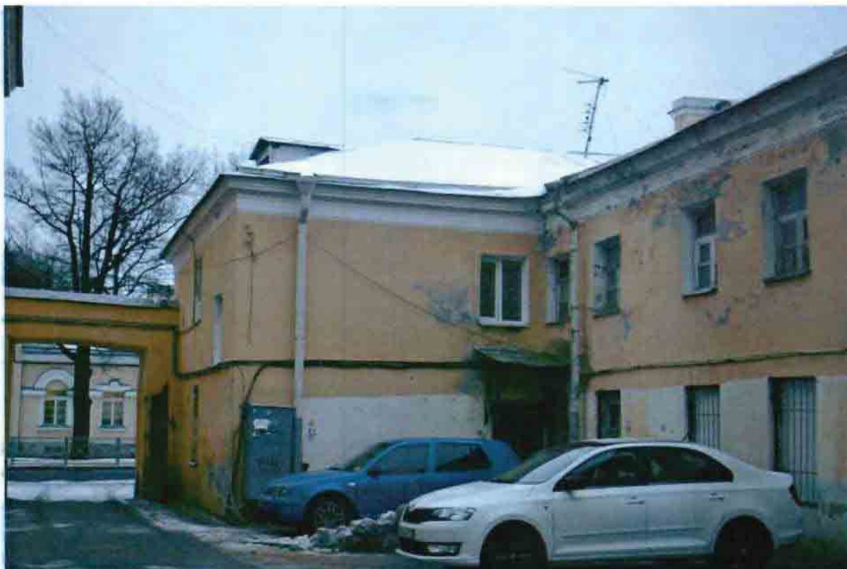
Фото 13. Часть дворового фасада.
