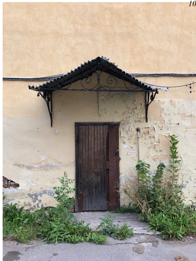
Фото 10. Дверное заполнение и кованый металлический козырек южного дворового фасада флигеля. Вид с юга.
