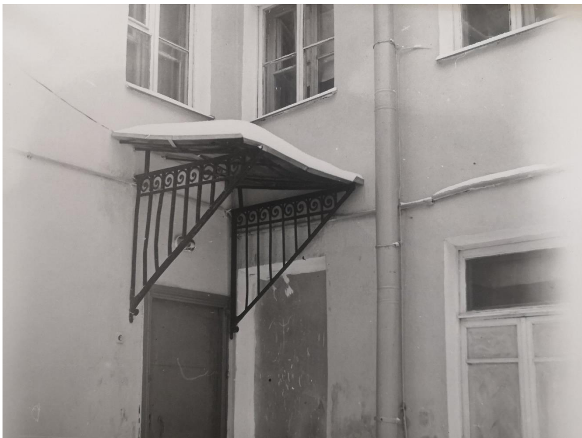
Илл. 16. Флигель жилого дома. Фрагмент главного фасада. 1989 г. // Архив КГИОП. П. 215. Пр-1. Часть 2
