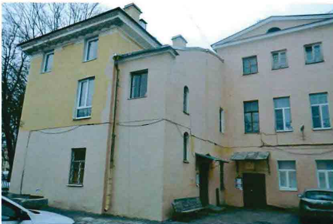
Фото 3. Часть дворового фасада.
