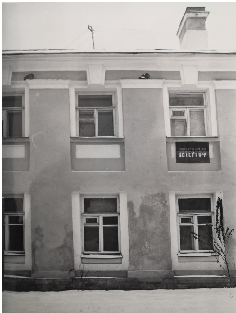
Илл. 14. Флигель жилого дома. Фрагмент восточного фасада. 1989 г. // Архив КГИОП. П. 215. Пр-1. Часть 2
