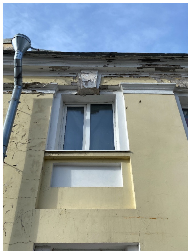
Фото 5. Современное оконное заполнение восточного фасада в уровне 1-го этажа. Вид с востока.
