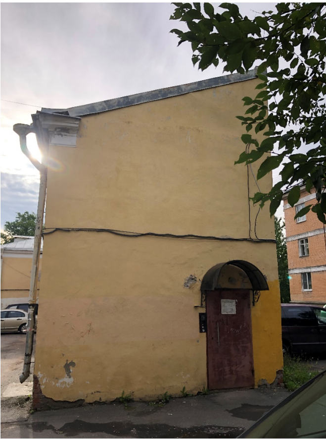
Фото 12. Общий вид западного дворового фасада флигеля. Вид с запада.
