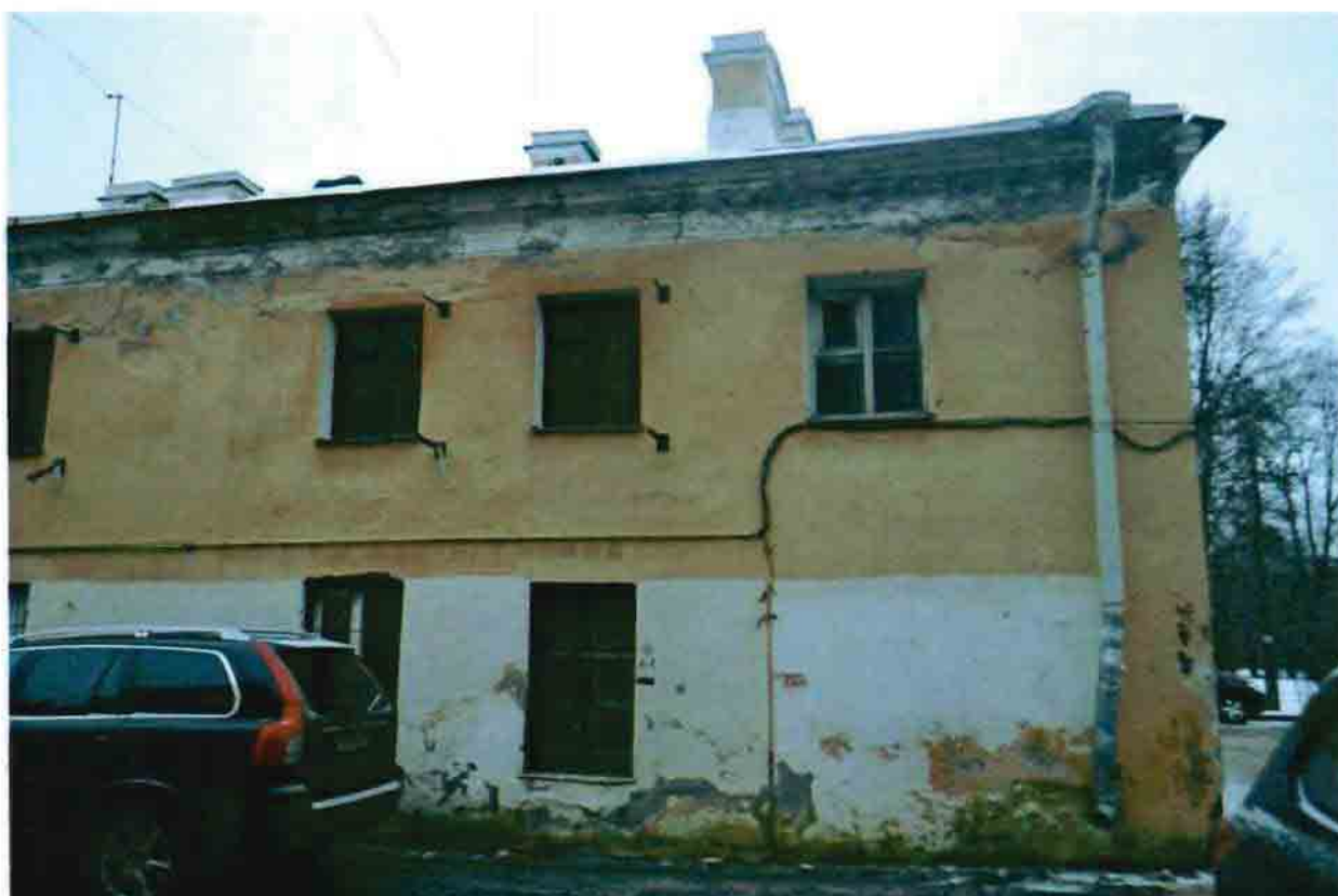
Фото 12. Часть дворового (северного) фасада.
