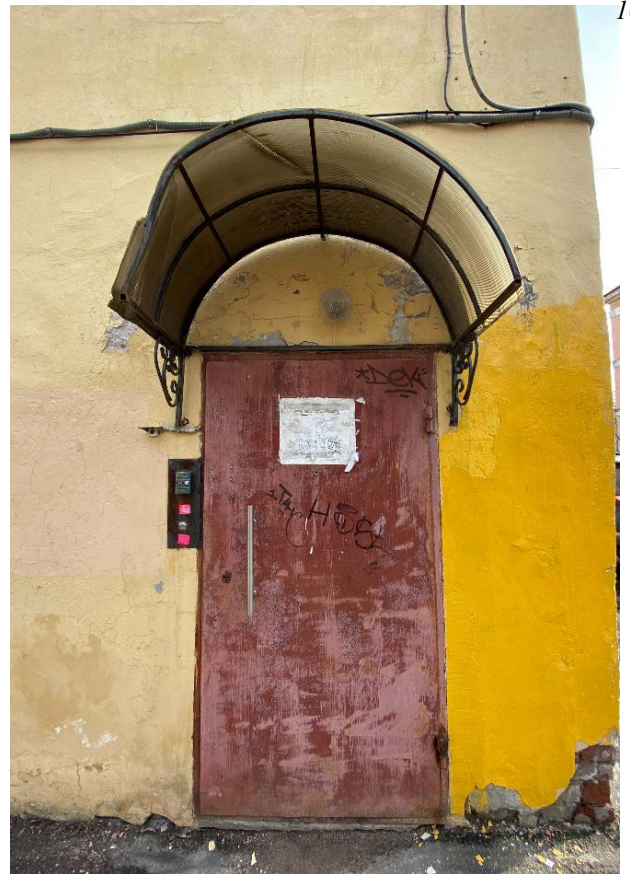
Фото 13. Общий вид современного дверного заполнения и козырька западного дворового фасада флигеля. Вид с запада.
