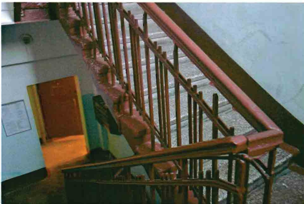
Фото 7. Лестница во втором подъезде.
