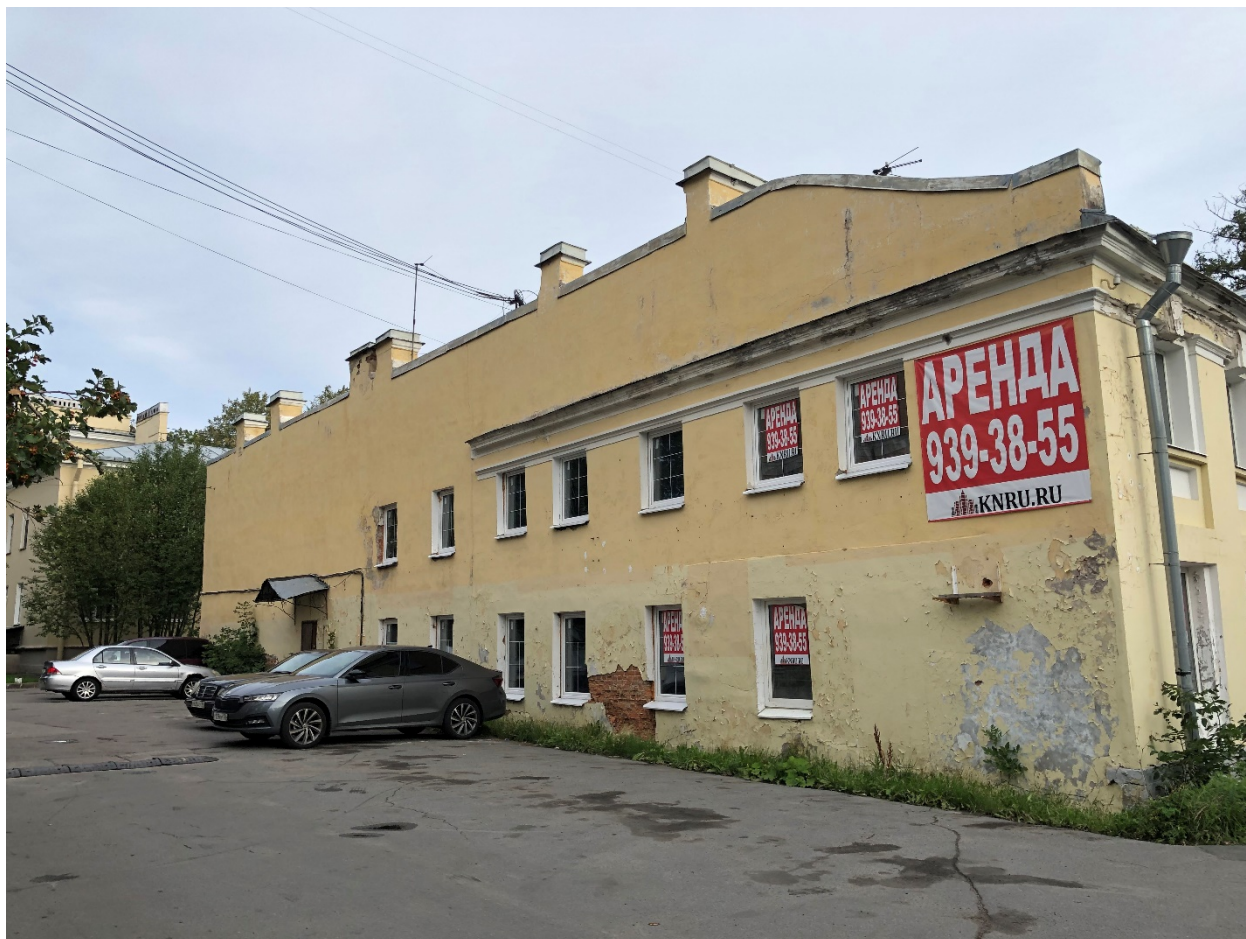
Фото 8. Общий вид южного дворового фасада флигеля. Вид с юго-востока.
