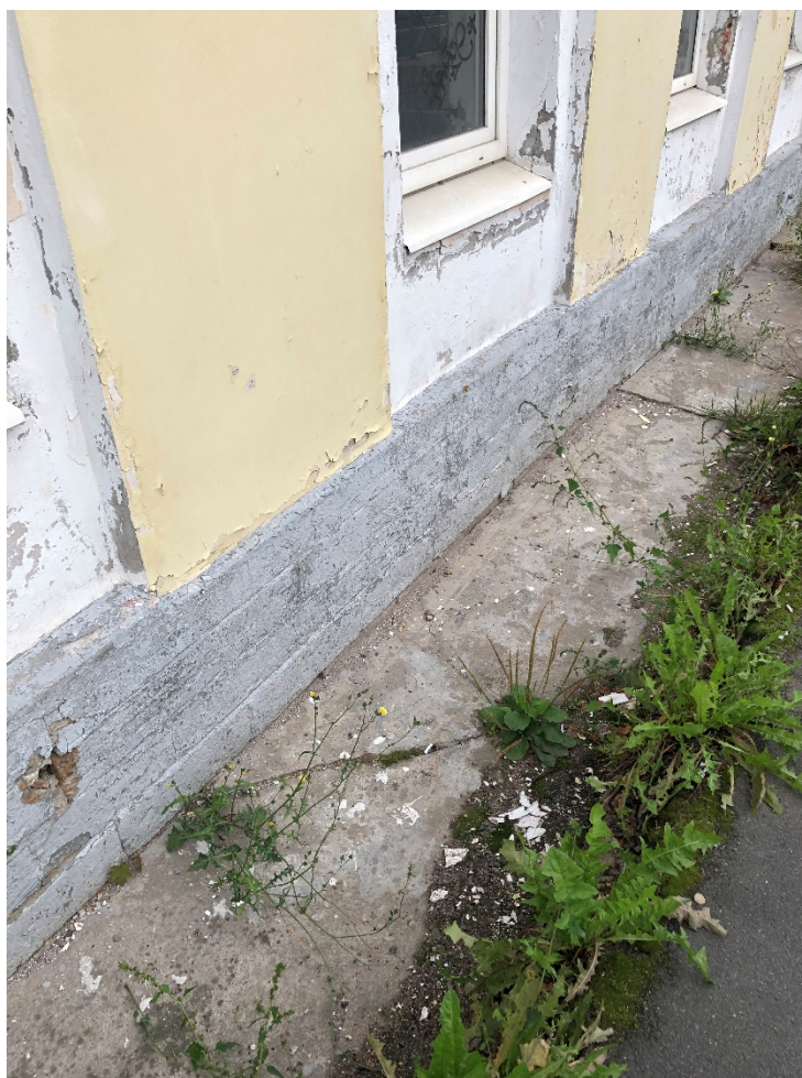
Фото 3. Бетонная отмостка со стороны восточного фасада флигеля.
