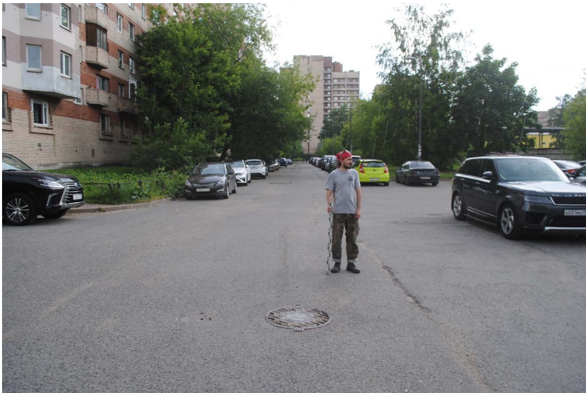
Рис. 19. Санкт-Петербург, улица Двинская 16к3 – 10к5. Общий вид трассы. Точка съемки 6. Вид на запад
