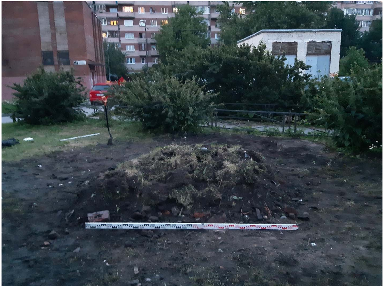
Рис. 32. Санкт-Петербург, улица Двинская 16к3 – 10к5. Шурф 1. Фотофиксация после рекультивации. Вид на север
