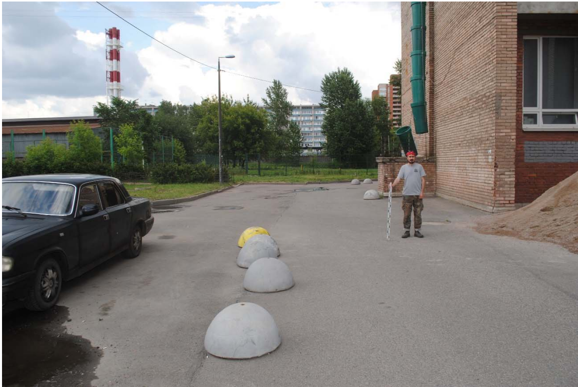
Рис. 14. Санкт-Петербург, улица Двинская 16к3 – 10к5. Общий вид трассы. Точка съемки 3. Вид на восток
