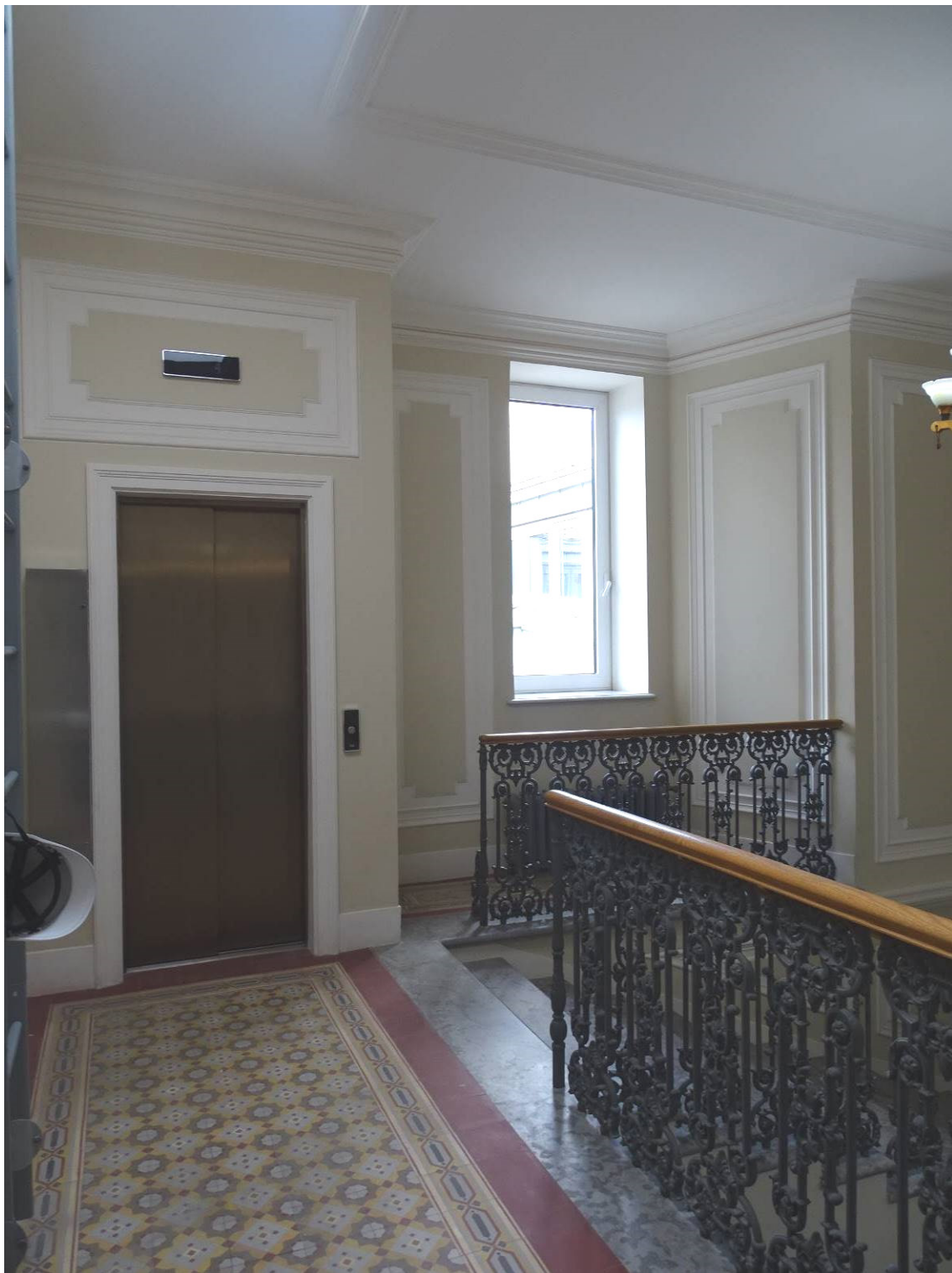
Илл. 09. Лестничная площадка 4-го этажа. Съемка 08.06.2021 г. Трушковский В. Э.
