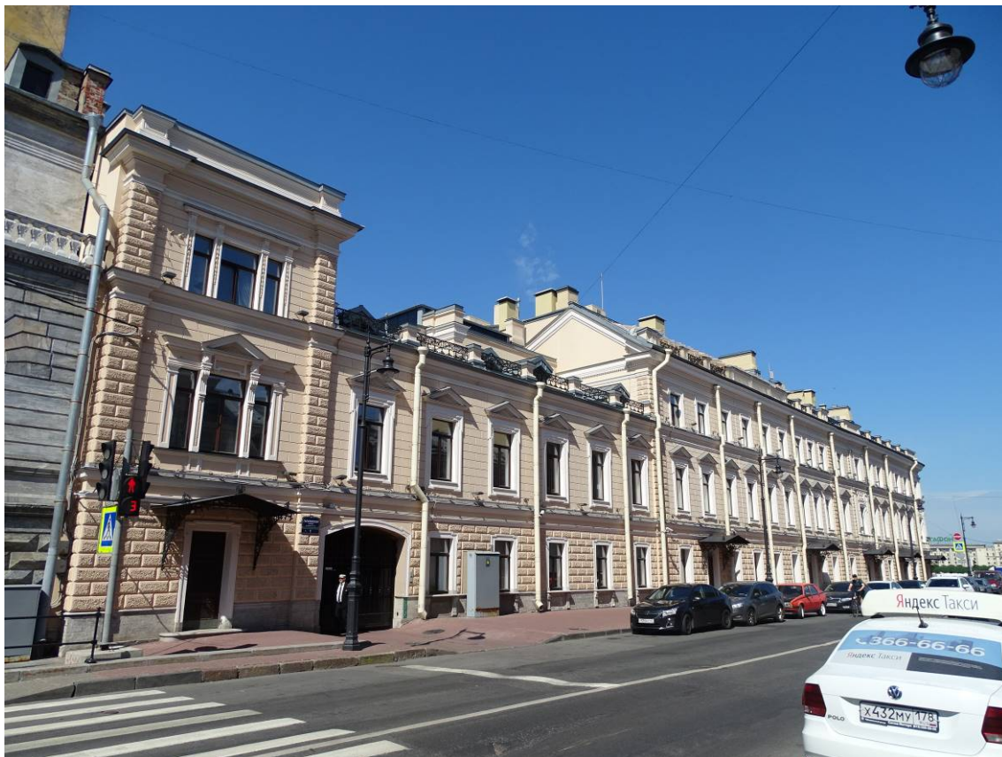
Илл. 01. Объект культурного наследия федерального значения «Дом Кушелева-Безбородко Г.А. (Елисеева А.Г.) с дворовыми флигелями». Вид на здание с Гагаринской ул. с южной стороны. Съемка 08.06.2021 г. Трушковский В. Э.
