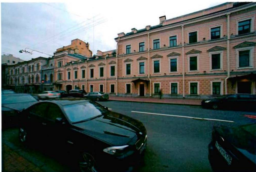
3. Фрагмент восточного фасада объекта культурного наследия.
