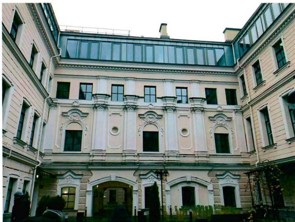
4. Фрагмент дворового фасада объекта культурного наследия. Южный фасад северного двора.
