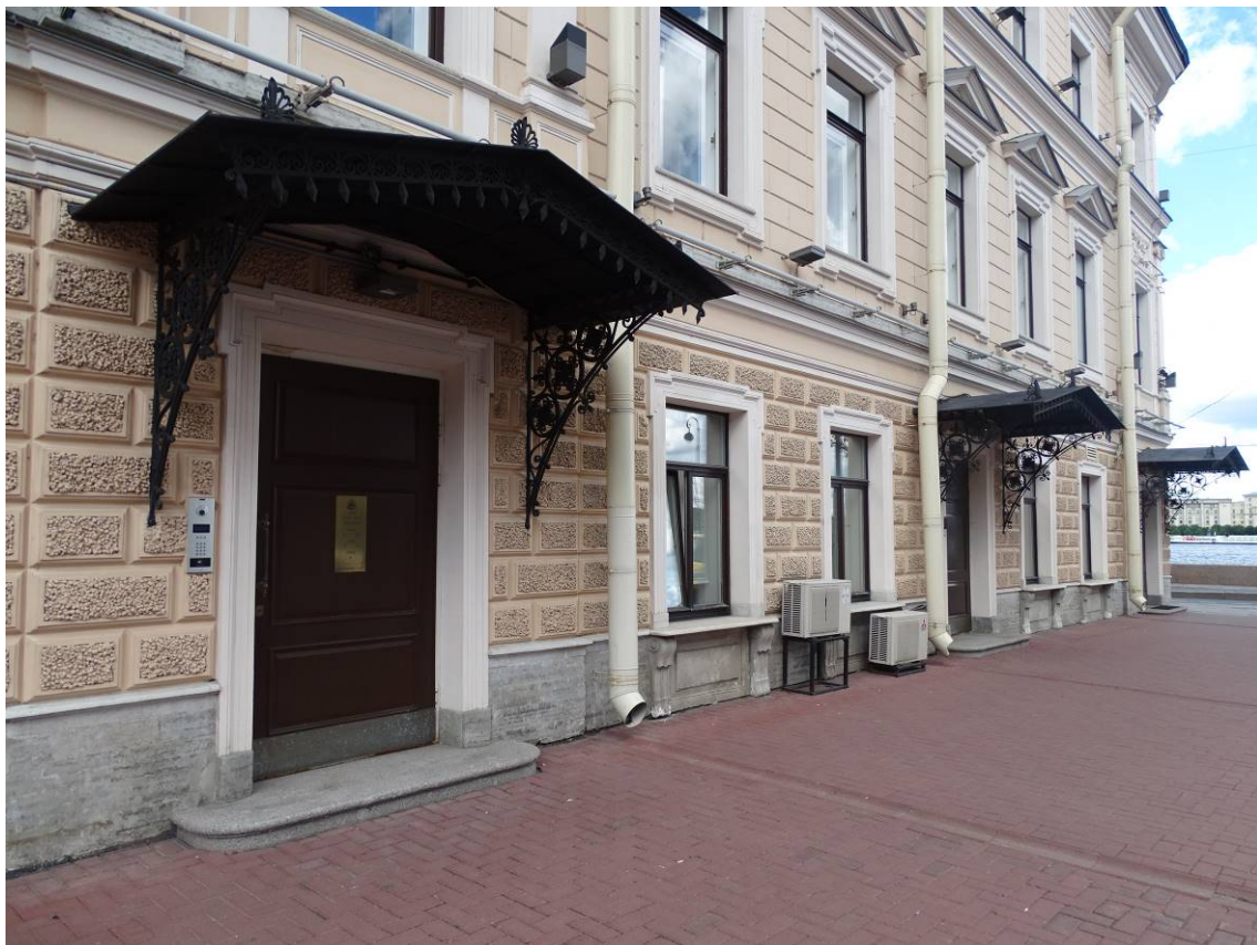
Илл. 03. Фрагмент лицевого фасада по Гагаринской ул. Вход на лестницу ЛК-2. Съемка 08.06.2021 г. Трушковский В. Э.
