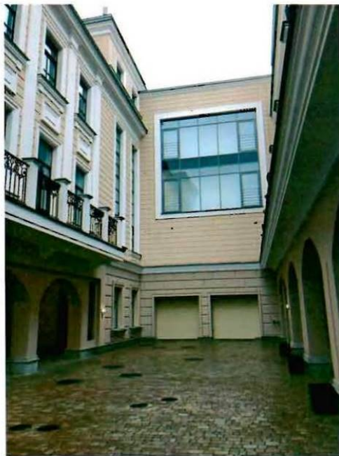
6. Фрагмент дворового фасада объекта культурного наследия. Западный фасад южного двора
