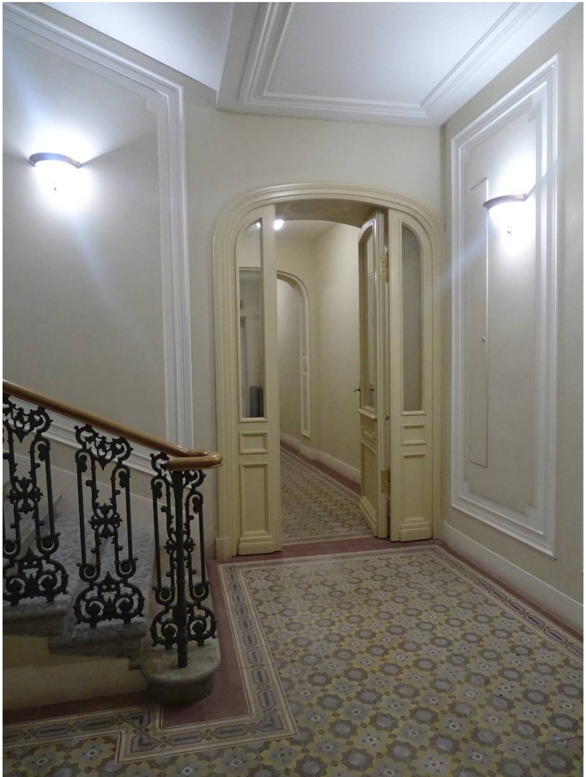
Илл. 06. Лестница ЛК-2. Вестибюль 1-го этажа. Съемка 08.06.2021 г. Трушковский В. Э.
