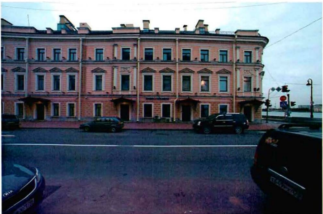
2. Фрагмент восточного фасада объекта культурного наследия.
