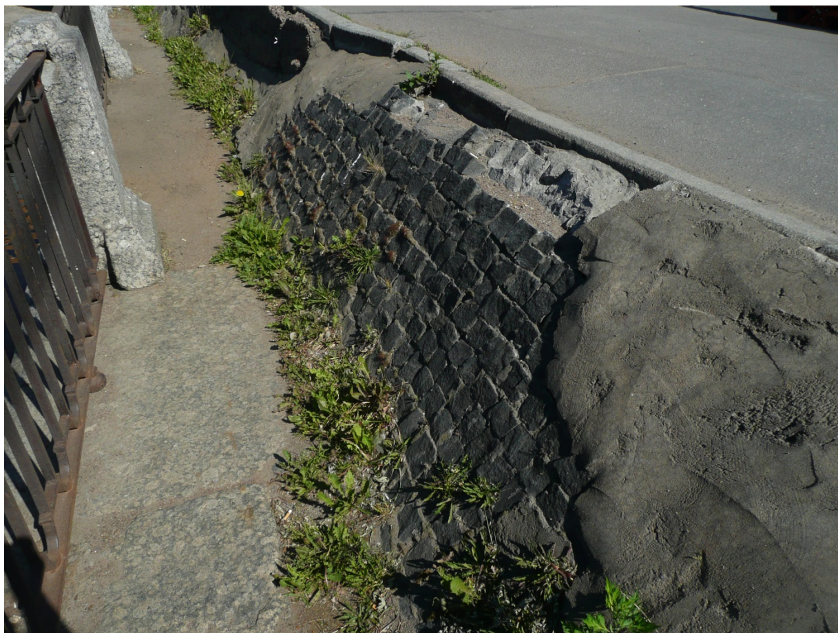
Фото 44. Фрагмент откоса набережной.
