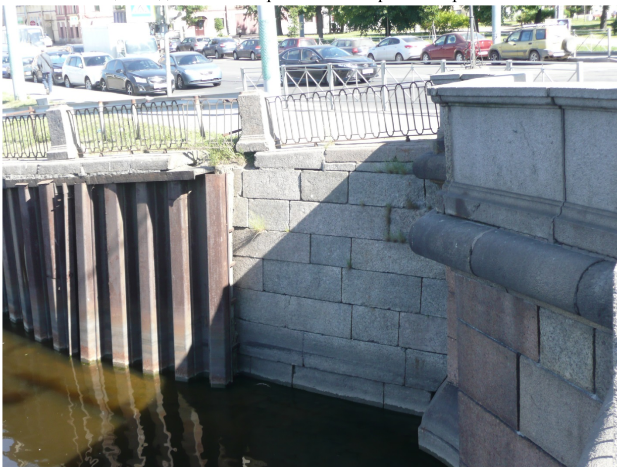
Фото 30. Участок примыкания стенки набережной к устью Старо-Калинкина моста.
