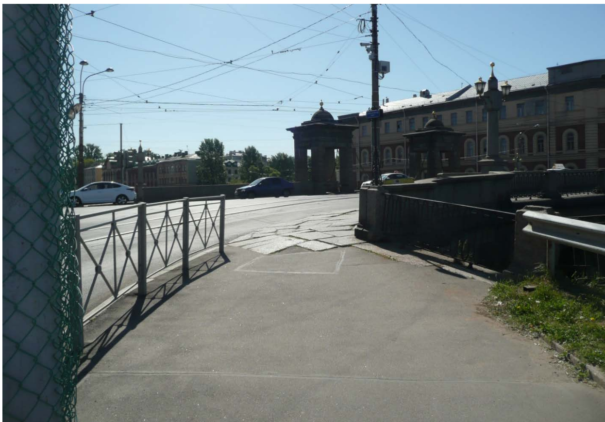
Фото 35. Участок примыкания тротуаров набережной и Старо-Калинкина моста.
