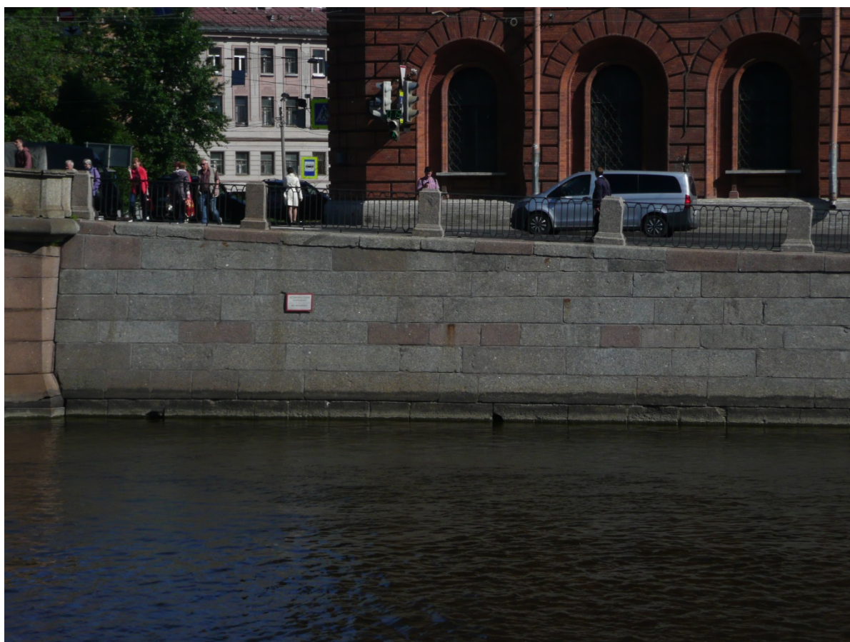
Фото 4. Фрагмент стенки набережной.
