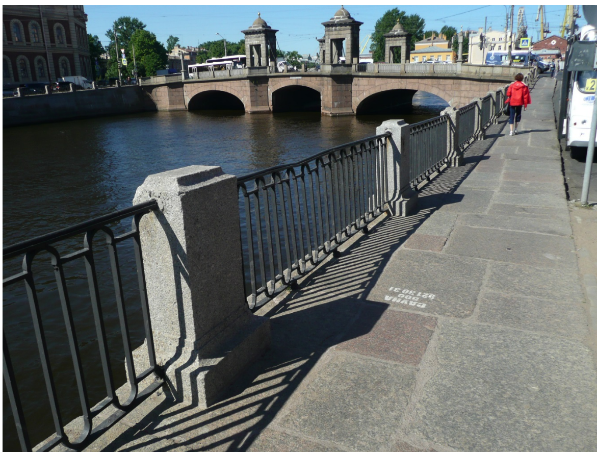
Фото 21-22. Общий вид ограждения и тротуара набережной.
