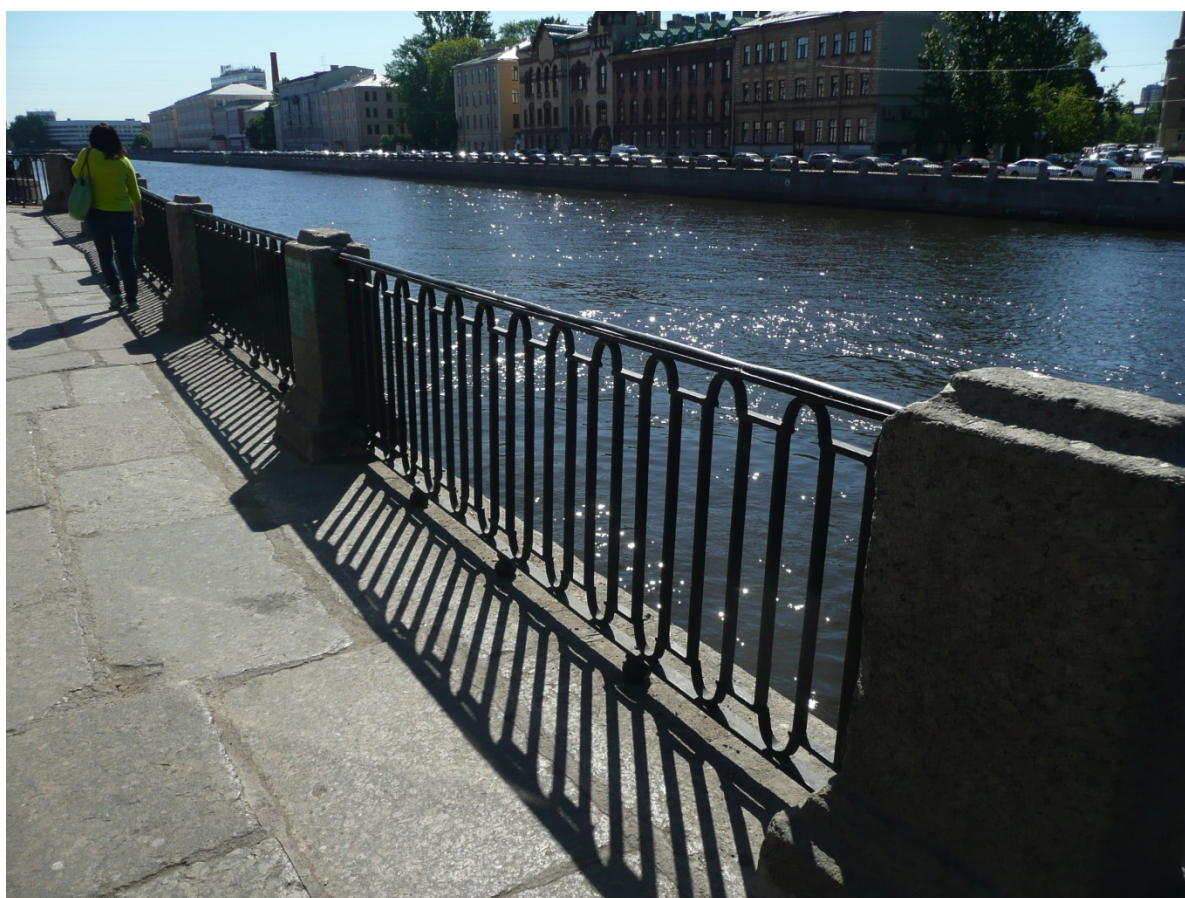
Фото 17-18. Общий вид ограждения и тротуара набережной.
