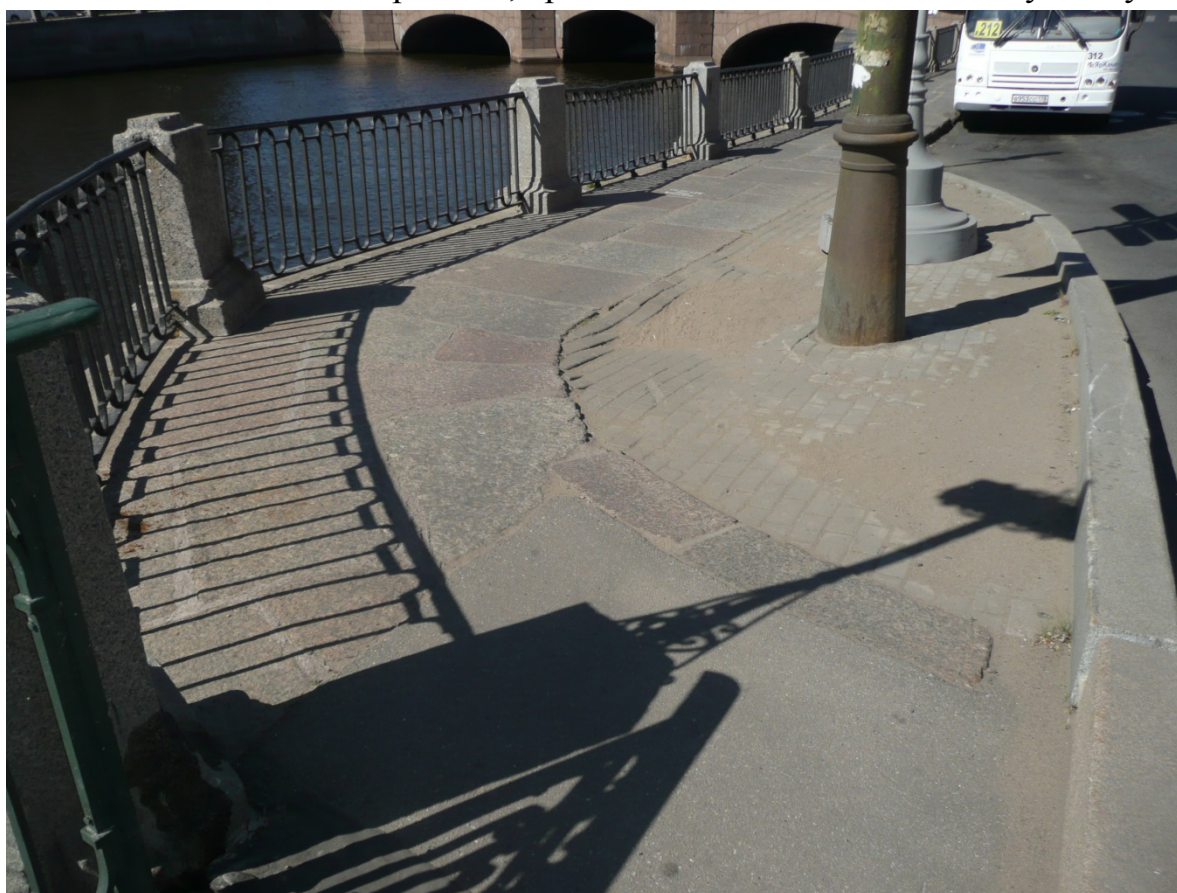
Фото 20. Покрытие тротуара на участке набережной, примыкающем к Мало-Калинкину мосту.
