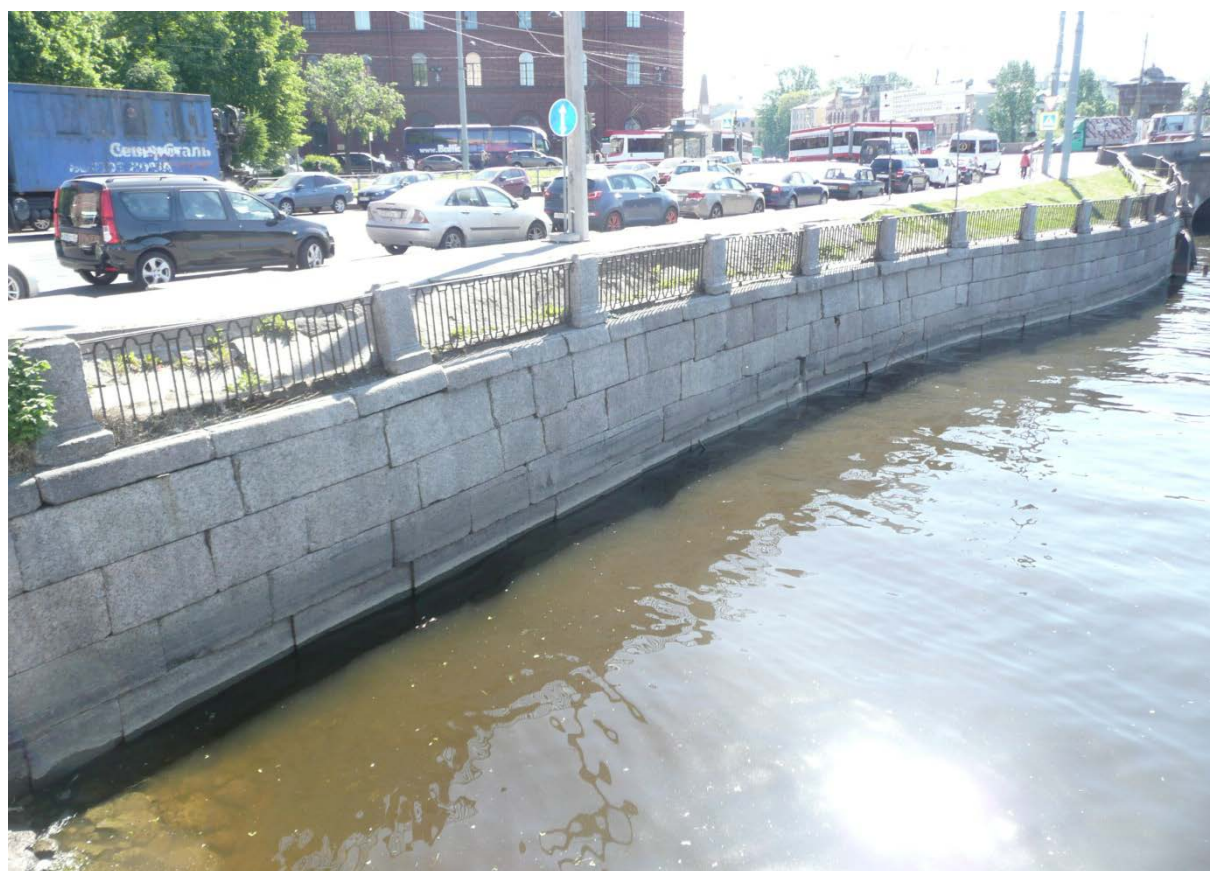
Фото 31-32. Фрагменты стенки набережной (вид от здания «Адмиралтейские верфи» по наб. р. Фонтанки, д. 203).
