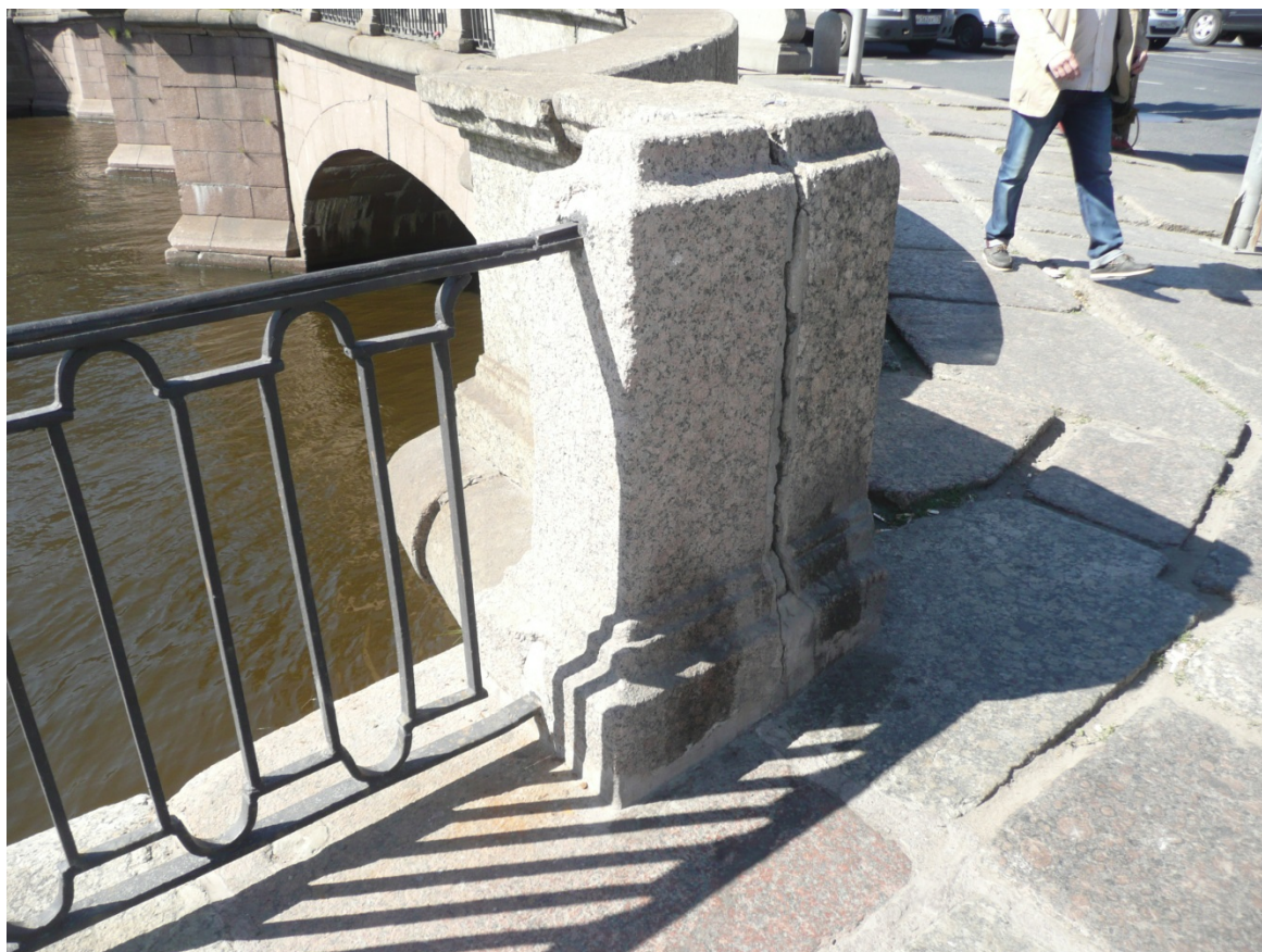
Фото 14. Участок примыкания ограждения набережной к Старо-Калинкину мосту.
