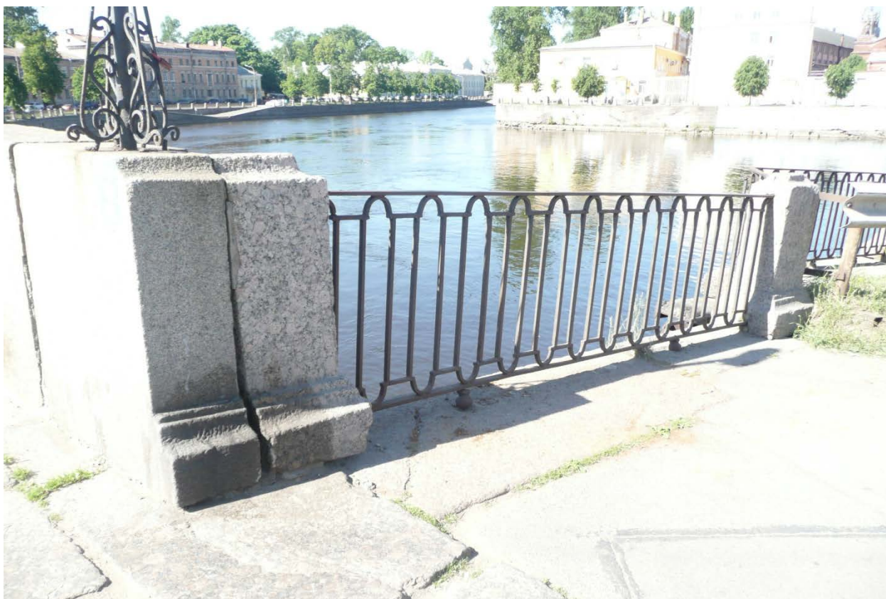
Фото 36. Фрагмент ограждения на участке примыкания тротуаров.
