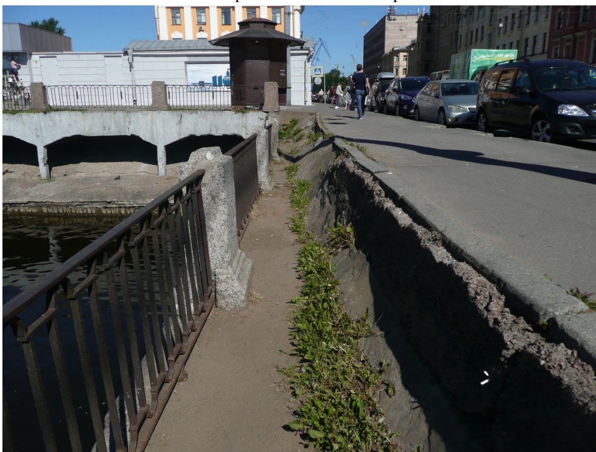
Фото 45. Фрагмент откоса набережной.
