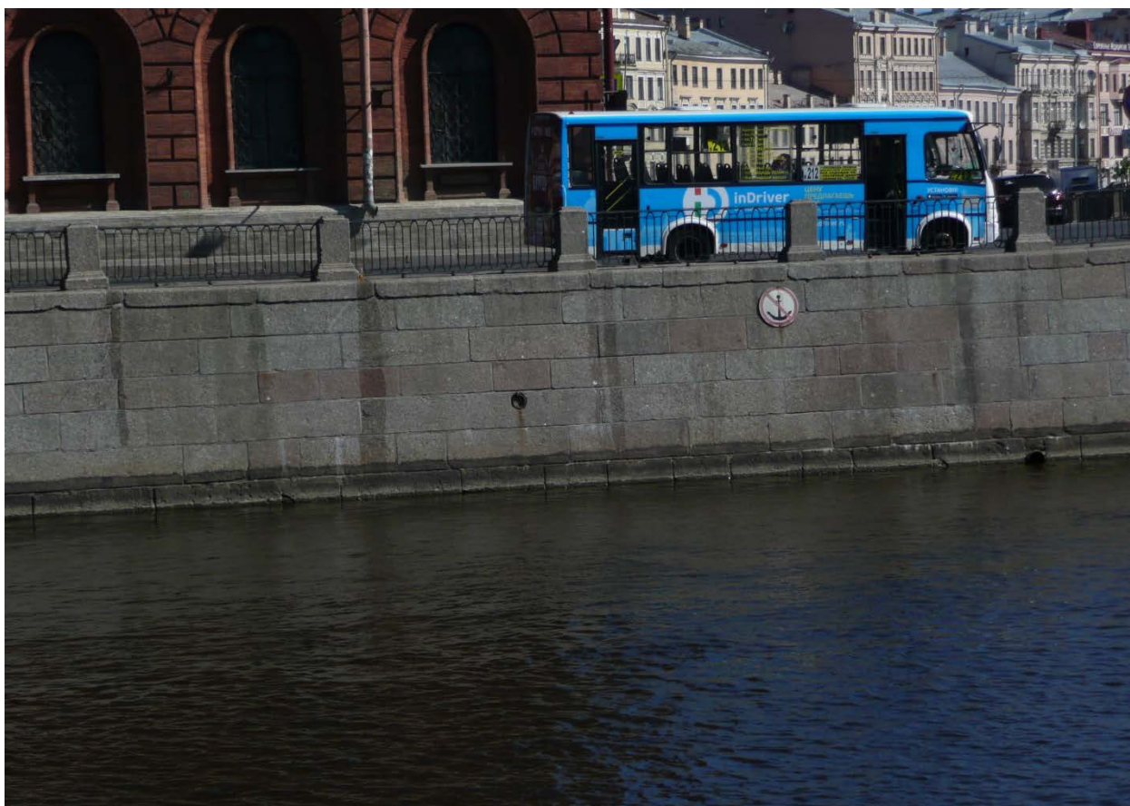
Фото 5-6. Фрагмент стенки набережной.
