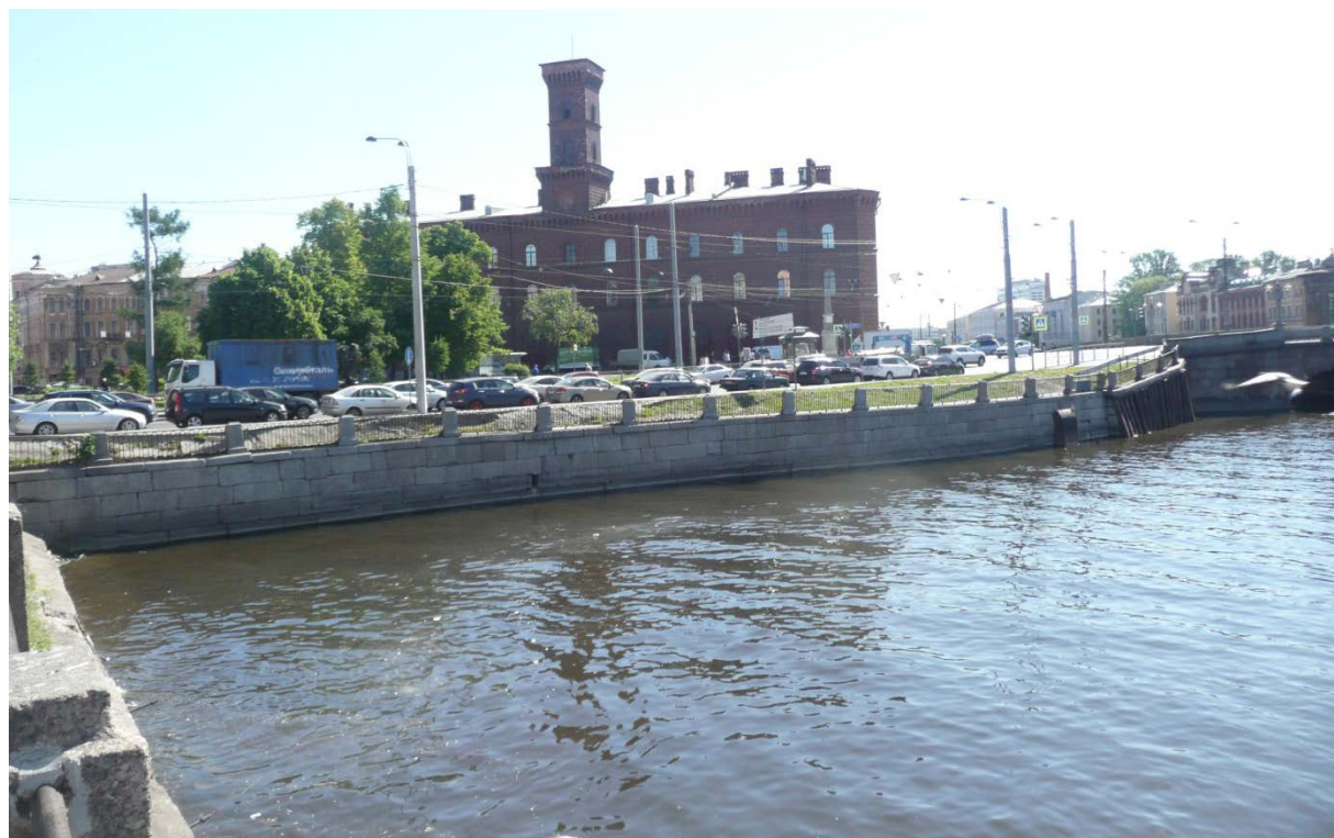
Фото 23-24. Участок набережной р. Фонтанки (правый берег), прилегающий к устью Старо-Калинкина моста. Общий вид.
