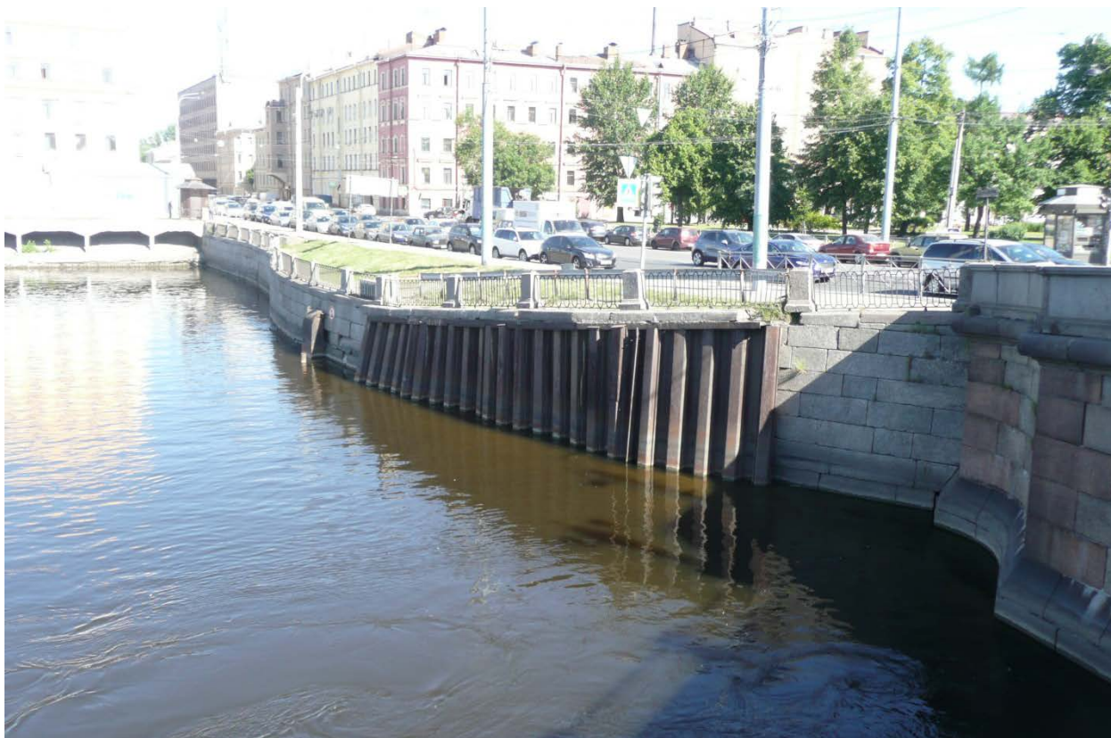
Фото 29. Общий вид стенки набережной со стороны Старо-Калинкина моста.
