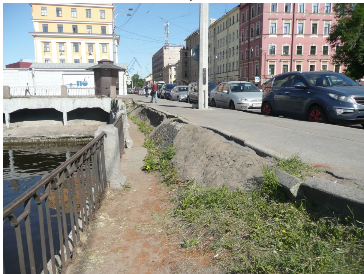
Фото 43. Откос между стенкой набережной и тротуаром.
