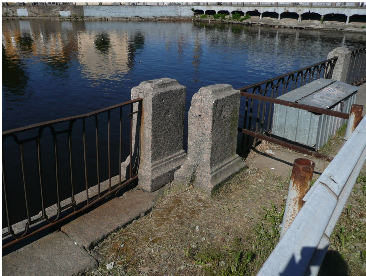
Фото 39. Парапетные тумбы ограждения.
