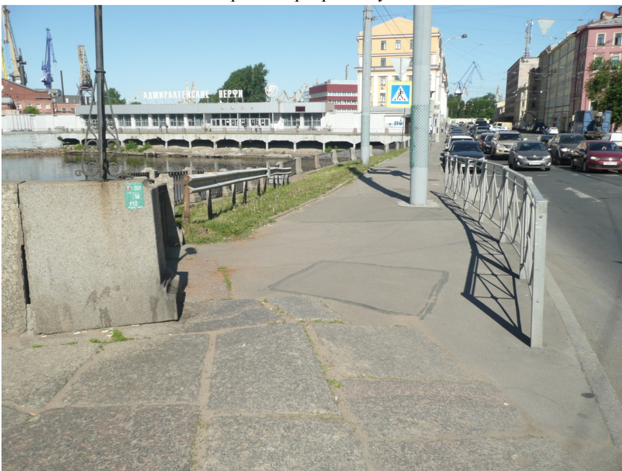
Фото 34. Участок примыкания тротуаров набережной и Старо-Калинкина моста.
