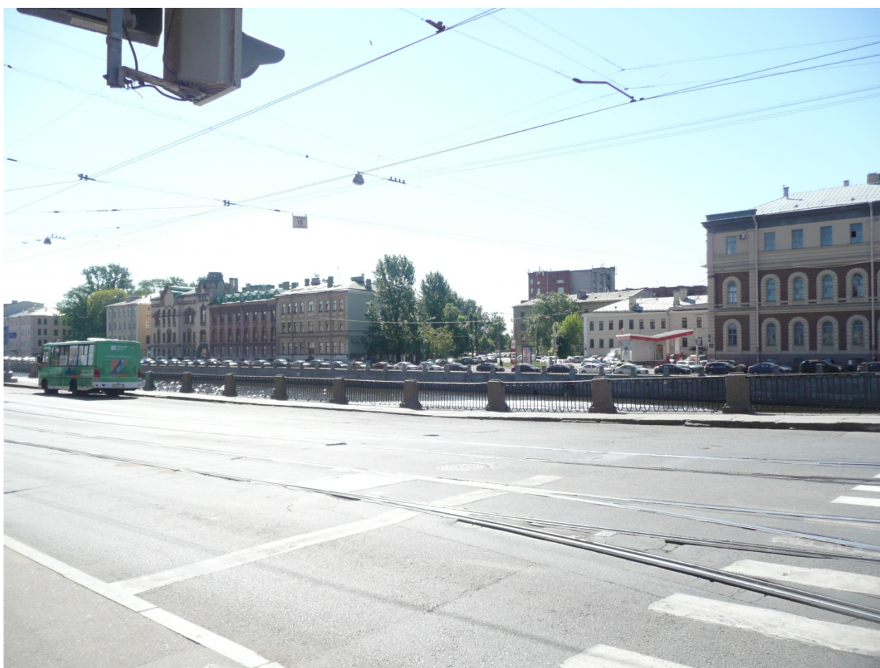
Фото 11-12. Общий вид участка набережной со стороны проезжей части набережной р. Фонтанки.
