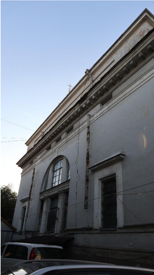
Фото 3,4. Дворовый южный фасад.
