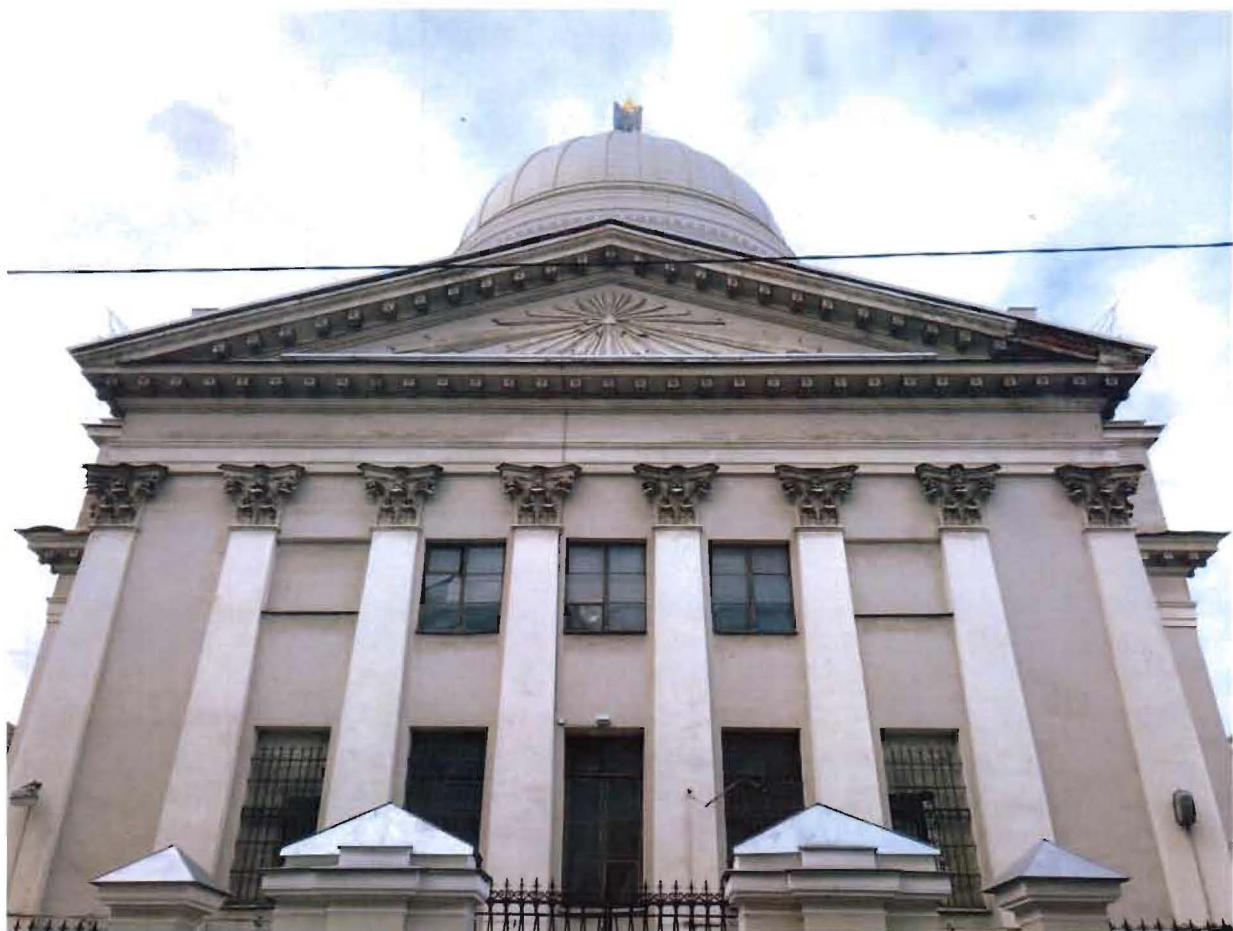
5. Северо-восточный фасад объекта культурного наследия.
