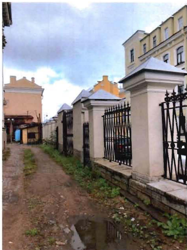
16. Фрагмент ограды вдоль Тучкова переулка. Юго-западный фасад.
