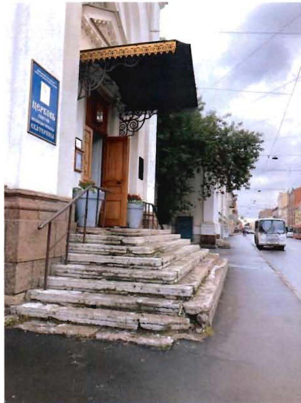
2. Юго-западный фасад объекта культурного наследия. Главный вход.
