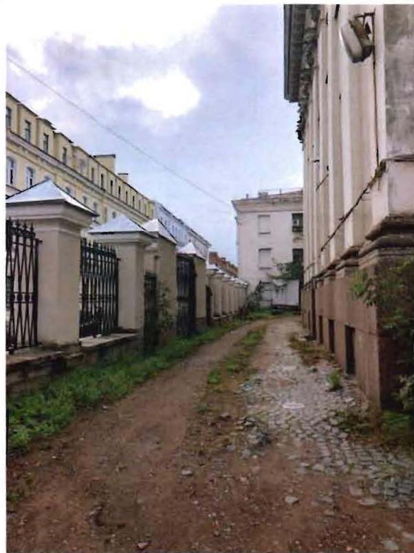
21. Фрагмент территории объекта культурного наследия со стороны северо-восточного фасада церкви.
