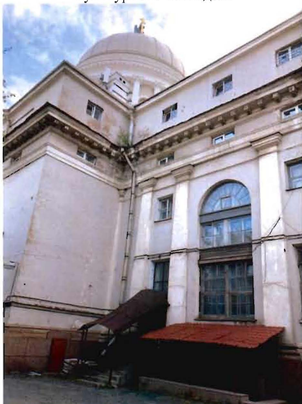
3. Фрагмент северо-западного фасада объекта культурного наследия.
