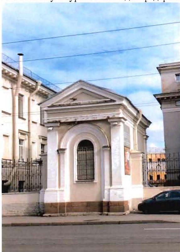
11. Юго-западный фасад северо-западной Часовни.
