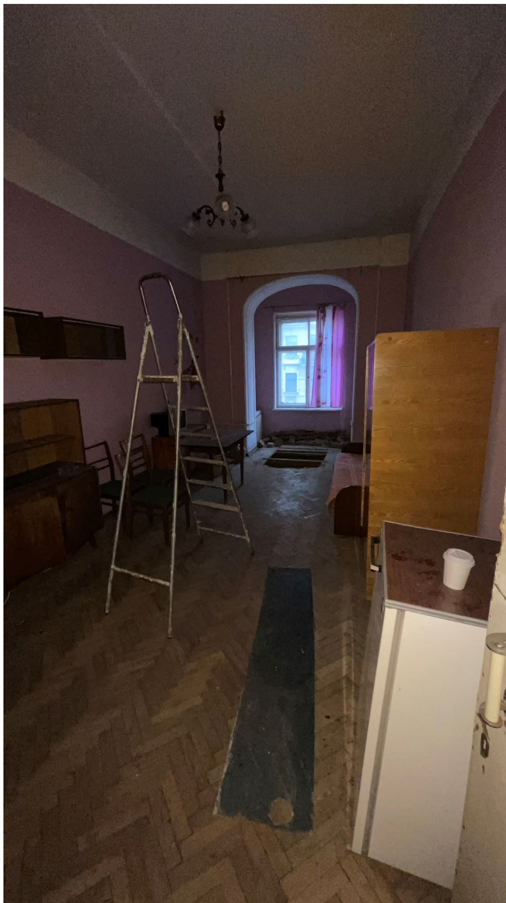
15. Фрагмент интерьера комнаты (помещение 9/28.0);
