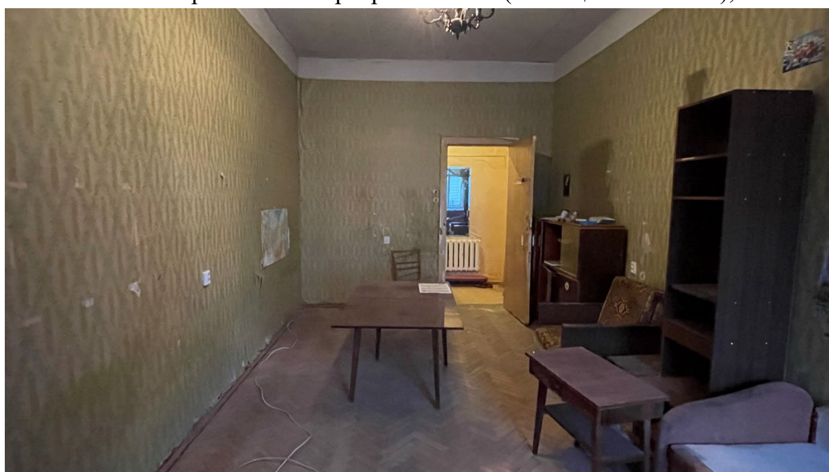
6. Фрагмент интерьера комнаты (помещение 12/22.8);
