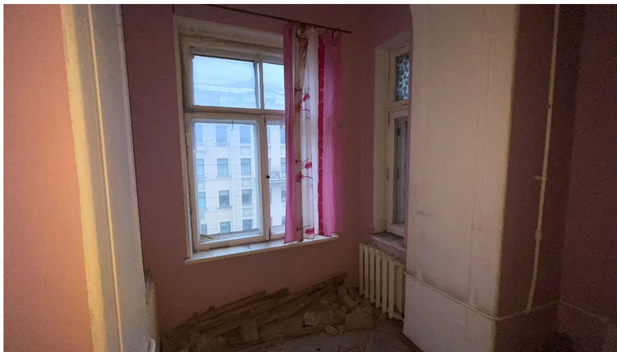
17.Фрагмент интерьера комнаты (помещение 9/28.0);
