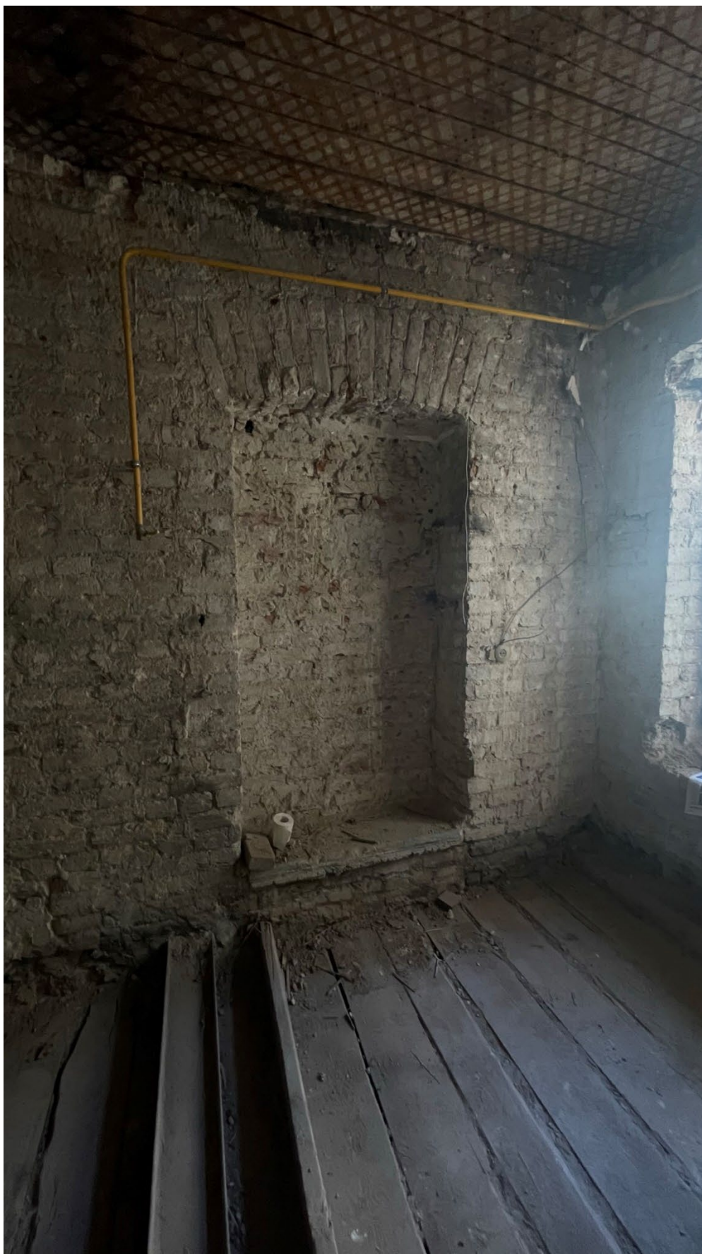
7. Ниша в помещении кухни (помещение 2/12.5);
