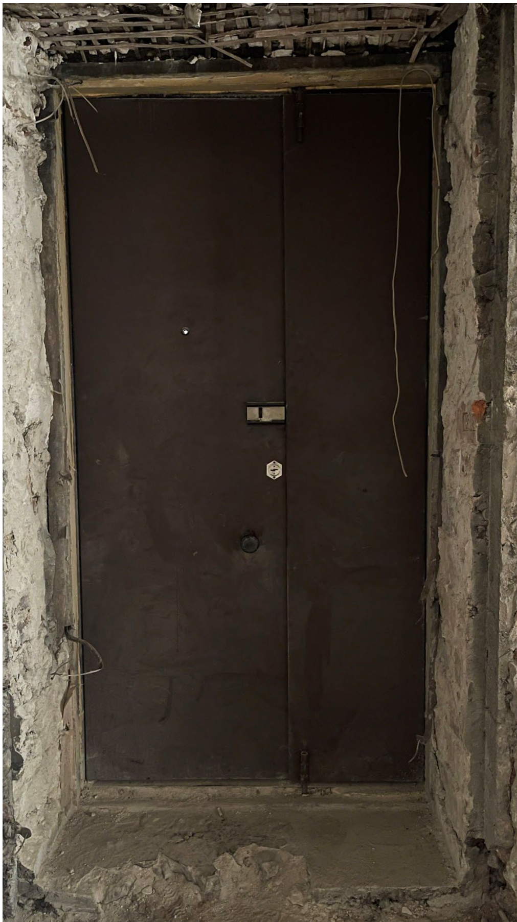
4. Вид на входную дверь в квартире;
