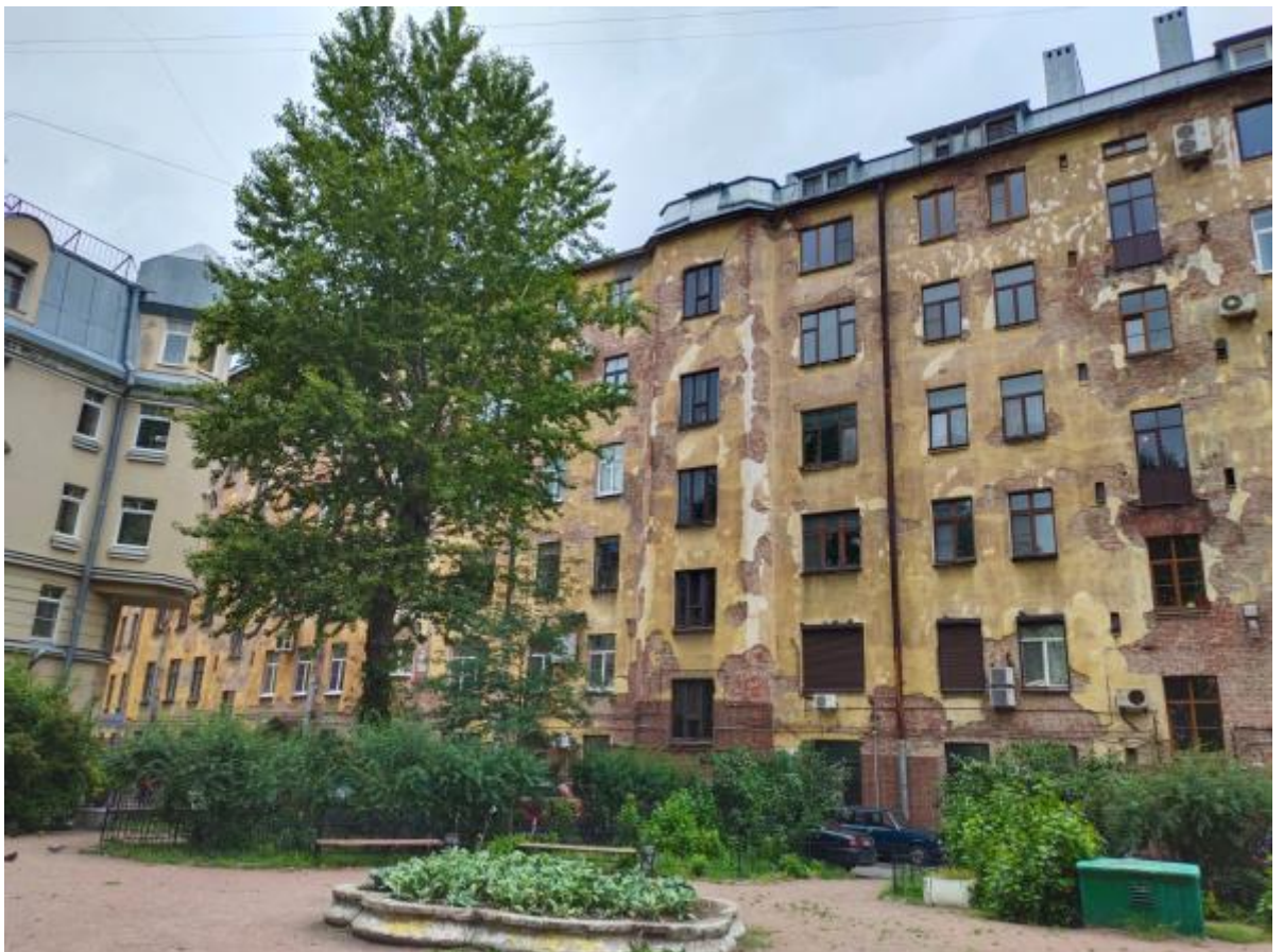
8. Объект культурного наследия регионального значения «Бывший дом Толстого (фасады)» (г. Санкт-Петербург, Фонтанки р. наб., 54; Рубинштейна ул., 15-17). Дворовый фасад со стороны Щербакова переулка.
