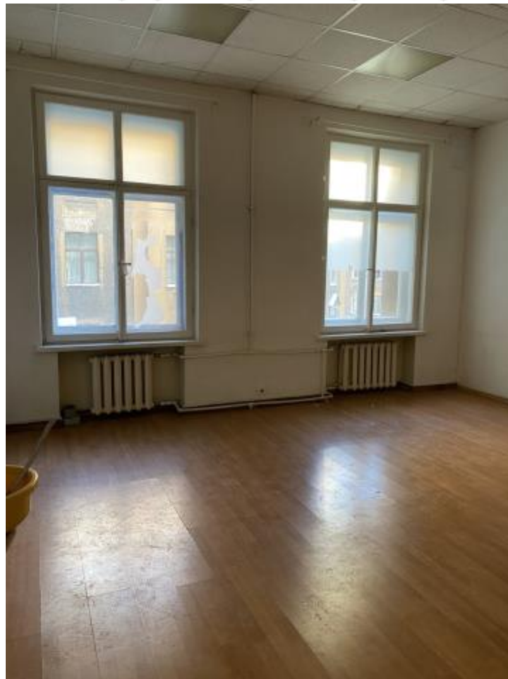
13. Объект культурного наследия регионального значения «Бывший дом Толстого (фасады)» (г. Санкт-Петербург, Фонтанки р. наб., 54; Рубинштейна ул., 15-17). Помещение квартиры № 460.
