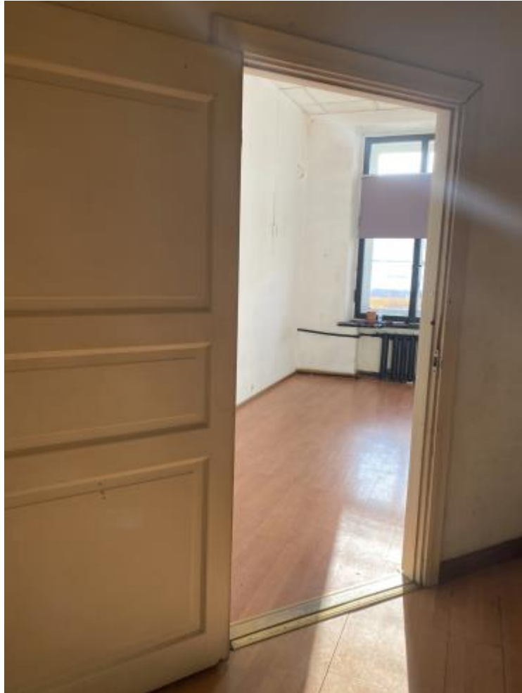
16. Объект культурного наследия регионального значения «Бывший дом Толстого (фасады)» (г. Санкт-Петербург, Фонтанки р. наб., 54; Рубинштейна ул., 15-17). Помещение квартиры № 460.
