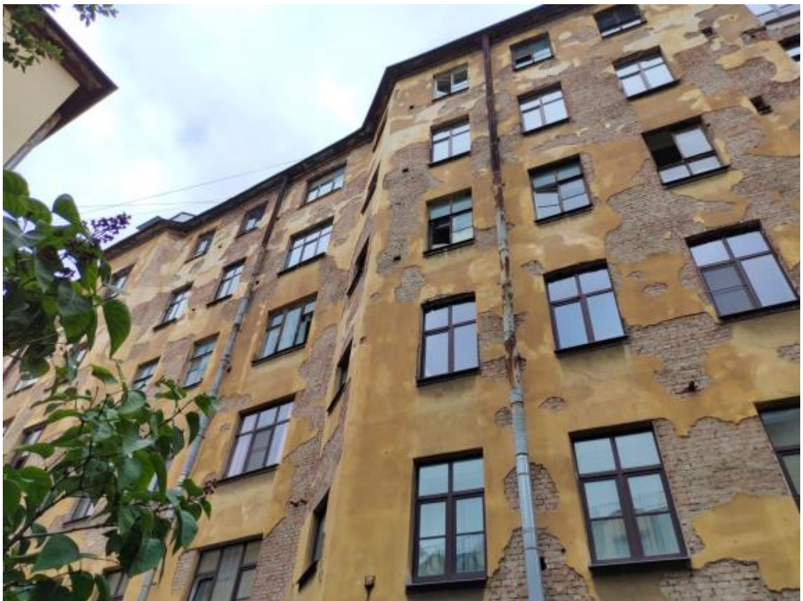
7. Объект культурного наследия регионального значения «Бывший дом Толстого (фасады)» (г. Санкт-Петербург, Фонтанки р. наб., 54; Рубинштейна ул., 15-17). Дворовый фасад со стороны Щербакова переулка.
