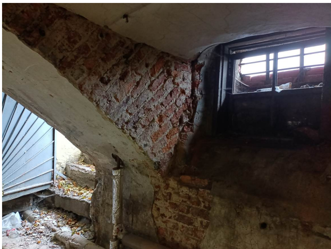
Фото 4. Точка 4 – пом. №2 (существующий оконный проем)
