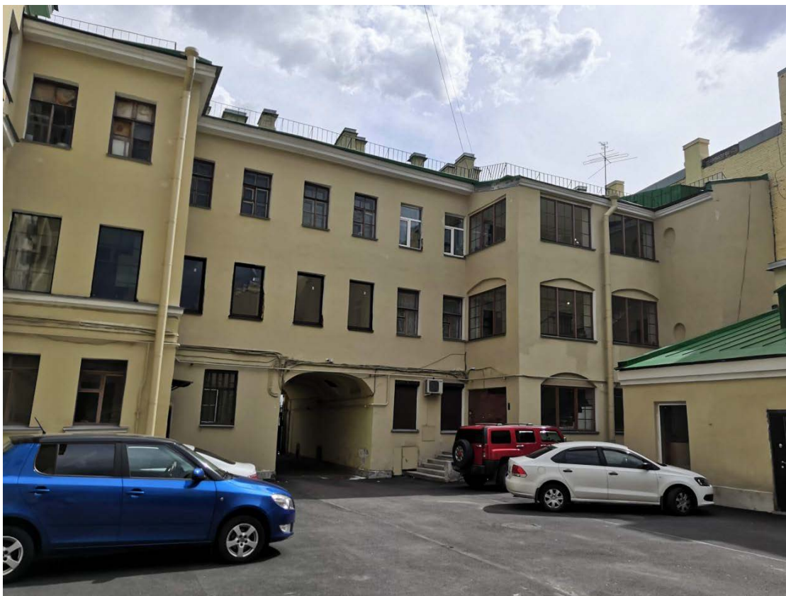
Фото 11. Точка 11 – Общий вид дворового фасада здания
