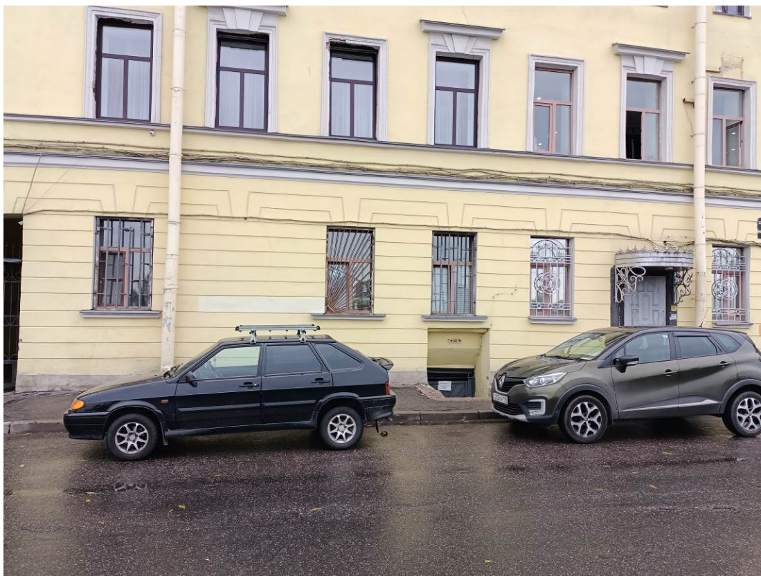
Фото 4. Точка 4 – Фрагмент лицевого фасада здания
