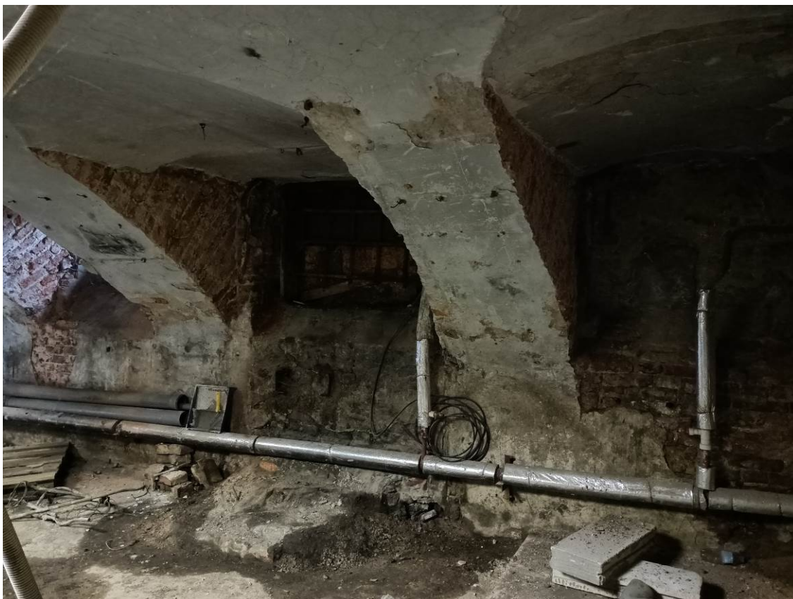
Фото 3. Точка 3 – пом. №2 (заложенный со стороны фасад оконный проем)
