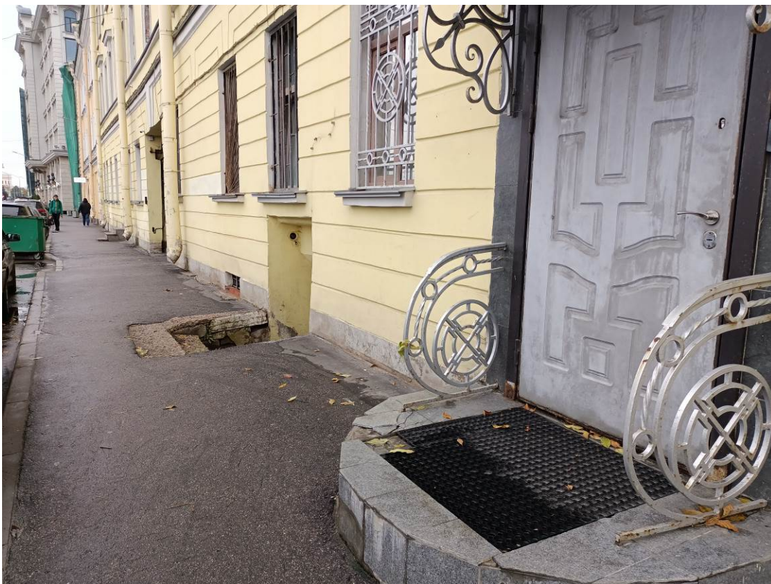
Фото 5. Точка 5 – Фрагмент лицевого фасада здания
