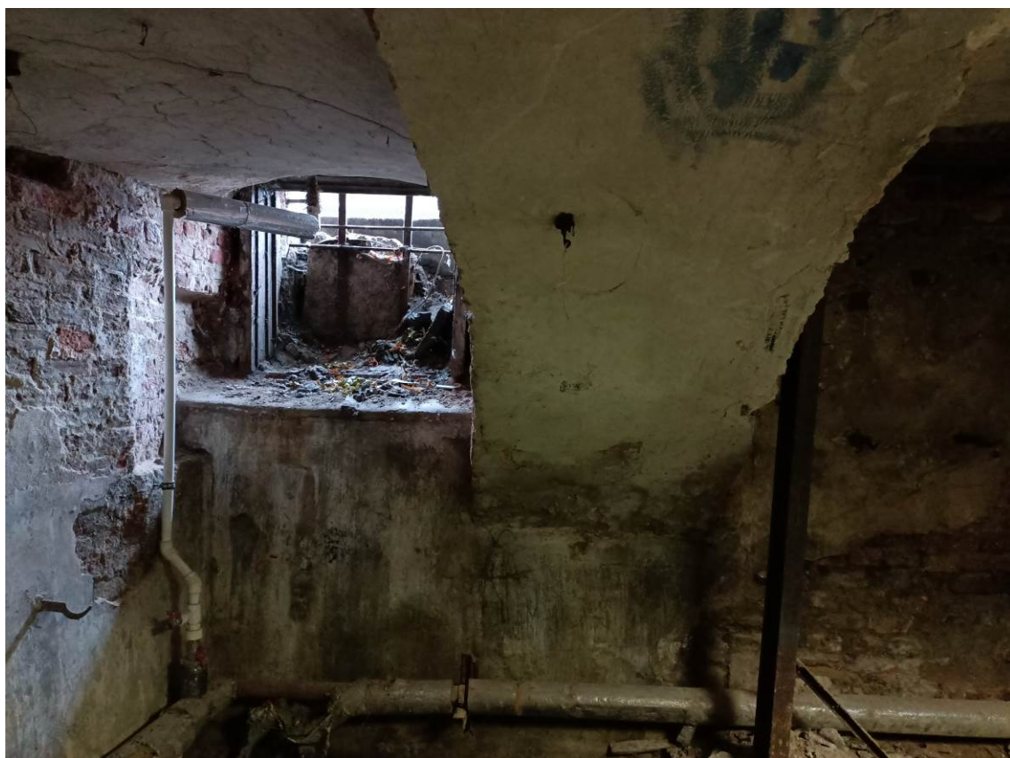
Фото 12. Точка 12 – пом. №1 (существующий оконный проем)
