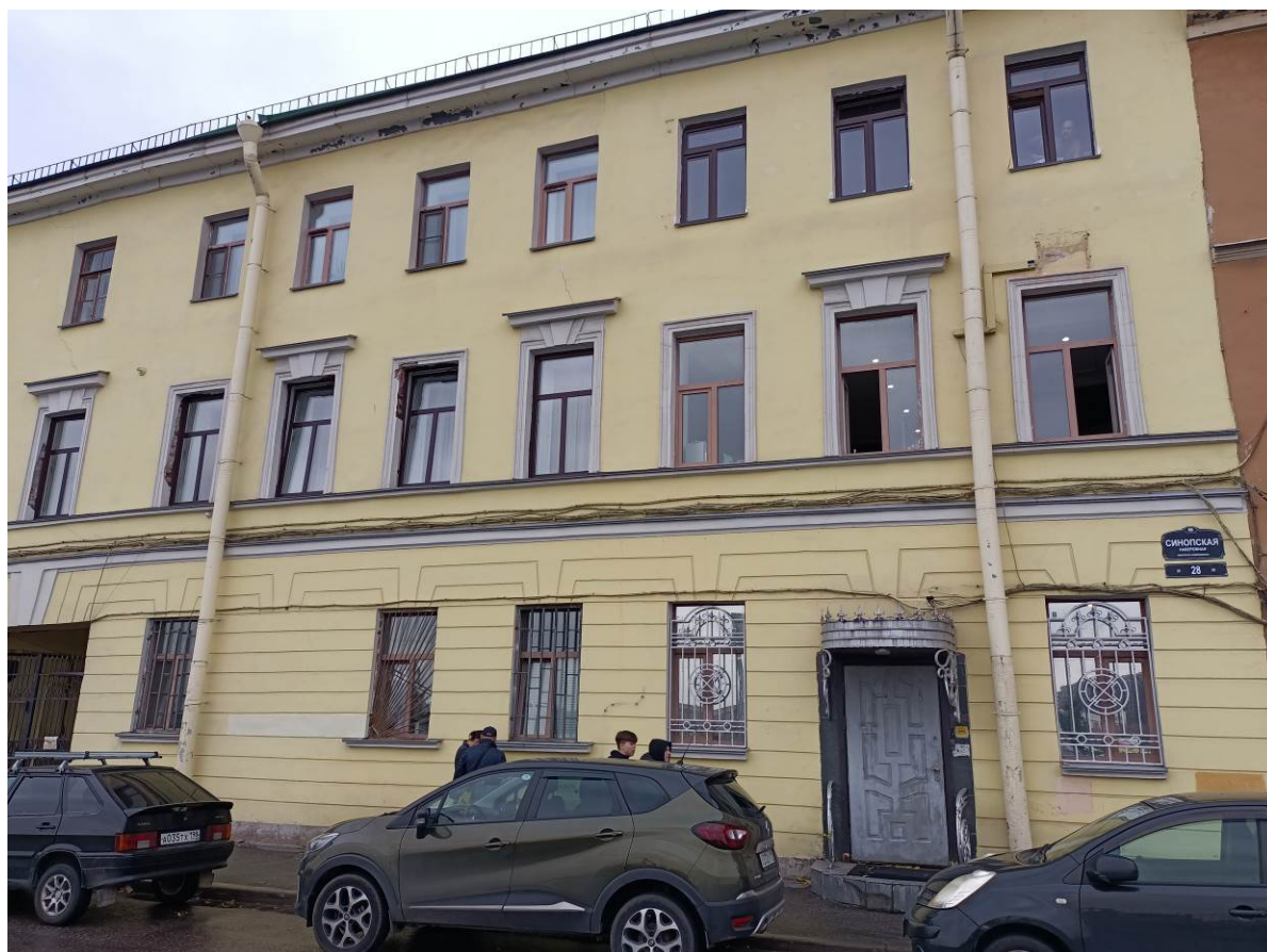
Фото 2. Точка 2 – Общий вид лицевого фасада здания
