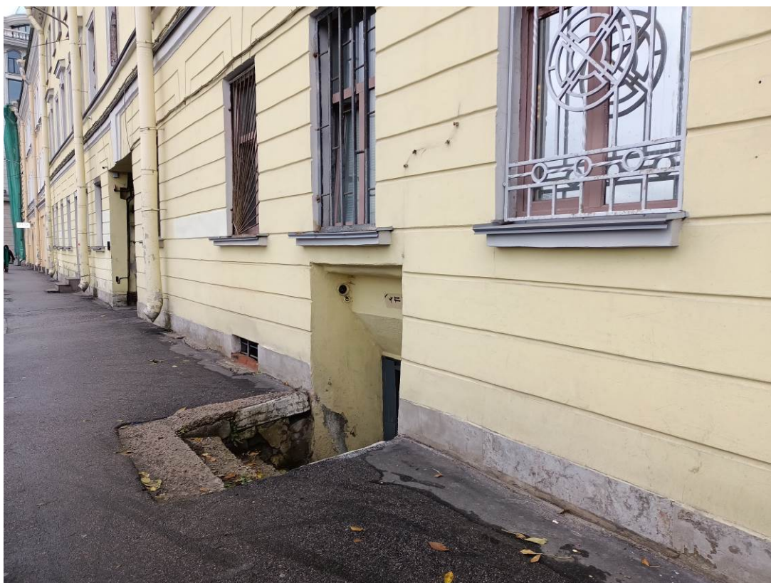
Фото 8. Точка 8 – Фрагмент лицевого фасада здания. Прямок пом. 2-Н
