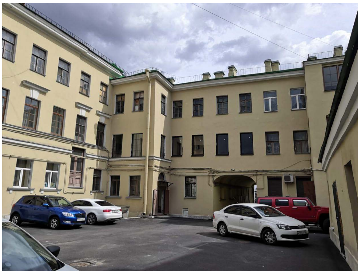
Фото 10. Точка 10 – Общий вид дворового фасада здания
