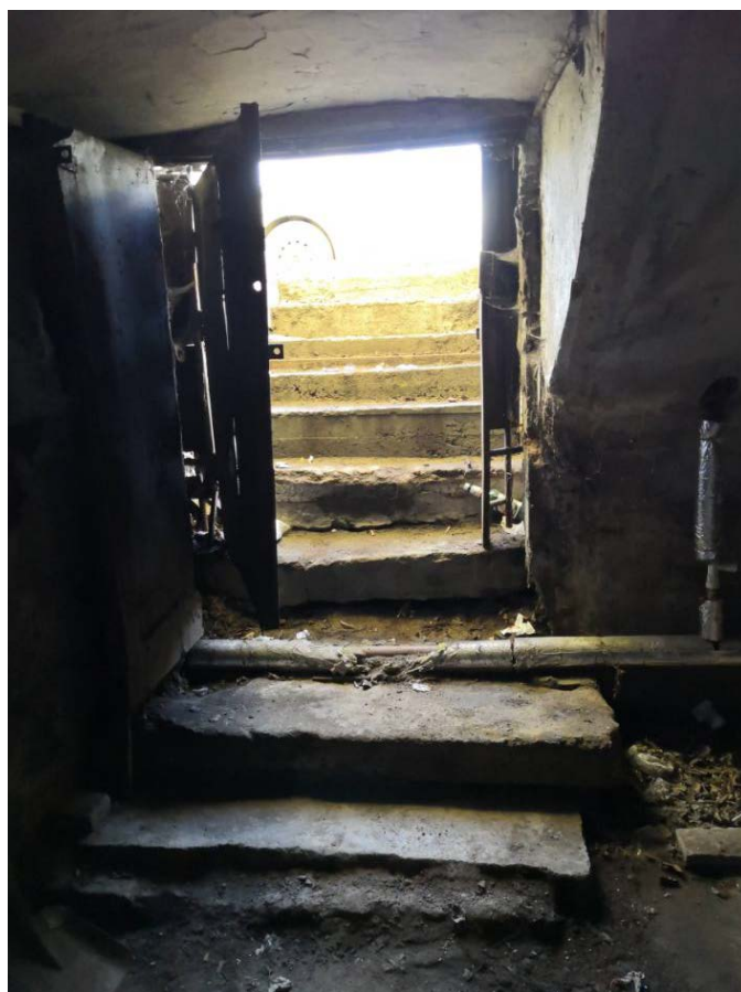
Фото 8. Точка 8 – пом. №2 (дверной проем)
