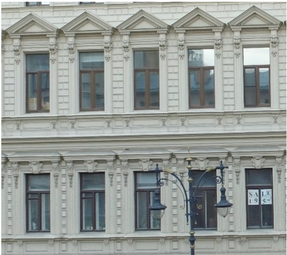
9. Восточный лицевой фасад объекта культурного наследия регионального значения «Дом Вейнера П.П.», расположенного по адресу: г. Санкт-Петербург, ул. Чайковского, д. 38/9, литера А. Фрагмент. 28.04.2022
