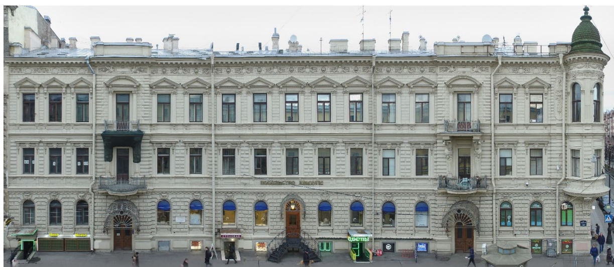
1. Южный лицевой фасад объекта культурного наследия регионального значения «Дом Вейнера П.П.», расположенного по адресу: г. Санкт-Петербург, ул. Чайковского, д. 38/9, литера А. 28.04.2022
