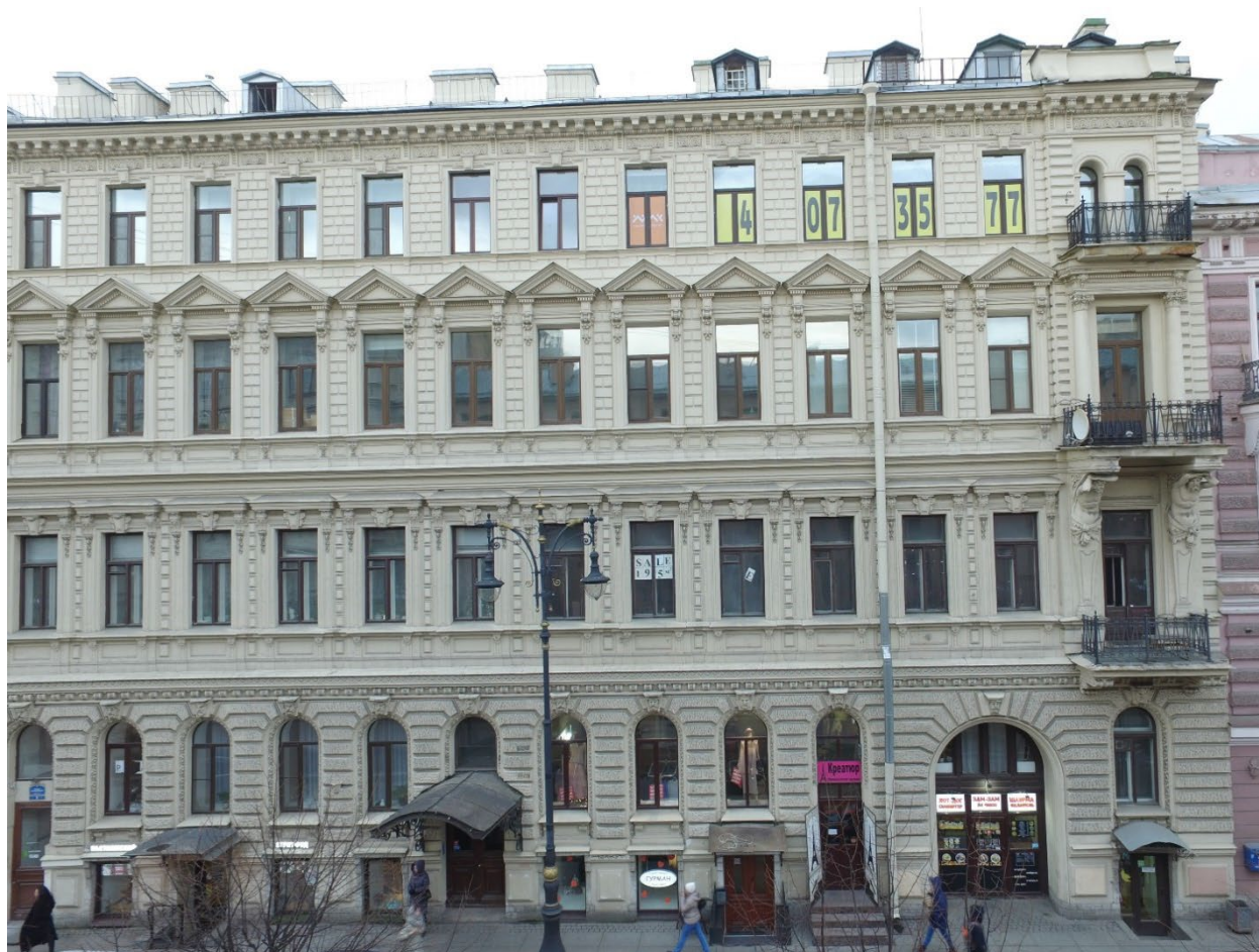
7. Восточный лицевой фасад объекта культурного наследия регионального значения «Дом Вейнера П.П.», расположенного по адресу: г. Санкт-Петербург, ул. Чайковского, д. 38/9, литера А. Фрагмент. 28.04.2022
