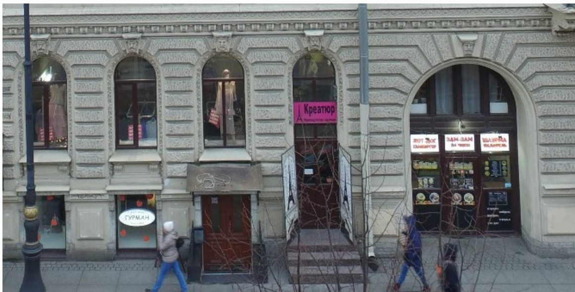
10. Восточный лицевой фасад объекта культурного наследия регионального значения «Дом Вейнера П.П.», расположенного по адресу: г. Санкт-Петербург, ул. Чайковского, д. 38/9, литера А. Фрагмент. 28.04.2022
