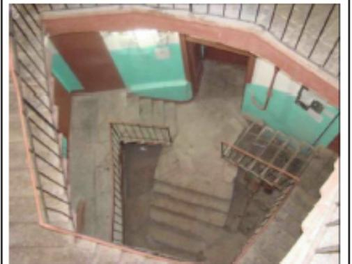
боковая (восточная) лестница корпуса по наб. кан. Грибоедова – местоположение, габариты, конфигурация, тип (многомаршевая), конструкция (на косоурах), материал ступеней («путиловская» плита), ограждение – материал (металл), техника исполнения (литье), рисунок; поручень – материал (дерево), профиль;
