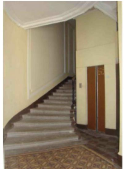
лестница корпуса по Казначейской ул. – местоположение, габариты, конфигурация, тип (многомаршевая), конструкция (на косоурах), материал ступеней («путиловская» плита), ограждение – материал (металл), техника исполнения (литье), рисунок; поручень – материал (дерево), профиль.
