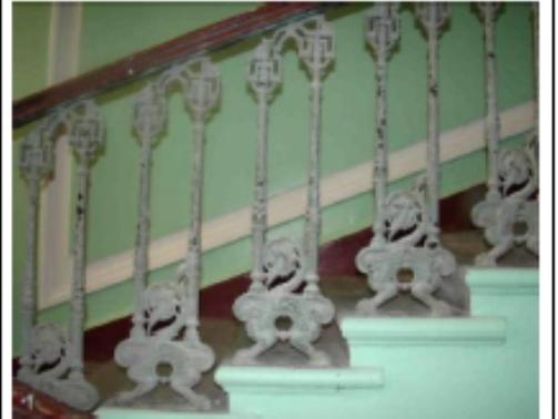
боковая (западная) лестница корпуса по наб. кан. Грибоедова (в осях 2-3) – местоположение, габариты, конфигурация, тип (многомаршевая), конструкция (на косоурах), материал ступеней («путиловская» плита), ограждение – материал (металл), техника исполнения (литье), рисунок; поручень – материал (дерево), профиль;
