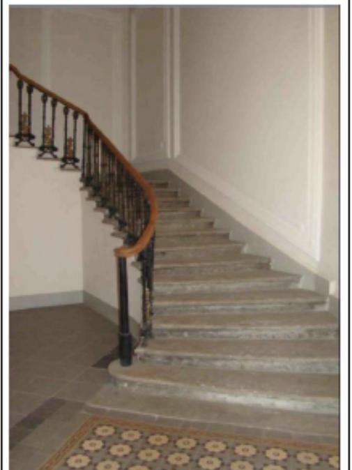
парадная лестница корпуса по наб. кан. Грибоедова (в осях 7-9) – местоположение, габариты, конфигурация, тип (распашная), конструкция (на косоурах), материал ступеней («путиловская» плита), ограждение – материал (металл), техника исполнения (литье), рисунок; поручень – материал (дерево), профиль;
