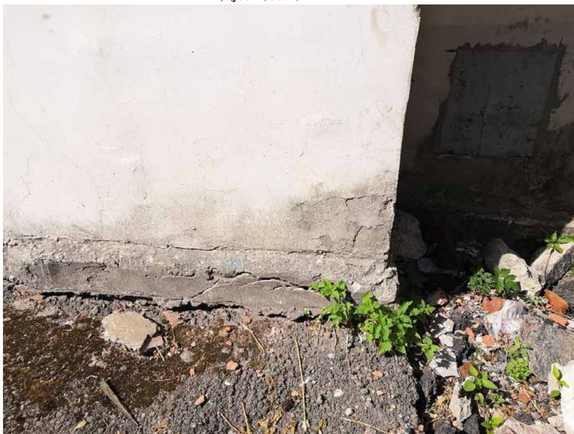
Илл. 12. Вид на фрагмент цоколя лицевого фасада. Адрес: Санкт-Петербург, ул. Дудко, д. 3, лит. ВЯ.
