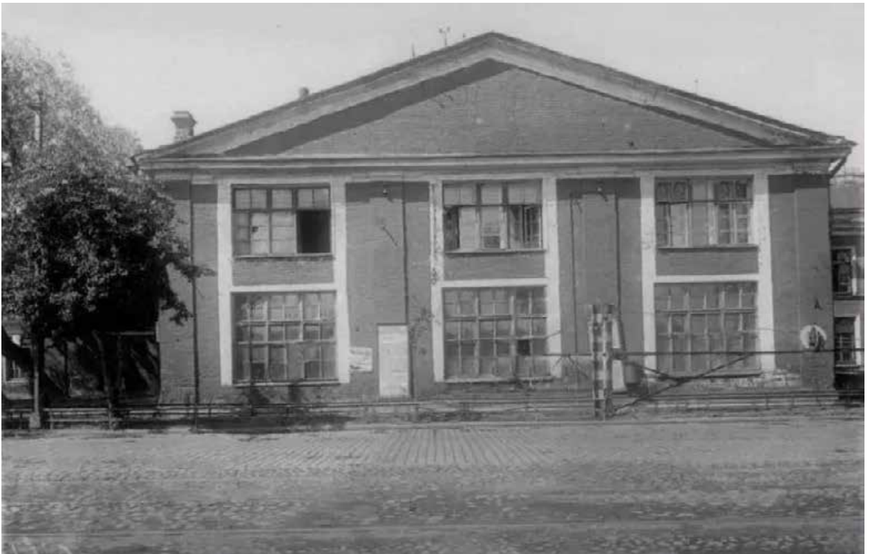
Илл. 41 Фрагмент фасада главного здания Пролетарского паровозоремонтного завода на проспекте Крупской. 23 июля 1934 г. // ЦГАКФФД СПб. Фотодокумент Гр 67132.
