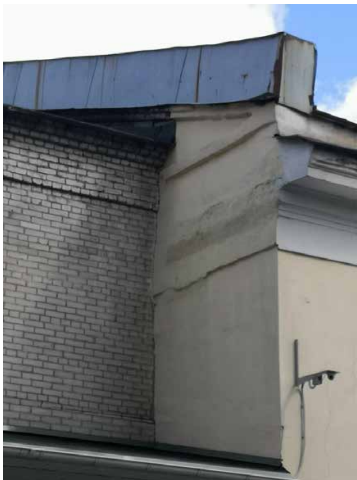
Илл. 29. Вид на фрагмент карниза и торцевого фасада корпуса. Адрес: Санкт-Петербург, ул. Дудко, д. 3, лит. Б.
