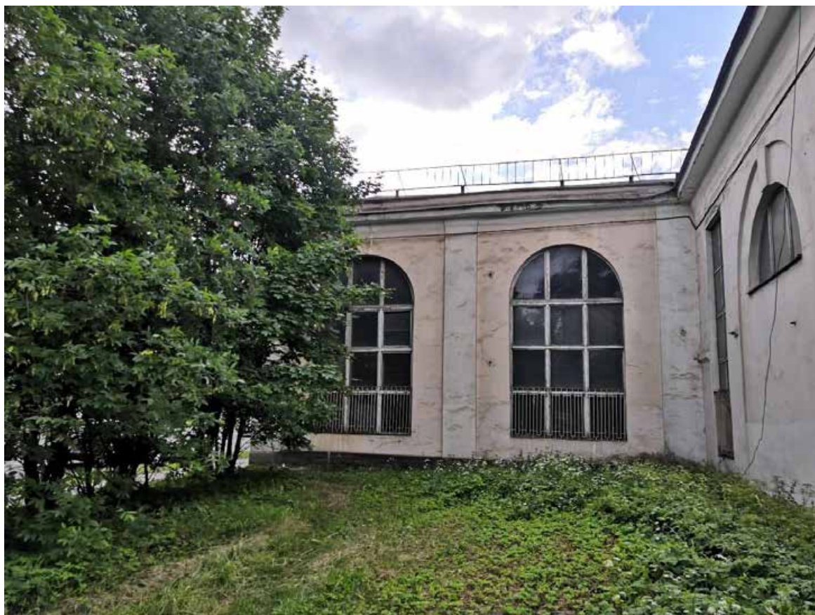
Илл. 3. Вид на фрагмент лицевого фасада с северо-запада. Адрес: Санкт-Петербург, ул. Дудко, д. 3, лит. БЛ.
