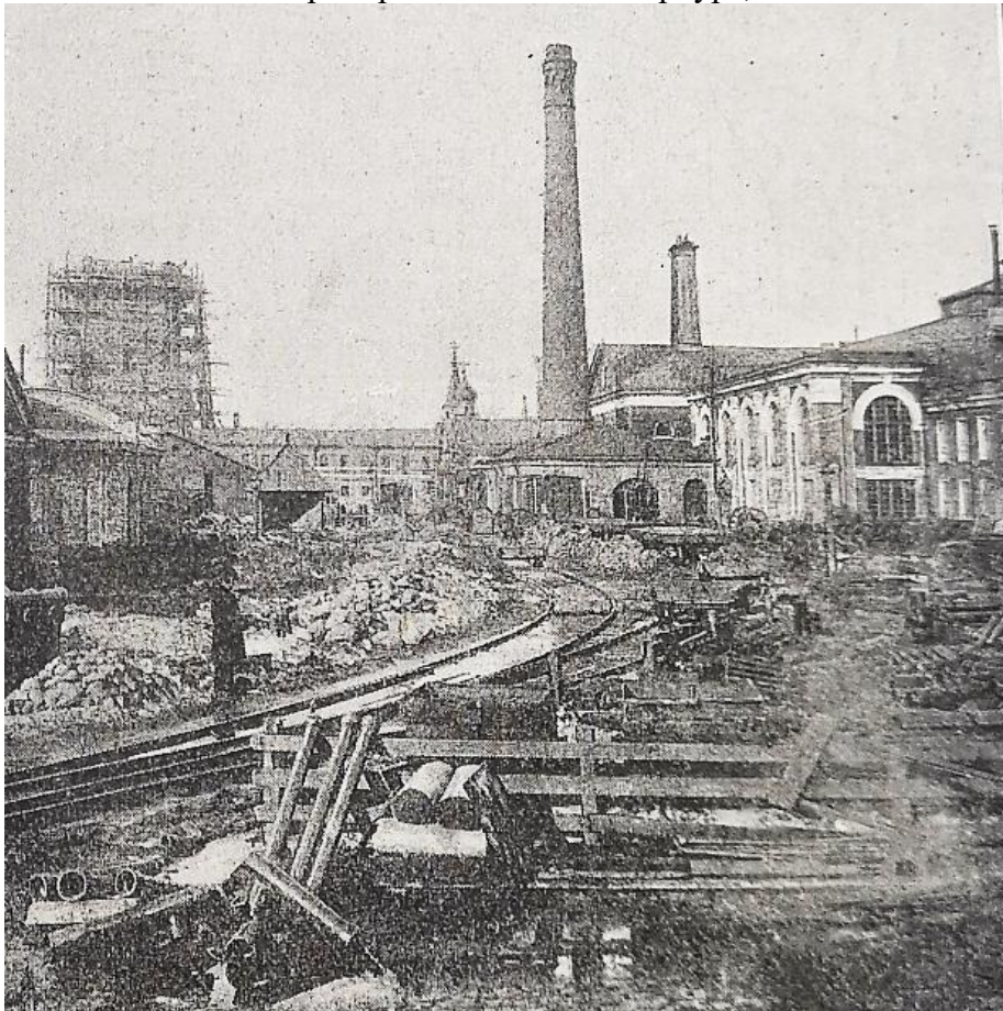
Илл. 36 Вид со двора Александровского завода на мастерские. Справа фрагмент дворового фасада центральной части лицевых корпусов. 1880-90-е гг. // Постройка и эксплуатация Николаевской железной дороги. (1842-1851-1901 гг.): Крат. ист. очерк / Сост. Упр. дороги. - Санкт-Петербург, 1901.
