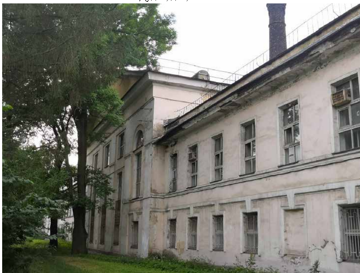
Илл. 6. Вид на фрагмент лицевого фасада с севера. Адрес: Санкт-Петербург, ул. Дудко, д. 3, лит. ВЯ.
