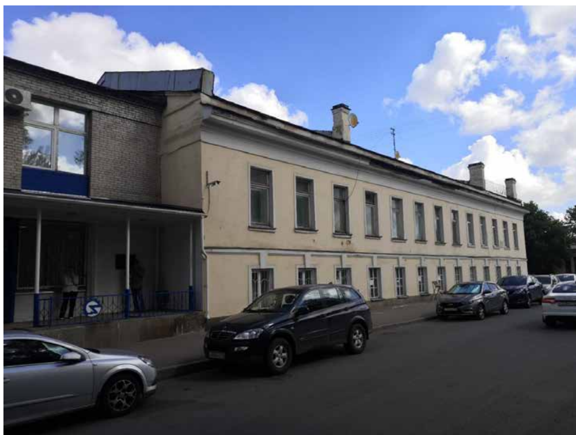
Илл. 28. Общий вид на корпус с юга. Адрес: Санкт-Петербург, ул. Дудко, д. 3, лит. Б.
