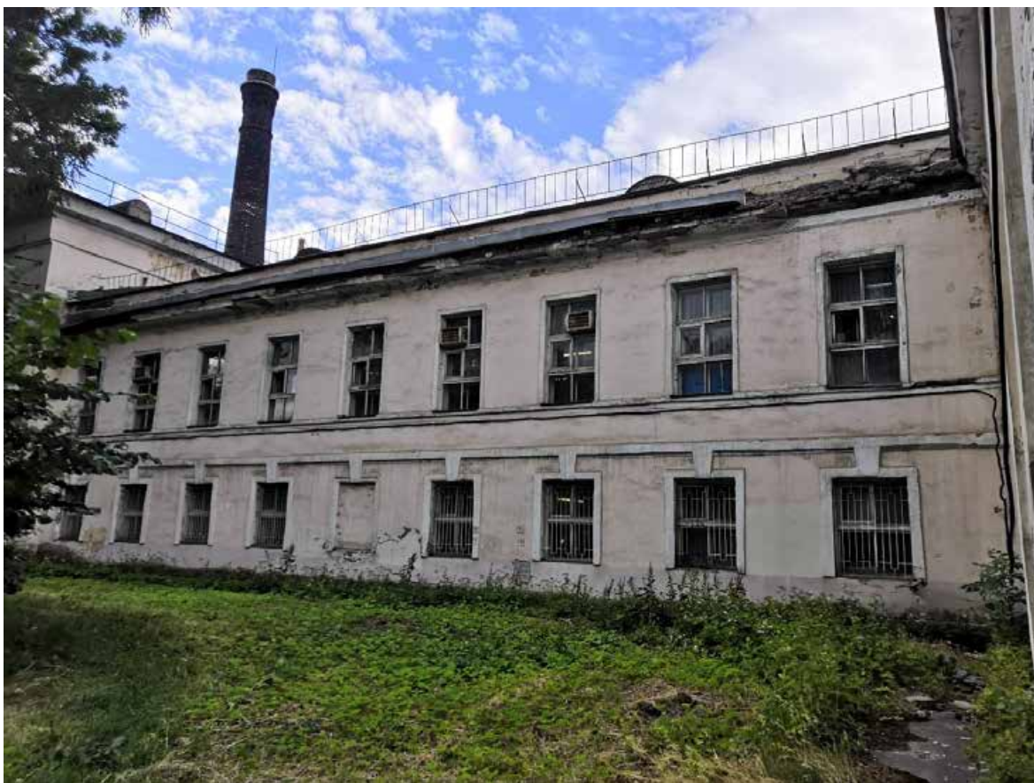
Илл. 5. Вид на фрагмент лицевого фасада с северо-востока. Адрес: Санкт-Петербург, ул. Дудко, д. 3, лит. ВЯ.
