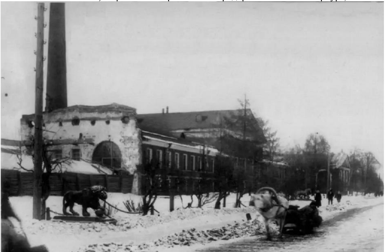
Илл. 38 Общий вид главного корпуса Пролетарского завода Октябрьской железной дороги на проспекте Крупской. 1926 г. // ЦГАКФФД СПб Гр 65108.
