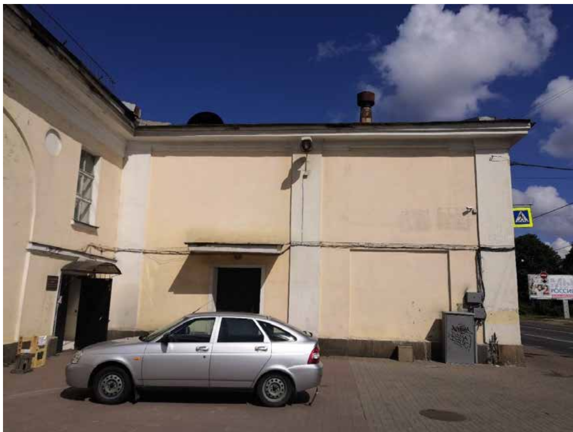
Илл. 25 Вид на фрагмент лицевого фасада с ул. Дудко. Адрес: Санкт-Петербург, ул. Дудко, д. 3, лит. Б.
