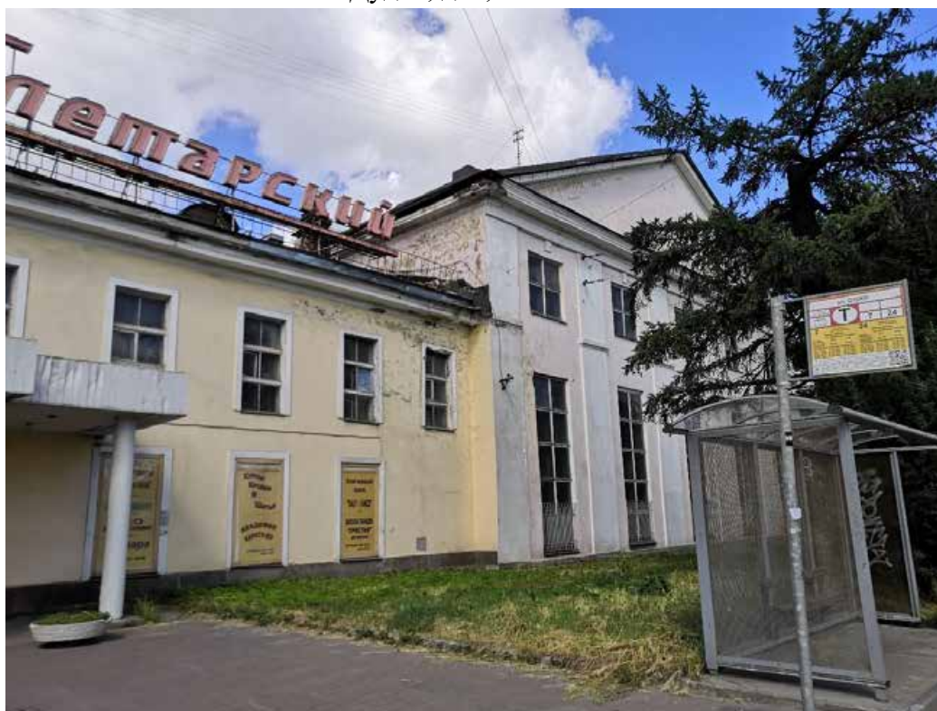
Илл. 16. Вид на фрагмент лицевого фасада с юго-востока. Адрес: Санкт-Петербург, ул. Дудко, д. 3, лит. ВЯ, Б.
