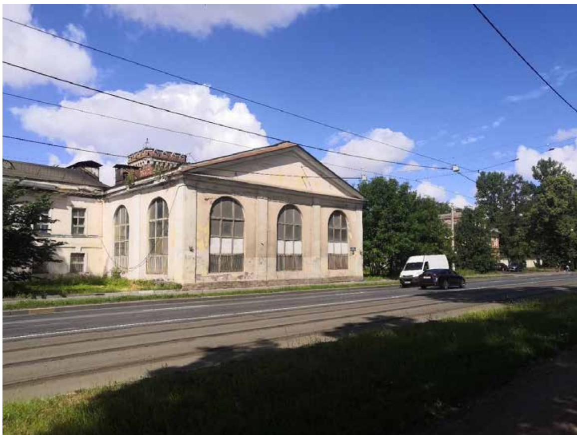
Илл. 21. Общий вид на здание с юго-востока. Адрес: Санкт-Петербург, ул. Дудко, д. 3, лит. БЛ.
