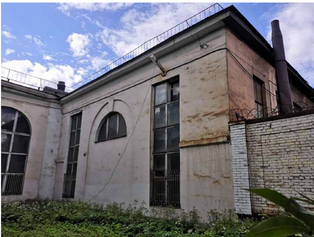
Илл. 2. Вид на фрагмент лицевого фасада с северо-востока. Адрес: Санкт-Петербург, ул. Дудко, д. 3, лит. БЛ.
