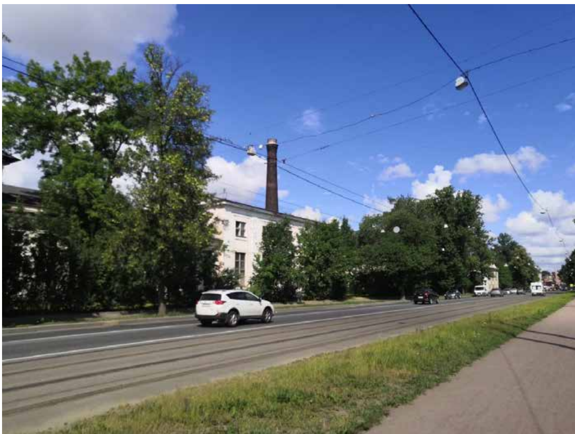
Илл. 23. Общий вид на корпуса с юго-востока. Адрес: Санкт-Петербург, ул. Дудко, д. 3, лит. БЛ, ВЯ.
