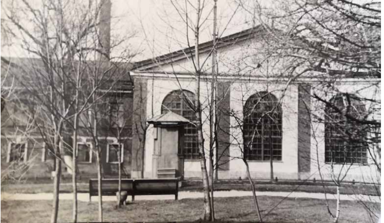
Илл. 56 Фотографии зданий до реконструкции. Фасады по проспекту Обуховской обороны. Северная часть. Фрагмент. 1950-е гг. // Архив Пролетарского завода.
