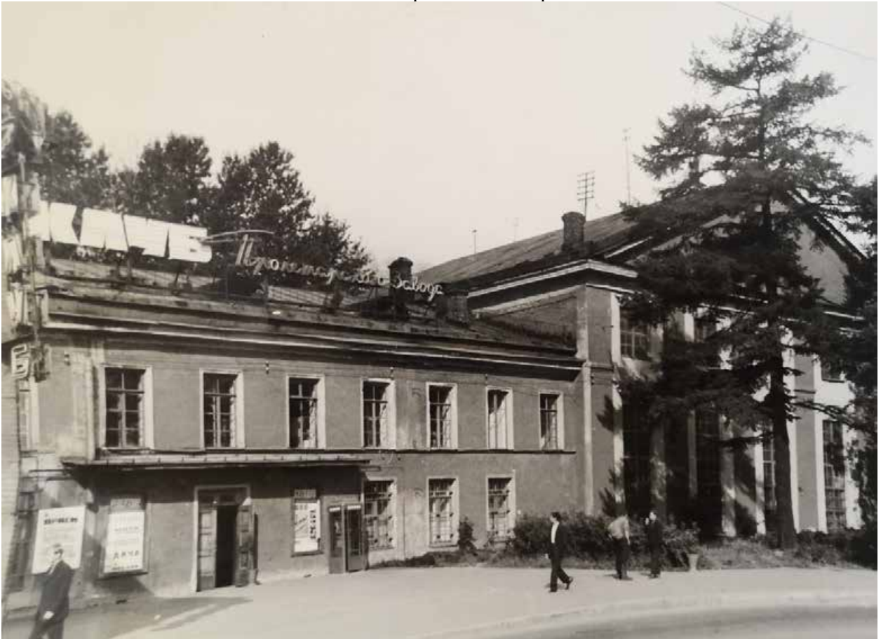
Илл. 50 Здание клуба. Фотографии зданий до реконструкции. Фасады по проспекту Обуховской обороны. 1950-е гг. // Архив Пролетарского завода.
