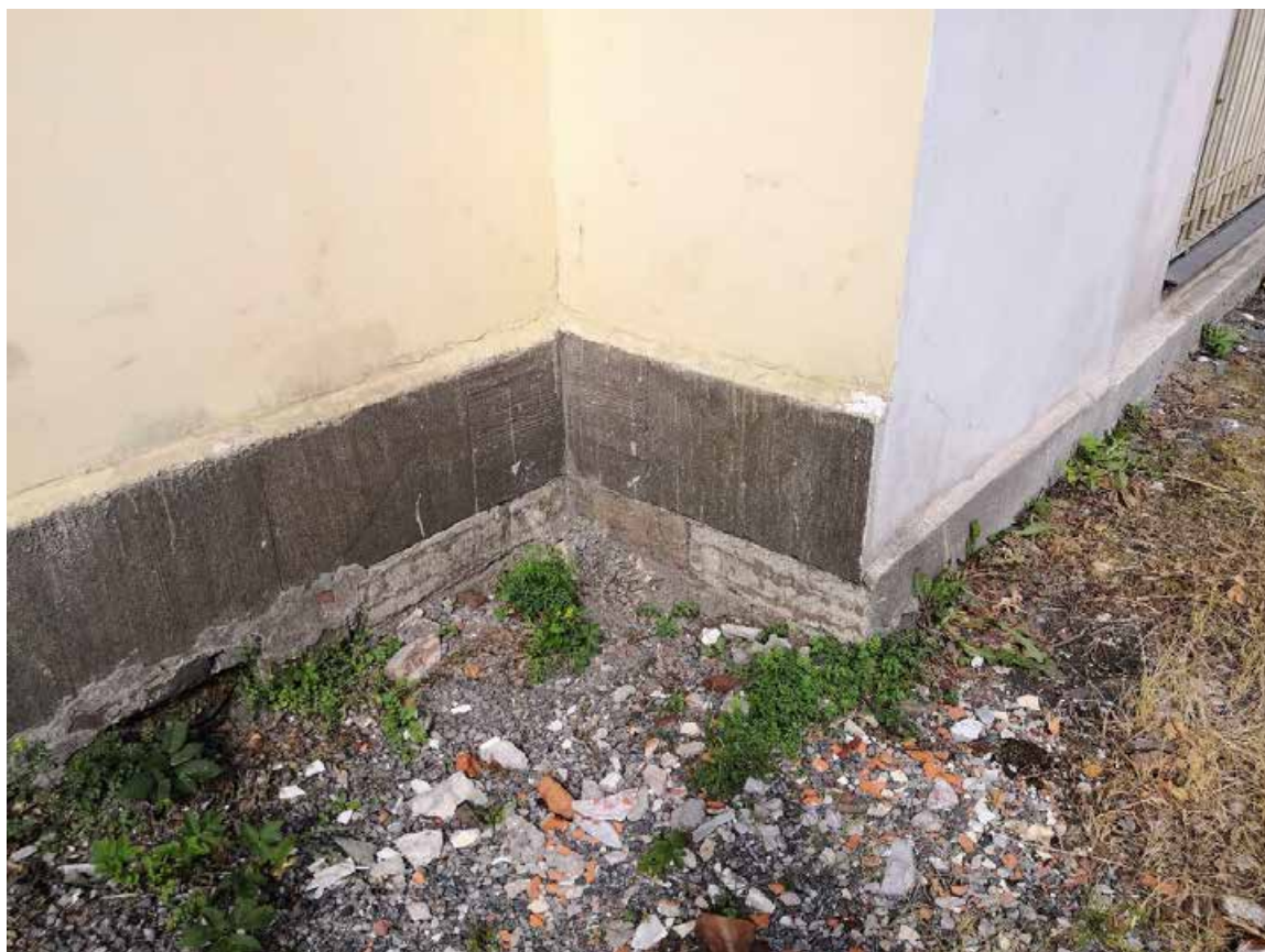
Илл. 19. Вид на фрагмент цоколя лицевого фасада. Главный вход. Адрес: Санкт-Петербург, ул. Дудко, д. 3, лит. Б.
