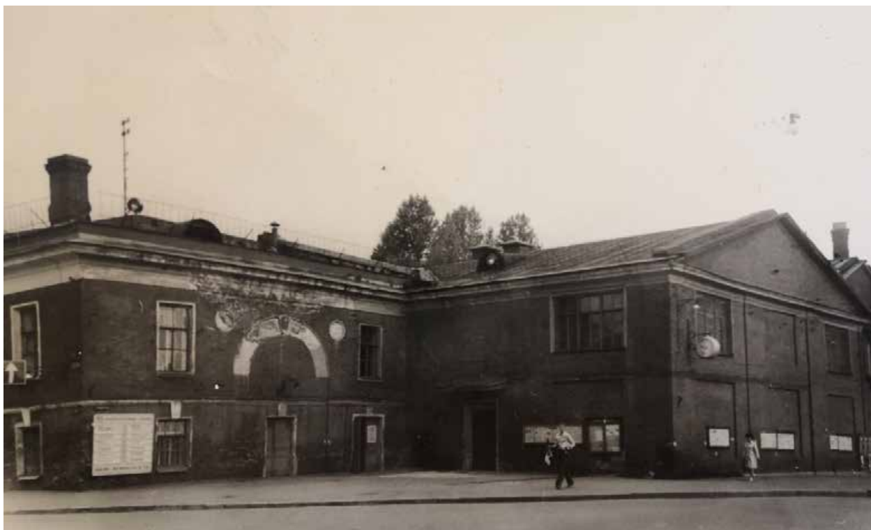
Илл. 51 Здание клуба. Фотографии зданий до реконструкции. Фасады. Вид с перекрестка. 1950-е гг. // Архив Пролетарского завода.
