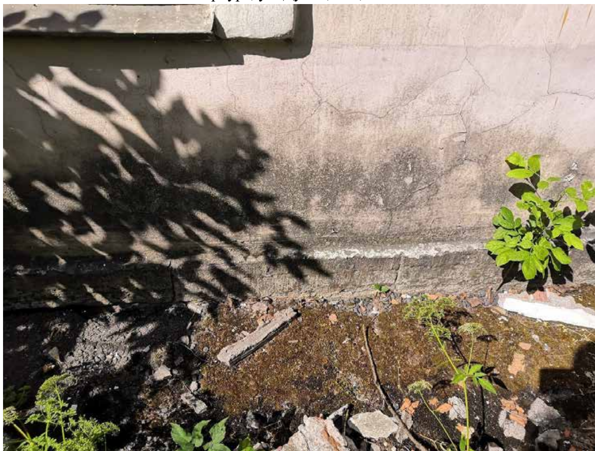
Илл. 10. Вид на фрагмент цоколя лицевого фасада. Адрес: Санкт-Петербург, ул. Дудко, д. 3, лит. ВЯ.
