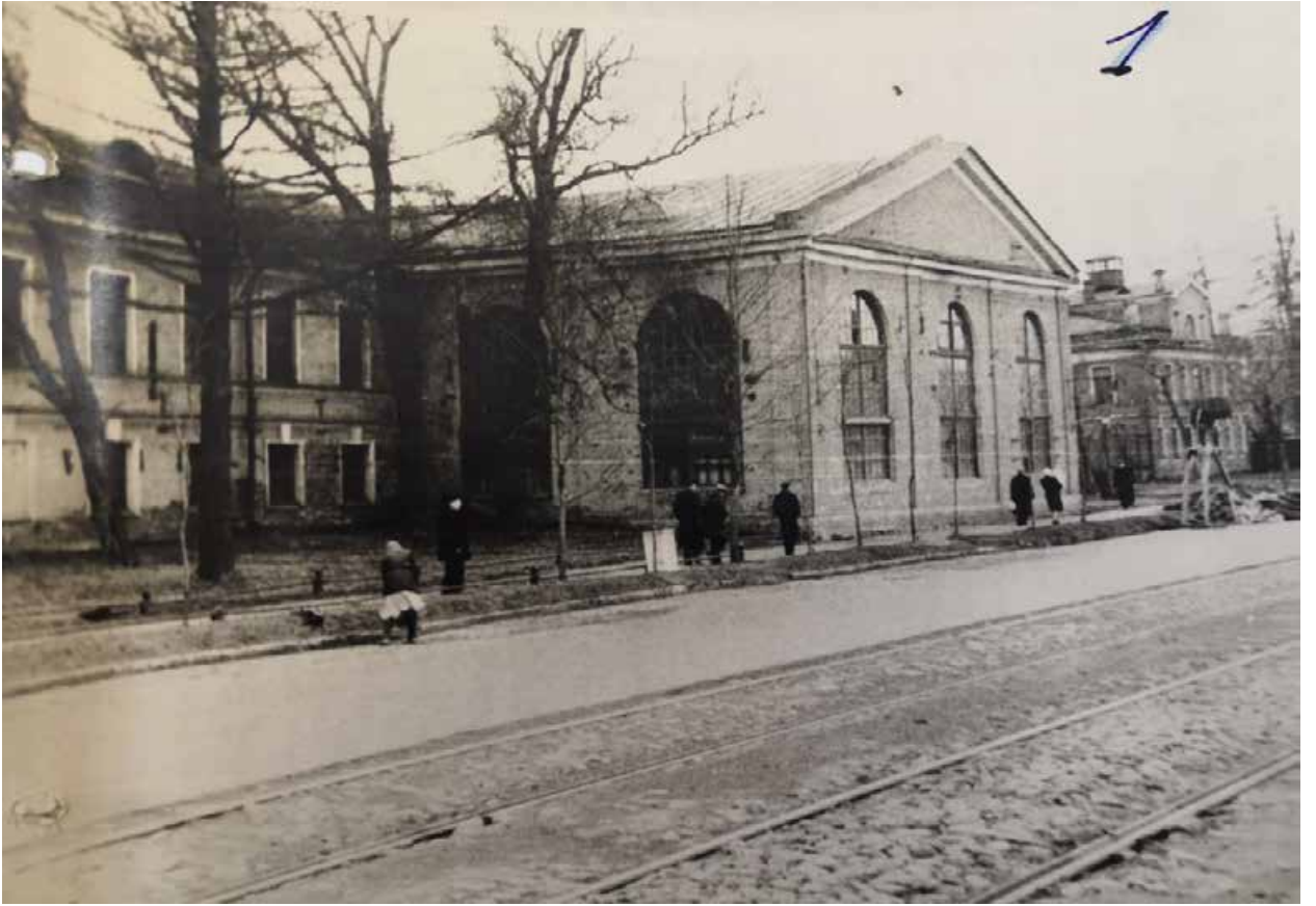
Илл. 57 Фотографии зданий по проспекту Обуховской обороны. Фасады. Северная часть. Апрель 1950 г. // Архив Пролетарского завода.
