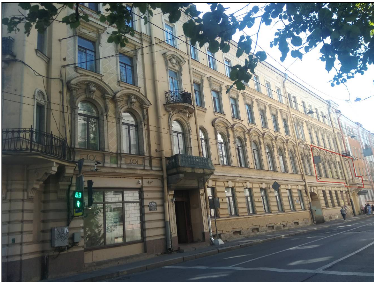
3. Общий вид лицевого фасада по Большой Пушкарской ул. Окна, принадлежащие квартире №14.
