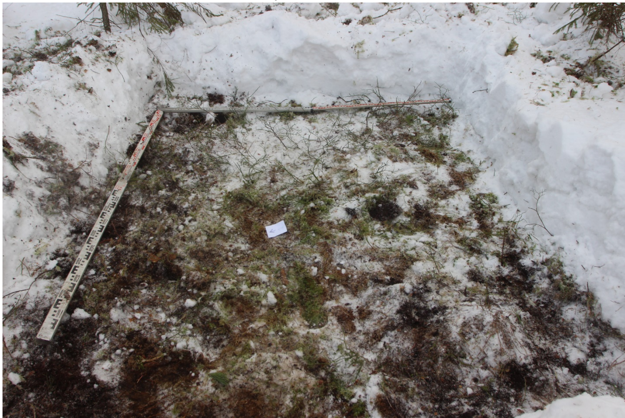
Рис. 29. Зеленогорск, Кривоносковская ул. КН:78:38:2253102:1229-2023. Шурф 2, дневная поверхность, вид на восток.
