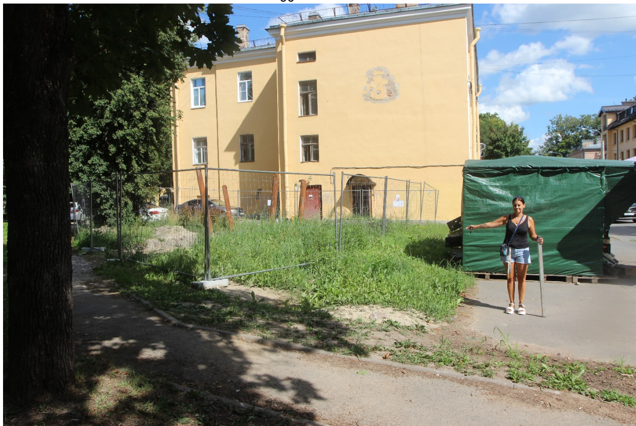
Рис. 29. Пушкин, Кадетский бул. 8а, лит. Б-2023. Точка фотофиксации 11, вид на восток.
