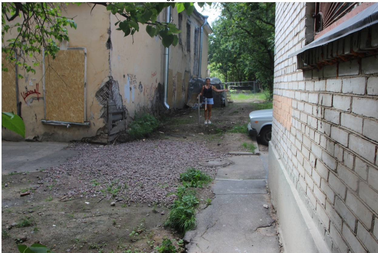
Рис. 27. Пушкин, Кадетский бул. 8а, лит. Б-2023. Точка фотофиксации 9, вид на запад.
