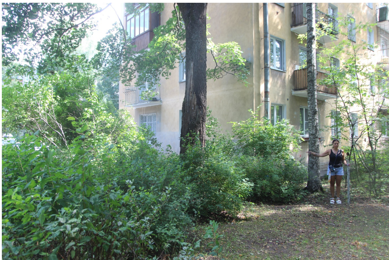
Рис. 14. Пушкин, Кадетский бул. 8а, лит. Б-2023. Точка фотофиксации 1, вид на восток.
