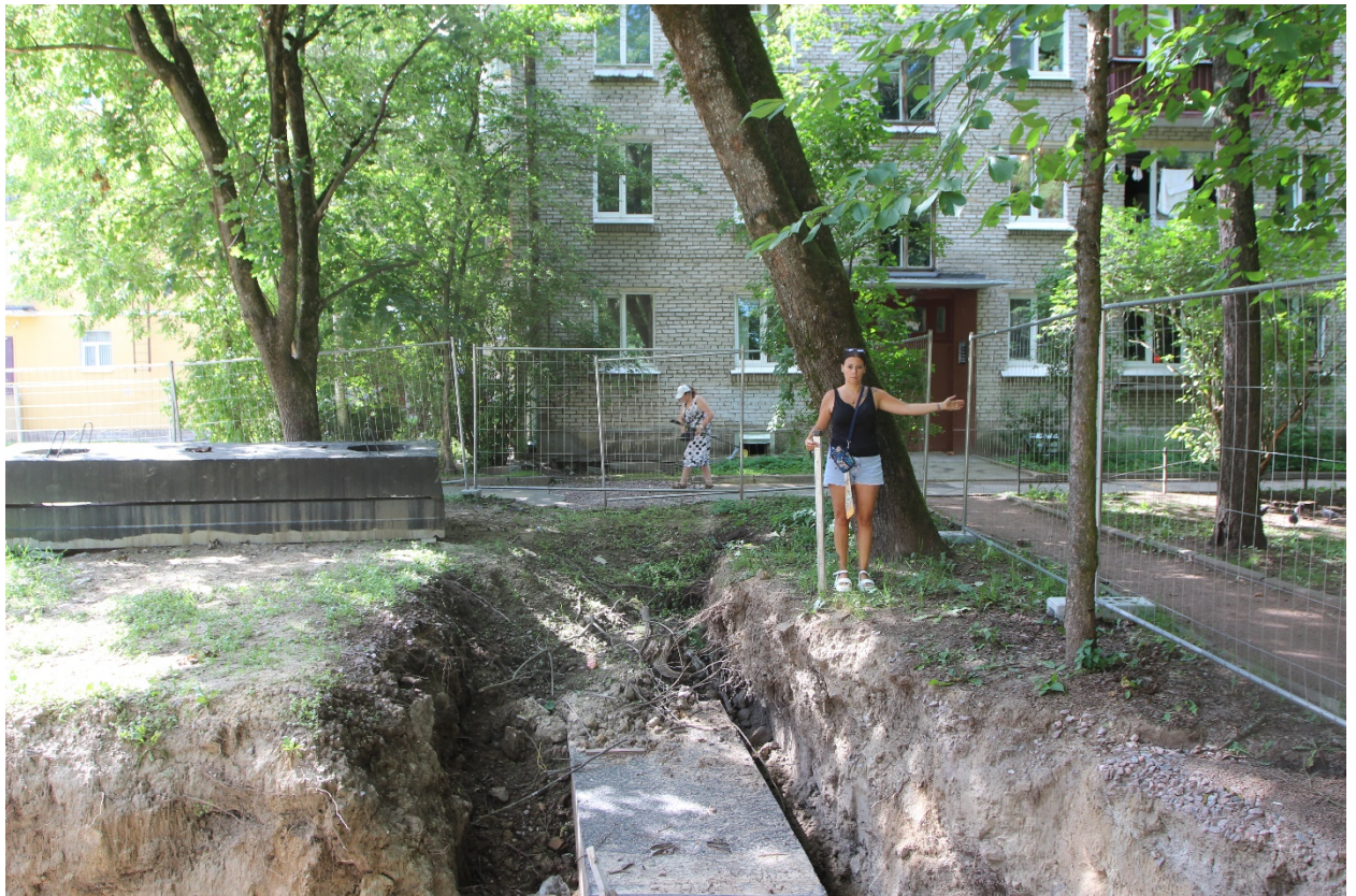
Рис. 26. Пушкин, Кадетский бул. 8а, лит. Б-2023. Точка фотофиксации 8, вид на запад.
