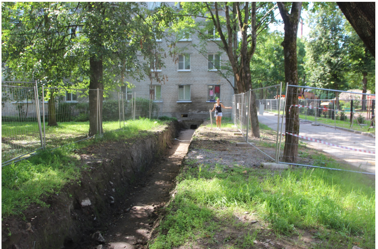
Рис. 24. Пушкин, Кадетский бул. 8а, лит. Б-2023. Точка фотофиксации 6, вид на запад.
