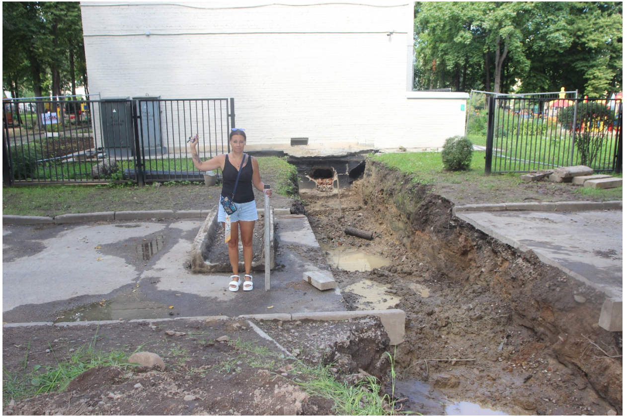
Рис. 25. Пушкин, Кадетский бул. 8а, лит. Б-2023. Точка фотофиксации 7, вид на север.
