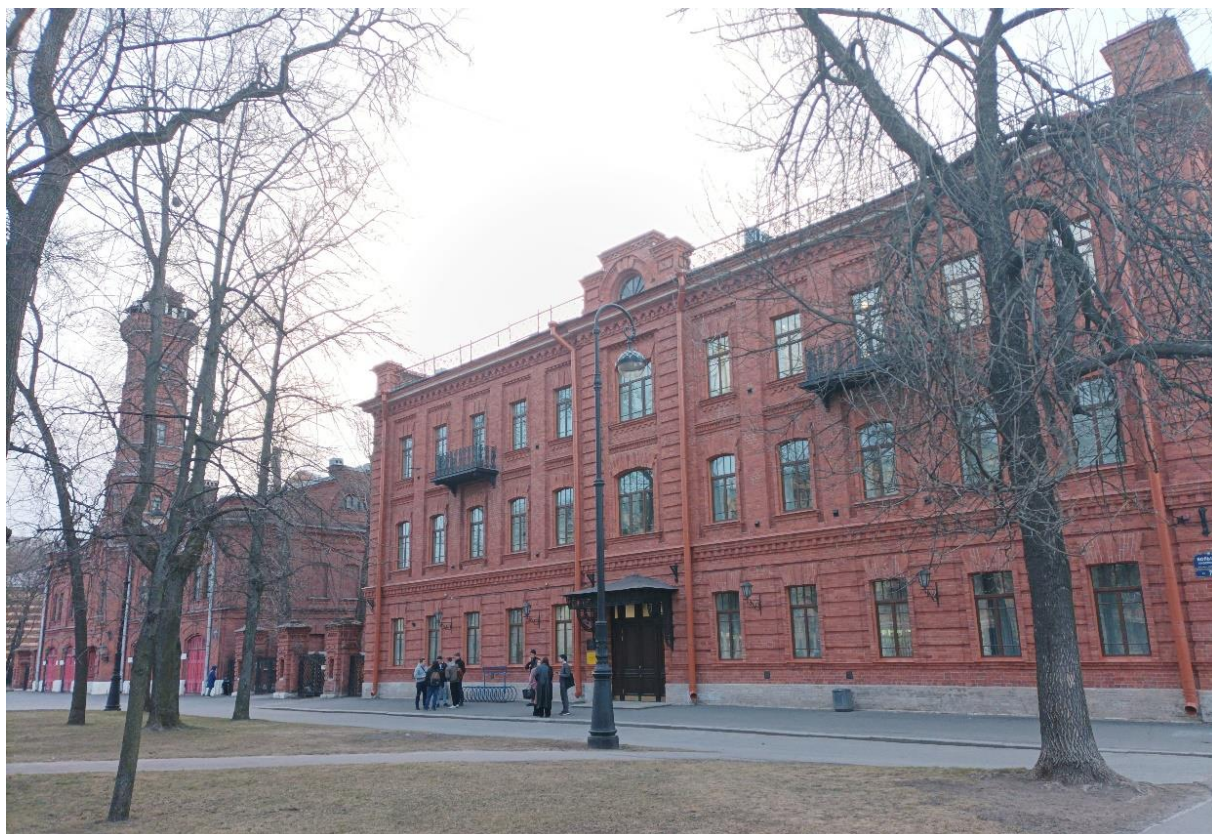
11. Вид на объекты культурного наследия регионального значения «Бульвар Большого проспекта Васильевского Острова», «Полицейский дом», Большой проспект В.О., дом 71, литера А и «Пожарное отделение», Большой проспект В.О., дом 73, литера А. Направление съемки северо-запад.
