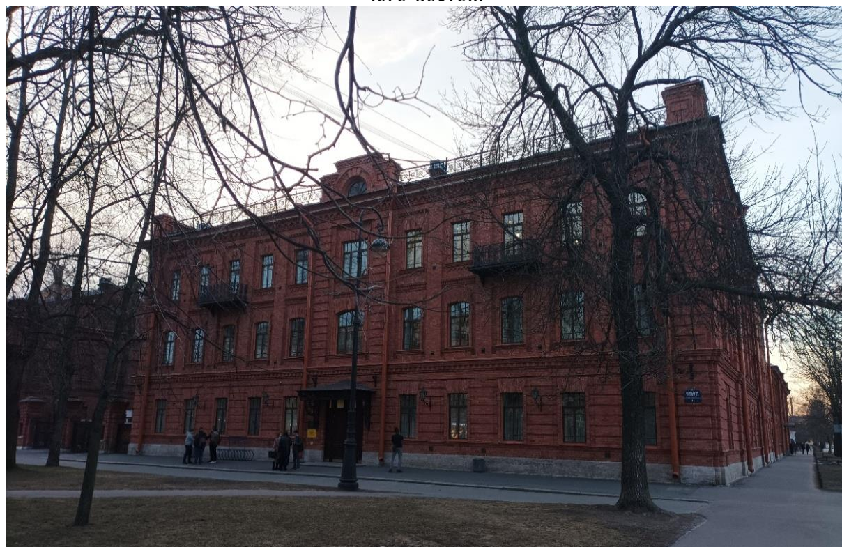
10. Вид на объекты культурного наследия регионального значения «Бульвар Большого проспекта Васильевского Острова» и «Полицейский дом», Большой проспект В.О., дом 71, литера А. Направление съемки северо-запад.
