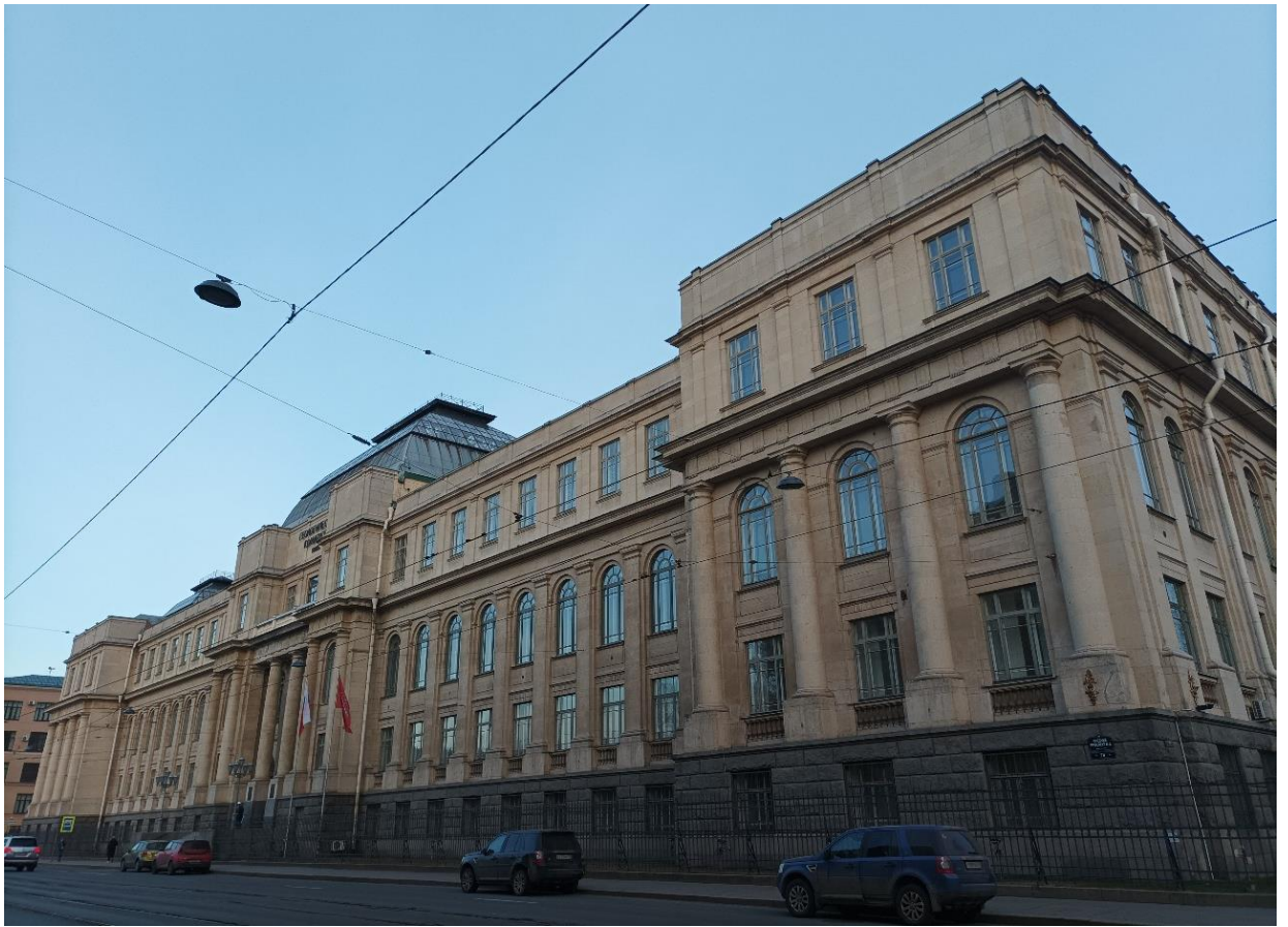
3. Вид на выявленный объект культурного наследия «Здание Геологического комитета (с палисадником и оградой)». Направление съемки восток.
