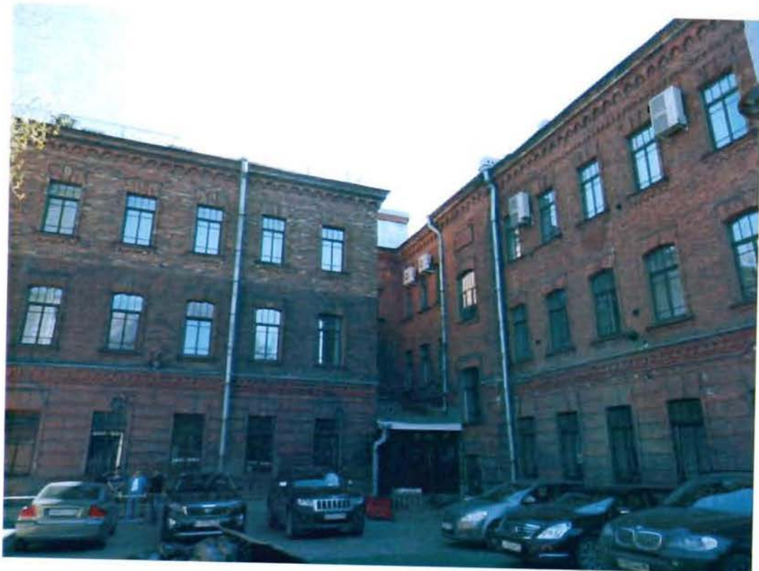
4. Фрагмент дворовых фасадов
