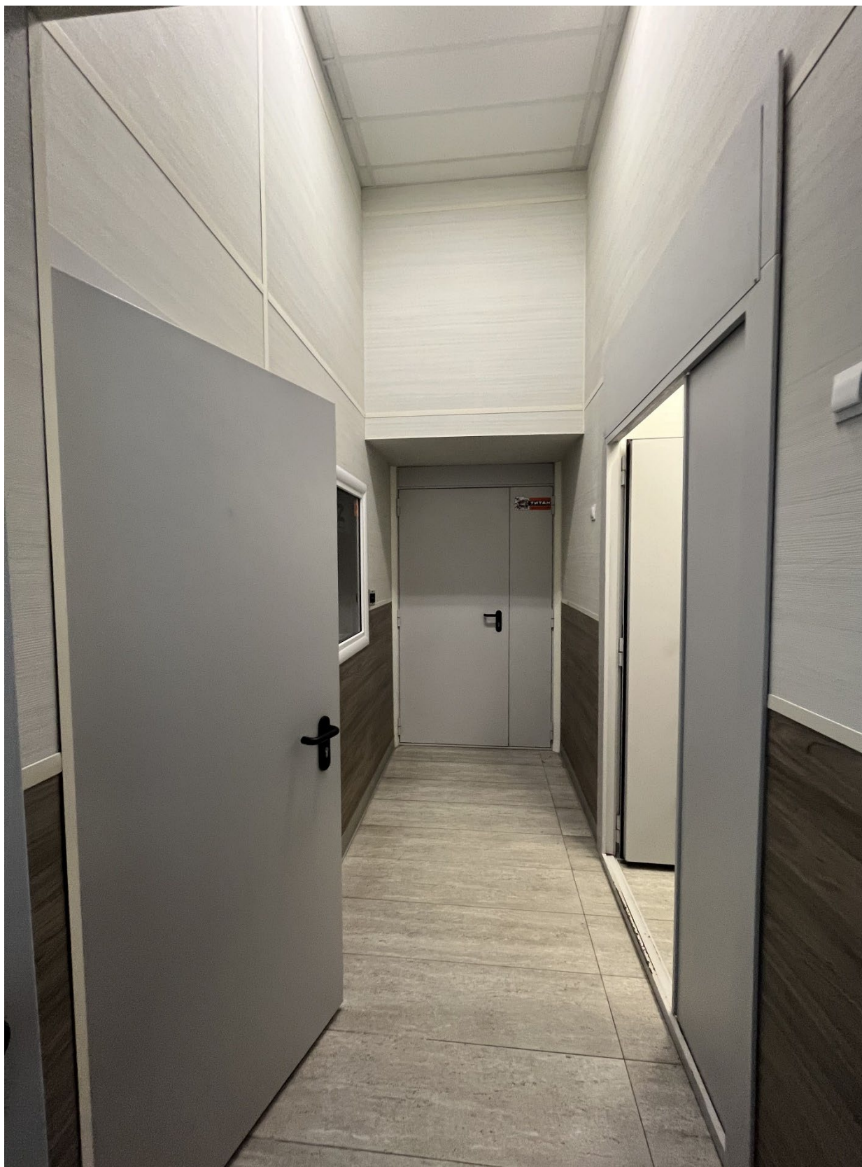
9. Фрагмент интеръера коридора (помещение 2/5.8);
