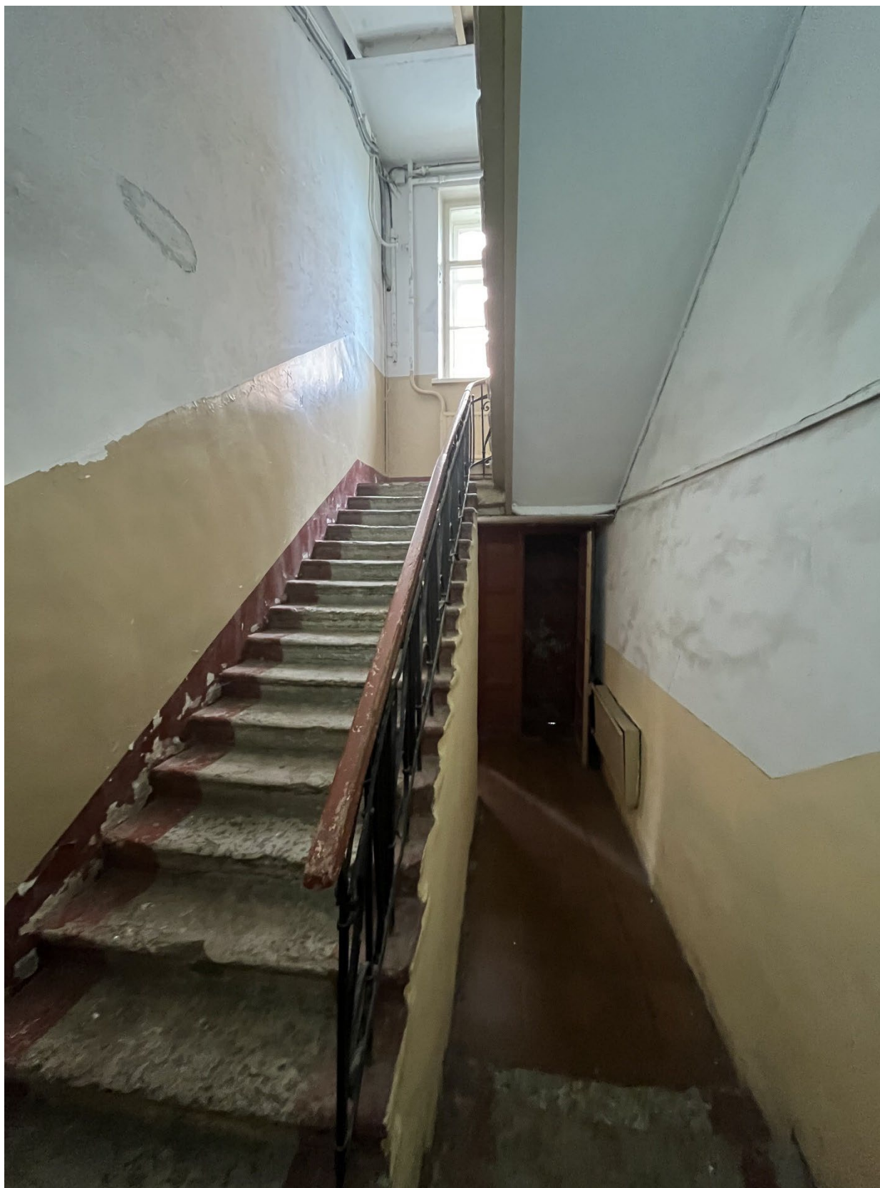
22. Вид на лестницу.
