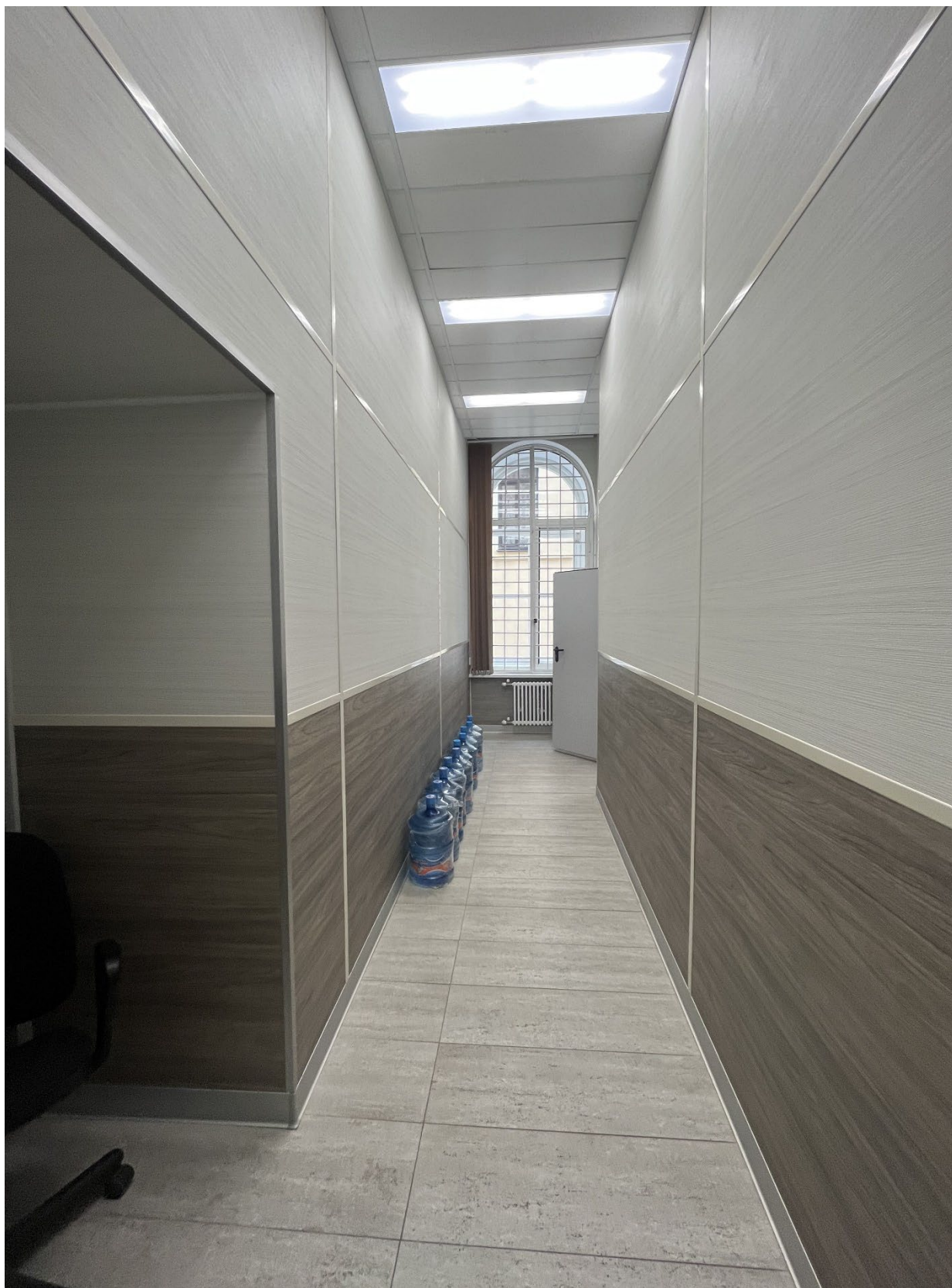
16. Фрагмент интеръера коридора (помещение 12/11.8);
