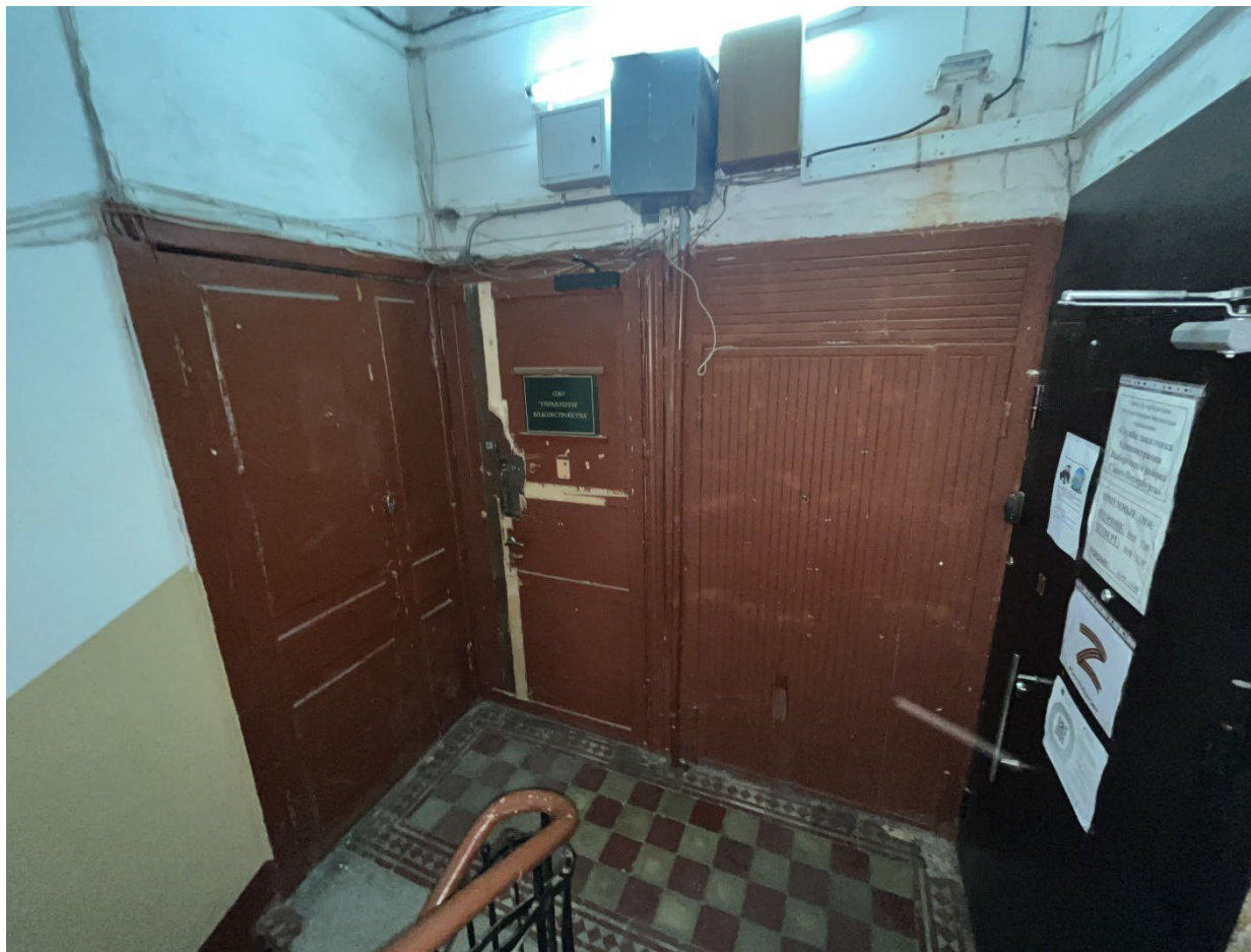
42. Вид на входные двери в помещения;
