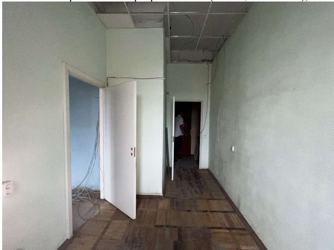
54.Фрагмент интерьера комнаты (помещение 7/10.5);
