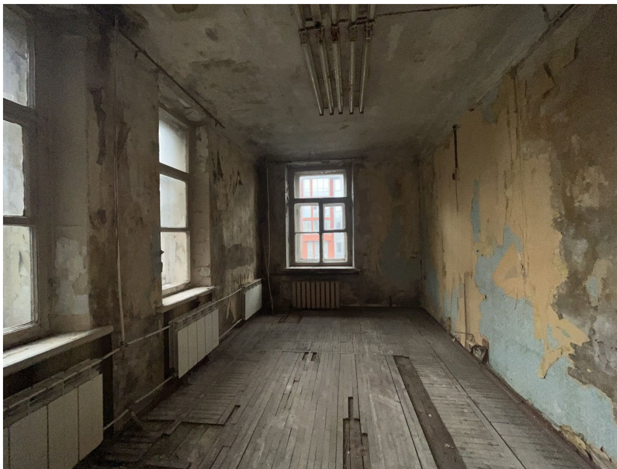
46.Фрагмент интерьера комнаты (помещение 10/21.1);
