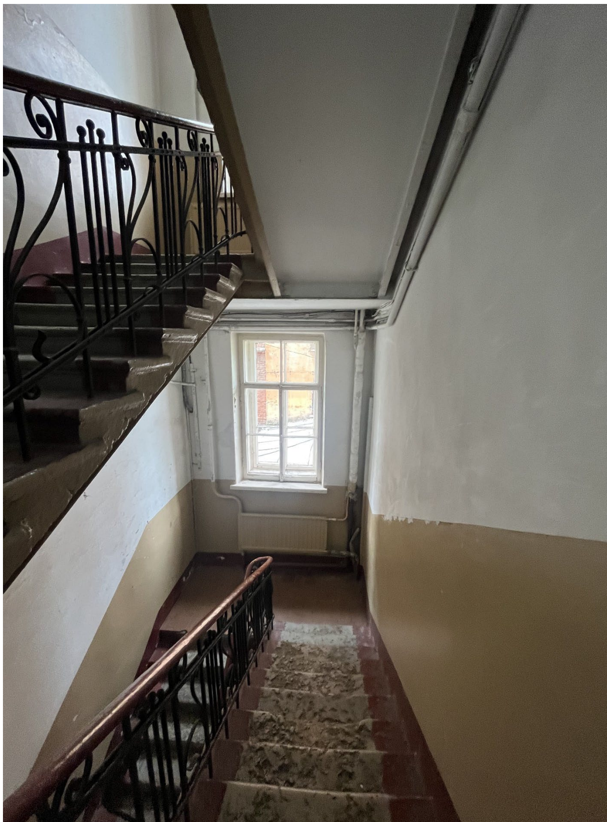
23. Вид на лестницу;
