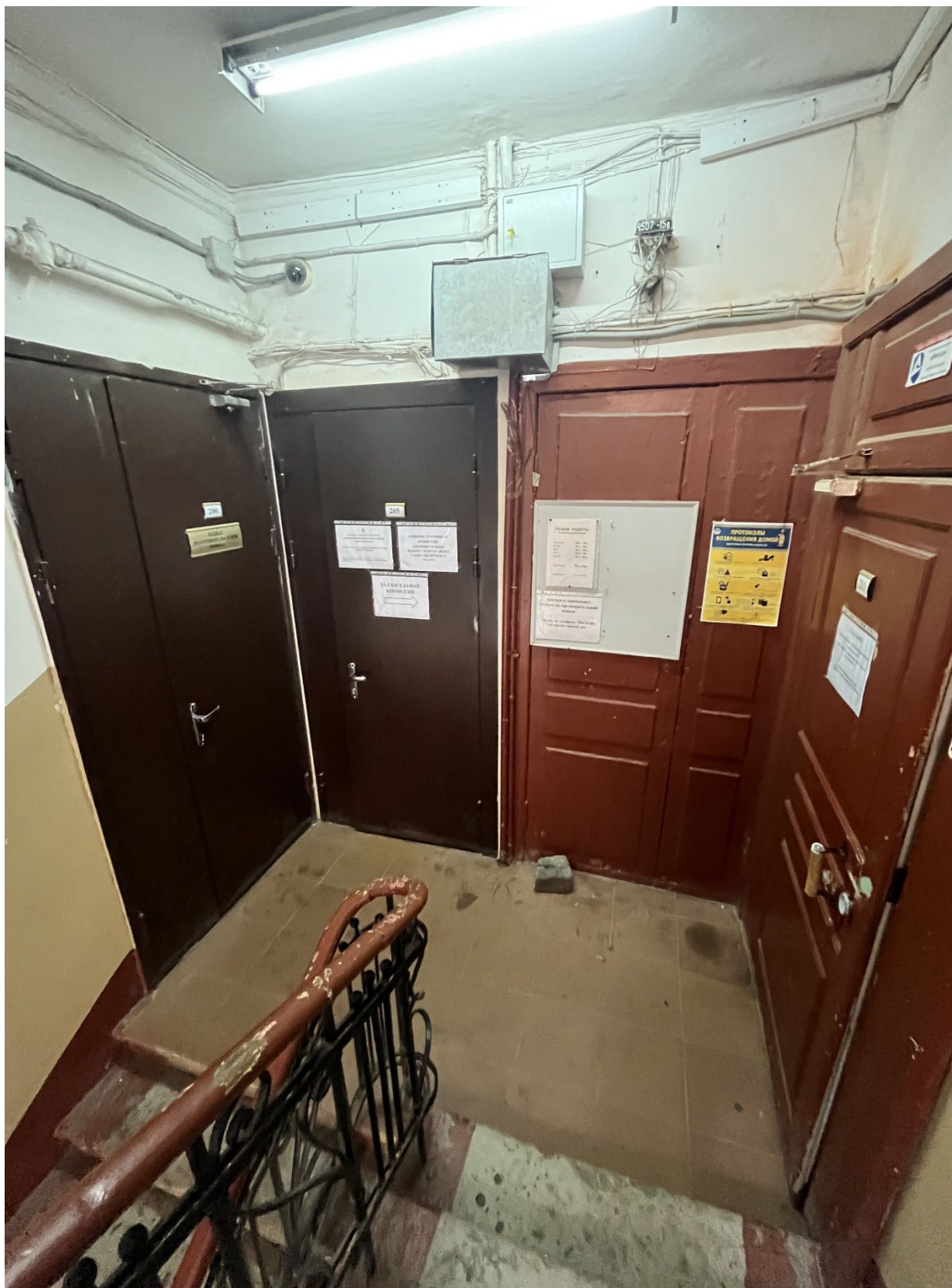
24. Вид на входные двери в помещения;
