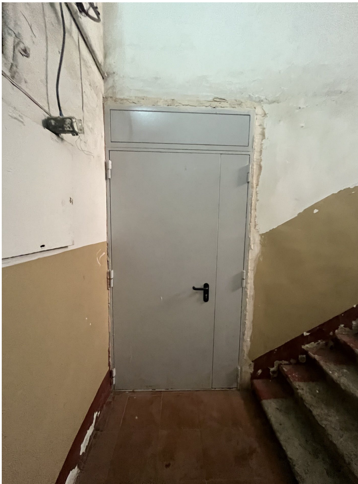
19. Вид на входную дверь в помещение;
