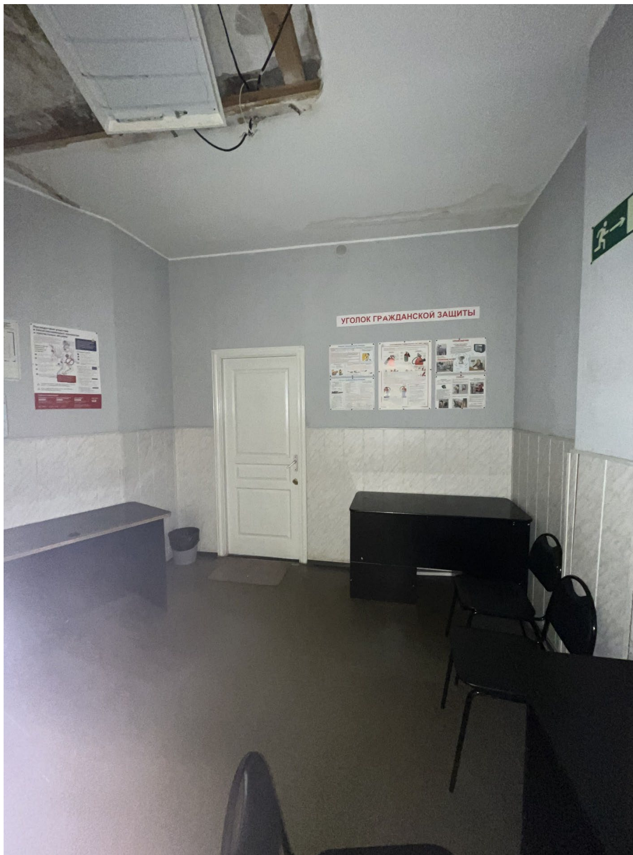
31.Фрагмент интерьера коридора (помещение 6/25.4);
