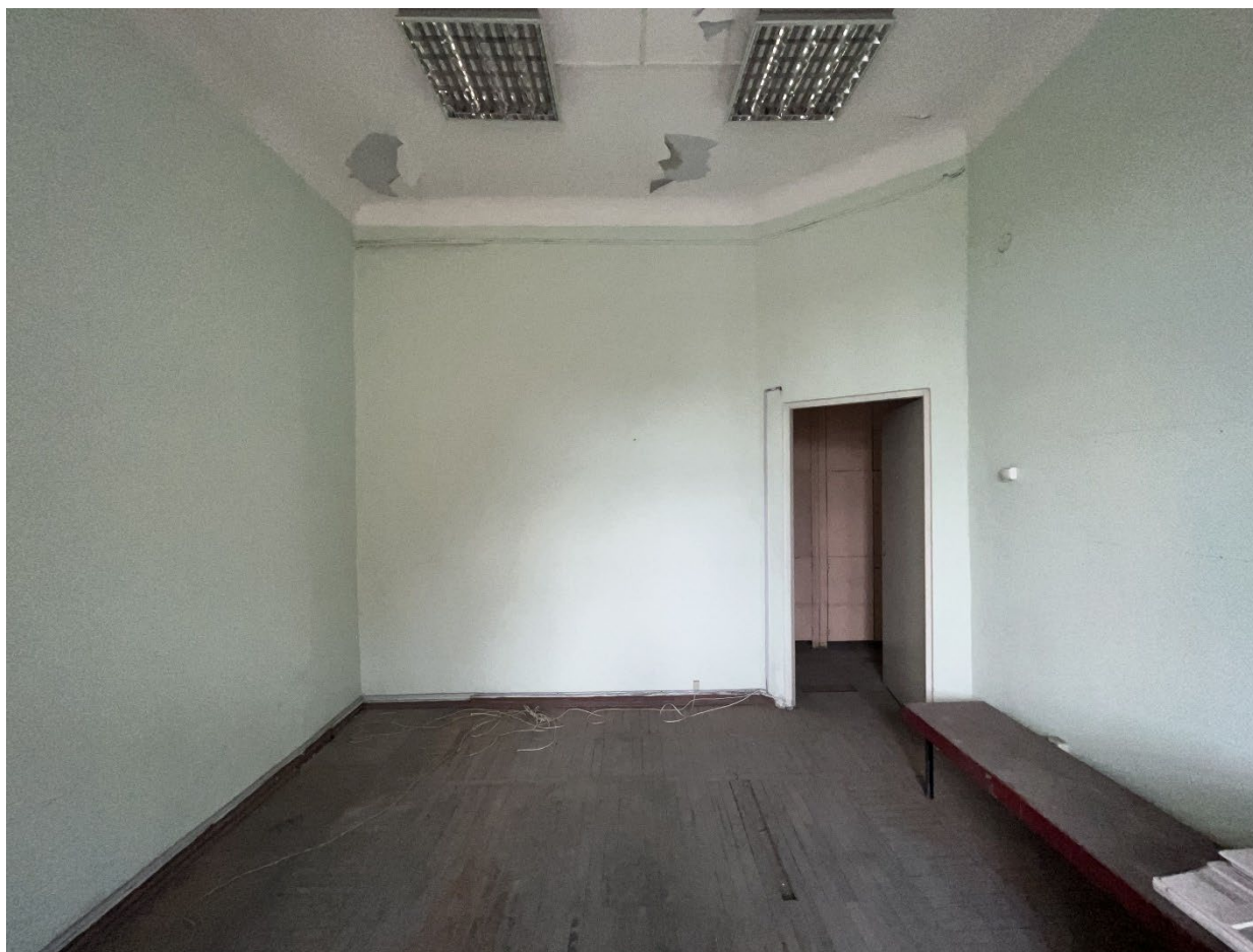
53.Фрагмент интерьера комнаты (помещение 6/18.6);
