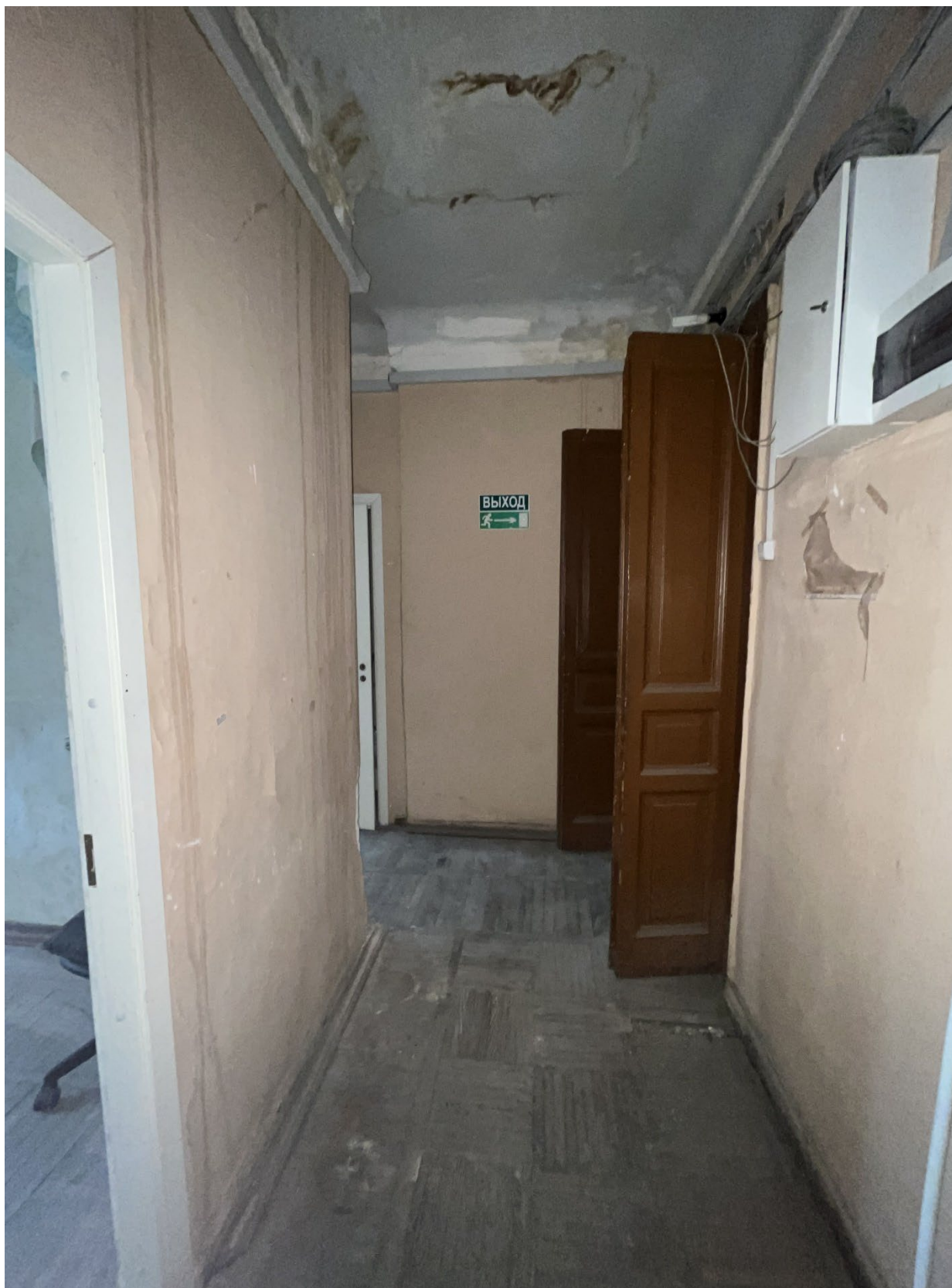
45. Фрагмент интерьера коридора (помещение 1/17.6);
