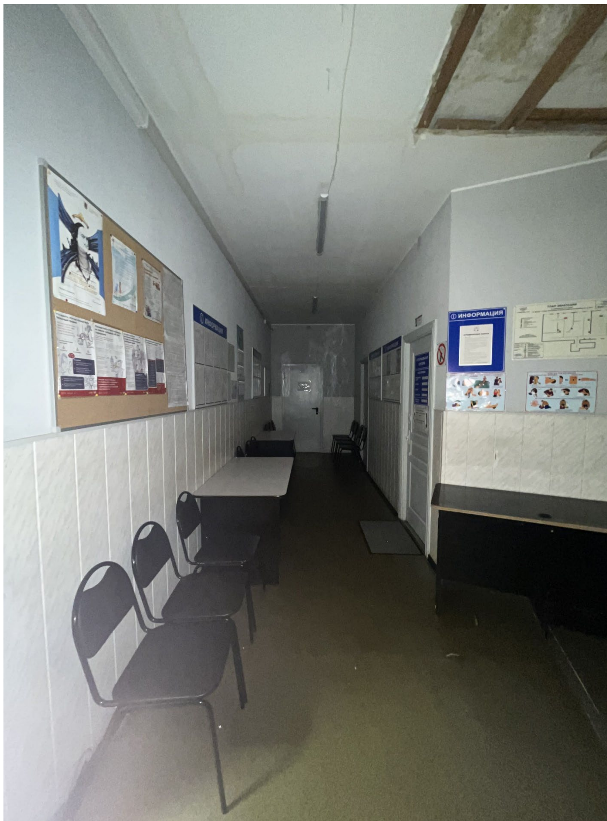
30. Фрагмент интерьера коридора (помещение 6/25.4);
