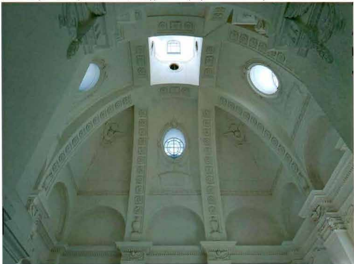
8. Сомкнутый свод усыпальницы, подпружные перекрещивающиеся арки.
