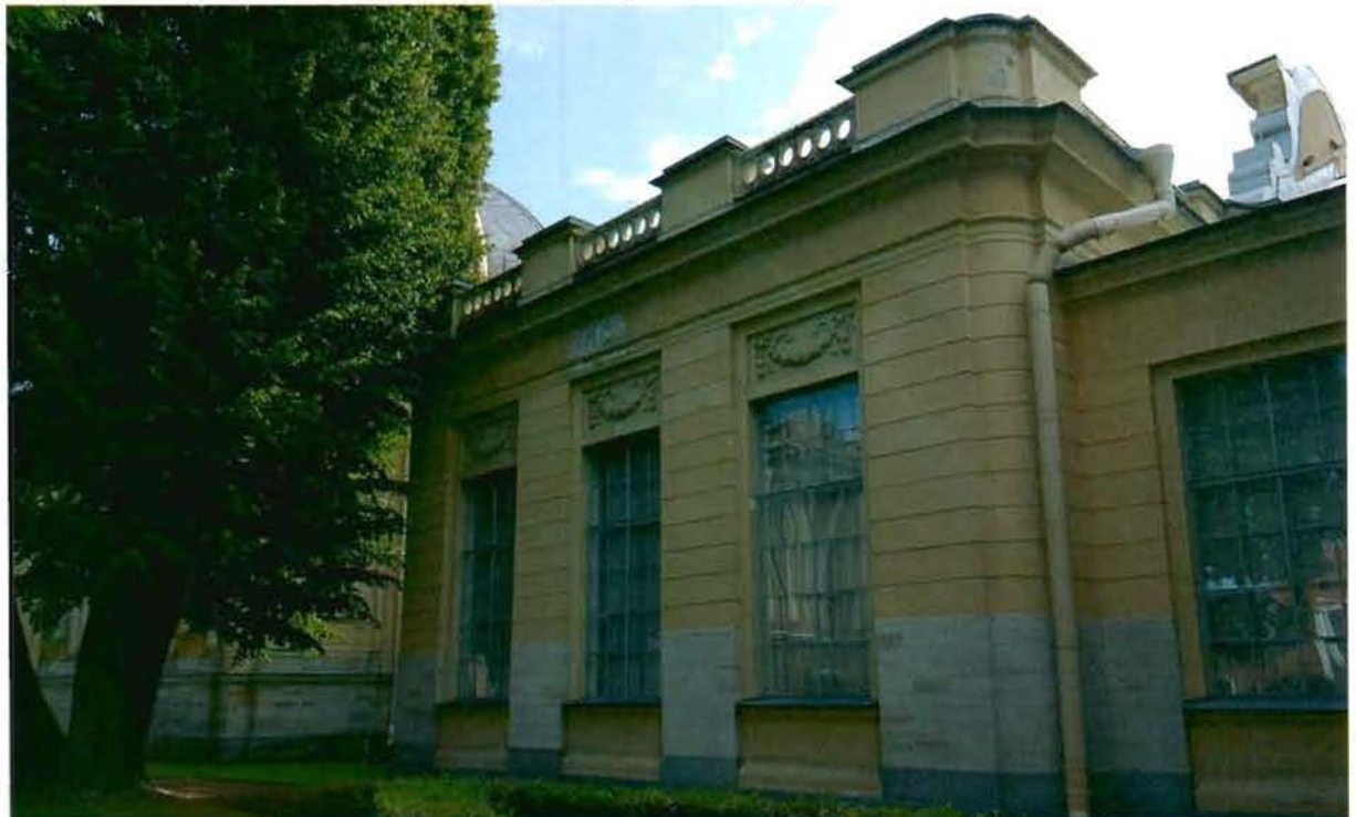
2. Фасад царских комнат (Галерея-переход). Вид с севера.
