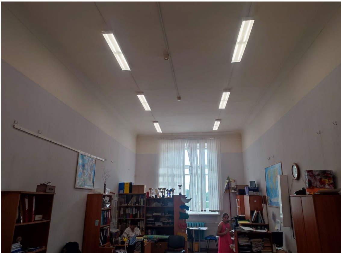
79. Объект культурного наследия регионального значения «Реальное училище», расположенный по адресу: Санкт-Петербург, город Пушкин, Госпитальная улица, дом 24, литера А. Общий вид пом. 1-Н (70) в уровне 2-го этажа.
