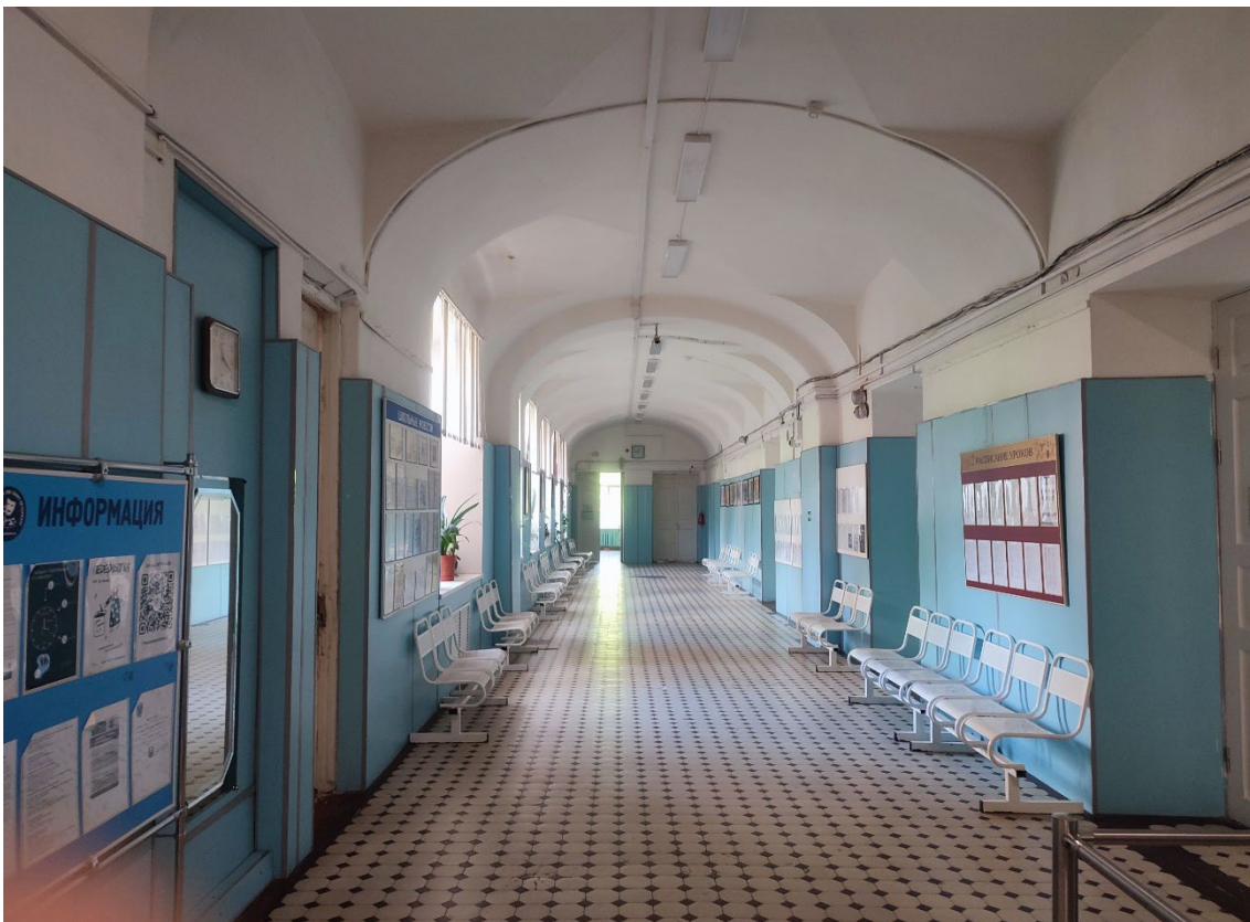
37. Объект культурного наследия регионального значения «Реальное училище», расположенный по адресу: Санкт-Петербург, город Пушкин, Госпитальная улица, дом 24, литера А. Общий вид пом. 1-Н (9) в уровне 1-го этажа.
