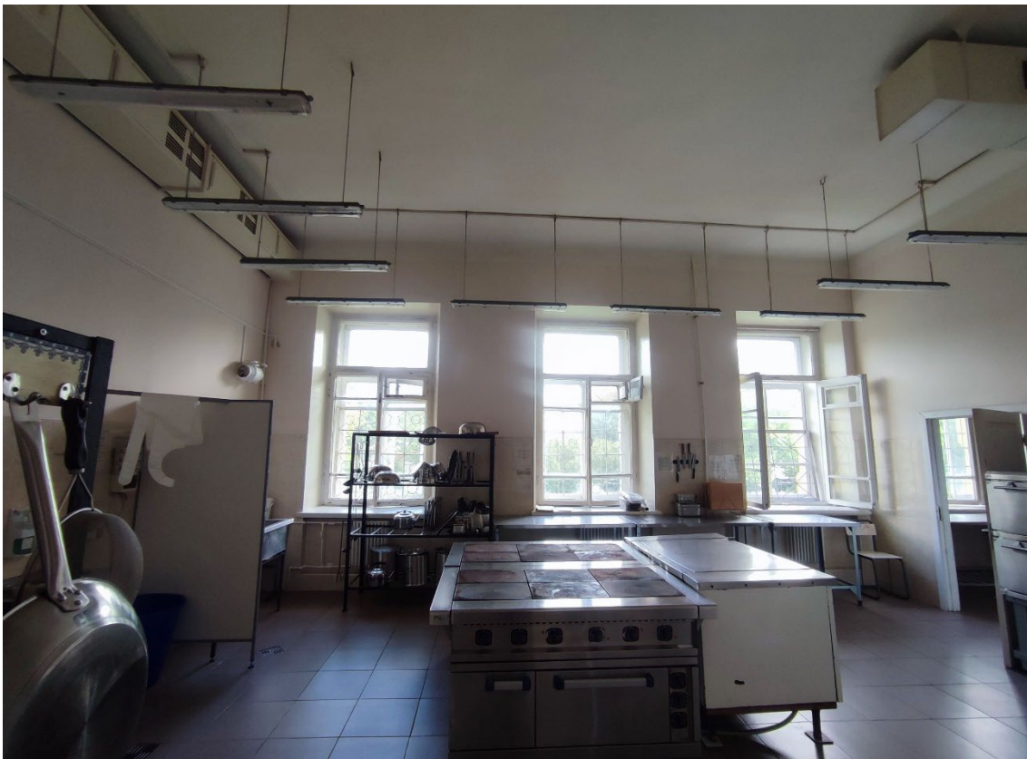
57. Объект культурного наследия регионального значения «Реальное училище», расположенный по адресу: Санкт-Петербург, город Пушкин, Госпитальная улица, дом 24, литера А. Общий вид пом. 1-Н (45) в уровне 1-го этажа.
