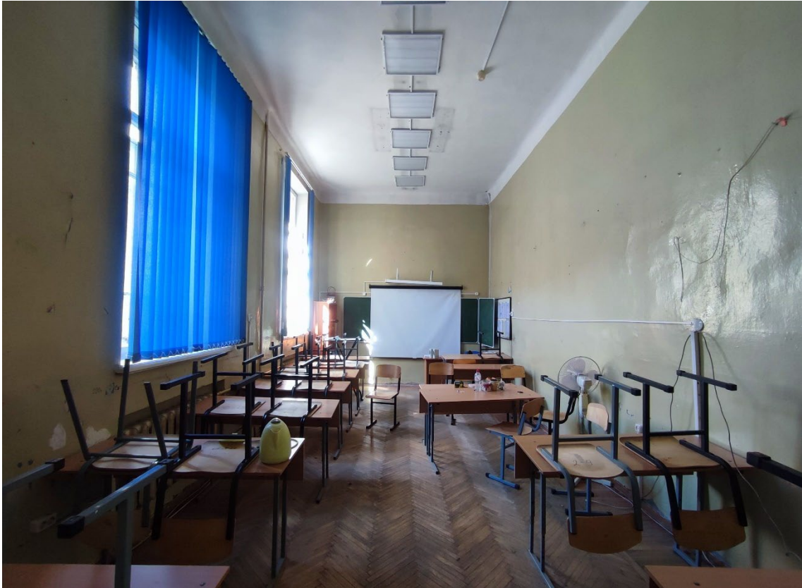
93. Объект культурного наследия регионального значения «Реальное училище», расположенный по адресу: Санкт-Петербург, город Пушкин, Госпитальная улица, дом 24, литера А. Общий вид пом. 1-Н (64) в уровне 2-го этажа.
