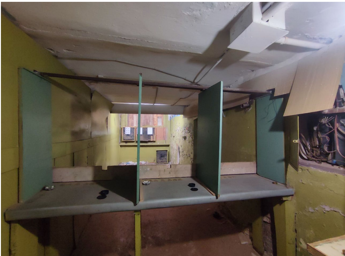
17. Объект культурного наследия регионального значения «Реальное училище», расположенный по адресу: Санкт-Петербург, город Пушкин, Госпитальная улица, дом 24, литера А. Общий вид пом. 1-Н (151) в уровне подвала.
