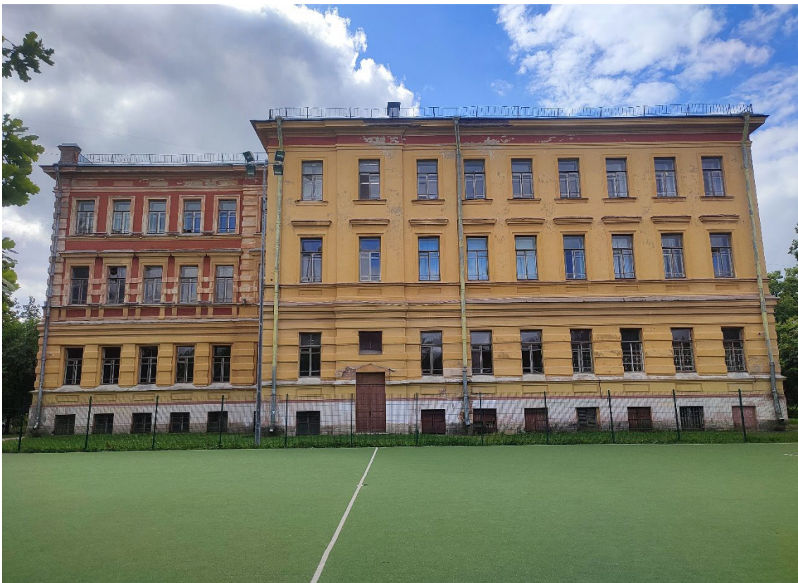
6. Объект культурного наследия регионального значения «Реальное училище», расположенный по адресу: Санкт-Петербург, город Пушкин, Госпитальная улица, дом 24, литера А. Общий вид северо-восточного бокового фасада.
