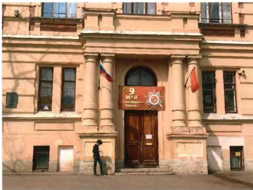
4. Фрагмент объекта культурного наследия. Входная группа со стороны восточного фасада.
