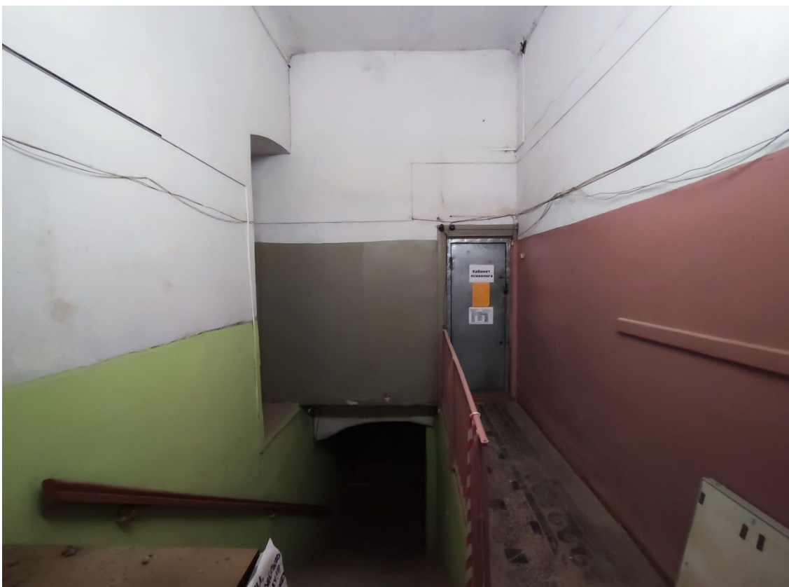
44. Объект культурного наследия регионального значения «Реальное училище», расположенный по адресу: Санкт-Петербург, город Пушкин, Госпитальная улица, дом 24, литера А. Общий вид пом. 1-Н (30) в уровне 1-го этажа.
