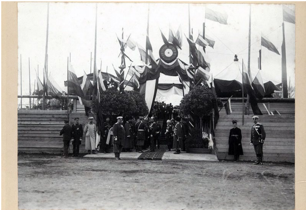
4. Царское Село. Закладка здания городского Реального училища. 1901 г. Фотоателье «К.Е. Ган и Ко».
