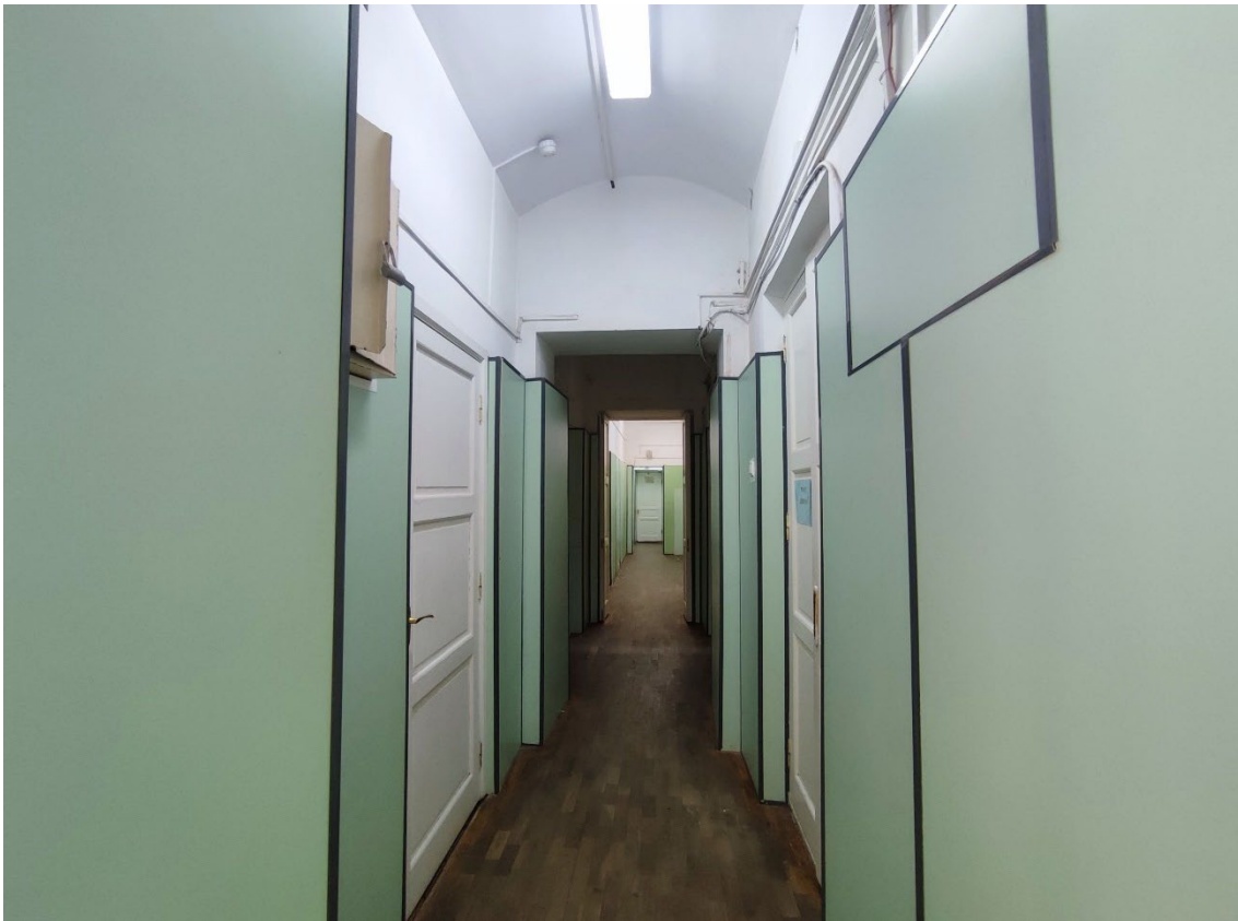
86. Объект культурного наследия регионального значения «Реальное училище», расположенный по адресу: Санкт-Петербург, город Пушкин, Госпитальная улица, дом 24, литера А. Общий вид пом. 1-Н (79) в уровне 2-го этажа.
