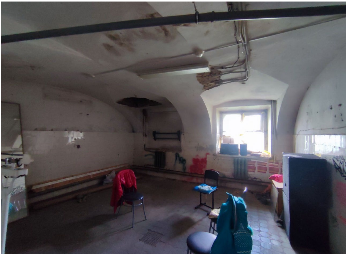
28. Объект культурного наследия регионального значения «Реальное училище», расположенный по адресу: Санкт-Петербург, город Пушкин, Госпитальная улица, дом 24, литера А. Общий вид пом. 1-Н (132) в уровне подвала.
