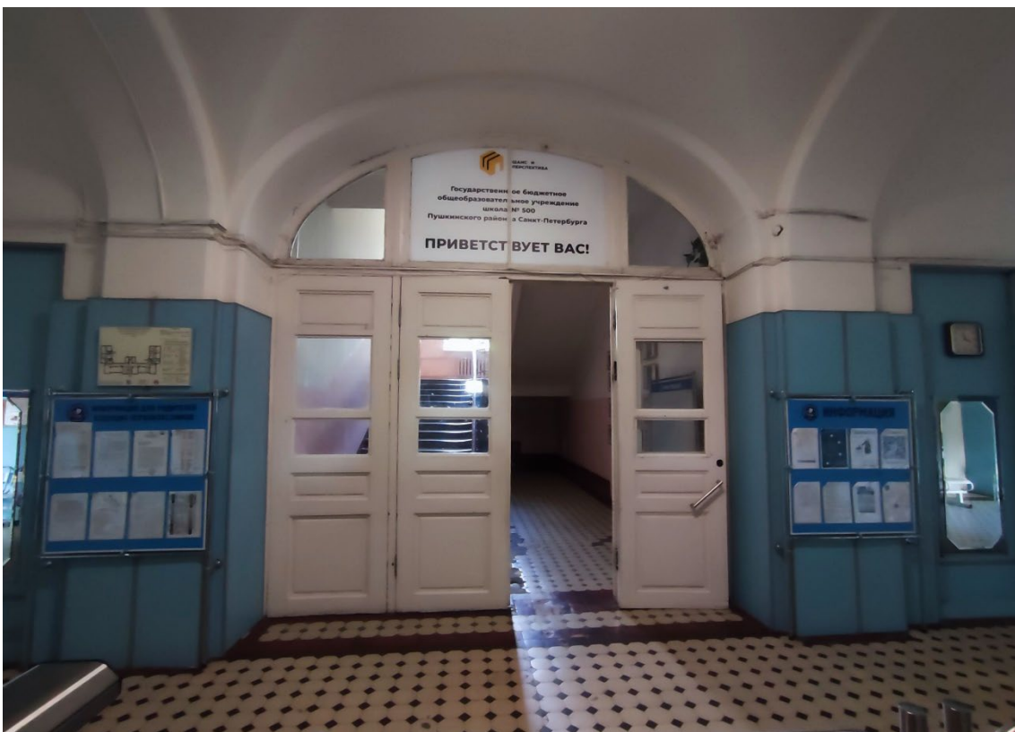
35. Объект культурного наследия регионального значения «Реальное училище», расположенный по адресу: Санкт-Петербург, город Пушкин, Госпитальная улица, дом 24, литера А. Фрагмент пом. 1-Н (9) в уровне 1-го этажа. Вход на лестничную клетку центральной двухмаршевой лестницы главного корпуса.
