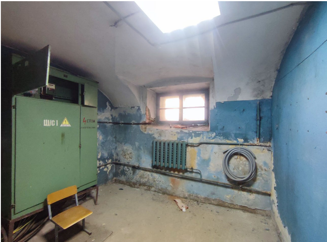
9. Объект культурного наследия регионального значения «Реальное училище», расположенный по адресу: Санкт-Петербург, город Пушкин, Госпитальная улица, дом 24, литера А. Общий вид пом. 1-Н (174) в уровне подвала.
