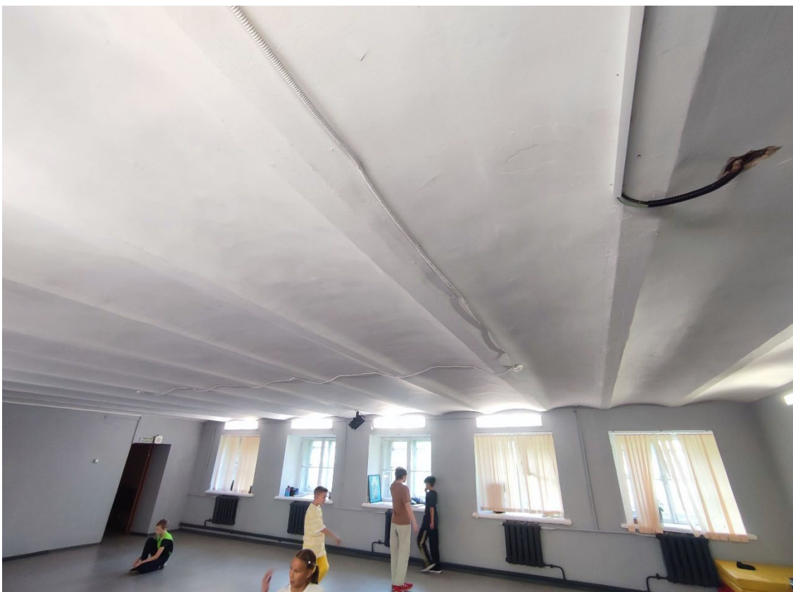
13. Объект культурного наследия регионального значения «Реальное училище», расположенный по адресу: Санкт-Петербург, город Пушкин, Госпитальная улица, дом 24, литера А. Общий вид пом. 1-Н (143) в уровне подвала.
