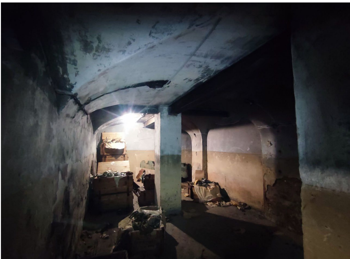
19. Объект культурного наследия регионального значения «Реальное училище», расположенный по адресу: Санкт-Петербург, город Пушкин, Госпитальная улица, дом 24, литера А. Общий вид пом. 1-Н (157) в уровне подвала.
