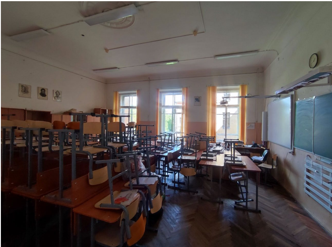
90. Объект культурного наследия регионального значения «Реальное училище», расположенный по адресу: Санкт-Петербург, город Пушкин, Госпитальная улица, дом 24, литера А. Общий вид пом. 1-Н (82) в уровне 2-го этажа.
