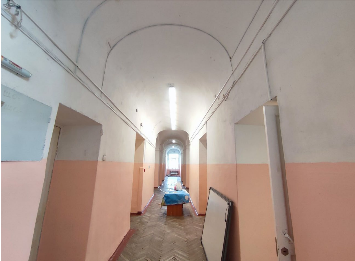
131. Объект культурного наследия регионального значения «Реальное училище», расположенный по адресу: Санкт-Петербург, город Пушкин, Госпитальная улица, дом 24, литера А. Общий вид пом. 1-Н (114) в уровне 3-го этажа.
