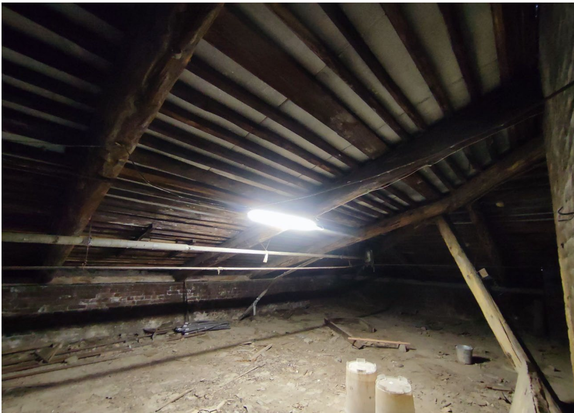
138. Объект культурного наследия регионального значения «Реальное училище», расположенный по адресу: Санкт-Петербург, город Пушкин, Госпитальная улица, дом 24, литера А. Фрагмент стропильной системы крыши южного корпуса.
