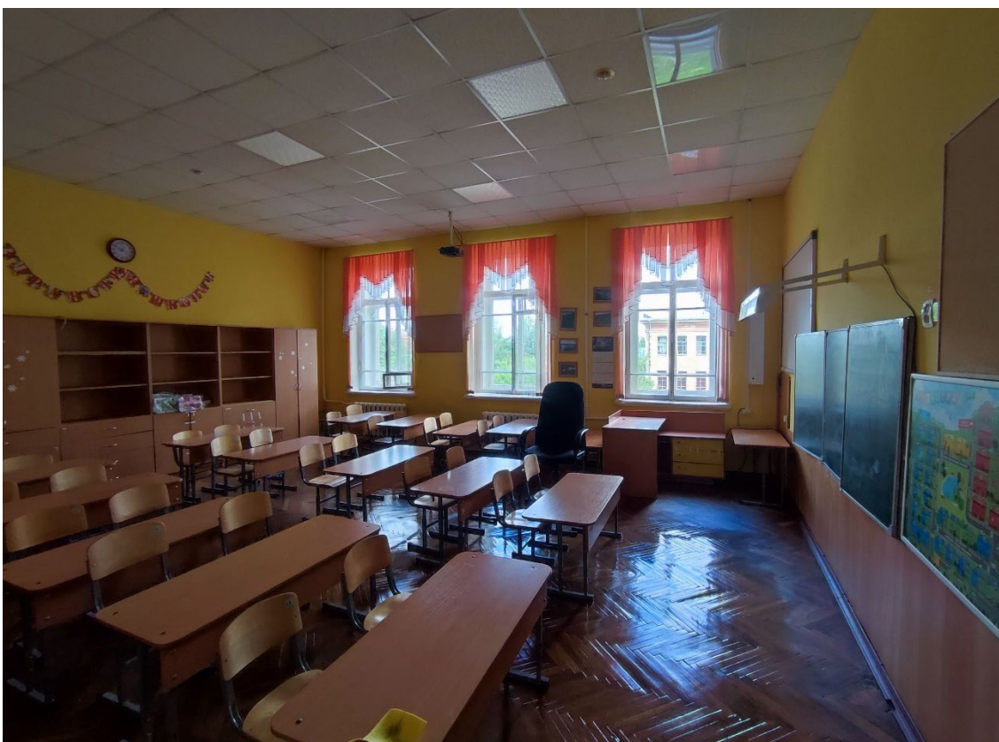
124. Объект культурного наследия регионального значения «Реальное училище», расположенный по адресу: Санкт-Петербург, город Пушкин, Госпитальная улица, дом 24, литера А. Общий вид пом. 1-Н (88) в уровне 3-го этажа.
