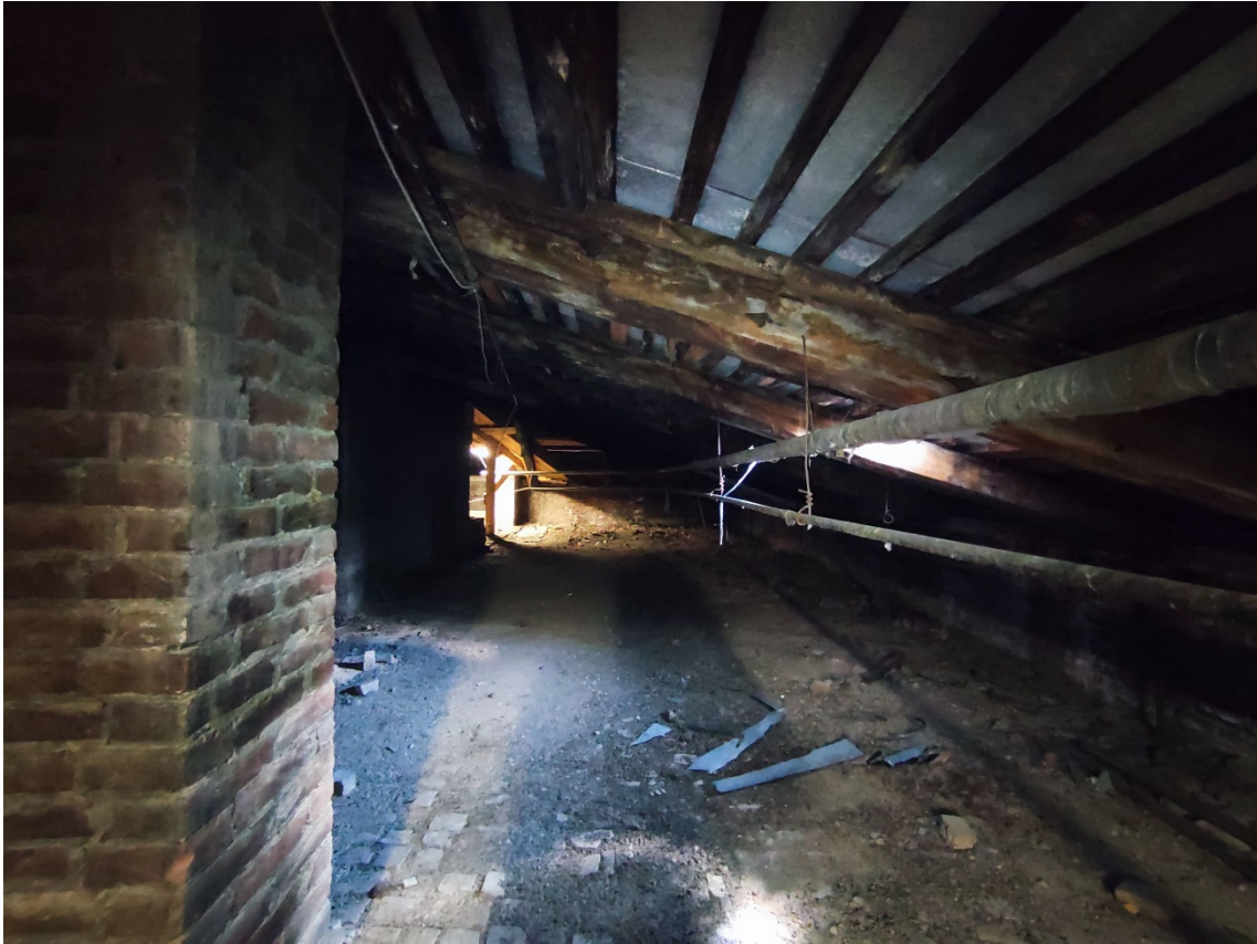
139. Объект культурного наследия регионального значения «Реальное училище», расположенный по адресу: Санкт-Петербург, город Пушкин, Госпитальная улица, дом 24, литера А. Фрагмент стропильной системы крыши южного корпуса.
