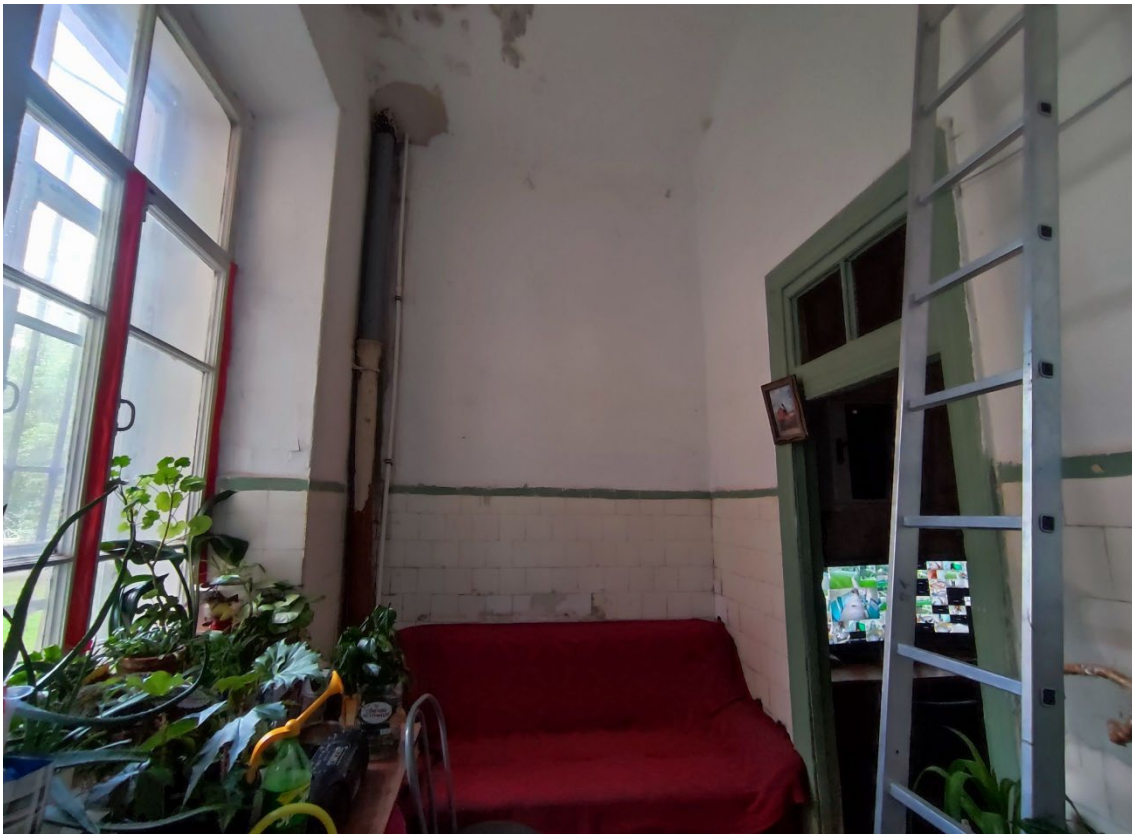
46. Объект культурного наследия регионального значения «Реальное училище», расположенный по адресу: Санкт-Петербург, город Пушкин, Госпитальная улица, дом 24, литера А. Общий вид пом. 1-Н (32) в уровне 1-го этажа.
