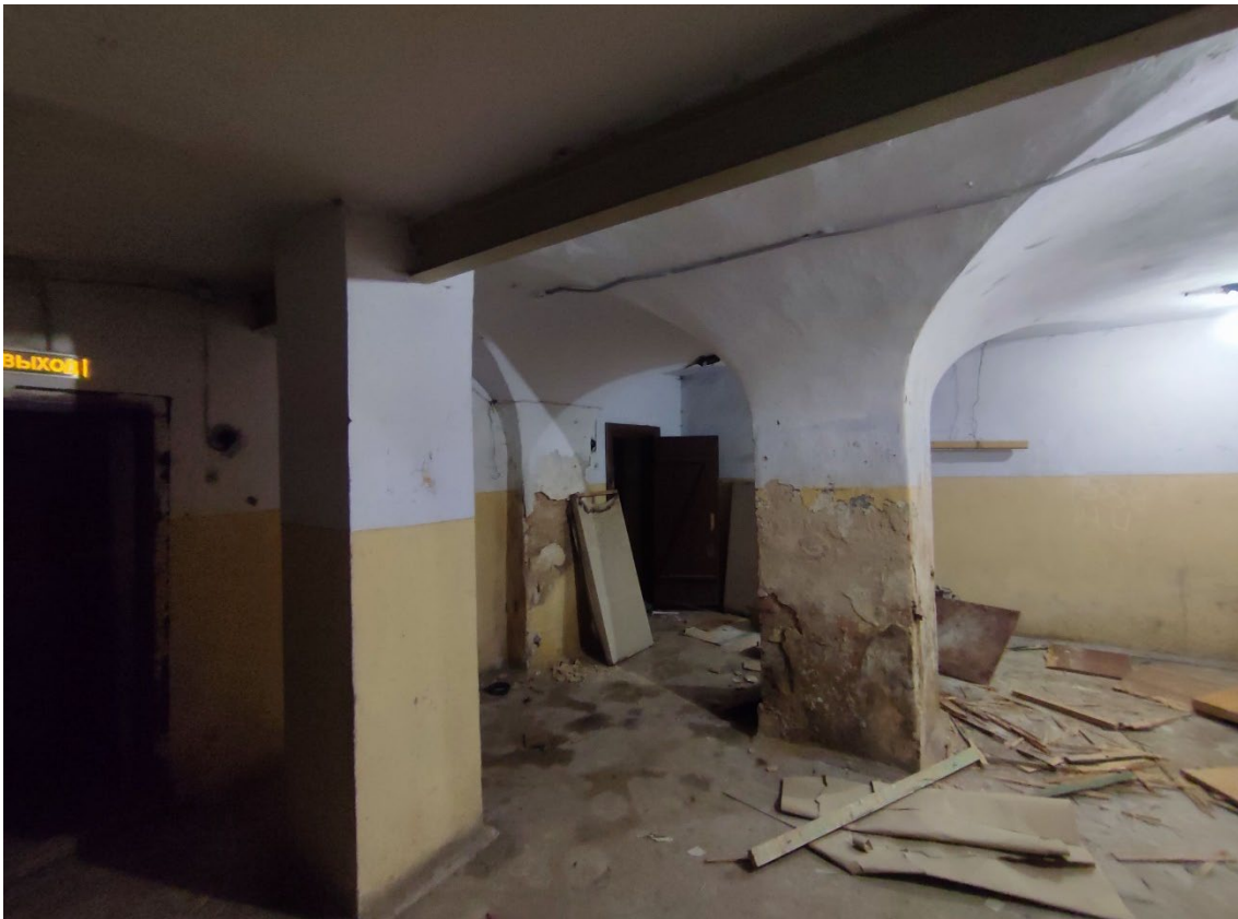
23. Объект культурного наследия регионального значения «Реальное училище», расположенный по адресу: Санкт-Петербург, город Пушкин, Госпитальная улица, дом 24, литера А. Общий вид пом. 1-Н (164) в уровне подвала.
