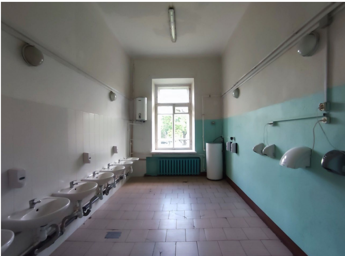
50. Объект культурного наследия регионального значения «Реальное училище», расположенный по адресу: Санкт-Петербург, город Пушкин, Госпитальная улица, дом 24, литера А. Общий вид пом. 1-Н (48) в уровне 1-го этажа.
