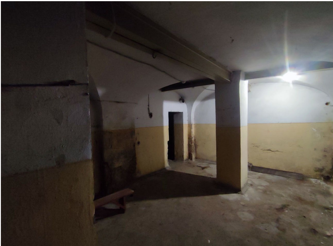
21. Объект культурного наследия регионального значения «Реальное училище», расположенный по адресу: Санкт-Петербург, город Пушкин, Госпитальная улица, дом 24, литера А. Общий вид пом. 1-Н (161) в уровне подвала.
