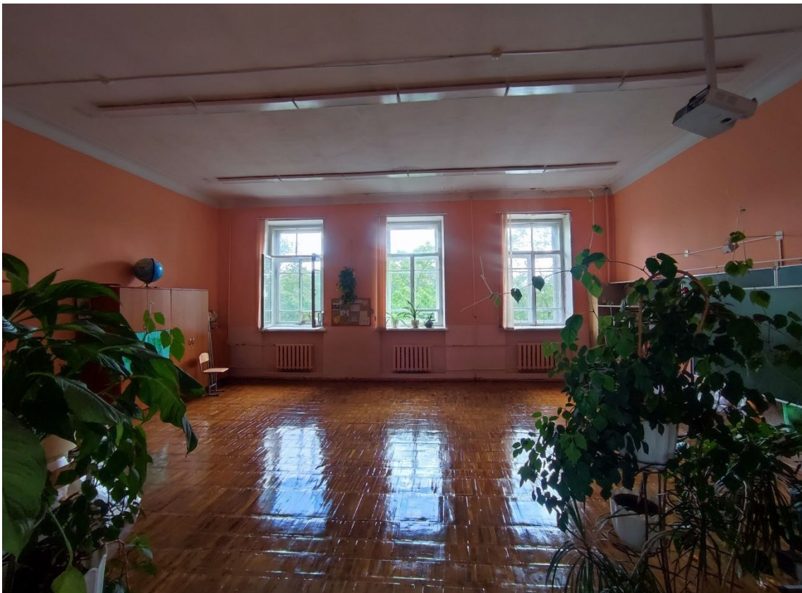
126. Объект культурного наследия регионального значения «Реальное училище», расположенный по адресу: Санкт-Петербург, город Пушкин, Госпитальная улица, дом 24, литера А. Общий вид пом. 1-Н (107) в уровне 3-го этажа.
