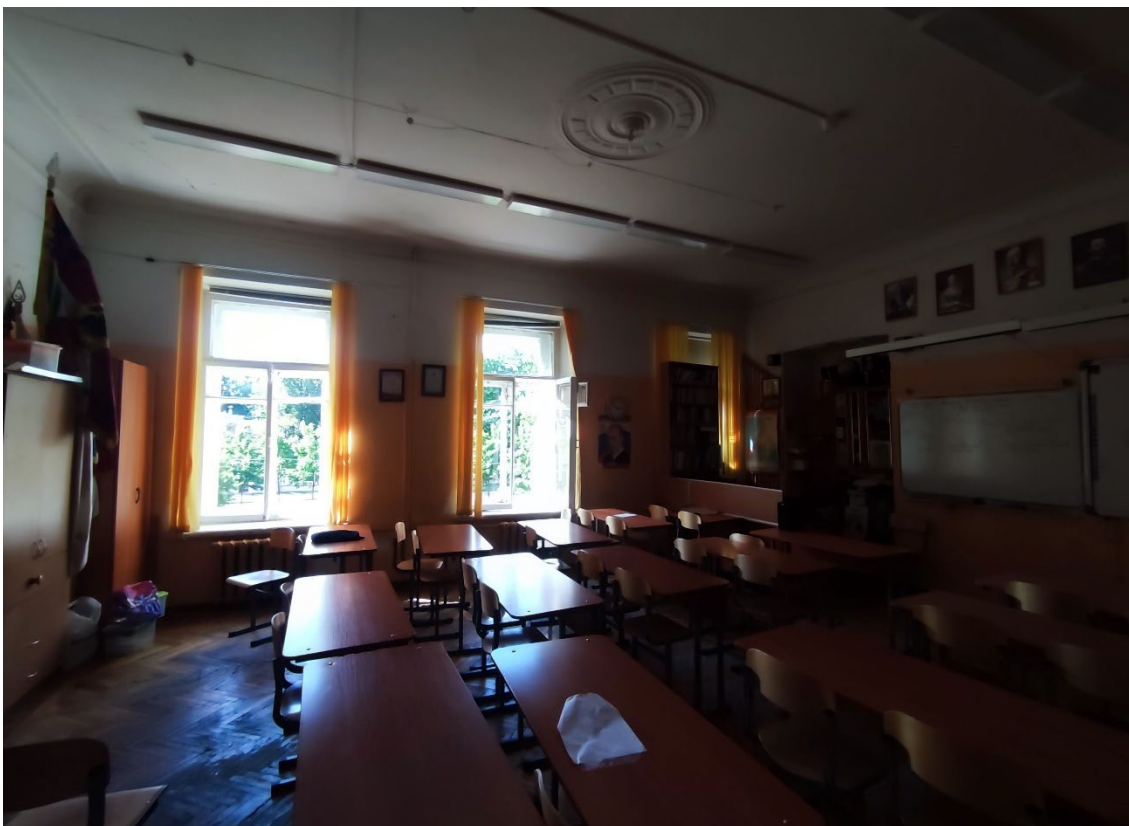
89. Объект культурного наследия регионального значения «Реальное училище», расположенный по адресу: Санкт-Петербург, город Пушкин, Госпитальная улица, дом 24, литера А. Общий вид пом. 1-Н (78) в уровне 2-го этажа.
