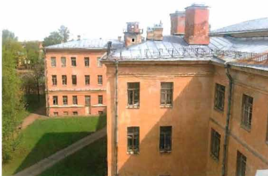
3. Фрагмент западного фасада объекта культурного наследия. Вид с крыши.
