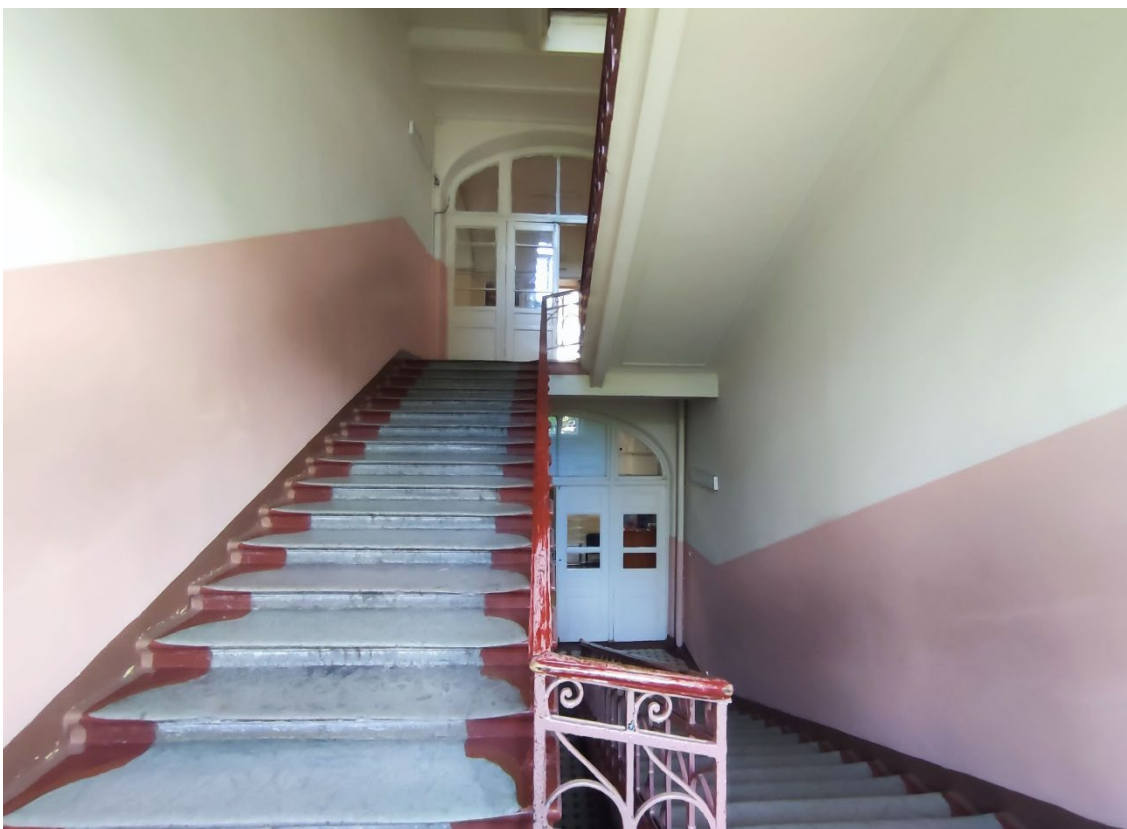
76. Объект культурного наследия регионального значения «Реальное училище», расположенный по адресу: Санкт-Петербург, город Пушкин, Госпитальная улица, дом 24, литера А. Общий вид центральной двухмаршевой лестницы главного корпуса с площадки между 1-м и 2-м этажами.
