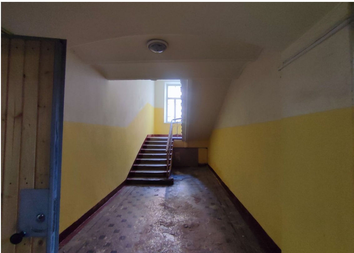
29. Объект культурного наследия регионального значения «Реальное училище», расположенный по адресу: Санкт-Петербург, город Пушкин, Госпитальная улица, дом 24, литера А. Общий вид двухмаршевой лестницы южного корпуса в уровне подвала (пом. 1-Н (176)).
