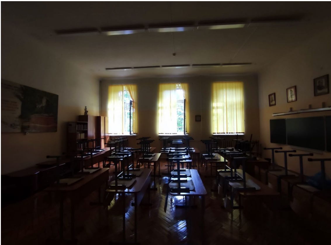
82. Объект культурного наследия регионального значения «Реальное училище», расположенный по адресу: Санкт-Петербург, город Пушкин, Госпитальная улица, дом 24, литера А. Общий вид пом. 1-Н (73) в уровне 2-го этажа.
