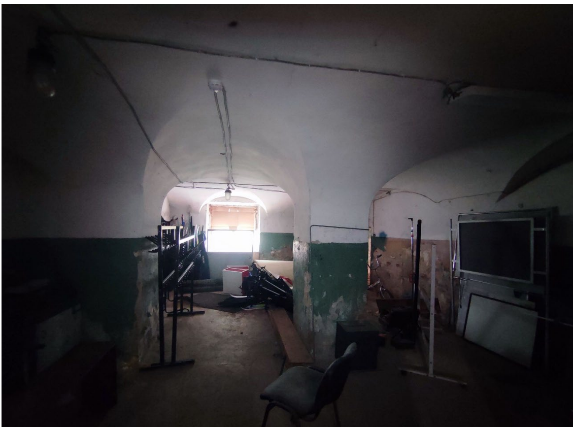
15. Объект культурного наследия регионального значения «Реальное училище», расположенный по адресу: Санкт-Петербург, город Пушкин, Госпитальная улица, дом 24, литера А. Общий вид пом. 1-Н (145) в уровне подвала.
