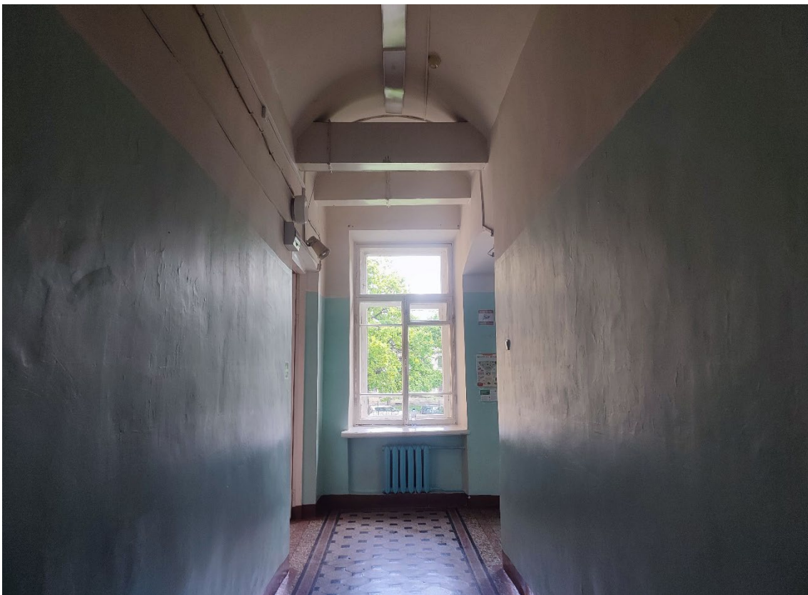
47. Объект культурного наследия регионального значения «Реальное училище», расположенный по адресу: Санкт-Петербург, город Пушкин, Госпитальная улица, дом 24, литера А. Общий вид пом. 1-Н (35) в уровне 1-го этажа.
