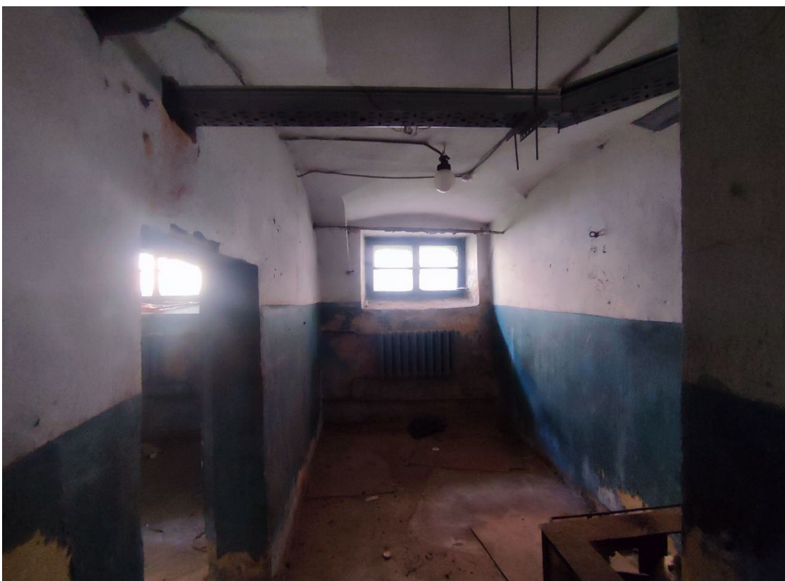
8. Объект культурного наследия регионального значения «Реальное училище», расположенный по адресу: Санкт-Петербург, город Пушкин, Госпитальная улица, дом 24, литера А. Общий вид пом. 1-Н (173) в уровне подвала.
