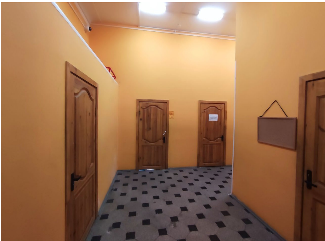
60. Объект культурного наследия регионального значения «Реальное училище», расположенный по адресу: Санкт-Петербург, город Пушкин, Госпитальная улица, дом 24, литера А. Общий вид пом. 1-Н (3) в уровне 1-го этажа.
