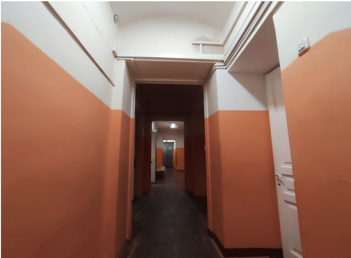
69. Объект культурного наследия регионального значения «Реальное училище», расположенный по адресу: Санкт-Петербург, город Пушкин, Госпитальная улица, дом 24, литера А. Общий вид пом. 1-Н (17) в уровне 1-го этажа.
