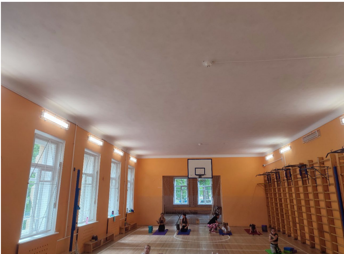
65. Объект культурного наследия регионального значения «Реальное училище», расположенный по адресу: Санкт-Петербург, город Пушкин, Госпитальная улица, дом 24, литера А. Общий вид пом. 1-Н (8) в уровне 1-го этажа.
