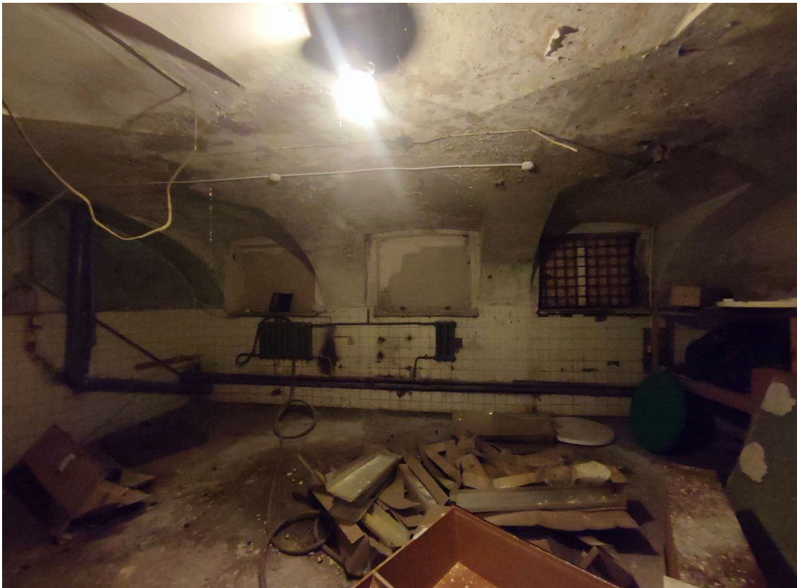
27. Объект культурного наследия регионального значения «Реальное училище», расположенный по адресу: Санкт-Петербург, город Пушкин, Госпитальная улица, дом 24, литера А. Общий вид пом. 1-Н (127-129) в уровне подвала.
