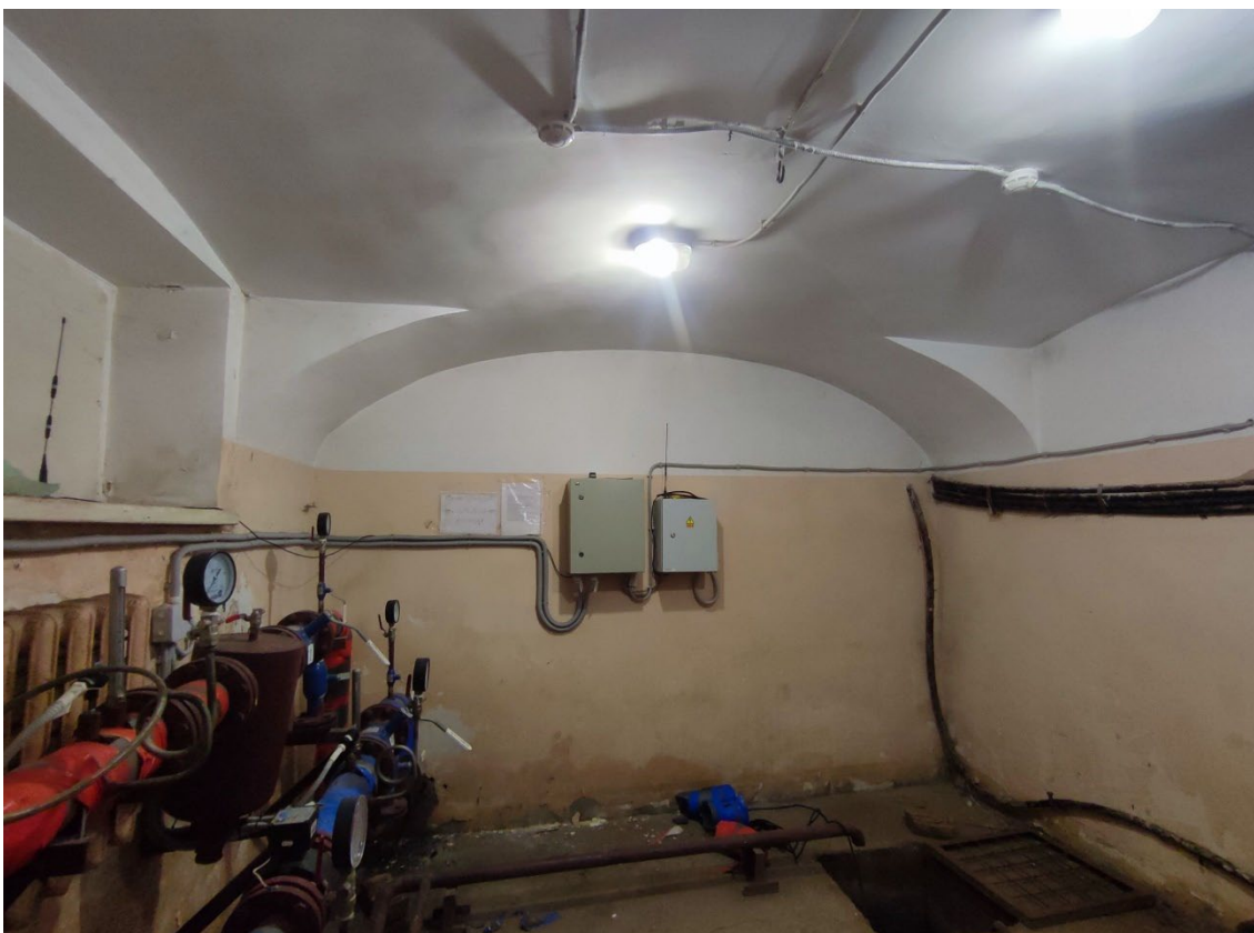
12. Объект культурного наследия регионального значения «Реальное училище», расположенный по адресу: Санкт-Петербург, город Пушкин, Госпитальная улица, дом 24, литера А. Общий вид пом. 1-Н (171) в уровне подвала.
