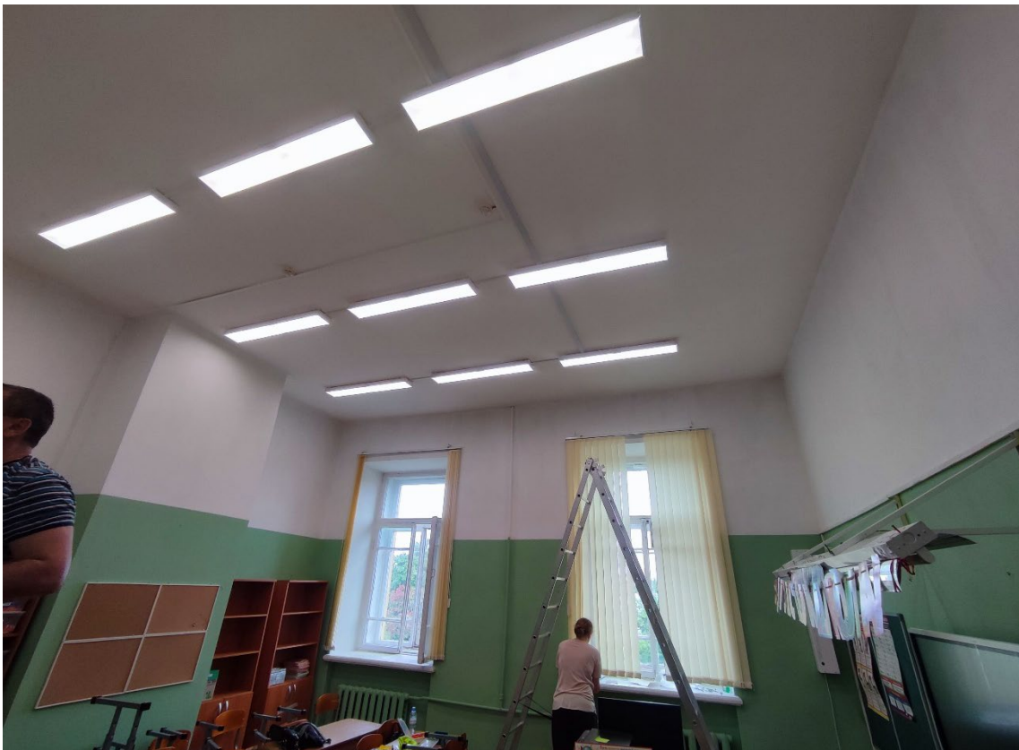
132. Объект культурного наследия регионального значения «Реальное училище», расположенный по адресу: Санкт-Петербург, город Пушкин, Госпитальная улица, дом 24, литера А. Общий вид пом. 1-Н (121) в уровне 3-го этажа.
