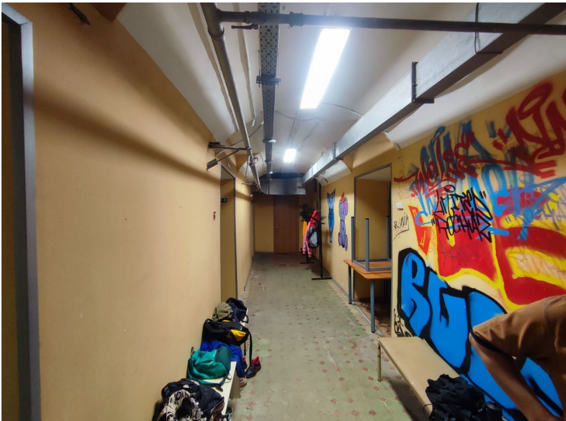
24. Объект культурного наследия регионального значения «Реальное училище», расположенный по адресу: Санкт-Петербург, город Пушкин, Госпитальная улица, дом 24, литера А. Фрагмент пом. 1-Н (123) в уровне подвала.
