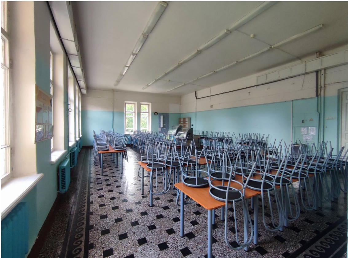
48. Объект культурного наследия регионального значения «Реальное училище», расположенный по адресу: Санкт-Петербург, город Пушкин, Госпитальная улица, дом 24, литера А. Общий вид пом. 1-Н (34) в уровне 1-го этажа.
