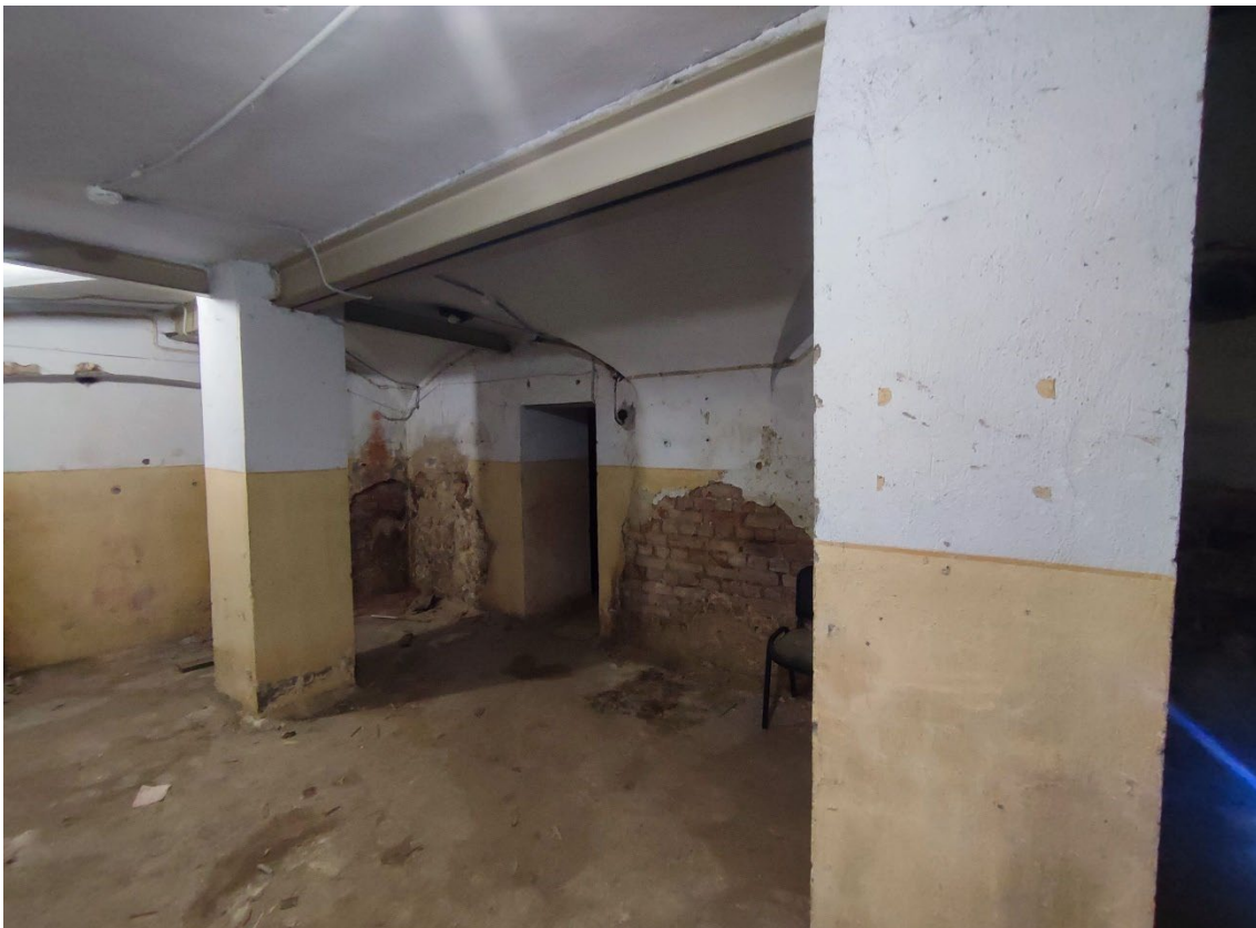
22. Объект культурного наследия регионального значения «Реальное училище», расположенный по адресу: Санкт-Петербург, город Пушкин, Госпитальная улица, дом 24, литера А. Общий вид пом. 1-Н (162) в уровне подвала.
