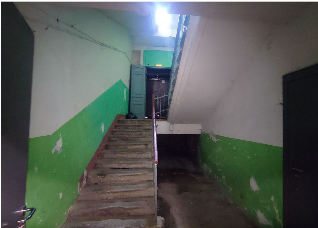
25. Объект культурного наследия регионального значения «Реальное училище», расположенный по адресу: Санкт-Петербург, город Пушкин, Госпитальная улица, дом 24, литера А. Общий вид двухмаршевой лестницы северного корпуса в уровне подвала (пом. 1-Н (122)).
