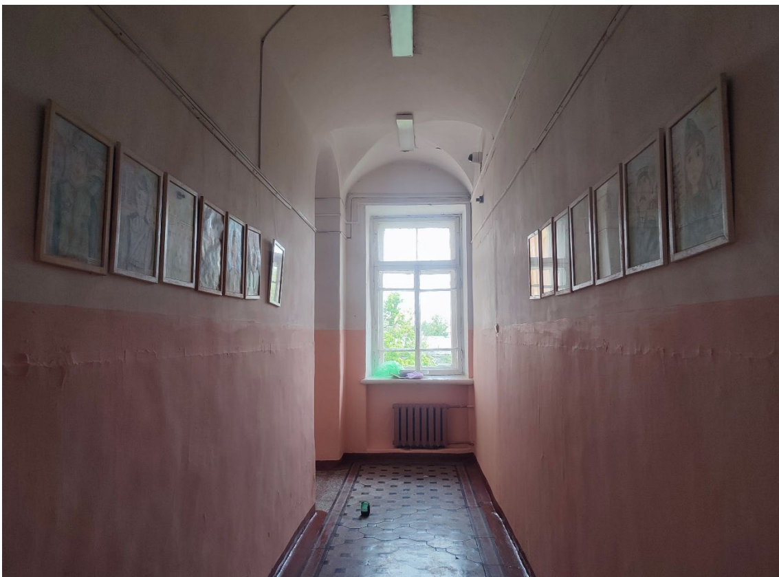
130. Объект культурного наследия регионального значения «Реальное училище», расположенный по адресу: Санкт-Петербург, город Пушкин, Госпитальная улица, дом 24, литера А. Общий вид пом. 1-Н (111) в уровне 3-го этажа.
