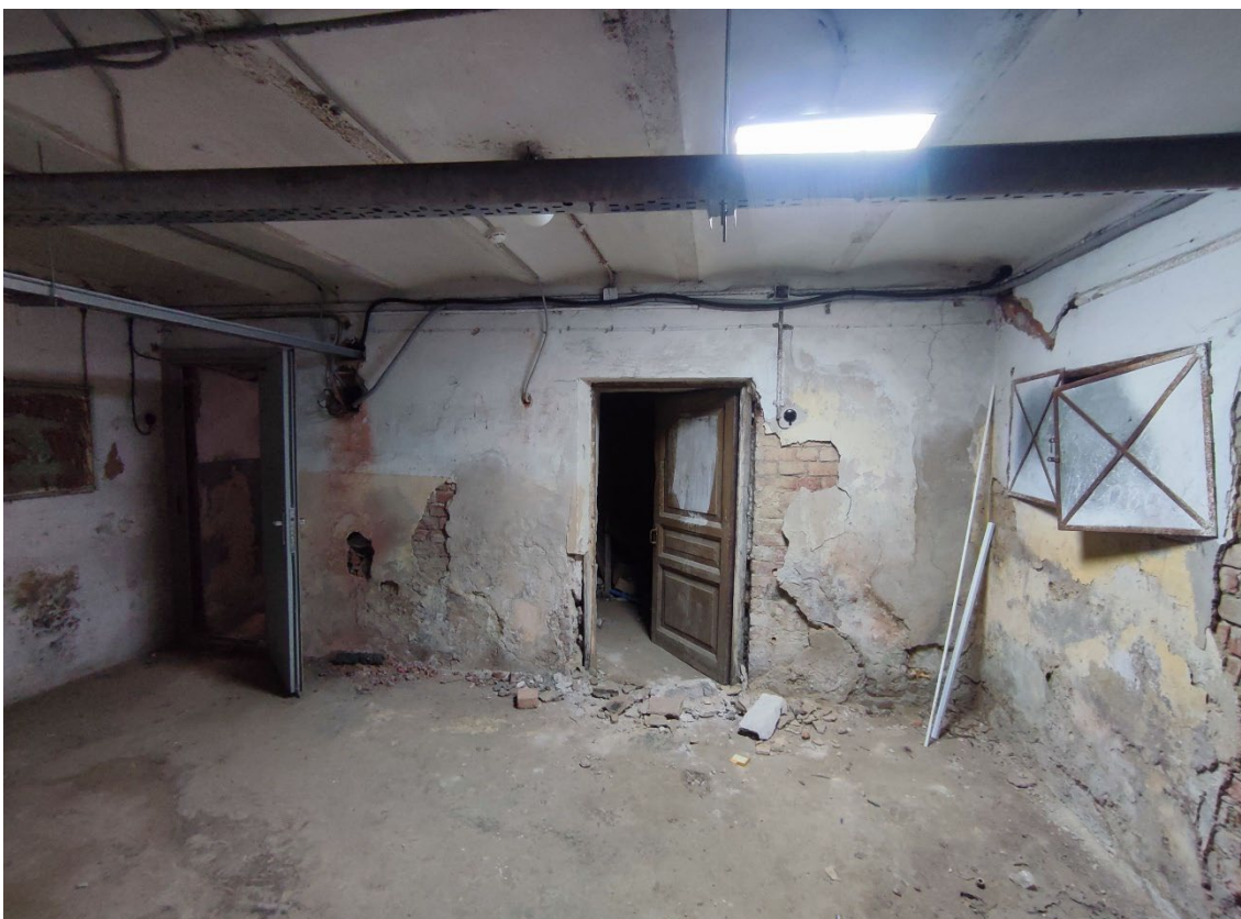
7. Объект культурного наследия регионального значения «Реальное училище», расположенный по адресу: Санкт-Петербург, город Пушкин, Госпитальная улица, дом 24, литера А. Общий вид пом. 1-Н (166) в уровне подвала.
