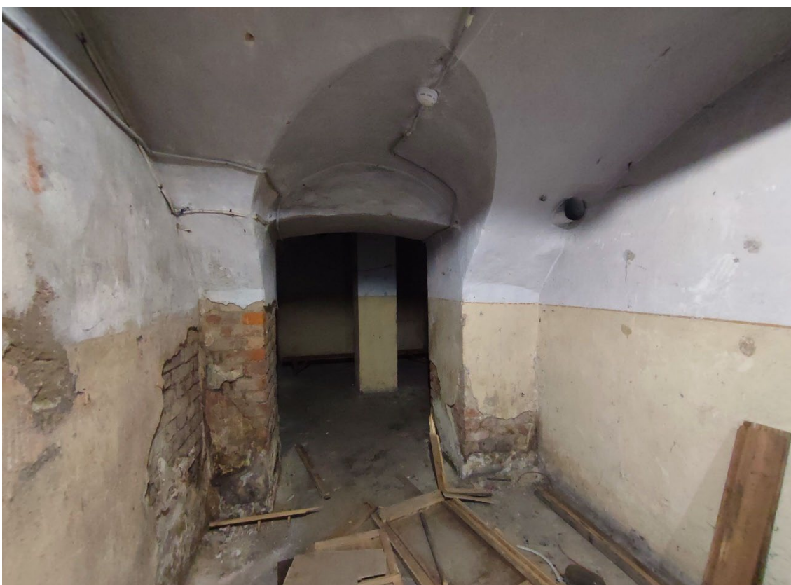
20. Объект культурного наследия регионального значения «Реальное училище», расположенный по адресу: Санкт-Петербург, город Пушкин, Госпитальная улица, дом 24, литера А. Общий вид пом. 1-Н (156) в уровне подвала.
