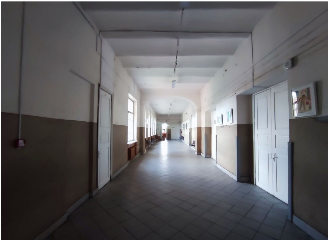
108. Объект культурного наследия регионального значения «Реальное училище», расположенный по адресу: Санкт-Петербург, город Пушкин, Госпитальная улица, дом 24, литера А. Общий вид пом. 1-Н (100) в уровне 3-го этажа.
