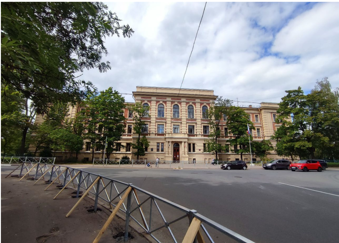
1. Объект культурного наследия регионального значения «Реальное училище», расположенный по адресу: Санкт-Петербург, город Пушкин, Госпитальная улица, дом 24, литера А. Общий вид юго-восточного лицевого фасада со стороны пересечения Московского переуллка и Госпитальной улицы.
