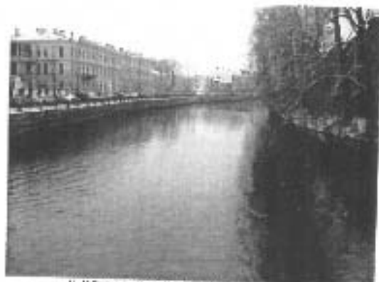
15. Набережная близ Павлова моста (на набережной)
