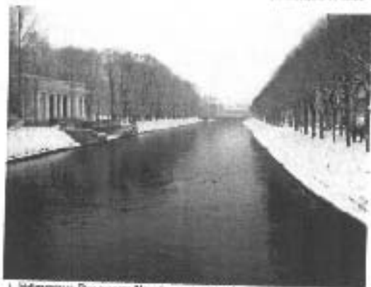
6. Набережная Ваг с моста Михайловского (от Садовой) по каналу, расположенному в углу (от набережной) моста Михайловского (от Садовой) от 7 (от Садовой) моста (правый берег)
