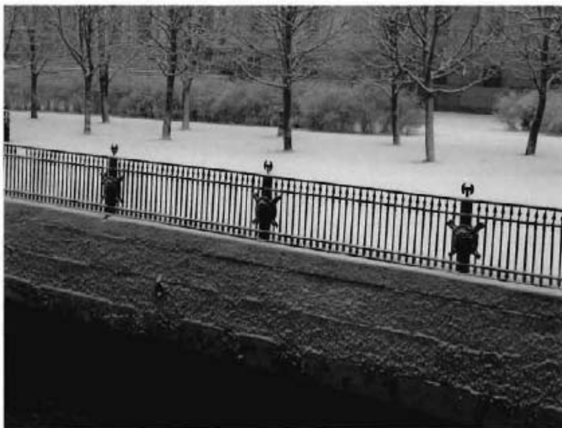
3. Ограждение набережной со стороны Михайловского (Инженерного) замка
