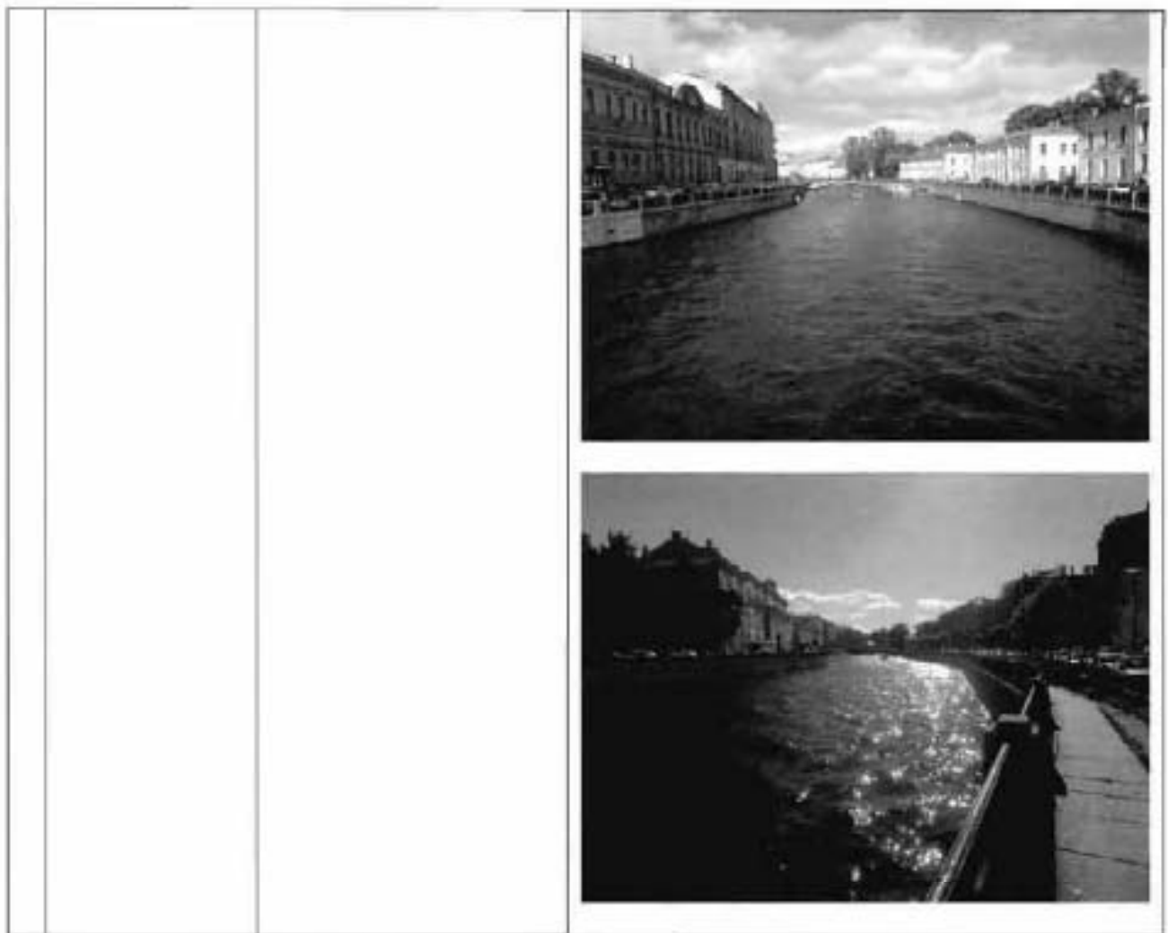
1. «Мост Инженерный Первый», 1824-1826 гг., инж. Базен П.П., 1952-1954 гг., инж. Левин Б.Б., 1953 г., арх. Ротач А.Л., расположенный по адресу: Санкт-Петербург, через р. Мойку по р. Фонтанке наб.
