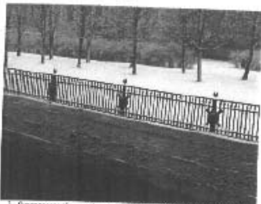
5. Ограда на набережной от сада Михайловского (Нижнегородский канал)
