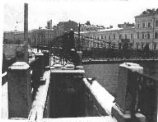
14. Девятинский мост у Нестановского моста
