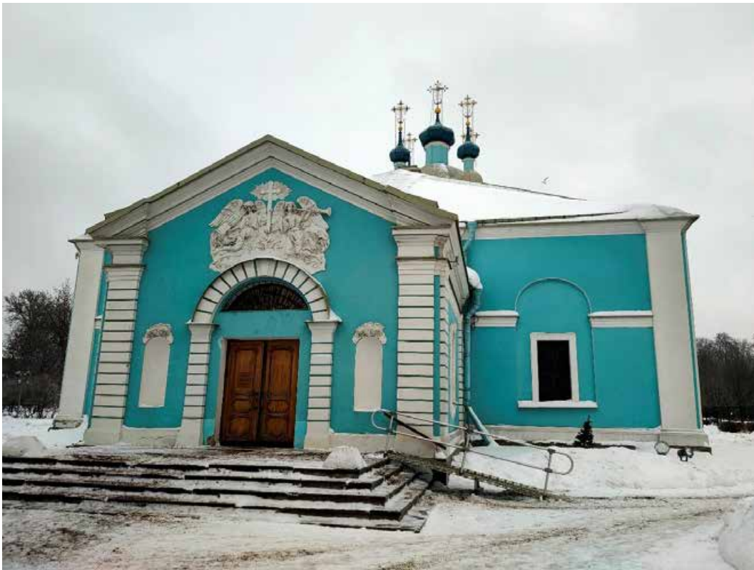
1. «Собор Сампсониевский», расположенный по адресу: г. Санкт-Петербург, Большой Сампсониевский пр., д. 41, лит. А. Западный фасад. Общий вид. Фото 17.11.2022г.
