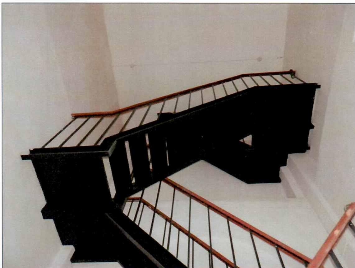
4. «Колокольня». Лестница в уровне второго яруса.
