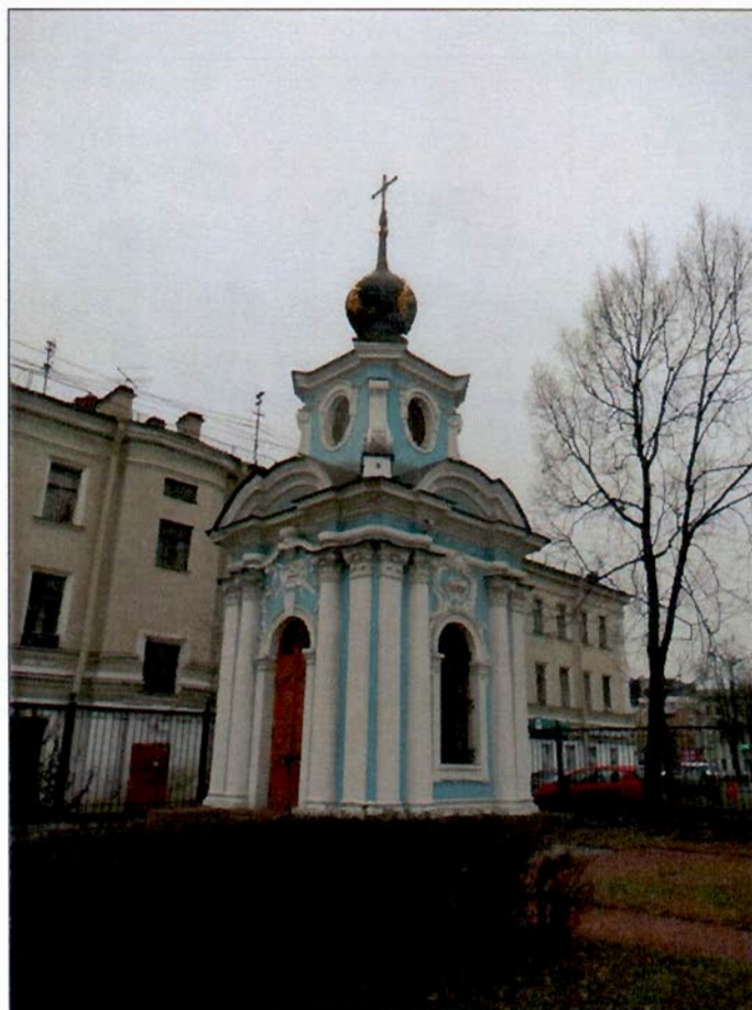
43. «Часовня». Вид с юго-востока.
