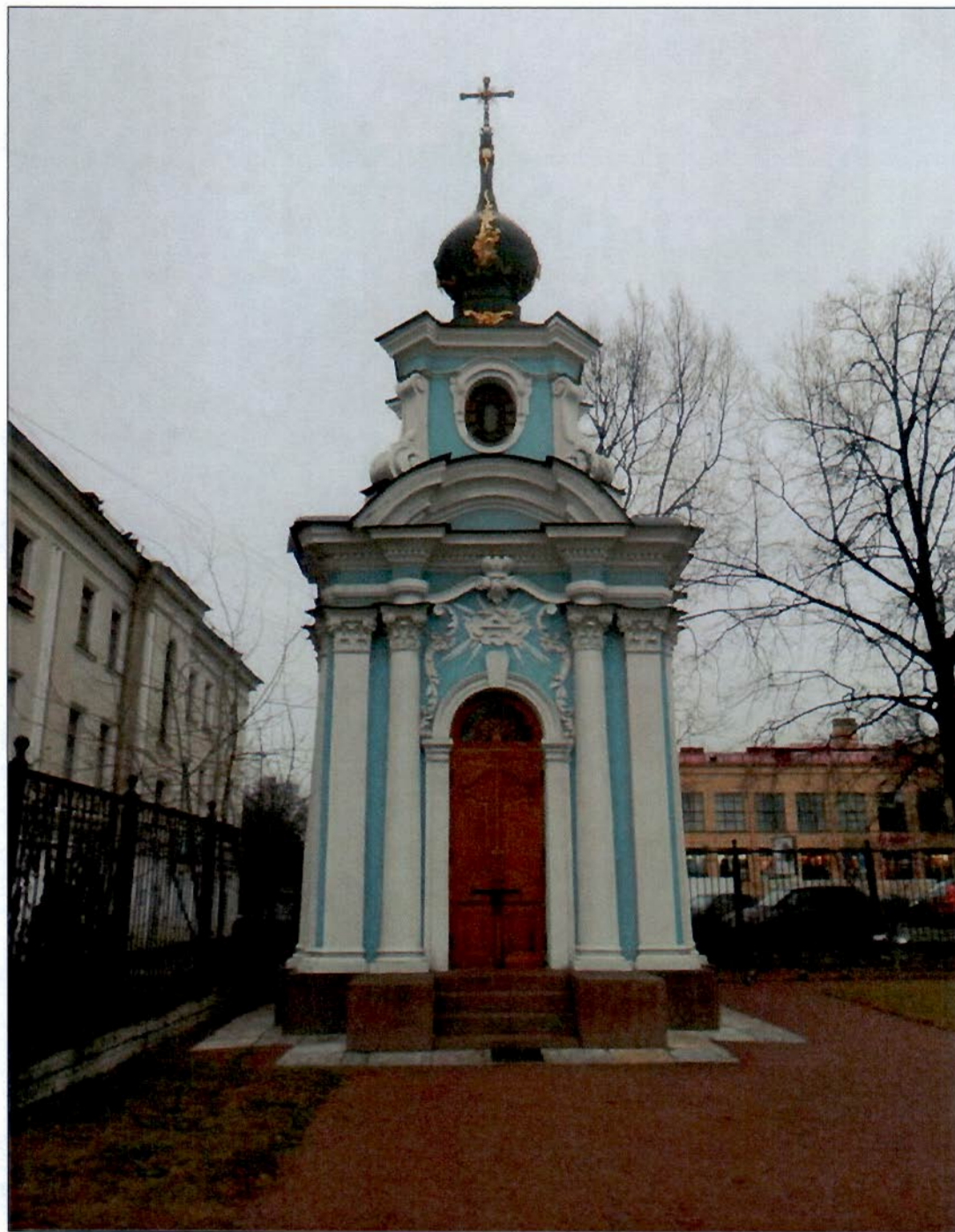
42. «Часовня». Южный фасад.
