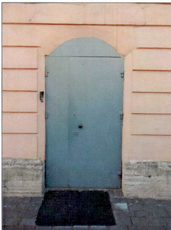
47. «Юбилейный домик». Дверной проем.
