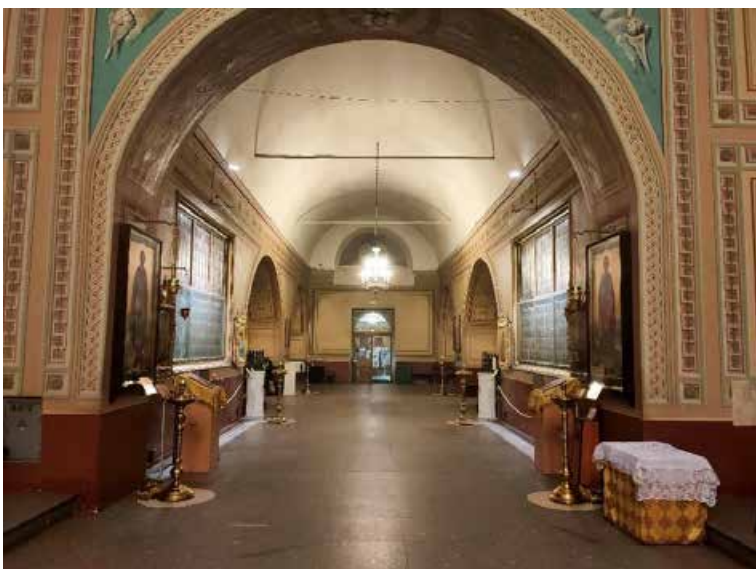
19. «Собор Сампсониевский», расположенный по адресу: г. Санкт-Петербург, Большой Сампсониевский пр., д. 41, лит. А. Общий вид на западную часть собора. Фото 17.11.2022г.
