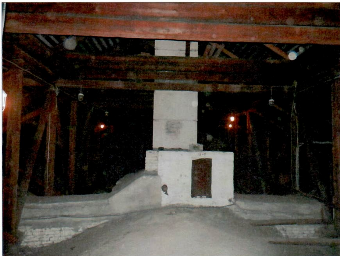
32. «Собор». Стропильная система. Фрагмент.
