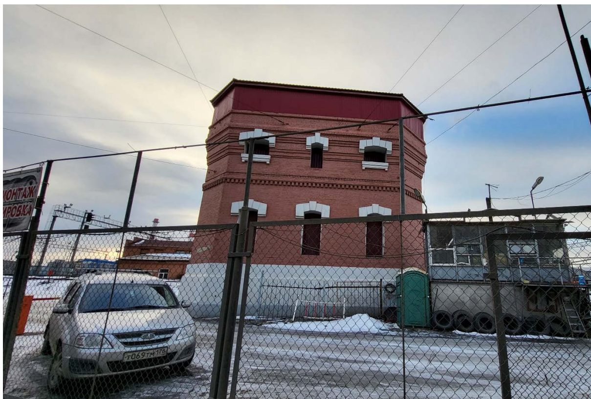
Фото 10. Выявленный объект культурного наследия «Водокачалня товарной станции Московско-Виндаво-Рыбинской железной дороги», расположенный по адресу: город Санкт-Петербург, Боровая ул., 61а Дата съемки: 15.02.2023
