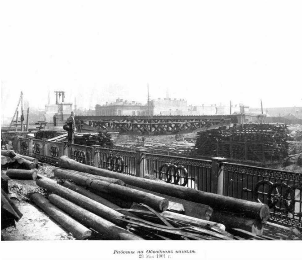
3. Строительство нового Царскосельского моста, 1901 г.
