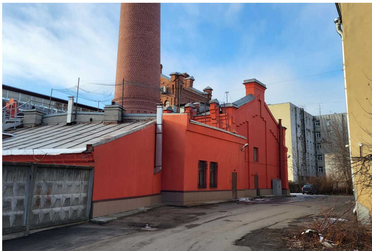
Фото 2. Выявленный объект культурного наследия «Здание электростанции общества Московско-Виндаво-Рыбинской железной дороги», расположенный по адресу: г.Санкт-Петербург, Обводного кан. наб., 70, корп. 2, лит. А1 (помещение 1-Н: части 1-8, 22-30; помещение 3-Н: части 1-5), А2, А3 Дата съемки:15.02.2023
