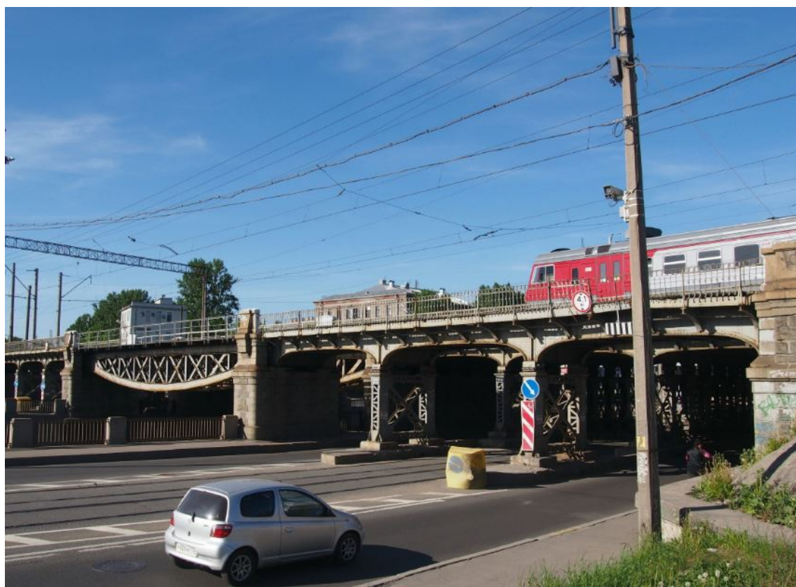
8. Общий вид с левого берега
