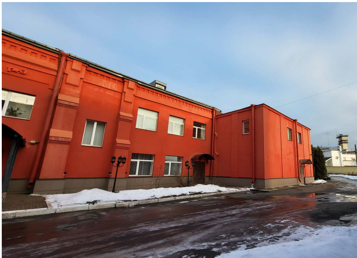
Фото 7. Выявленный объект культурного наследия «Здание электростанции общества Московско-Виндаво-Рыбинской железной дороги», расположенный по адресу: г.Санкт-Петербург, Обводного кан. наб., 70, корп. 2, лит. А1 (помещение 1-Н: части 1-8, 22-30; помещение 3-Н: части 1-5), А2, А3 Дата съемки:15.02.2023
