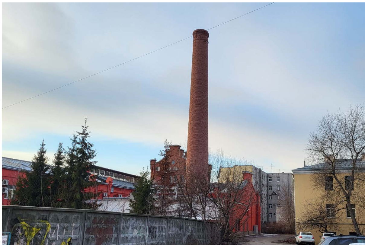
Фото 8. Выявленный объект культурного наследия «Здание электростанции общества Московско-Виндаво-Рыбинской железной дороги», расположенный по адресу: г.Санкт-Петербург, Обводного кан. наб., 70, корп. 2, лит. А1 (помещение 1-Н: части 1-8, 22-30; помещение 3-Н: части 1-5), А2, А3 Дата съемки:15.02.2023
