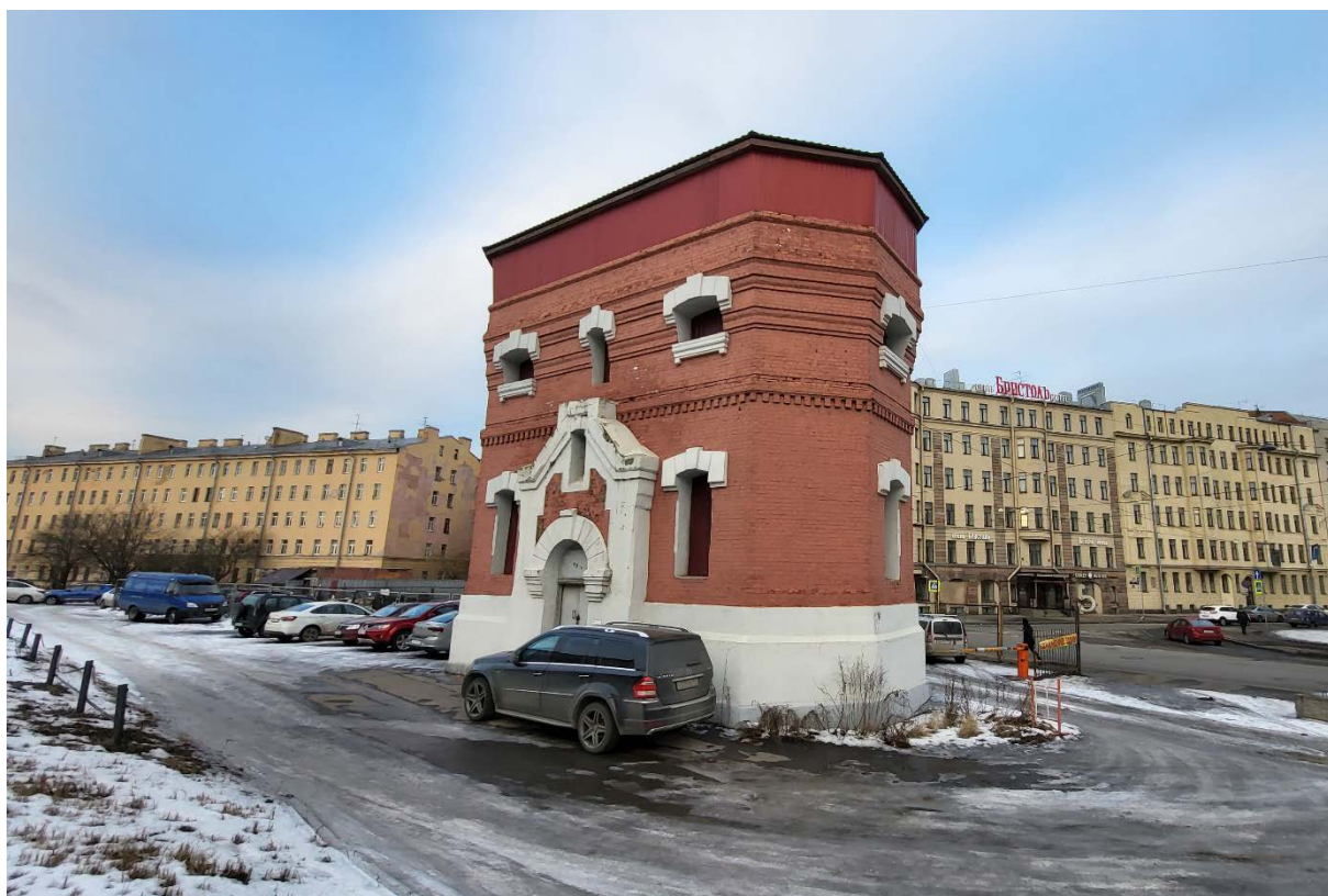
Фото 14. Выявленный объект культурного наследия «Водокачалня товарной станции Московско-Виндаво-Рыбинской железной дороги», расположенный по адресу: город Санкт-Петербург, Боровая ул., 61а Дата съемки:15.02.2023
