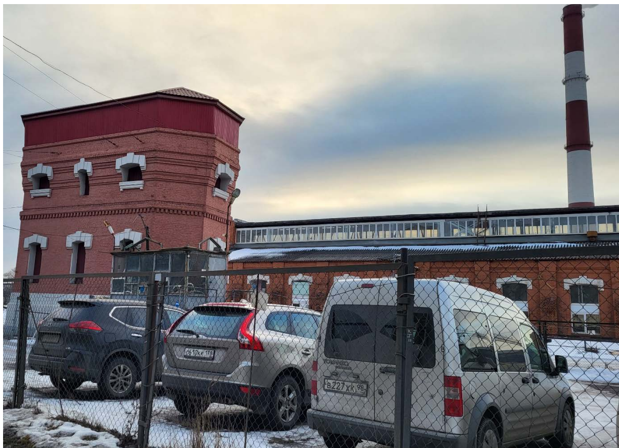
Фото 9. Выявленный объект культурного наследия «Водокачалня товарной станции Московско-Виндаво-Рыбинской железной дороги», расположенный по адресу: город Санкт-Петербург, Боровая ул., 61а Дата съемки: 15.02.2023
