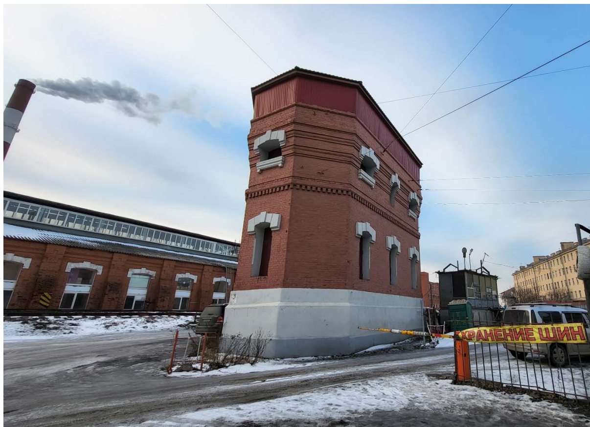
Фото 11. Выявленный объект культурного наследия «Водокачалня товарной станции Московско-Виндаво-Рыбинской железной дороги», расположенный по адресу: город Санкт-Петербург, Боровая ул., 61а Дата съемки:15.02.2023
