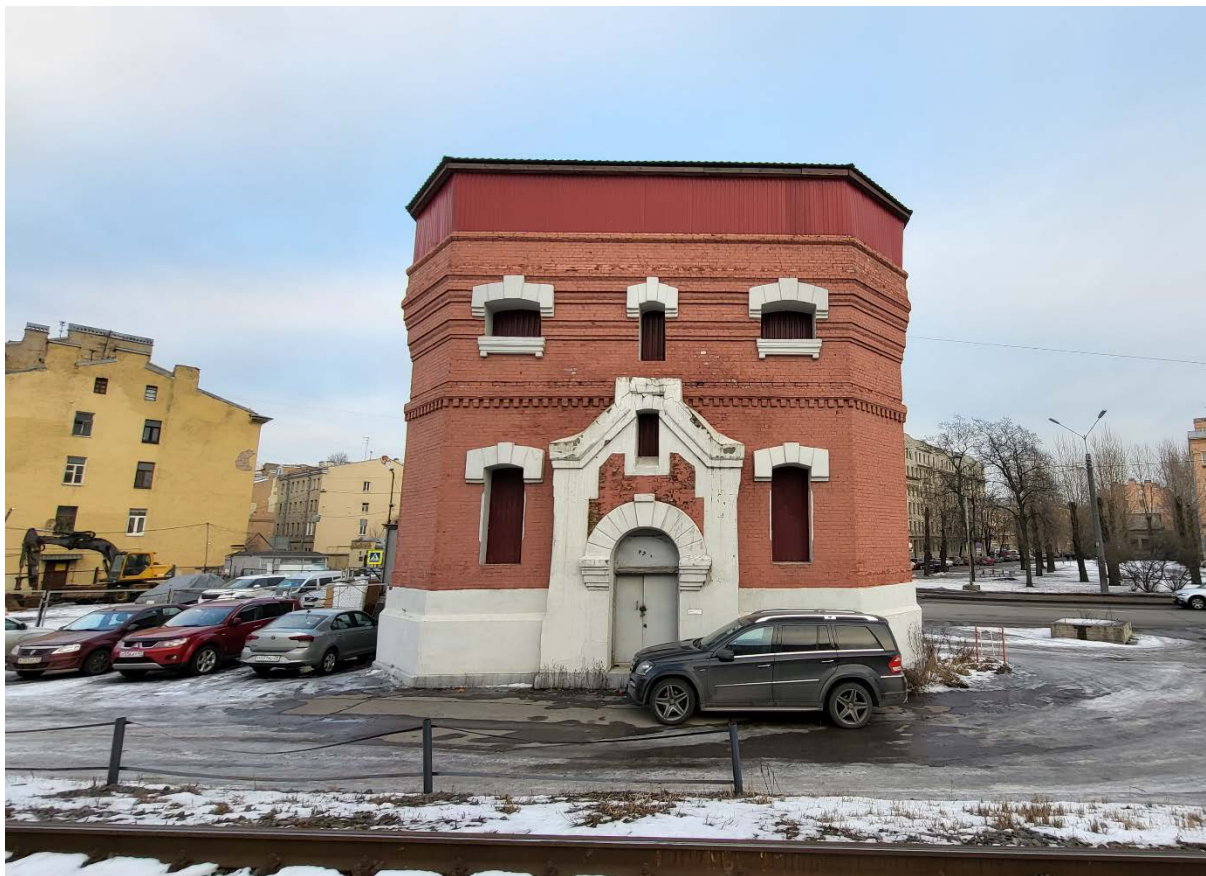
Фото 15. Выявленный объект культурного наследия «Водокачалня товарной станции Московско-Виндаво-Рыбинской железной дороги», расположенный по адресу: город Санкт-Петербург, Боровая ул., 61а Дата съемки:15.02.2023
