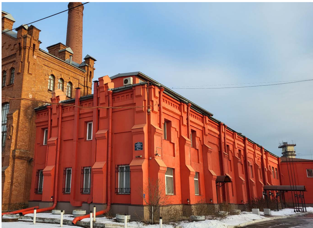
Фото 5. Выявленный объект культурного наследия «Здание электростанции общества Московско-Виндаво-Рыбинской железной дороги», расположенный по адресу: г.Санкт-Петербург, Обводного кан. наб., 70, корп. 2, лит. А1 (помещение 1-Н: части 1-8, 22-30; помещение 3-Н: части 1-5), А2, А3 Дата съемки:15.02.2023
