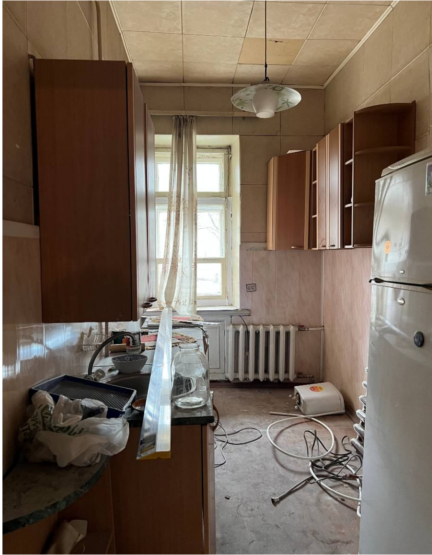
9. Вид в интерьере квартиры №70 (пом. 4).
