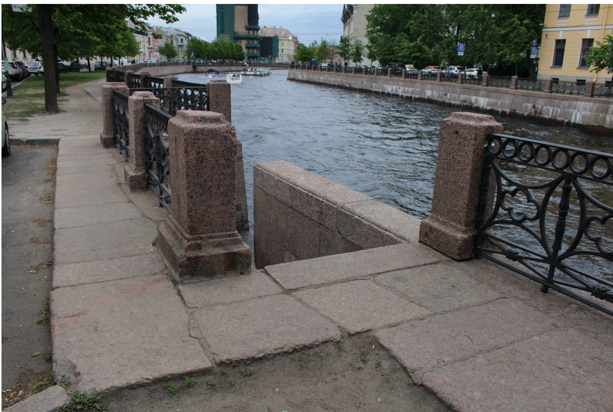
Фото 3. Вид на спуск № 15 объекта культурного наследия федерального значения «Набережные со спусками».
