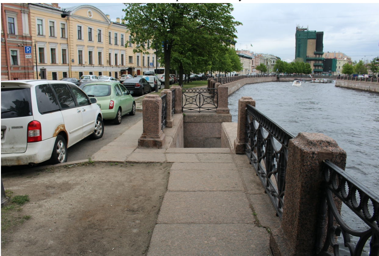
Фото 4. Вид на спуск № 15 объекта культурного наследия федерального значения «Набережные со спусками».
