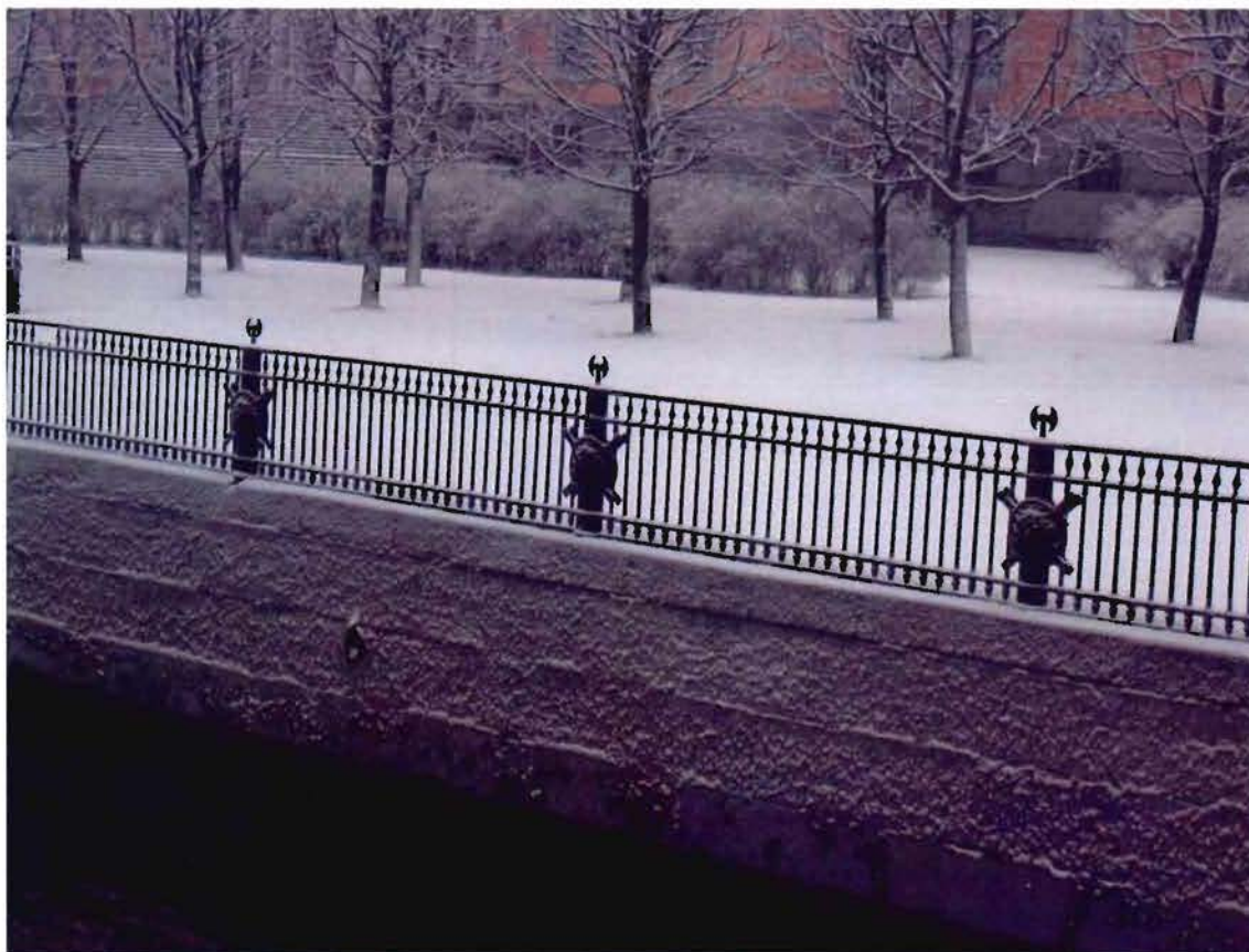
3. Ограждение набережной со стороны Михайловского (Инженерного) замка
