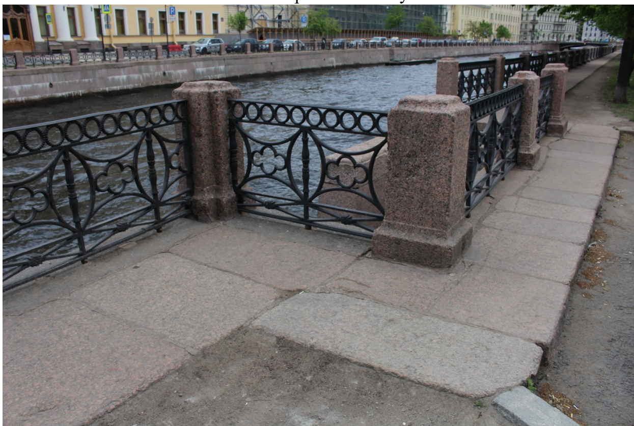
Фото 2. Вид на спуск № 15 объекта культурного наследия федерального значения «Набережные со спусками».
