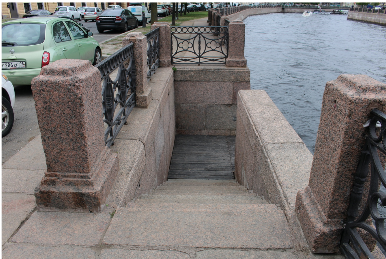
Фото 5. Вид на лестницу и нижнюю площадку спуска № 15 объекта культурного наследия федерального значения «Набережные со спусками».
