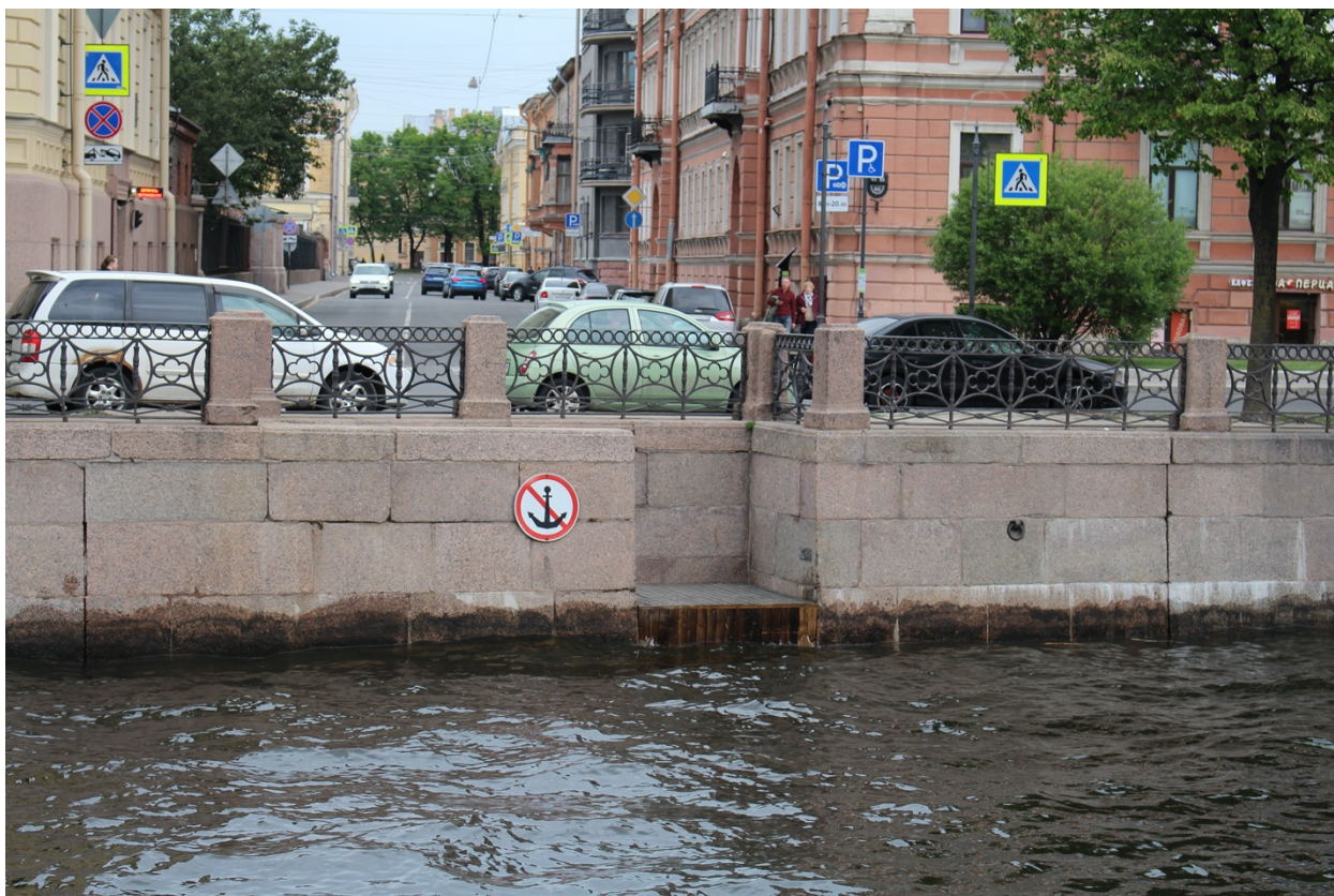
Фото 7. Вид на спуск № 15 объекта культурного наследия федерального значения «Набережные со спусками».
