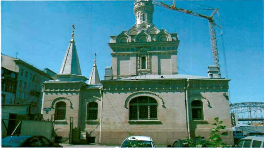
3. Фрагмент юго-восточного фасада объекта культурного наследия.
