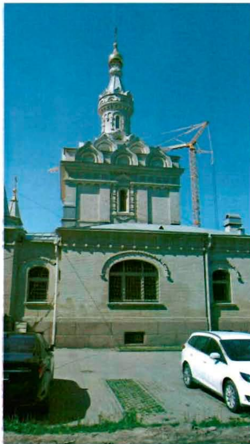
2. Фрагмент юго-восточного фасада объекта культурного наследия.
