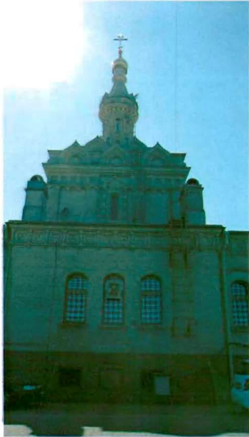
4. Фрагмент северо-восточного фасада объекта культурного наследия.
