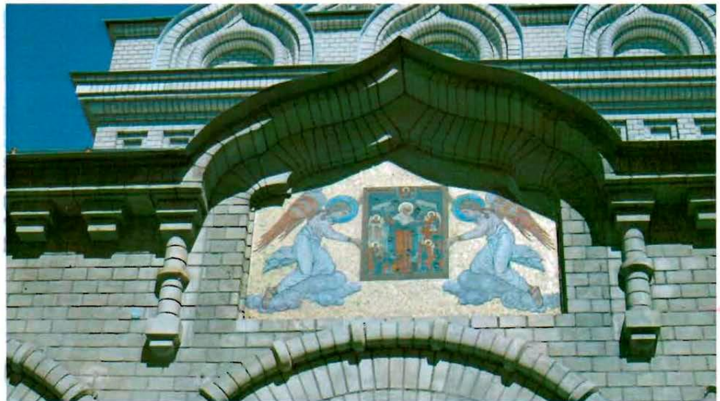
7. Фрагмент юго-западного фасада объекта культурного наследия. Мозаичная икона «Всех Скорбящих радость».
