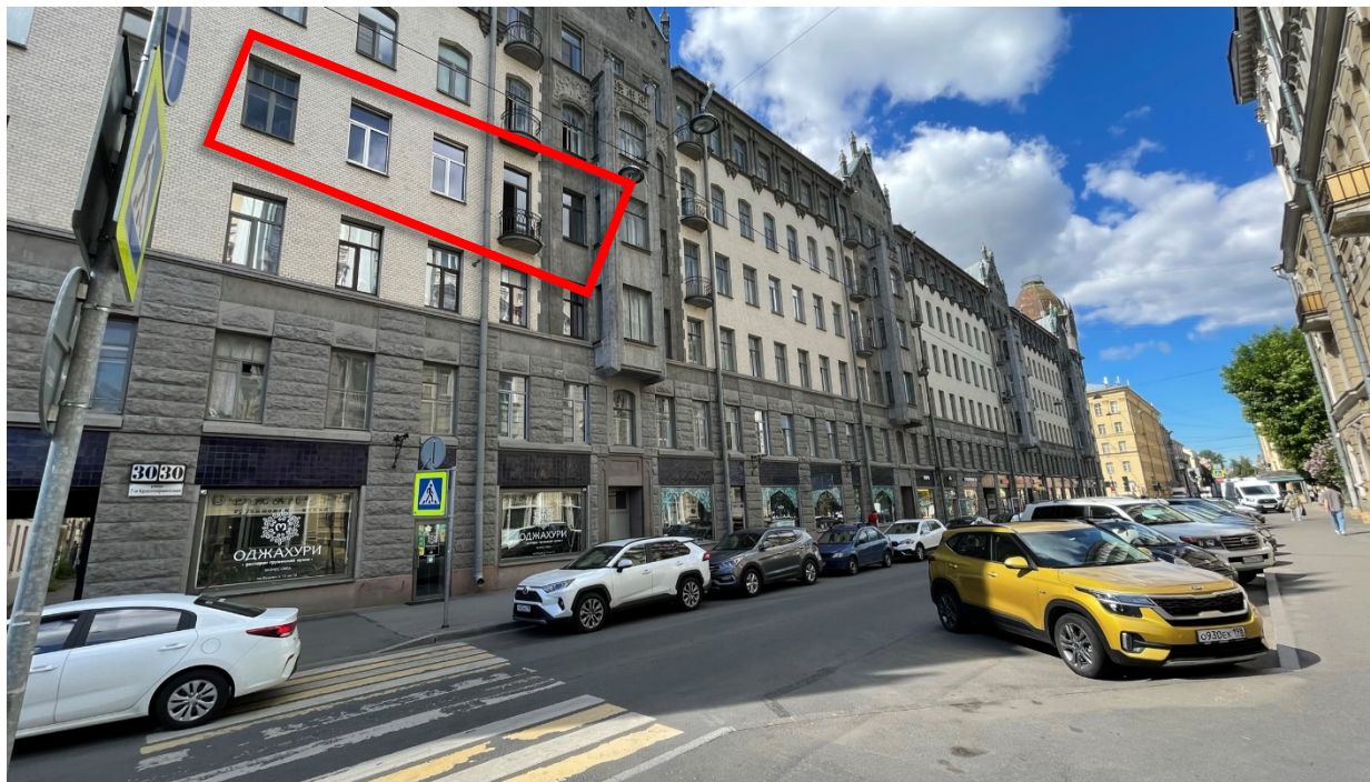
1. Общий вид на главный фасад здания и окна квартиры;
