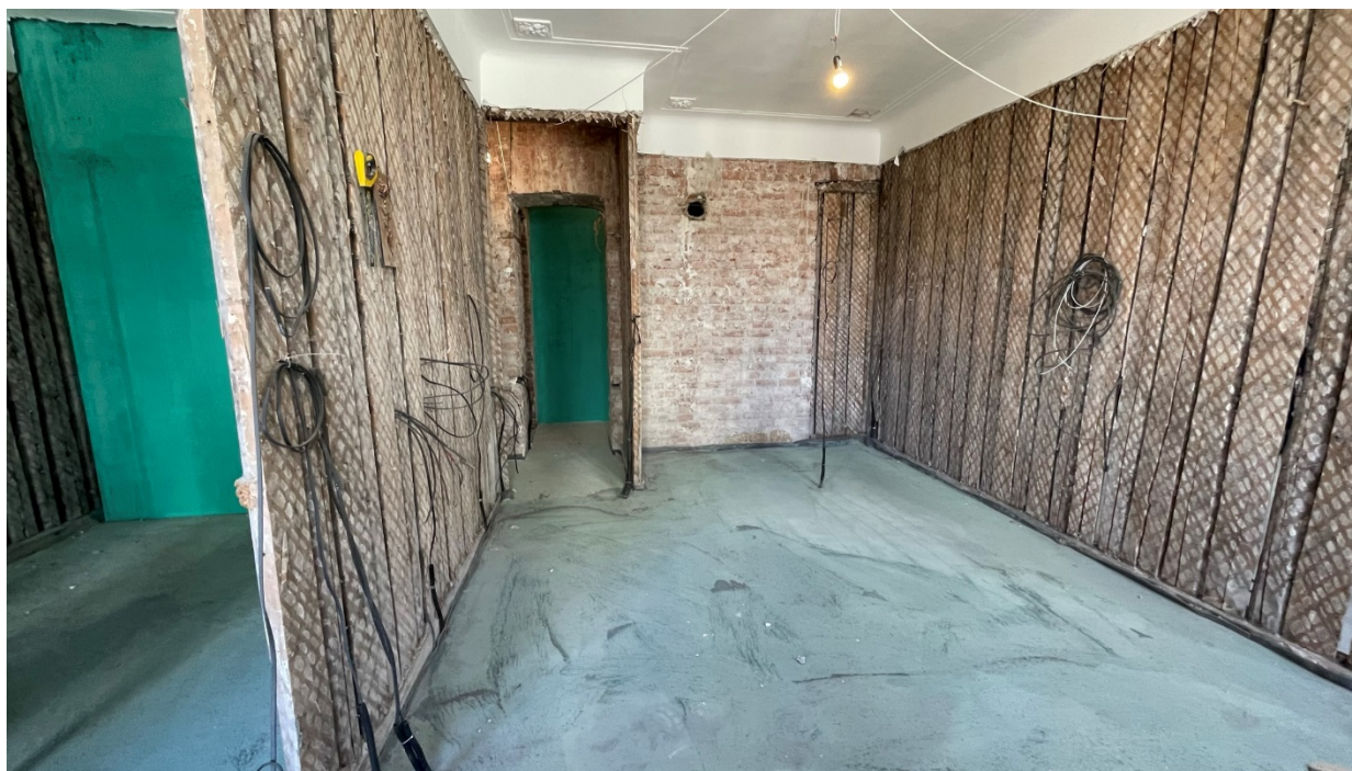
24.Фрагмент интерьера комнаты (помещение №3);
