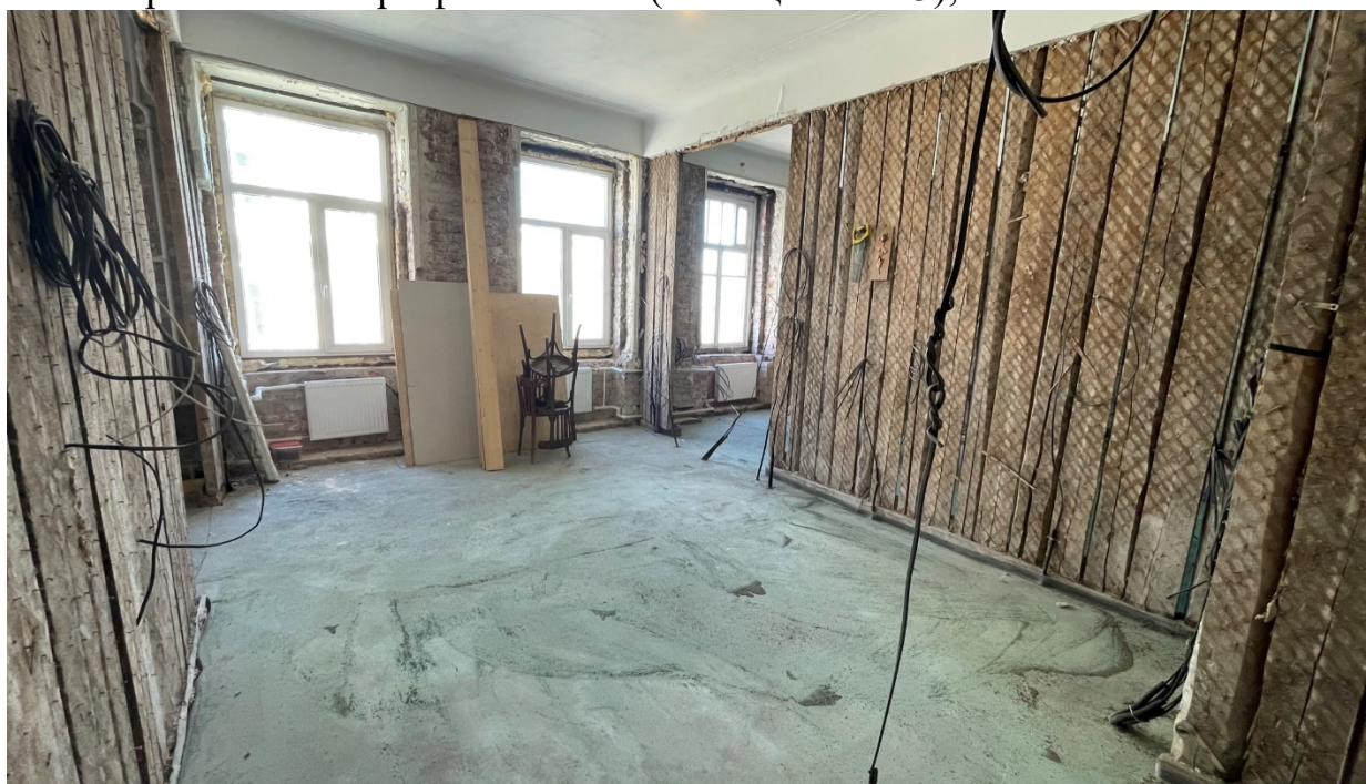
25.Фрагмент интерьера комнаты (помещение №3);
