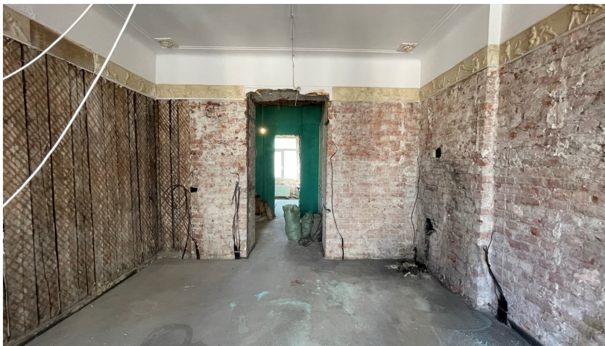
27.Фрагмент интерьера комнаты (помещение №2);
