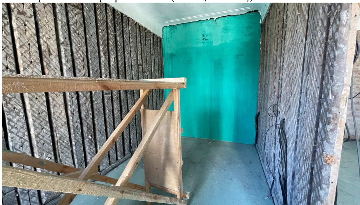
23.Фрагмент интерьера комнаты (помещение №4);
