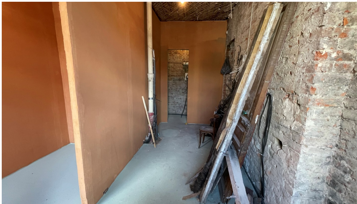
15. Фрагмент интерьера кухни (помещение №9);
