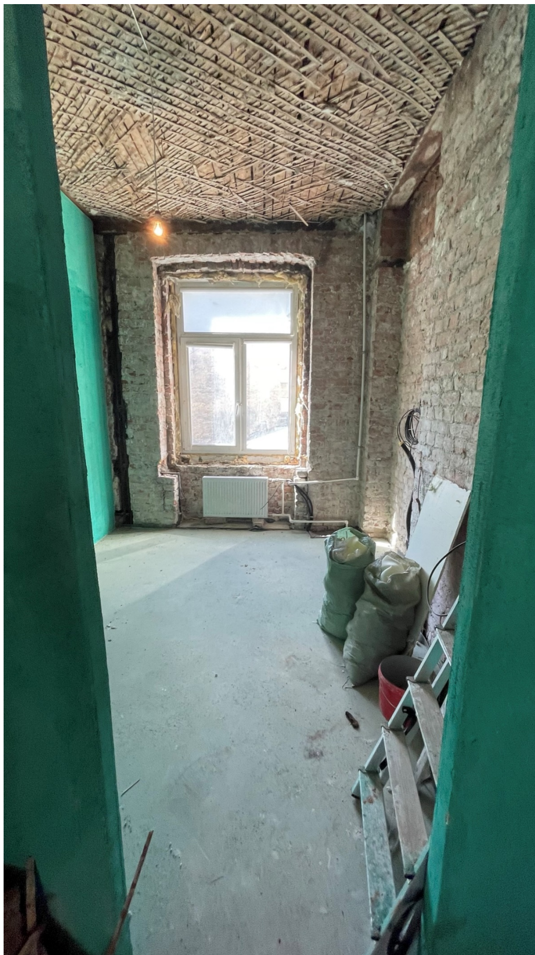
7. Фрагмент интерьера комнаты (помещение №12);
