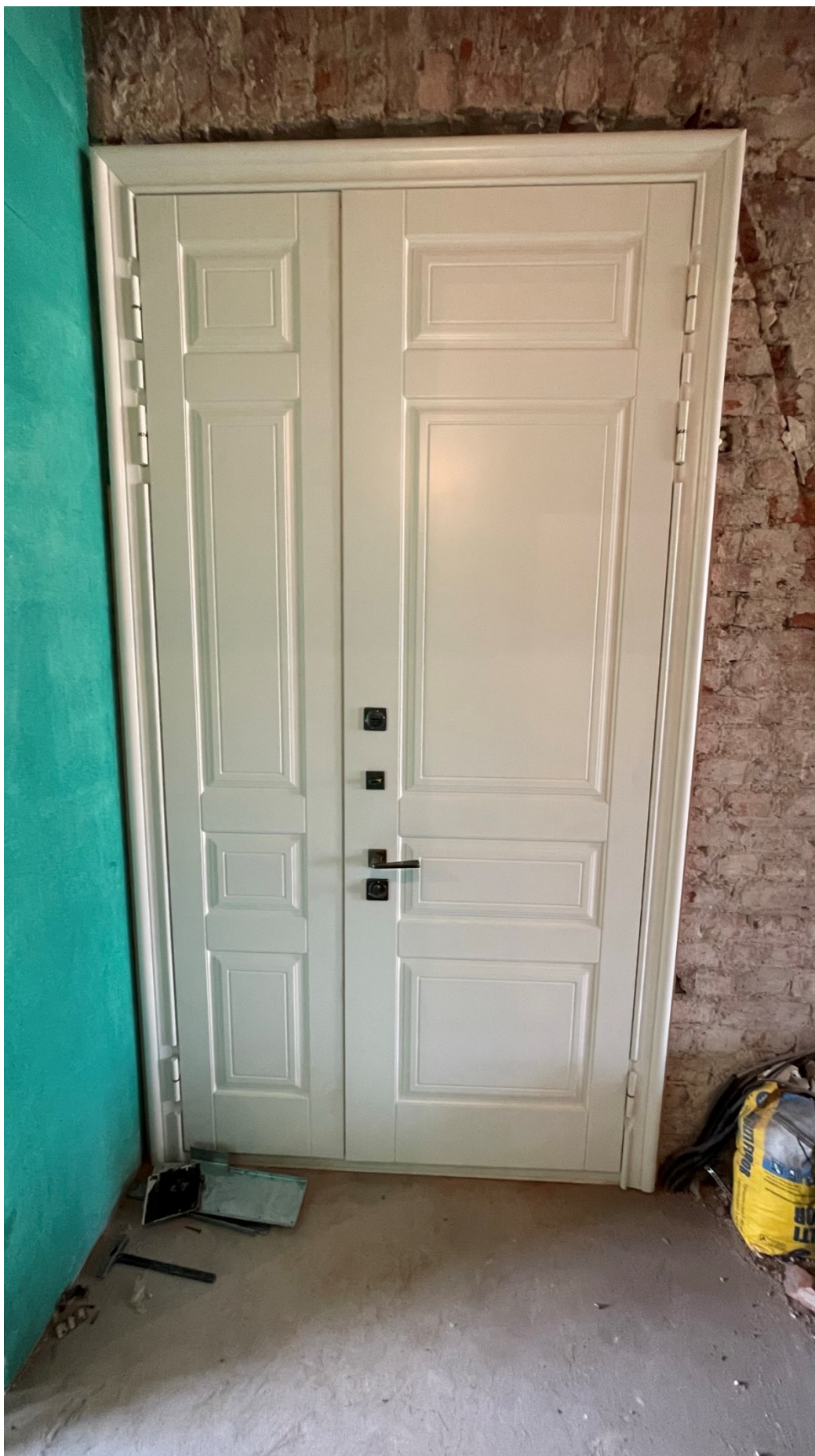
5. Вид на входную дверь в квартире;
