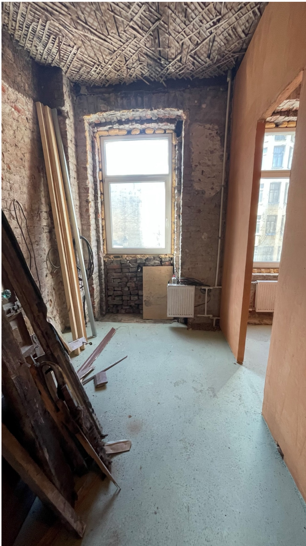
14. Фрагмент интерьера кухни (помещение №9);
