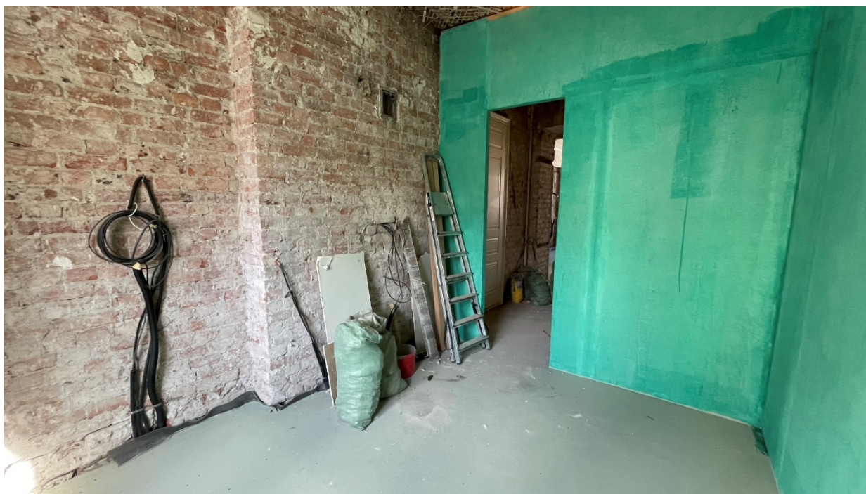
8. Фрагмент интерьера комнаты (помещение №12);
