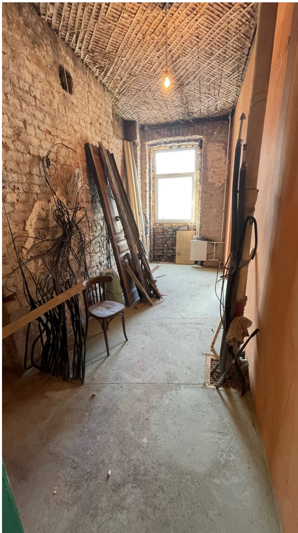
13. Фрагмент интерьера кухни (помещение №9);
