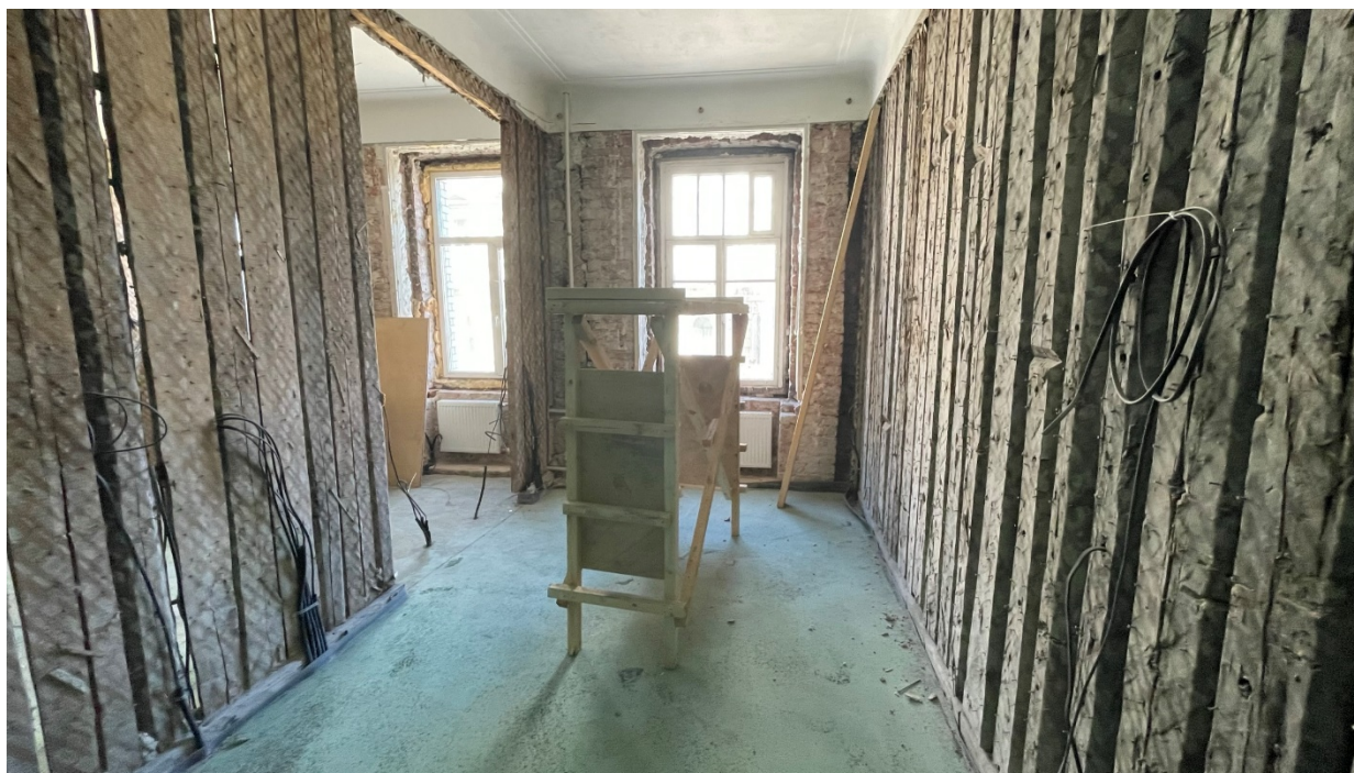
22.Фрагмент интерьера комнаты (помещение №4);
