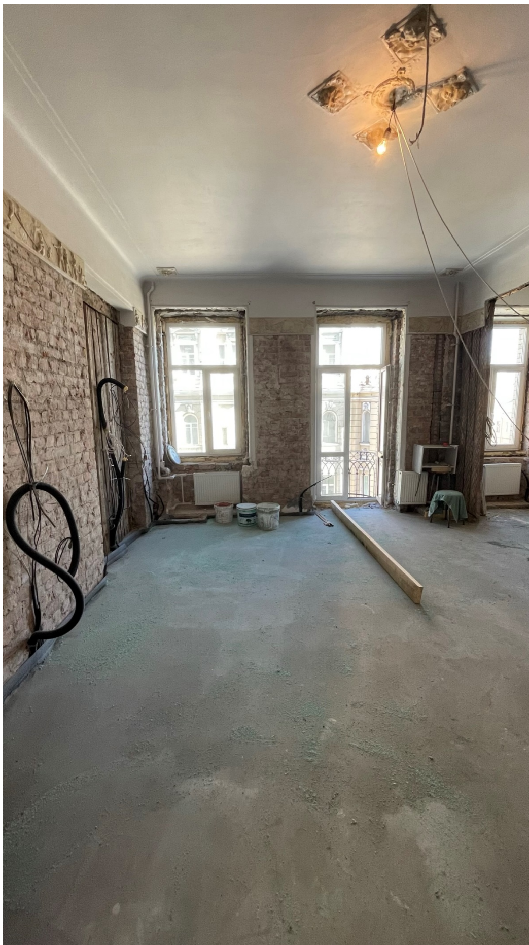
28. Фрагмент интерьера комнаты (помещение №2);
