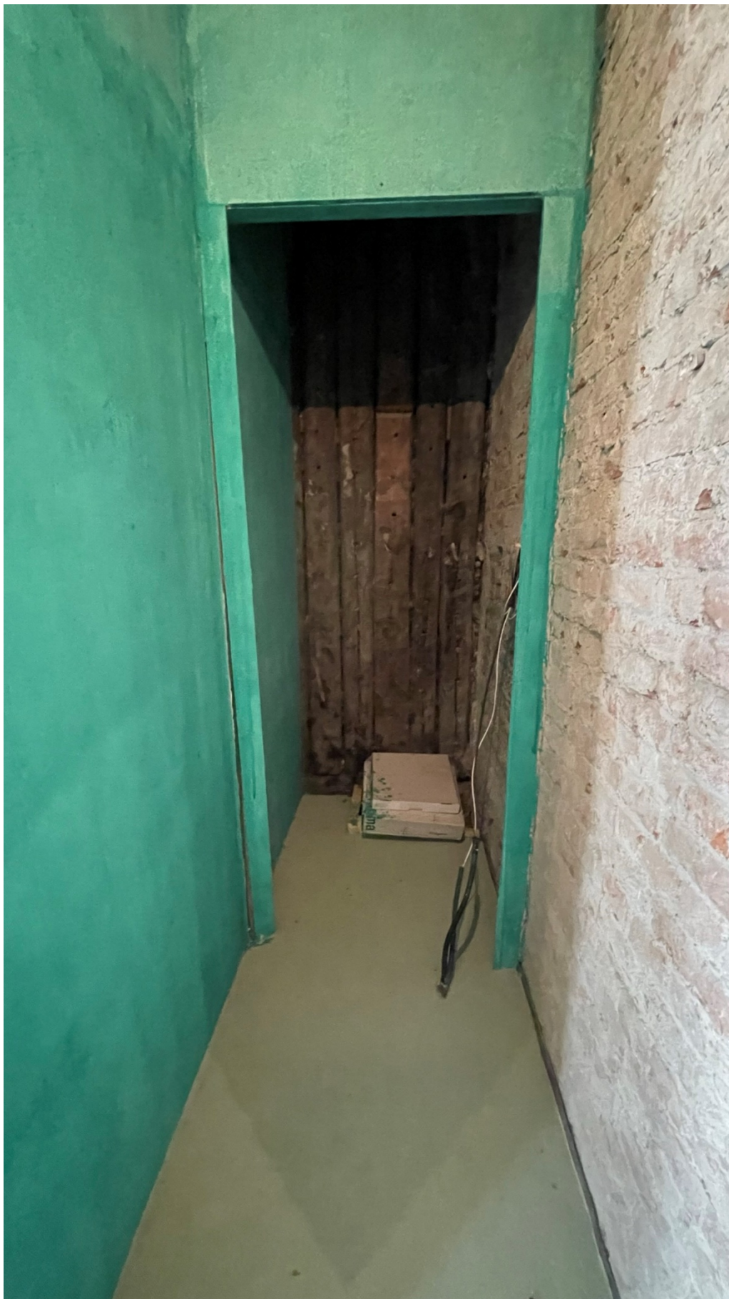
21. Фрагмент интерьера кладовой комнаты (помещение №5)
