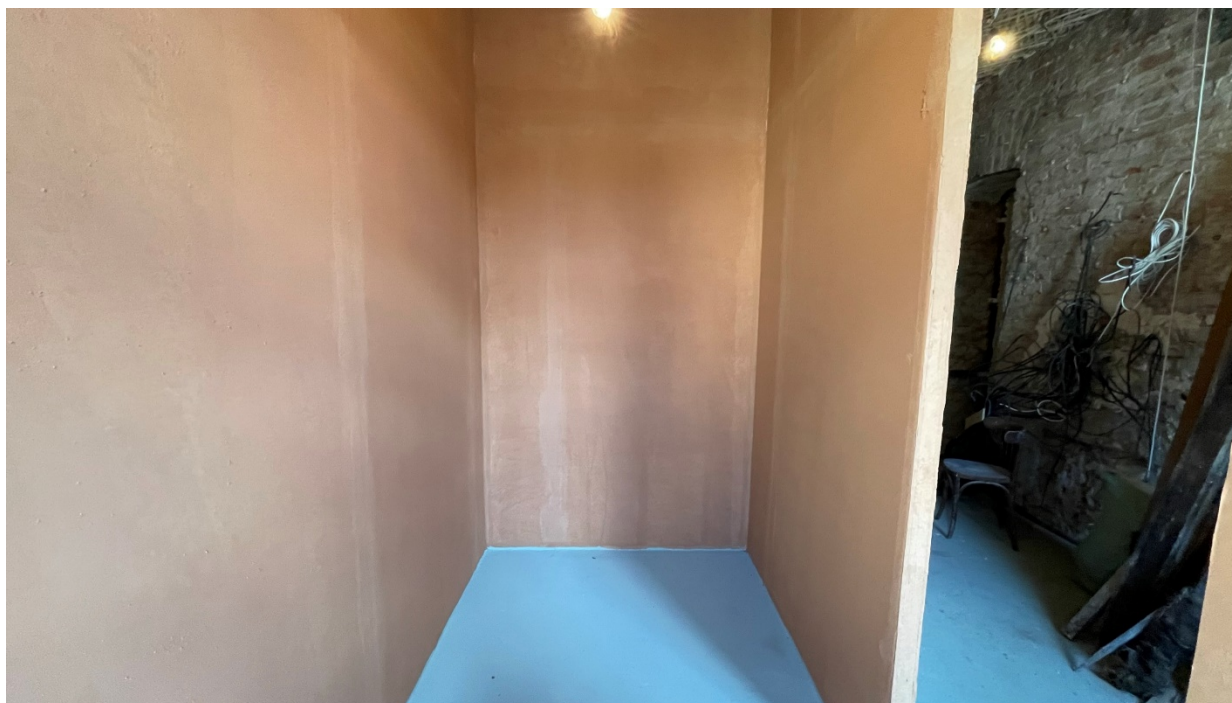
17.Фрагмент интерьера комнаты (помещение №11);
