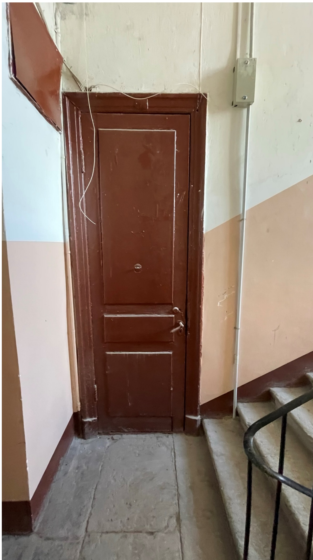
19. Входная дверь в квартиру;
