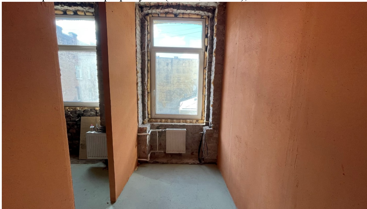
16. Фрагмент интерьера комнаты (помещение №11);
