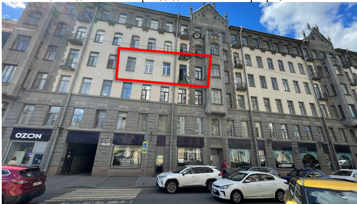
2. Общий вид на главный фасад здания и окна квартиры;
