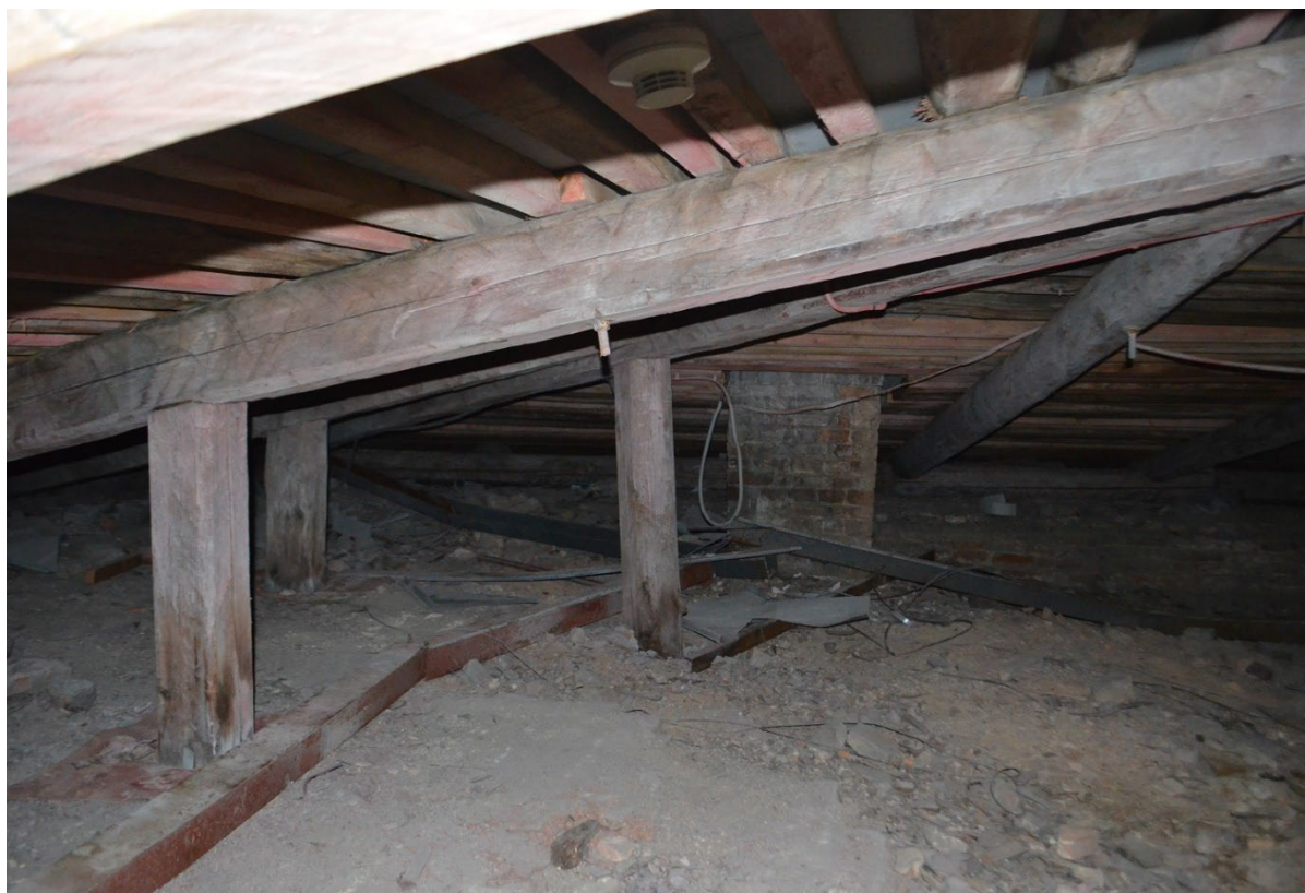
Фото 11. ОКН федерального значения «Кавальер Анны Иоанновны». Чердак. Стропильная система. Фрагмент. Съёмка 24.07.2023 г.
