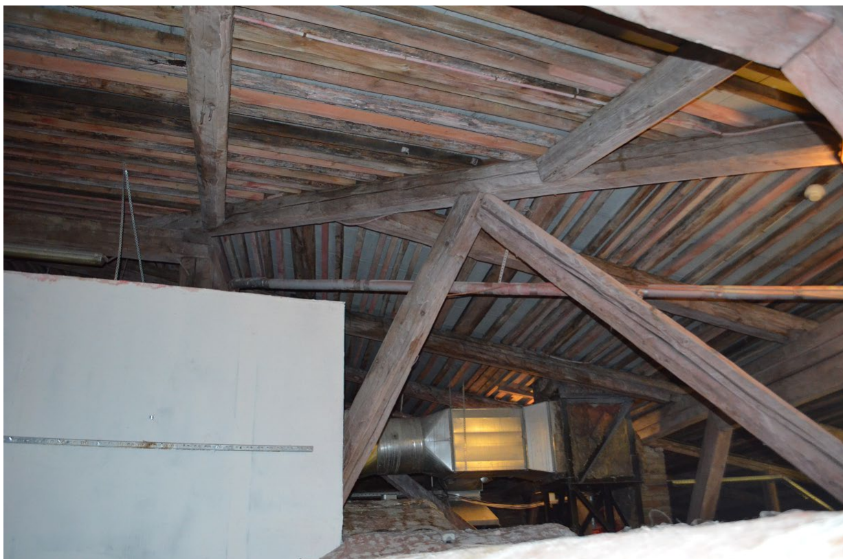
Фото 16. ОКН федерального значения «Кавальер Анны Иоанновны». Чердак. Стропильная система. Фрагмент. Съёмка 24.07.2023 г.
