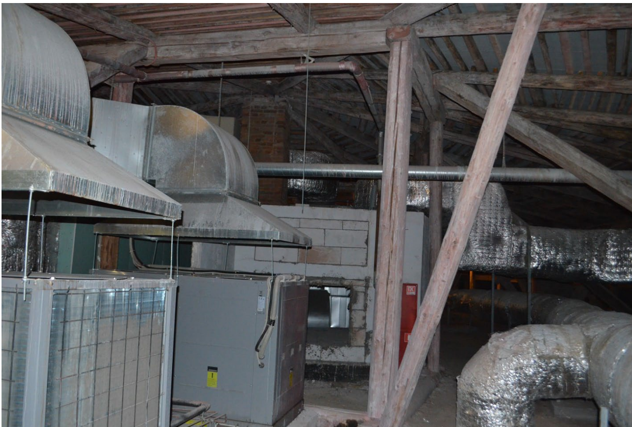
Фото 18. ОКН федерального значения «Кавальер Анны Иоанновны». Чердак. Стропильная система. Фрагмент. Съёмка 24.07.2023 г.
