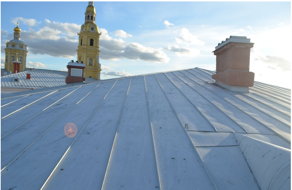
Фото 04. ОКН федерального значения «Кавальер Анны Иоанновны». Крыша. Фрагмент. Дымовые трубы. Съёмка 24.07.2023 г.
