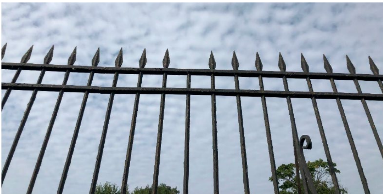
8. Металлическое ограждение стены колумбария объекта культурного наследия федерального значения «Кладбище Никольское», расположенного по адресу: г. Санкт-Петербург, Никольское кладбище, участок 1, входящего в состав объекта культурного наследия федерального значения «Александрo-Невская Лавра».
