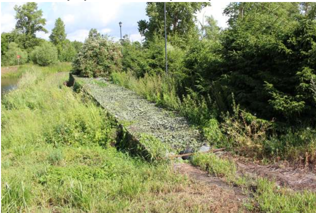
Фото 33. Вид на трубы теплосети вдоль западной границы сквера на территории объекта культурного наследия федерального значения «Крепость Кронштадт».
