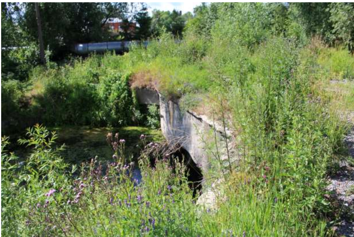
Фото 28. Вид на железобетонный мост через объект культурного наследия федерального значения «Ров крепостной оборонительный».
