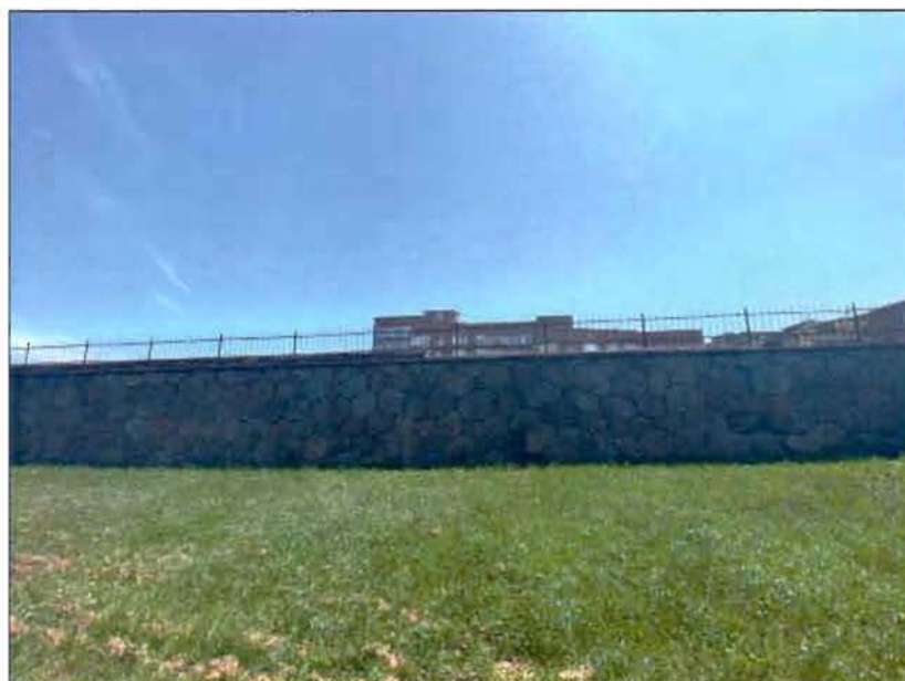
1. Общий вид на фрагмент северного участка «Стены эскарповой».
