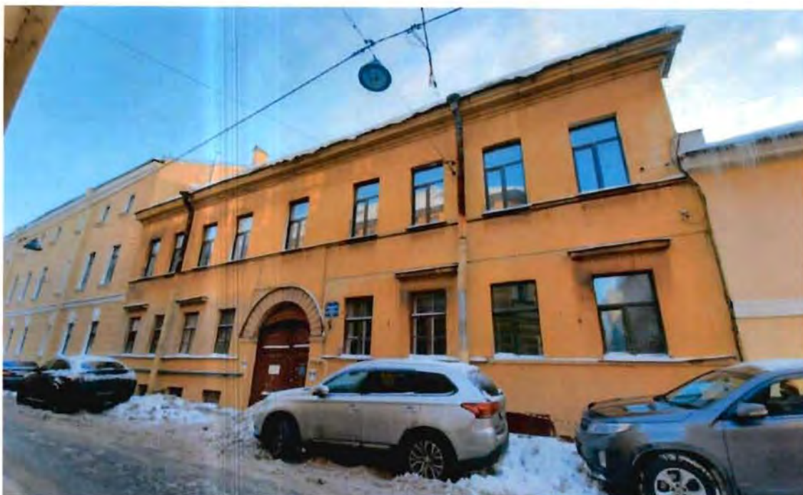
2. Вид на северо-западный фасад объекта культурного наследия
