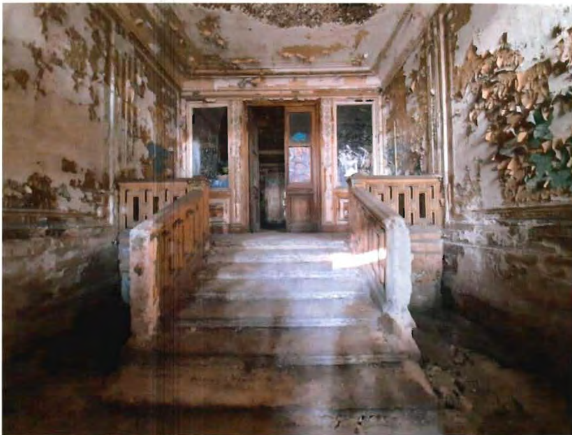
8. Лестница вестибюля, пом. 1-Н (17)
