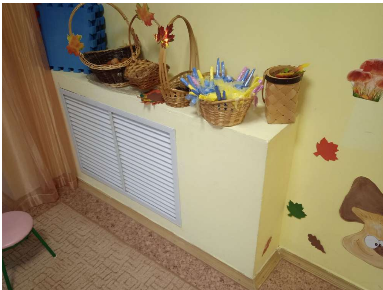
Фото 61. Помещение 3 Защитный короб радиаторов отопления.
