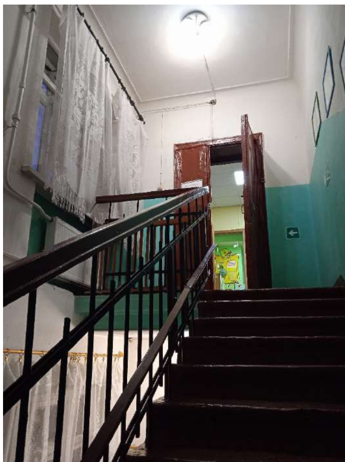
Фото 9 Лестничная клетка 1/К. Вид на площадку второго этажа.
