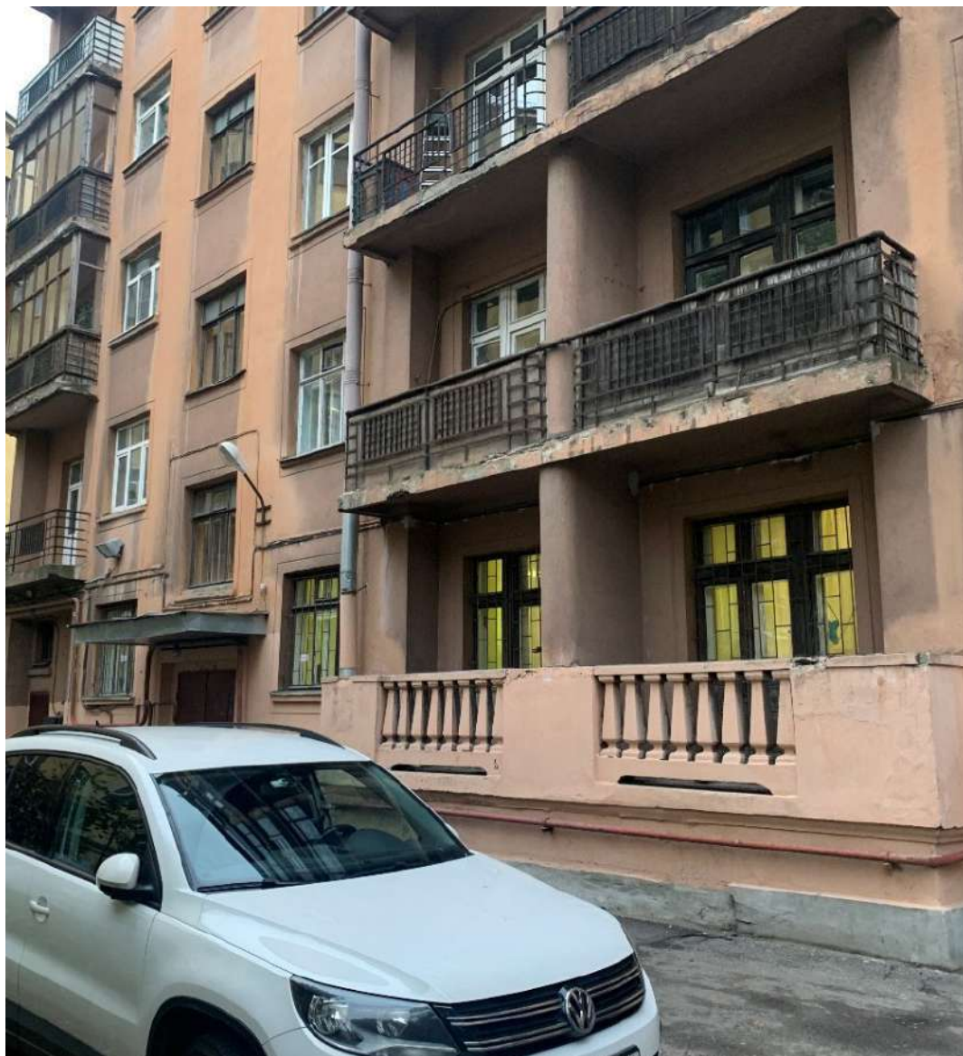
Фото 5. Общий вид здания. Дворовый фасад.
