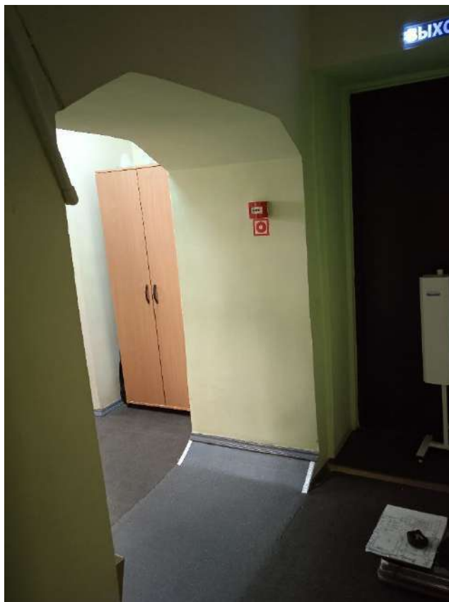
Фото 34 Помещение 11. Проем в капитальной стене
