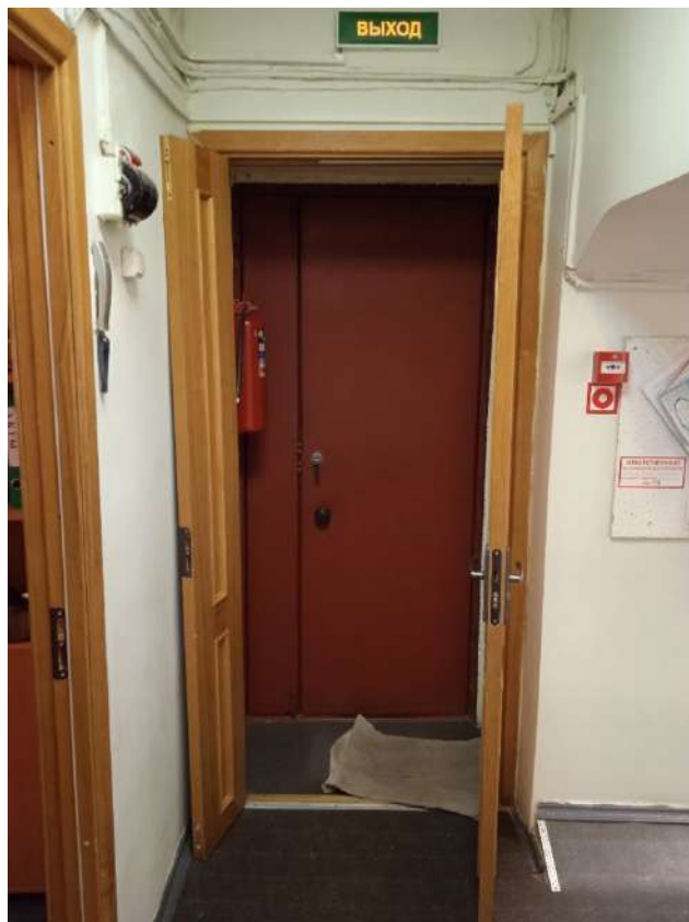
Фото 43. Помещение 11 Коридор Выход на лестничную клетку 6/ЛК
