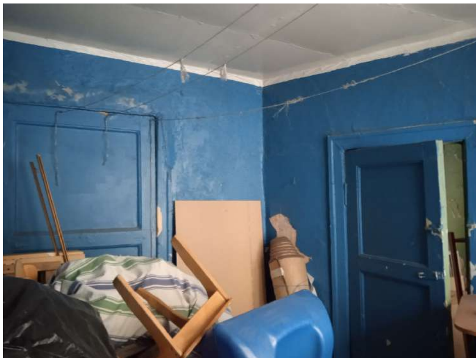
Фото 53 Помещение 21 Слева дверной проем на эвакуационную лестницу
