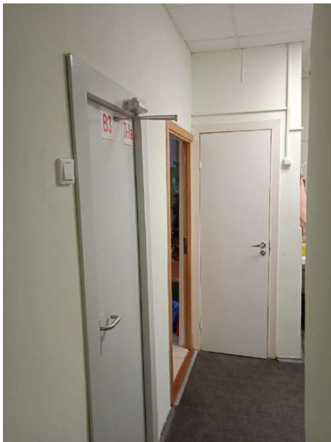
Фото 20. Помещение 6. Спереди вход в пом. 6.1 (санузел)
