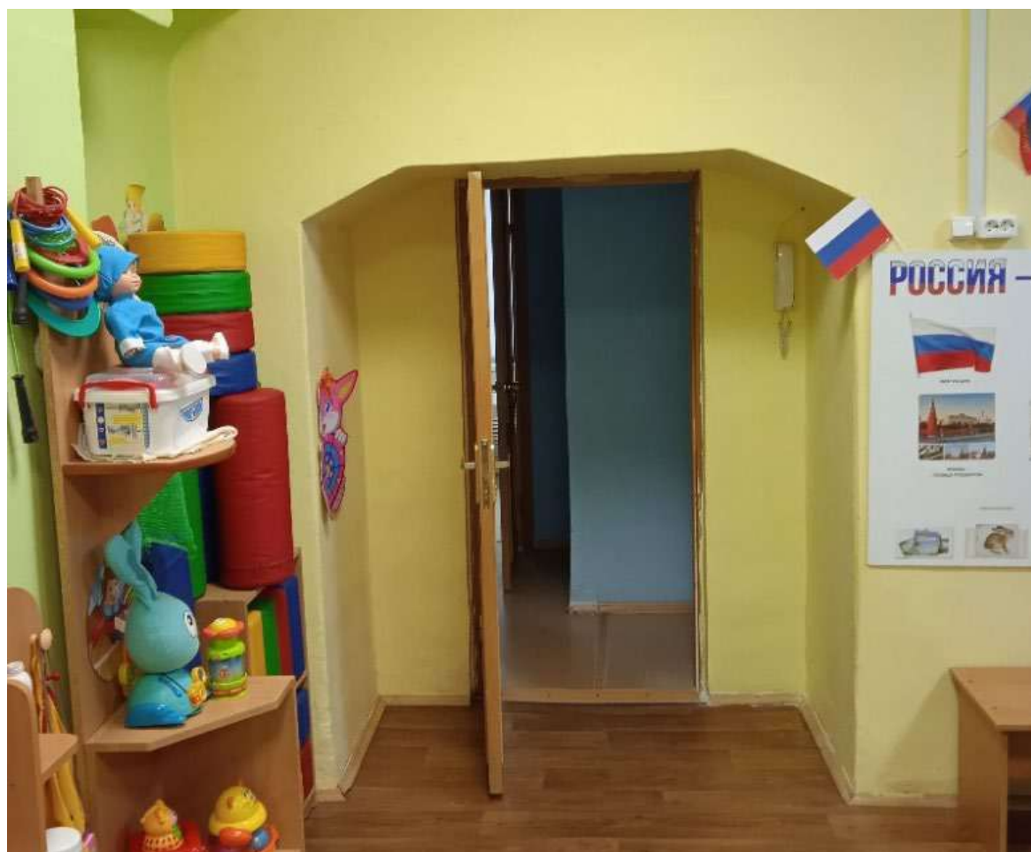
Фото 46. Помещение 18 Игровая. Проем в капитальной стене.
