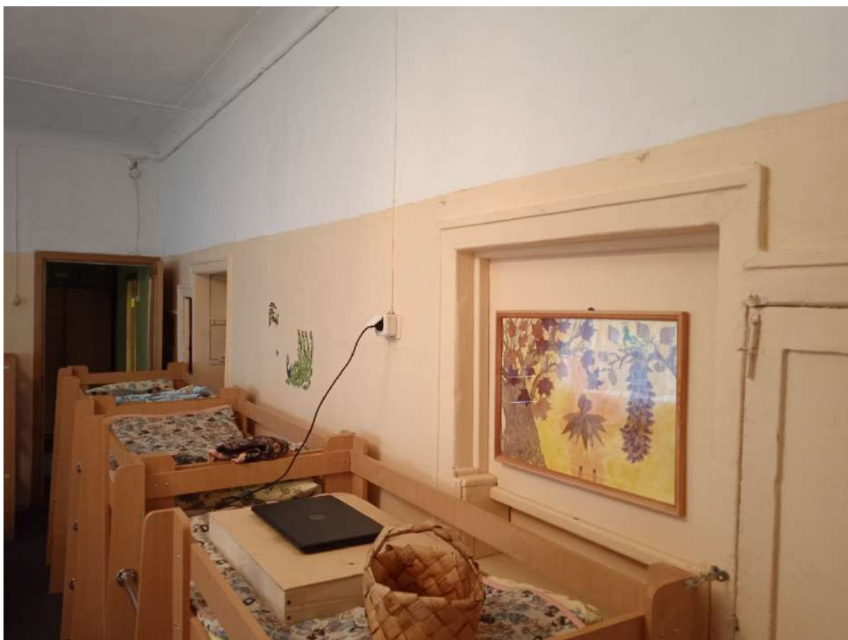
Фото 19. Помещение 5. Ниши в капитальной стене.
