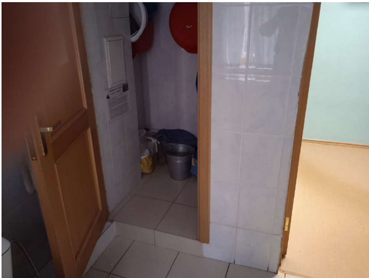
Фото 15. Помещение 4 и 4.1 (кладовая)
