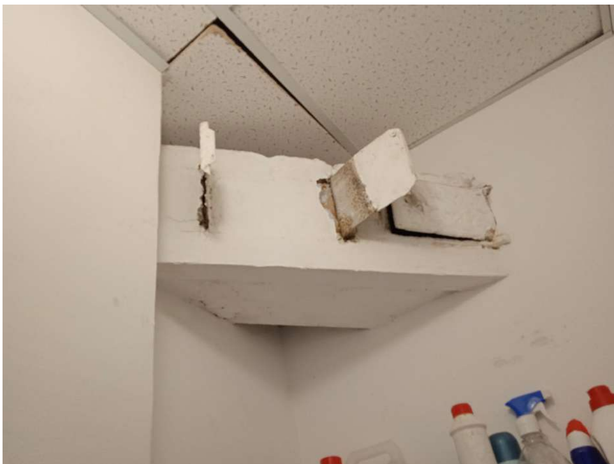
Фото 16. Помещение 4. Кладовая, вентиляционный короб
