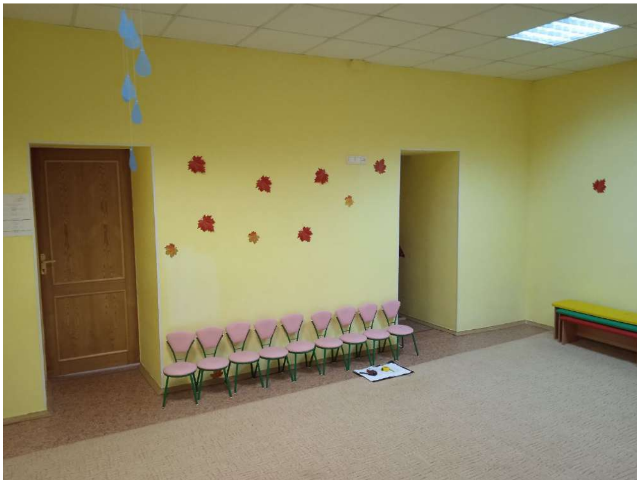
Фото 60. Помещение 3 Проемы в капитальной стене.
