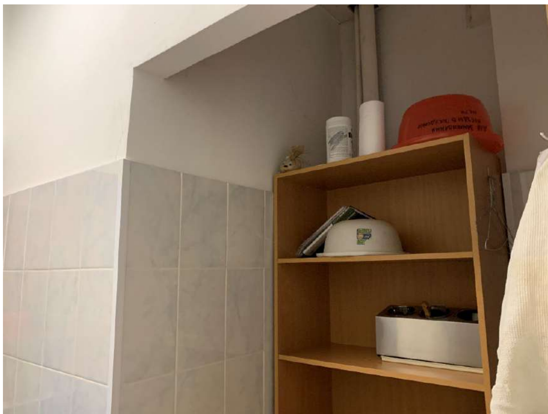
Фото 65 Помещение 5 Моечная. Ниша.
