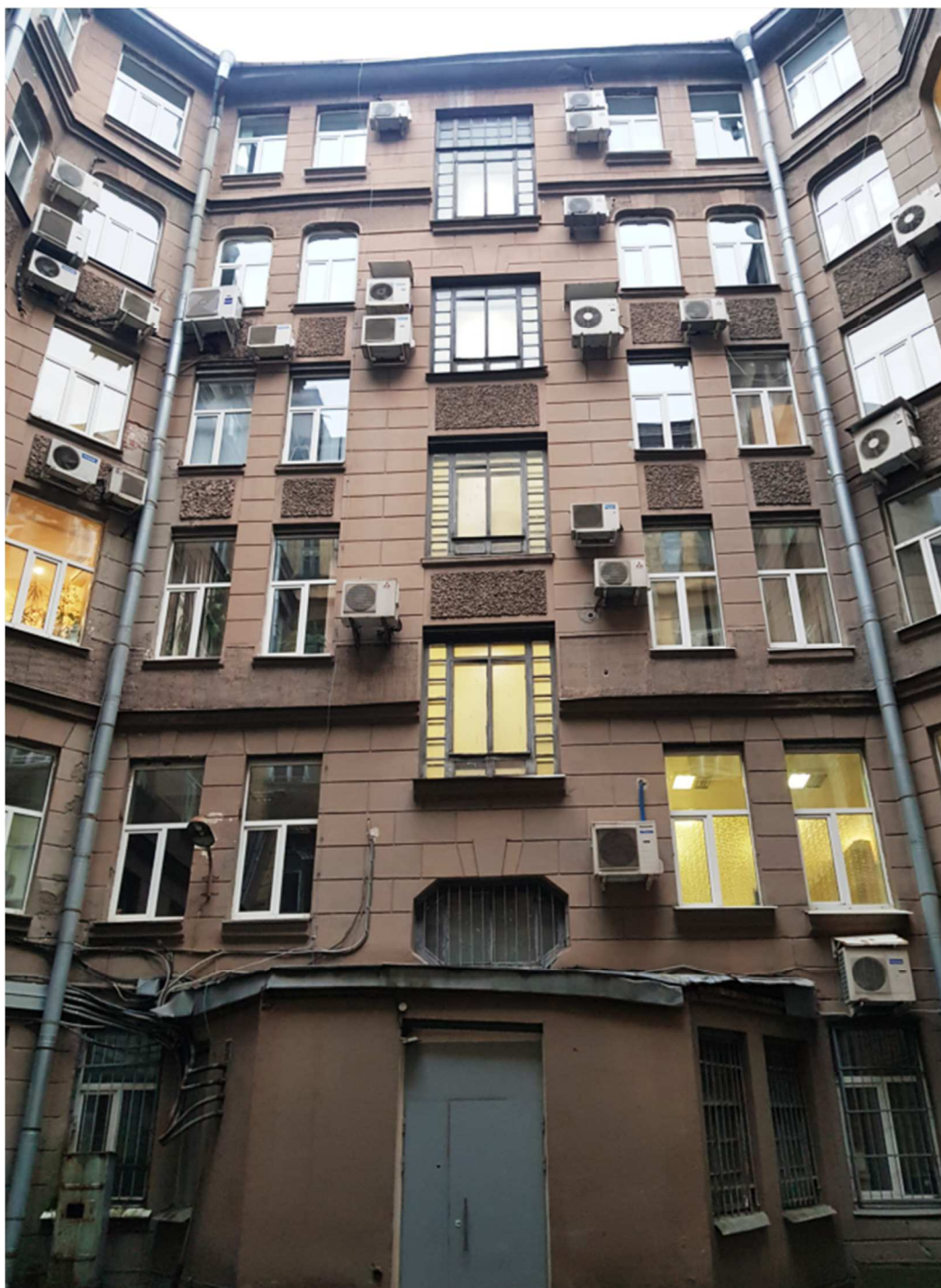
2. Вид дворового фасада.
