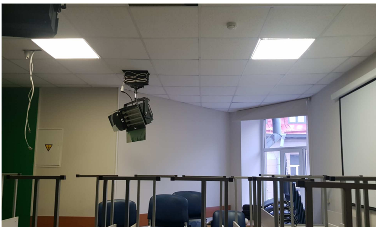
5. 6-й этаж. Помещение северного крыла.
