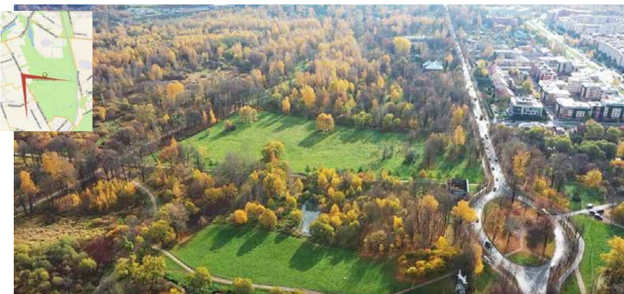
Аэрофотосъемка 8. Вид на южную часть Отдельного парка и Павловское шоссе.
