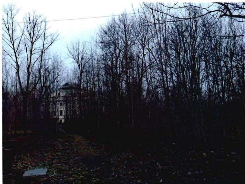
3. Центральная часть объекта культурного наследия.
