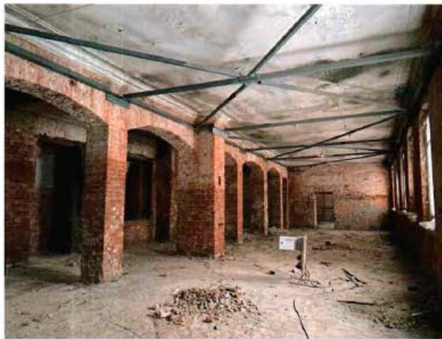
3. Общий вид помещения 1 этажа объекта культурного наследия.
