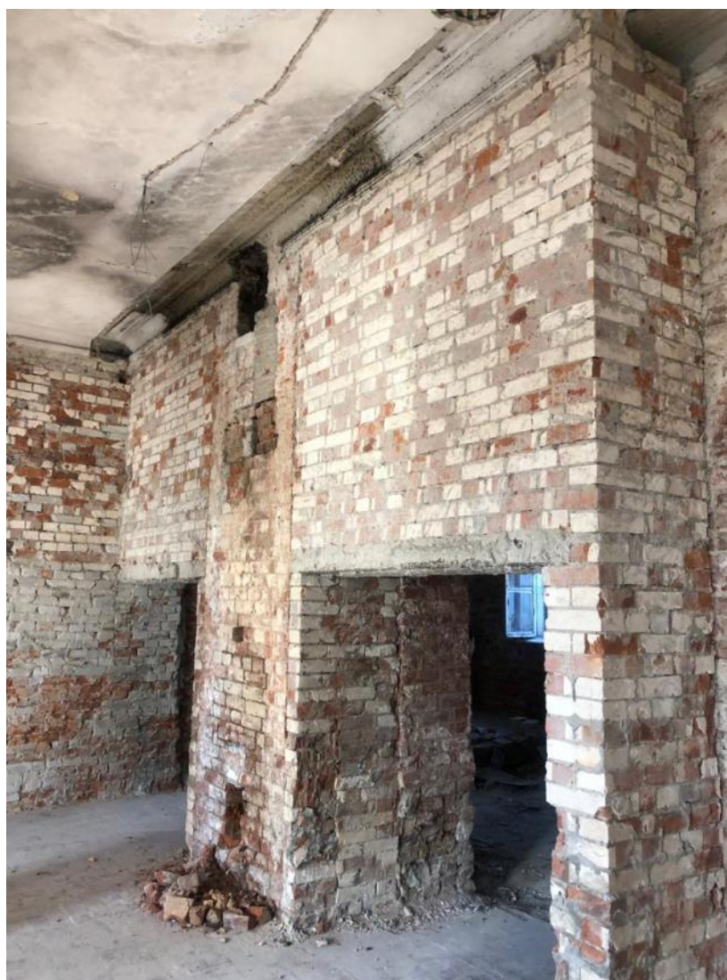
Фото 26. Фрагмент стены по оси «Г».
