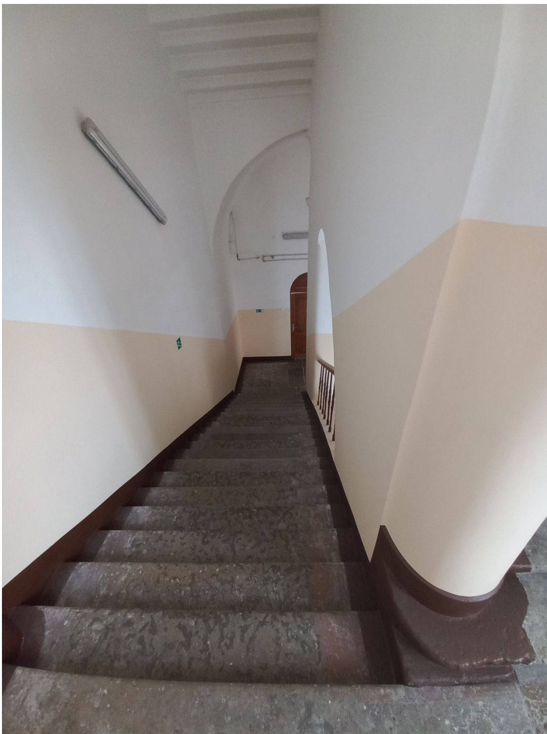
Фото 22. Вид с площадки третьего этажа.
