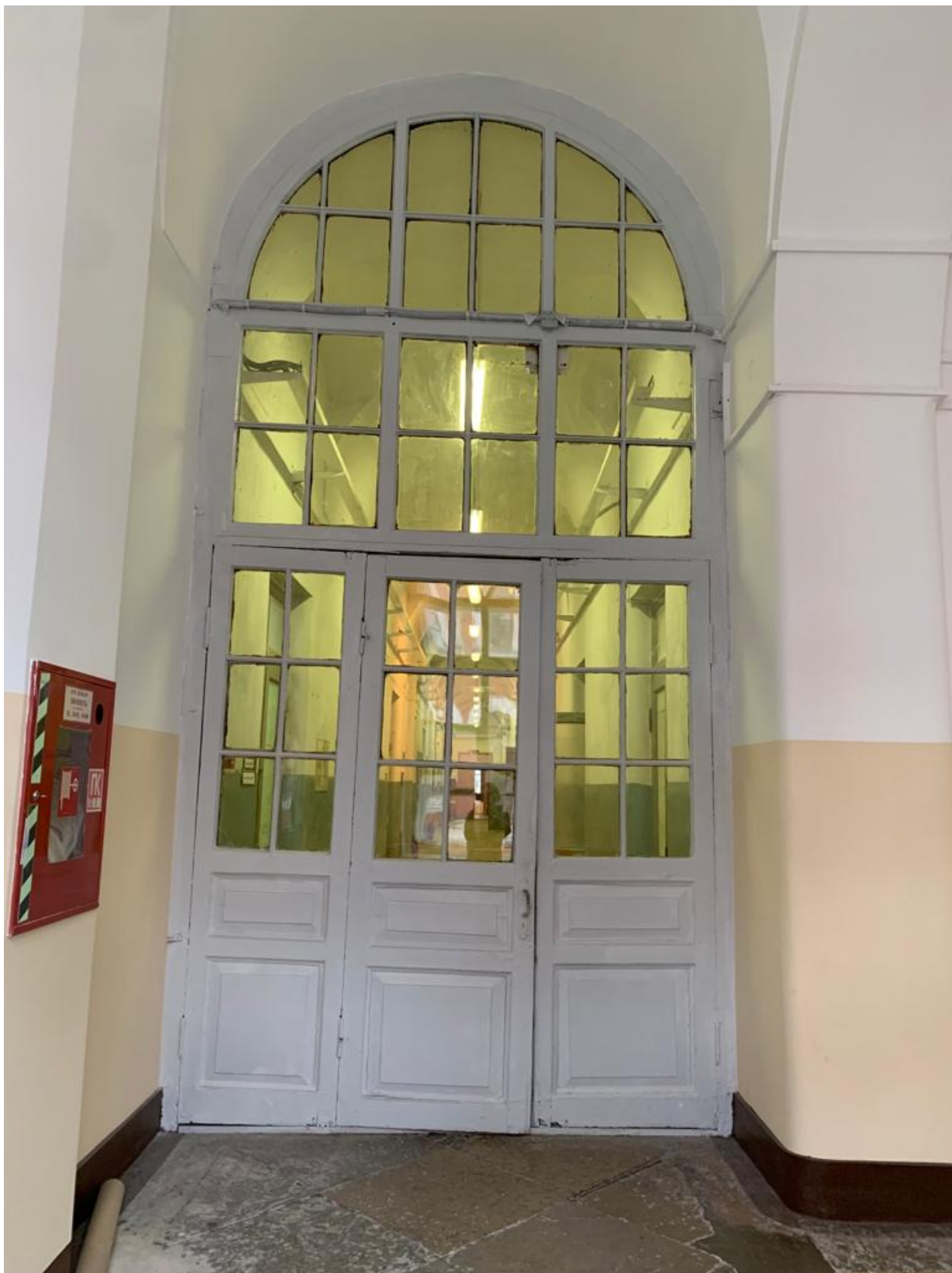
Фото 18. Дверное заполнение (2 этаж), вид со стороны лестницы.
