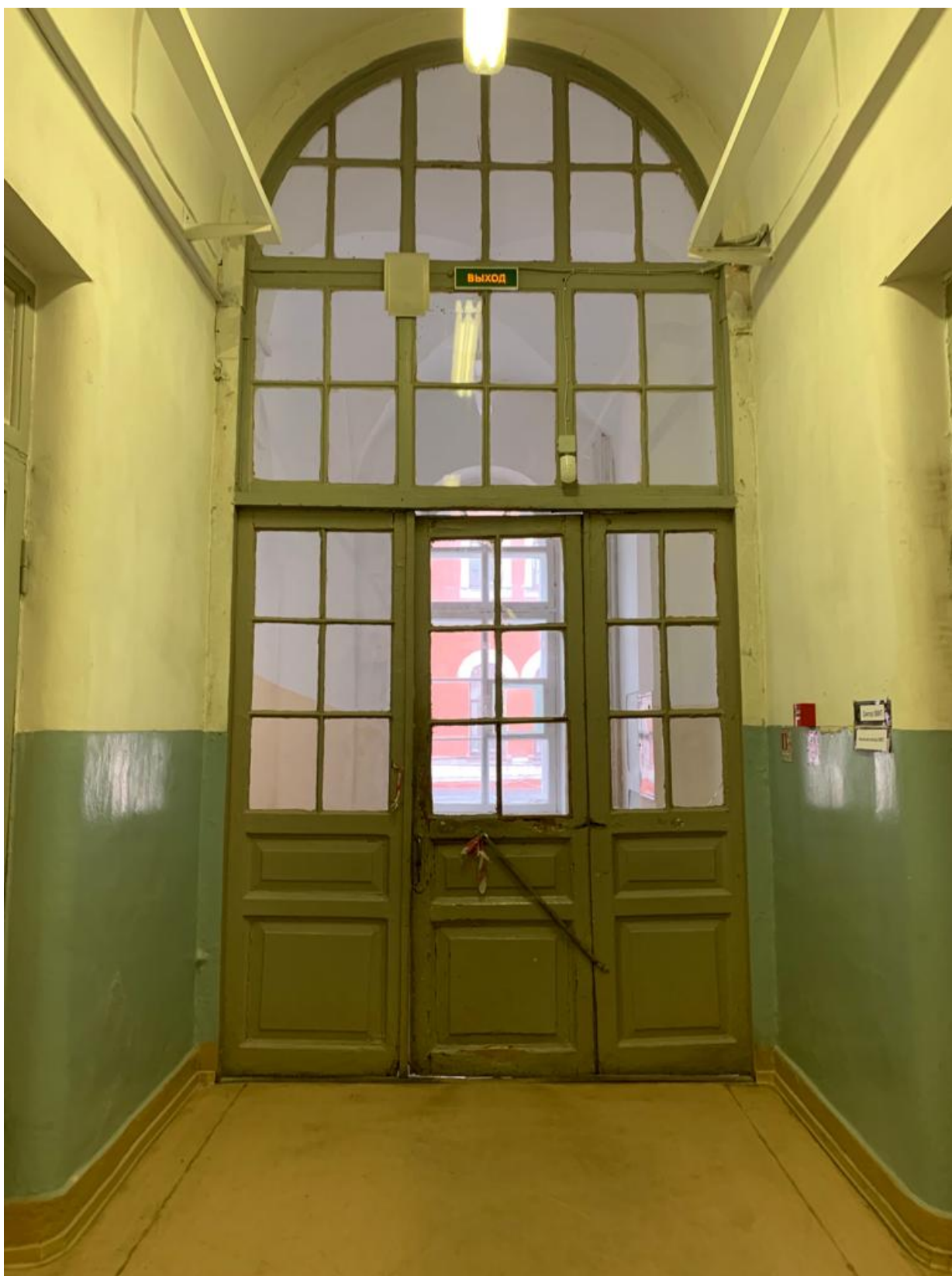
Фото 19. Дверное заполнение (2 этаж), вид со стороны коридора.
