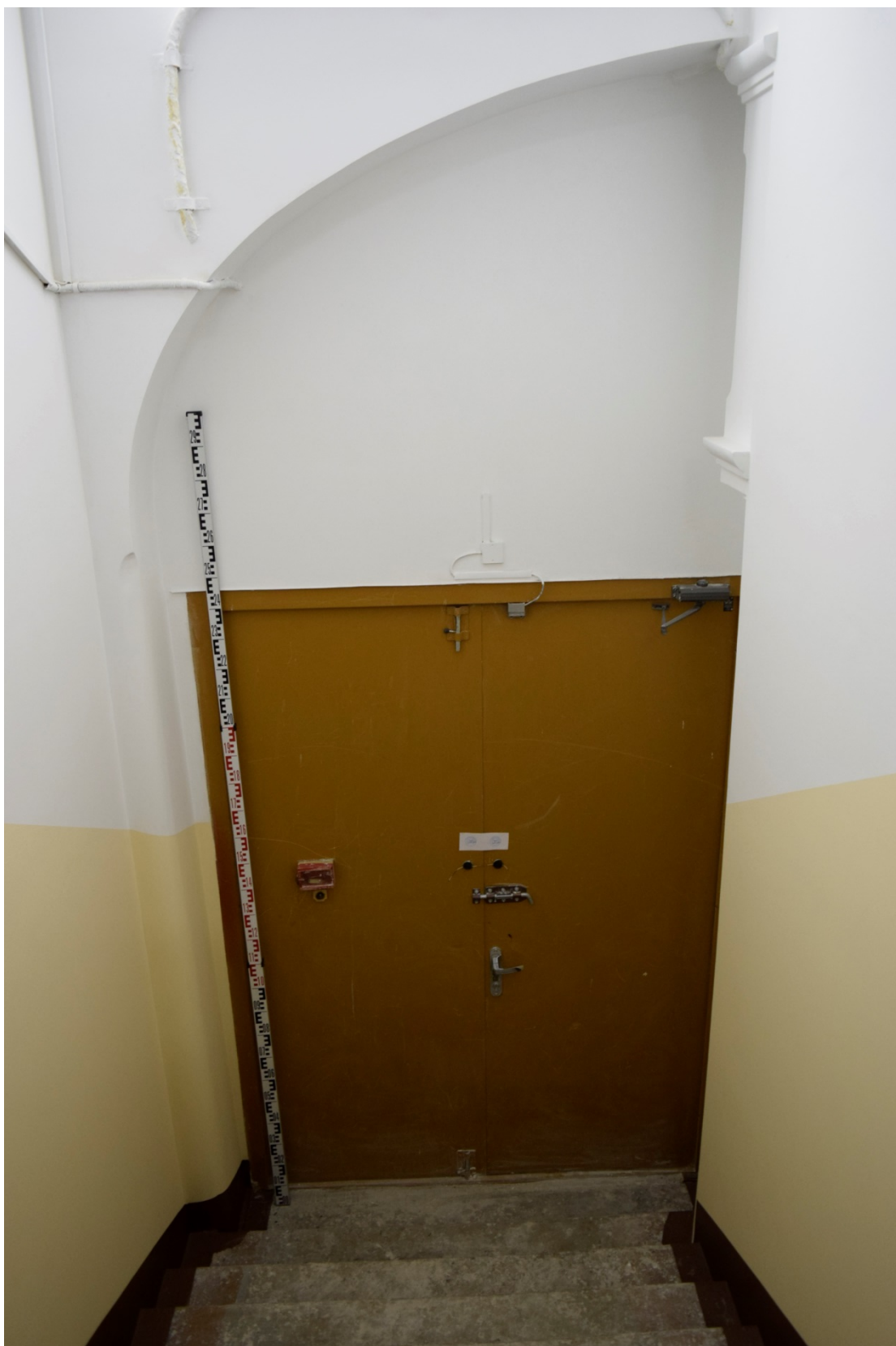
Фото 15. Марш с отметки первого этажа вверх.
