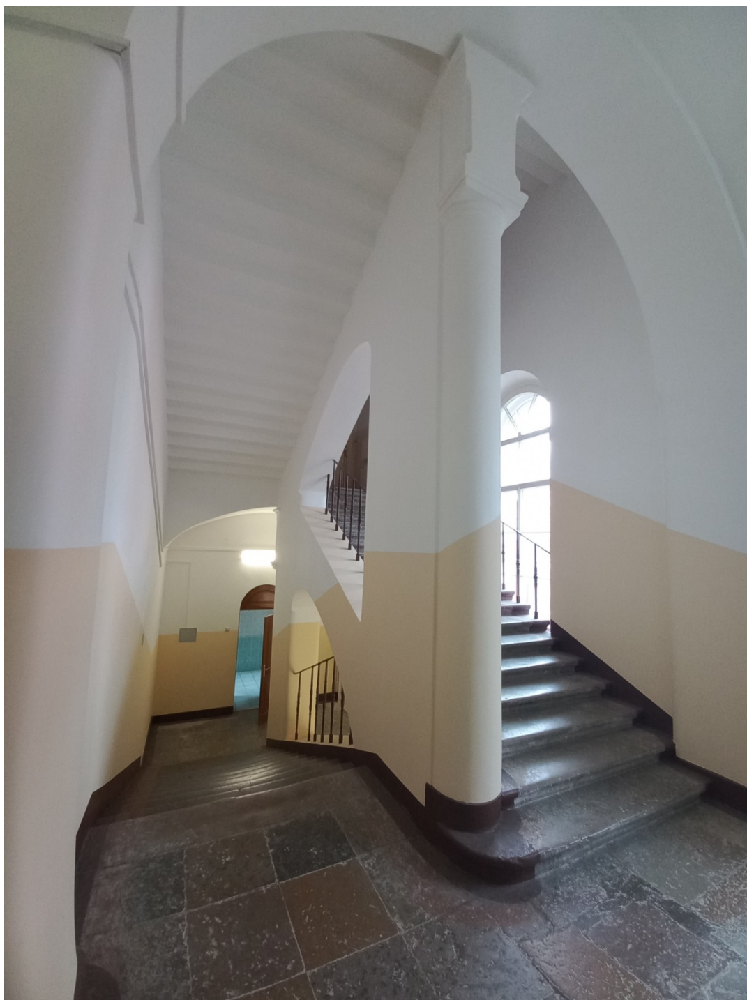
Фото 16. Площадка второго этажа.
