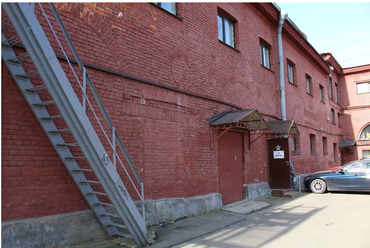
Фото 19. Вид на юго-западный фасад дворового корпуса выявленного объекта культурного наследия «Манеж и конюшни лейб-гвардии Гренадерского полка (здание тира лейб-гвардии Стрелкового батальона)». Фото 17.04.2023 г.
