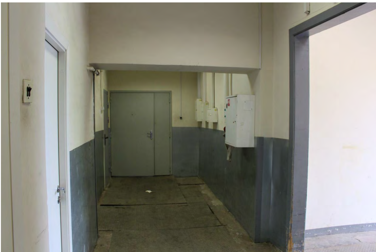
Фото 65. Внутренние помещения 1-го этажа лицевого корпуса выявленного объекта культурного наследия «Манеж и конюшни лейб-гвардии Гренадерского полка (здание тира лейб-гвардии Стрелкового батальона)». Фото 22.05.2023 г.
