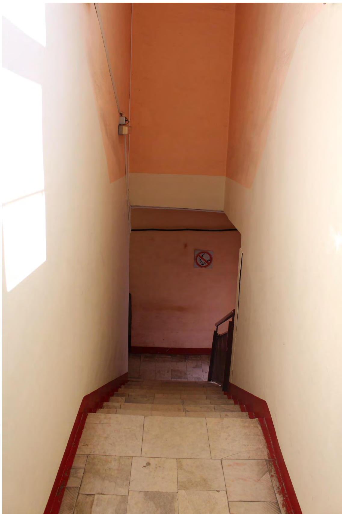
Фото 61. Центральная лестничная клетка лицевого корпуса выявленного объекта культурного наследия «Манеж и конюшни лейб-гвардии Гренадерского полка (здание тира лейб-гвардии Стрелкового батальона)». Фото 22.05.2023 г.
