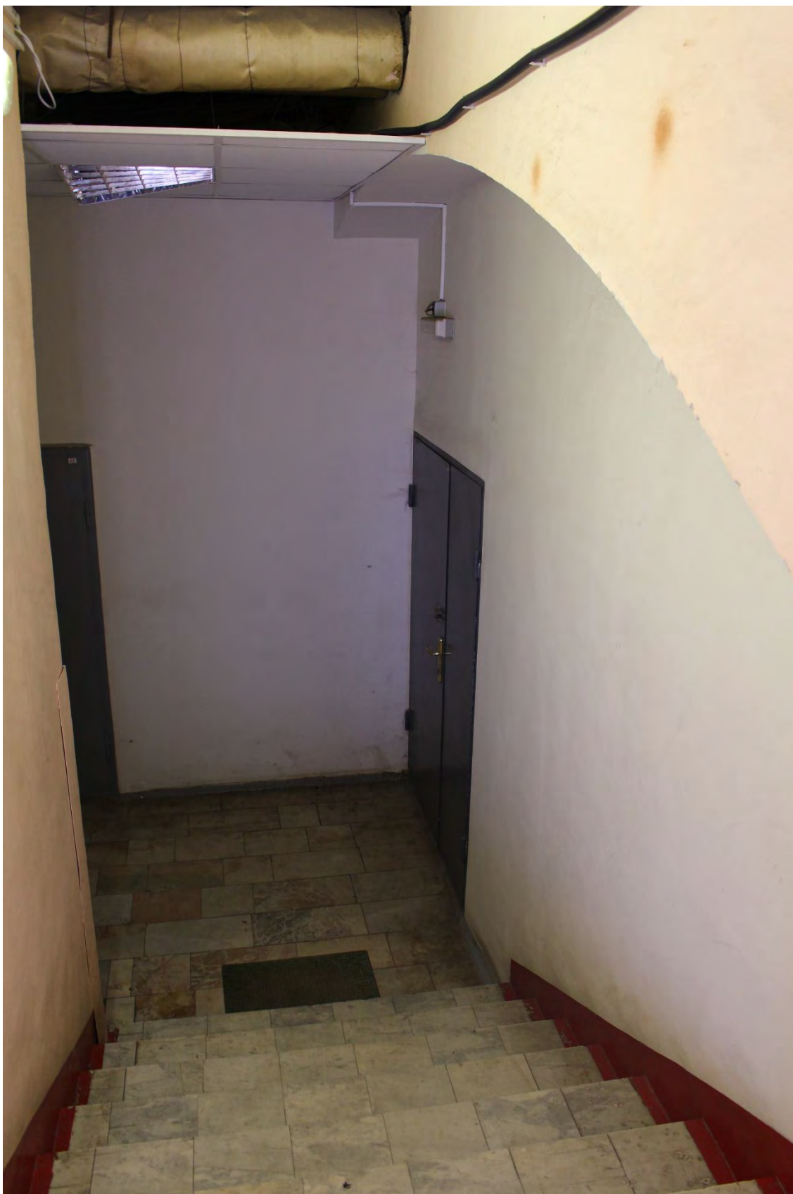
Фото 63. Центральная лестничная клетка лицевого корпуса выявленного объекта культурного наследия «Манеж и конюшни лейб-гвардии Гренадерского полка (здание тира лейб-гвардии Стрелкового батальона)». Фото 22.05.2023 г.
