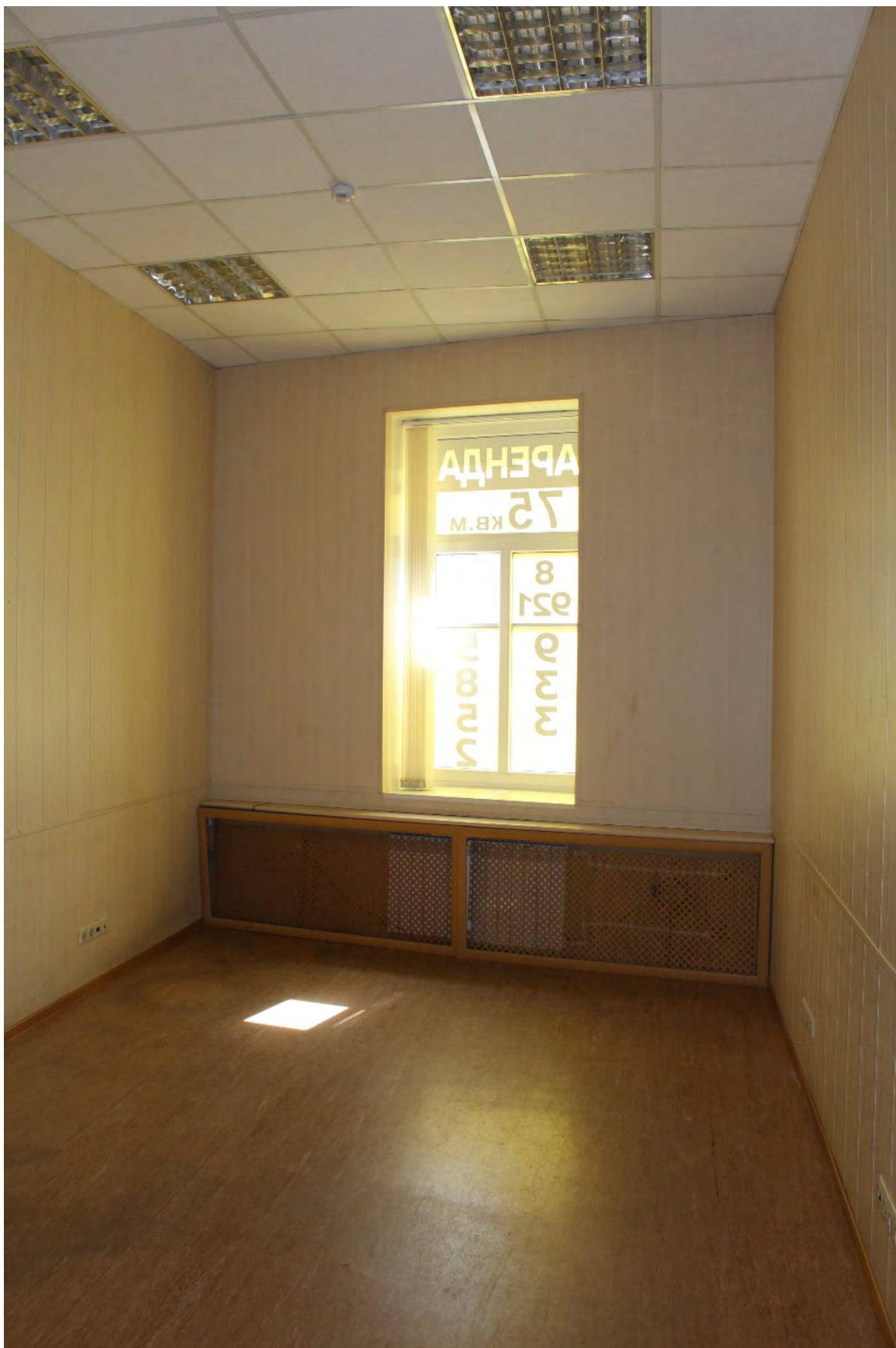
Фото 42. Внутренние помещения 2-го этажа лицевого корпуса выявленного объекта культурного наследия «Манеж и конюшни лейб-гвардии Гренадерского полка (здание тира лейб-гвардии Стрелкового батальона)». Фото 22.05.2023 г.
