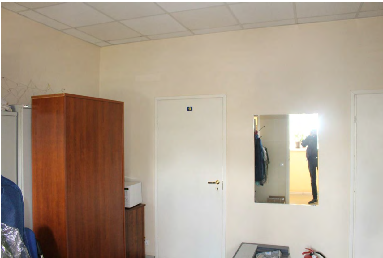
Фото 126. Внутренние помещения 3-го этажа дворового корпуса выявленного объекта культурного наследия «Манеж и конюшни лейб-гвардии Гренадерского полка (здание тира лейб-гвардии Стрелкового батальона)». Фото 22.05.2023 г.
