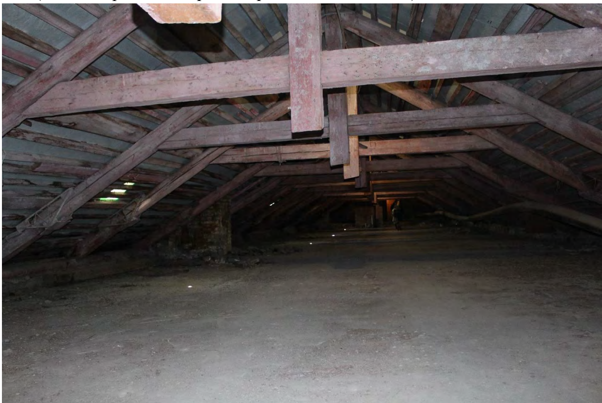
Фото 87. Чердачные помещения лицевого корпуса выявленного объекта культурного наследия «Манеж и конюшни лейб-гвардии Гренадерского полка (здание тира лейб-гвардии Стрелкового батальона)». Фото 22.05.2023 г.
