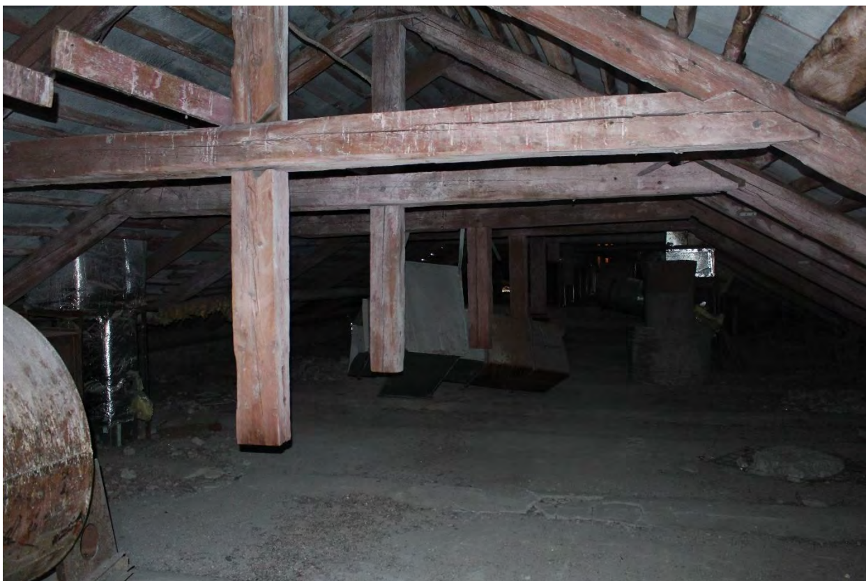
Фото 88. Чердачные помещения лицевого корпуса выявленного объекта культурного наследия «Манеж и конюшни лейб-гвардии Гренадерского полка (здание тира лейб-гвардии Стрелкового батальона)». Фото 22.05.2023 г.
