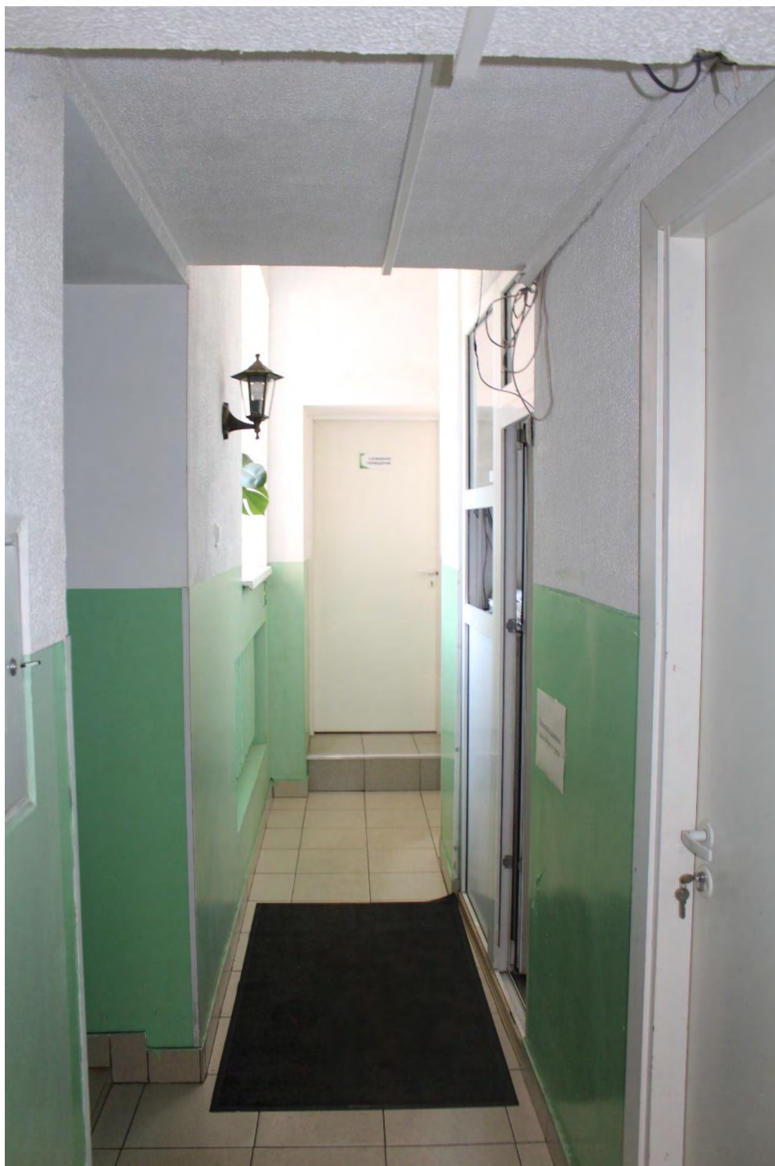
Фото 96. Внутренние помещения 1-го этажа дворового корпуса выявленного объекта культурного наследия «Манеж и конюшни лейб-гвардии Гренадерского полка (здание тира лейб-гвардии Стрелкового батальона)». Фото 22.05.2023 г.
