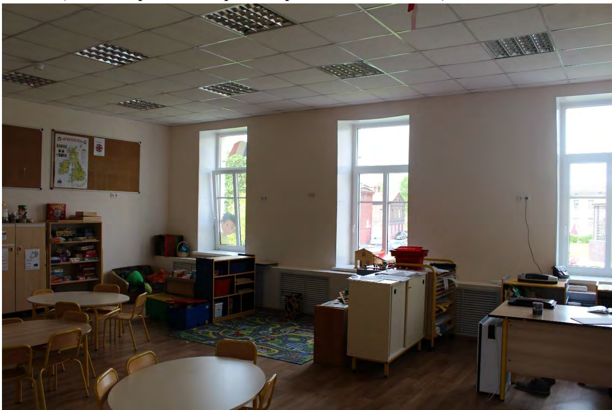
Фото 54. Внутренние помещения 2-го этажа лицевого корпуса выявленного объекта культурного наследия «Манеж и конюшни лейб-гвардии Гренадерского полка (здание тира лейб-гвардии Стрелкового батальона)». Фото 22.05.2023 г.
