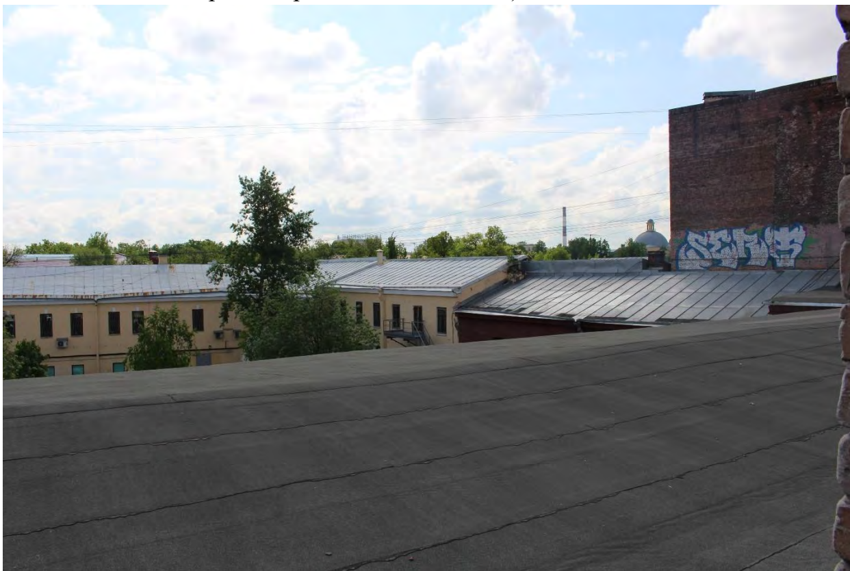
Фото 31. Вид с крыши дворового корпуса выявленного объекта культурного наследия «Манеж и конюшни лейб-гвардии Гренадерского полка (здание тира лейб-гвардии Стрелкового батальона)». Фото 22.05.2023 г.
