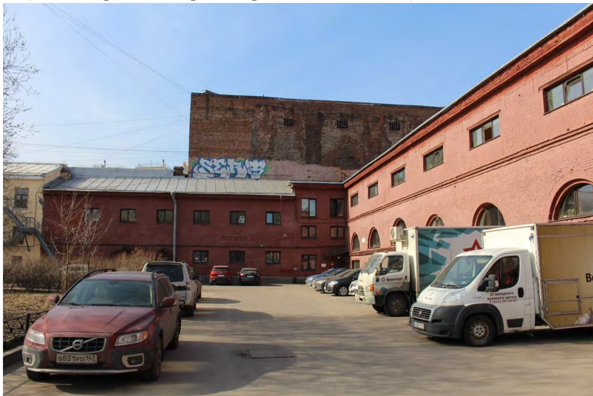
Фото 22. Вид на юго-западный и юго-восточный фасады дворового корпуса выявленного объекта культурного наследия «Манеж и конюшни лейб-гвардии Гренадерского полка (здание тира лейб-гвардии Стрелкового батальона)». Фото 17.04.2023 г.
