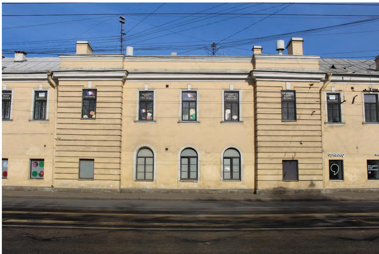
Фото 3. Вид на центральную часть юго-восточного фасада лицевого корпуса выявленного объекта культурного наследия «Манеж и конюшни лейб-гвардии Гренадерского полка (здание тира лейб-гвардии Стрелкового батальона)». Фото 17.04.2023 г.
