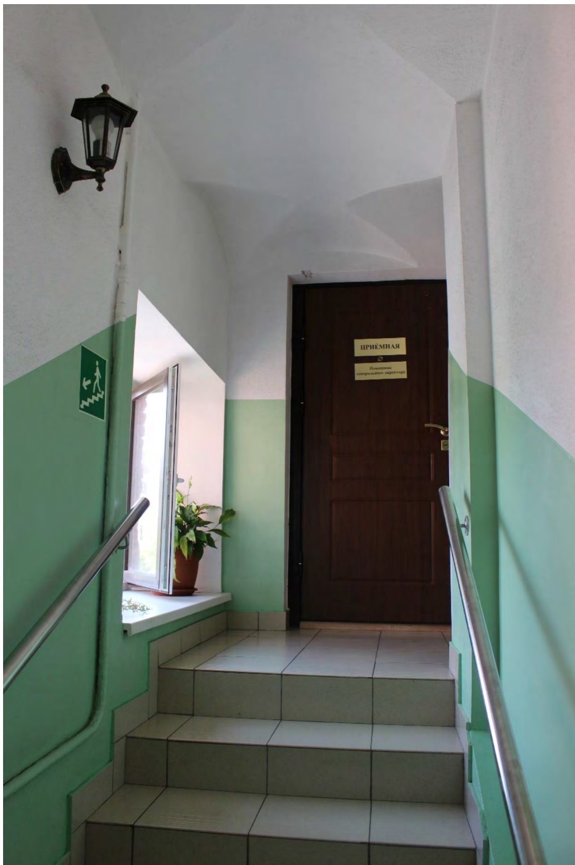
Фото 106. Западная лестничная клетка дворового корпуса выявленного объекта культурного наследия «Манеж и конюшни лейб-гвардии Гренадерского полка (здание тира лейб-гвардии Стрелкового батальона)». Фото 22.05.2023 г.
