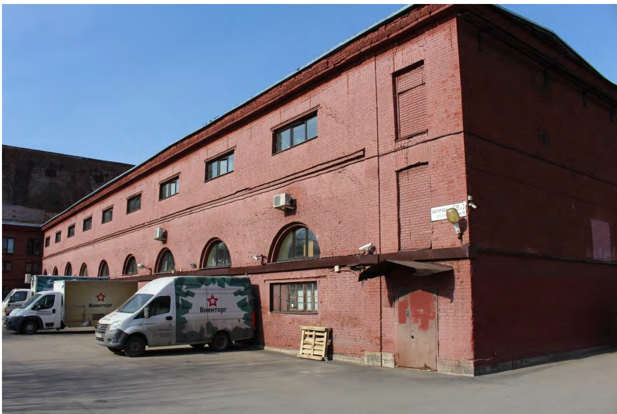
Фото 23. Вид на юго-восточный фасад дворового корпуса выявленного объекта культурного наследия «Манеж и конюшни лейб-гвардии Гренадерского полка (здание тира лейб-гвардии Стрелкового батальона)». Фото 17.04.2023 г.
