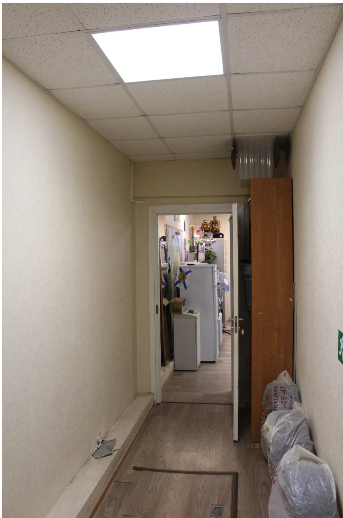
Фото 100. Внутренние помещения 1-го этажа дворового корпуса выявленного объекта культурного наследия «Манеж и конюшни лейб-гвардии Гренадерского полка (здание тира лейб-гвардии Стрелкового батальона)». Фото 22.05.2023 г.
