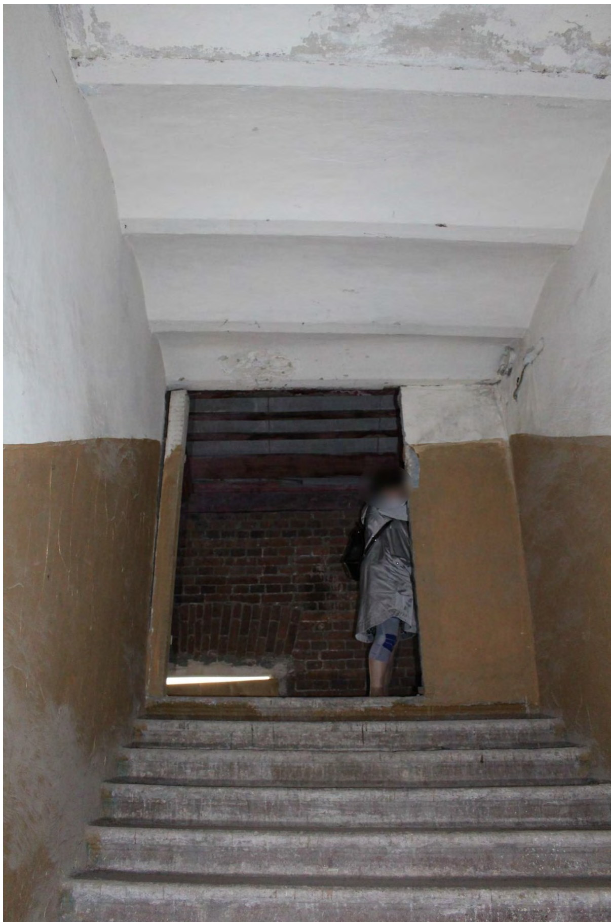
Фото 83. Выход в чердачные помещения лицевого корпуса выявленного объекта культурного наследия «Манеж и конюшни лейб-гвардии Гренадерского полка (здание тира лейб-гвардии Стрелкового батальона)». Фото 22.05.2023 г.
