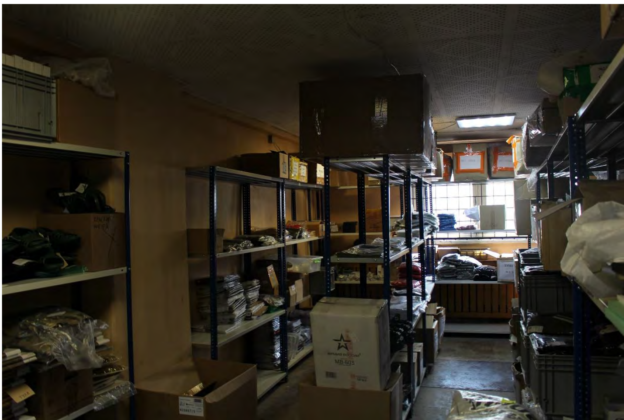
Фото 94. Внутренние помещения 1-го этажа дворового корпуса выявленного объекта культурного наследия «Манеж и конюшни лейб-гвардии Гренадерского полка (здание тира лейб-гвардии Стрелкового батальона)». Фото 22.05.2023 г.
