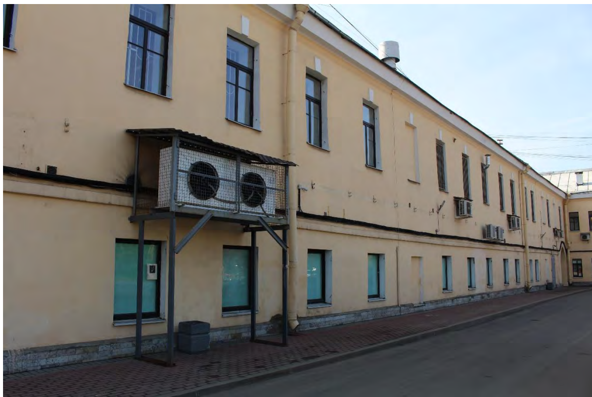
Фото 10. Вид на северо-восточный (дворовый) фасад лицевого корпуса выявленного объекта культурного наследия «Манеж и конюшни лейб-гвардии Гренадерского полка (здание тира лейб-гвардии Стрелкового батальона)». Фото 17.04.2023 г.
