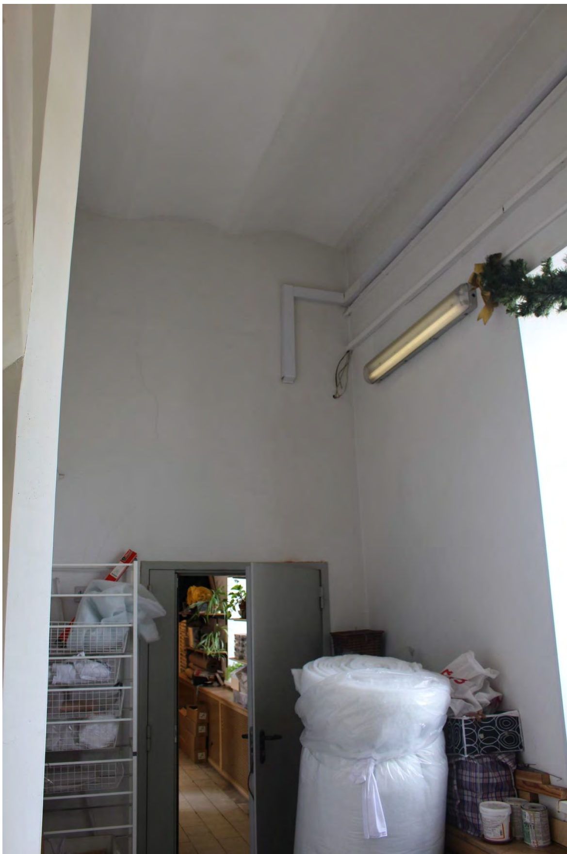
Фото 73. Юго-западная лестничная клетка в уровне 2-го этажа лицевого корпуса выявленного объекта культурного наследия «Манеж и конюшни лейб-гвардии Гренадерского полка (здание тира лейб-гвардии Стрелкового батальона)». Фото 22.05.2023 г.
