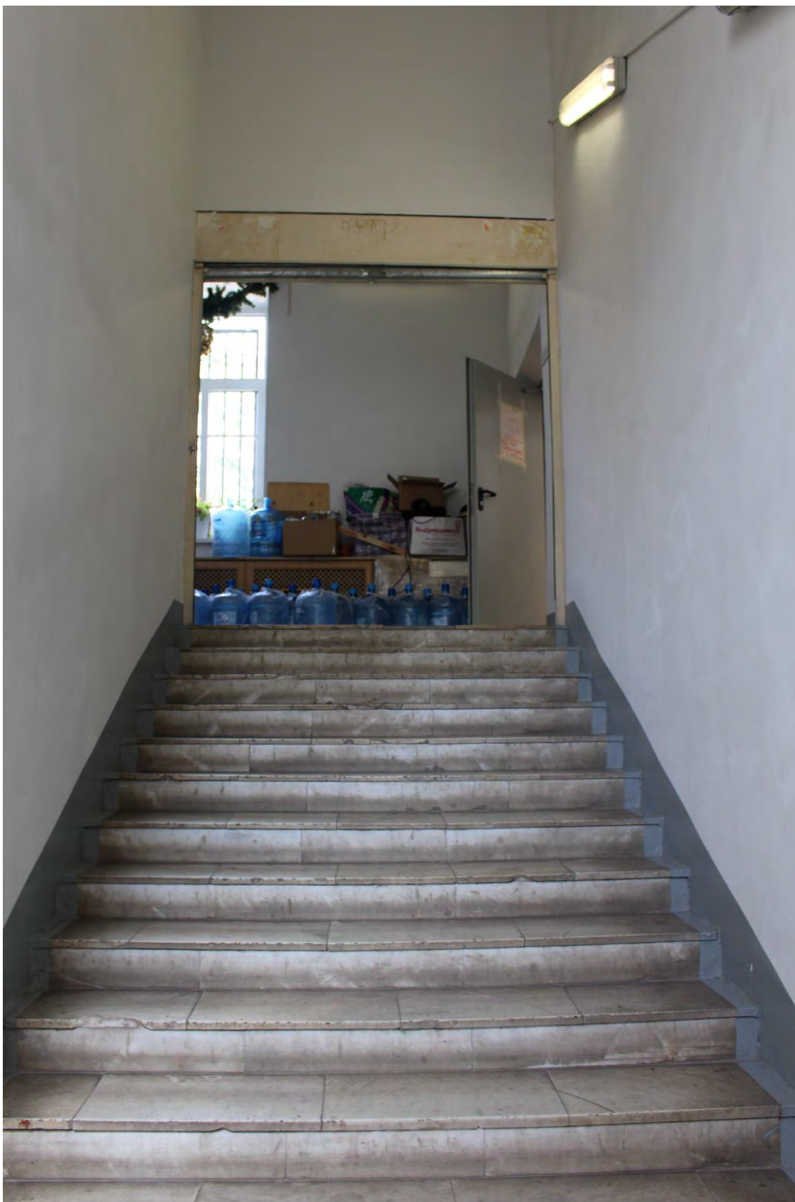
Фото 71. Юго-западная лестничная клетка лицевого корпуса выявленного объекта культурного наследия «Манеж и конюшни лейб-гвардии Гренадерского полка (здание тира лейб-гвардии Стрелкового батальона)». Фото 22.05.2023 г.
