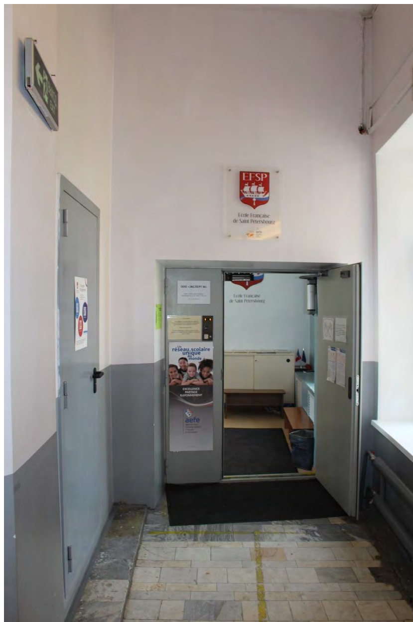
Фото 48. Вид на северо-восточную лестничную клетку в уровне 2-го этажа лицевого корпуса выявленного объекта культурного наследия «Манеж и конюшни лейб-гвардии Гренадерского полка (здание тира лейб-гвардии Стрелкового батальона)». Фото 22.05.2023 г.
