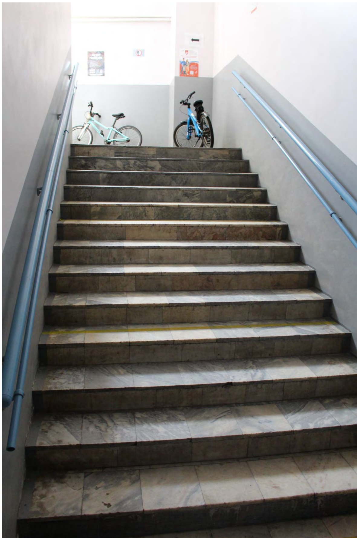
Фото 38. Вид на северо-восточную лестничную клетку лицевого корпуса выявленного объекта культурного наследия «Манеж и конюшни лейб-гвардии Гренадерского полка (здание тира лейб-гвардии Стрелкового батальона)». Фото 22.05.2023 г.
