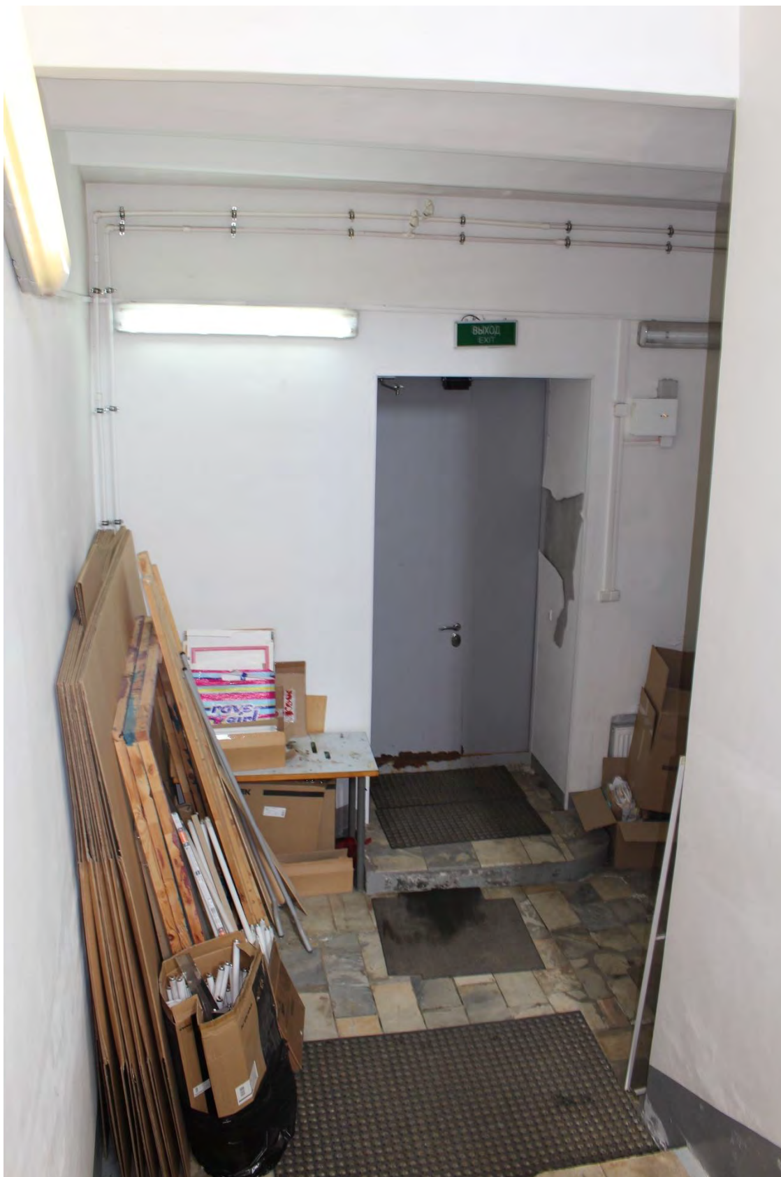
Фото 69. Юго-западная лестничная клетка лицевого корпуса выявленного объекта культурного наследия «Манеж и конюшни лейб-гвардии Гренадерского полка (здание тира лейб-гвардии Стрелкового батальона)». Фото 22.05.2023 г.
