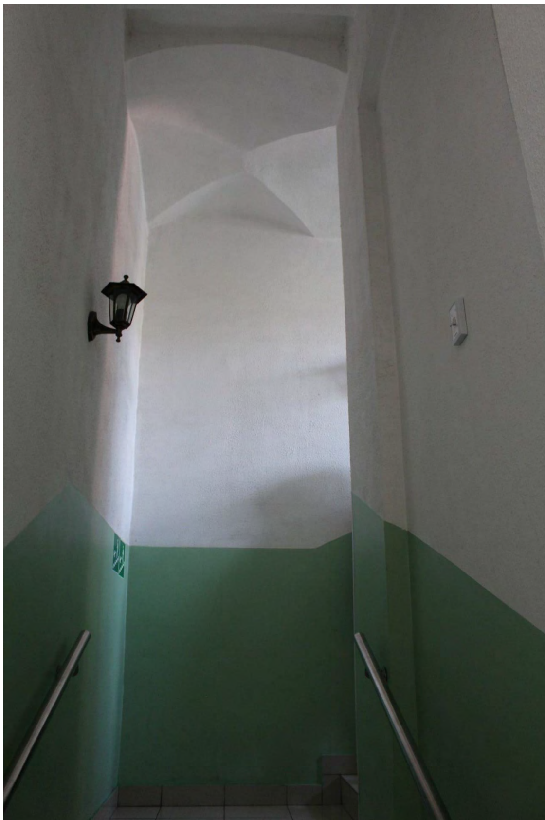
Фото 103. Западная лестничная клетка дворового корпуса выявленного объекта культурного наследия «Манеж и конюшни лейб-гвардии Гренадерского полка (здание тира лейб-гвардии Стрелкового батальона)». Фото 22.05.2023 г.
