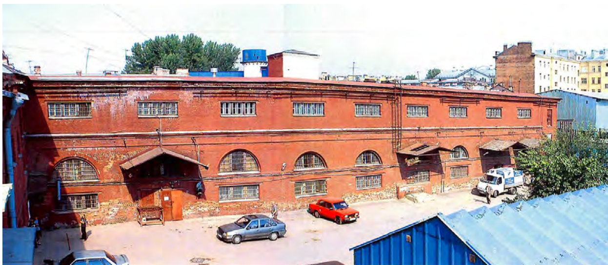
Илл. 46. Вид на южный фасад дворового корпуса (Загородный пр., д. 35, корп. 3, литера Н). 2008 г. (источник: архив КГИОП).
