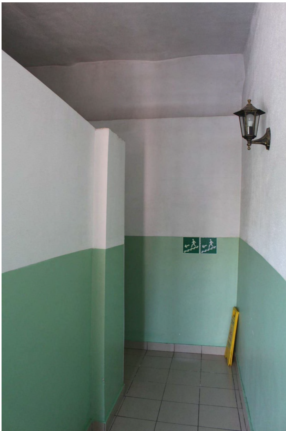
Фото 132. Западная лестничная клетка дворового корпуса выявленного объекта культурного наследия «Манеж и конюшни лейб-гвардии Гренадерского полка (здание тира лейб-гвардии Стрелкового батальона)». Фото 22.05.2023 г.
