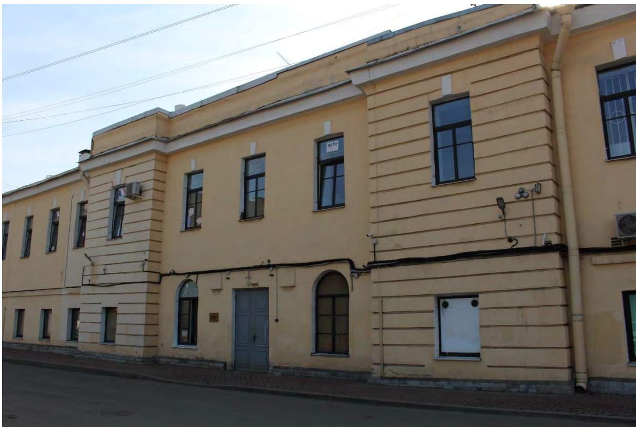
Фото 11. Вид на центральную часть северо-восточного (дворового) фасада лицевого корпуса выявленного объекта культурного наследия «Манеж и конюшни лейб-гвардии Гренадерского полка (здание тира лейб-гвардии Стрелкового батальона)». Фото 17.04.2023 г.
