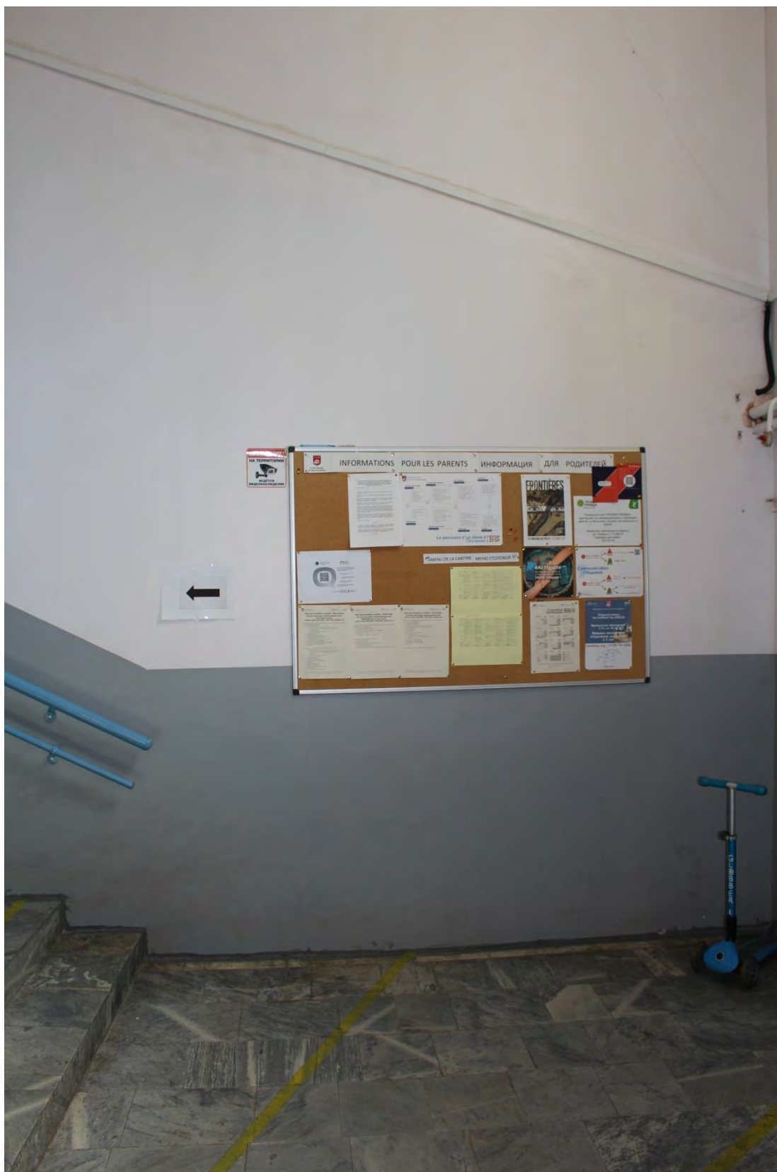
Фото 39. Вид на северо-восточную лестничную клетку лицевого корпуса выявленного объекта культурного наследия «Манеж и конюшни лейб-гвардии Гренадерского полка (здание тира лейб-гвардии Стрелкового батальона)». Фото 22.05.2023 г.
