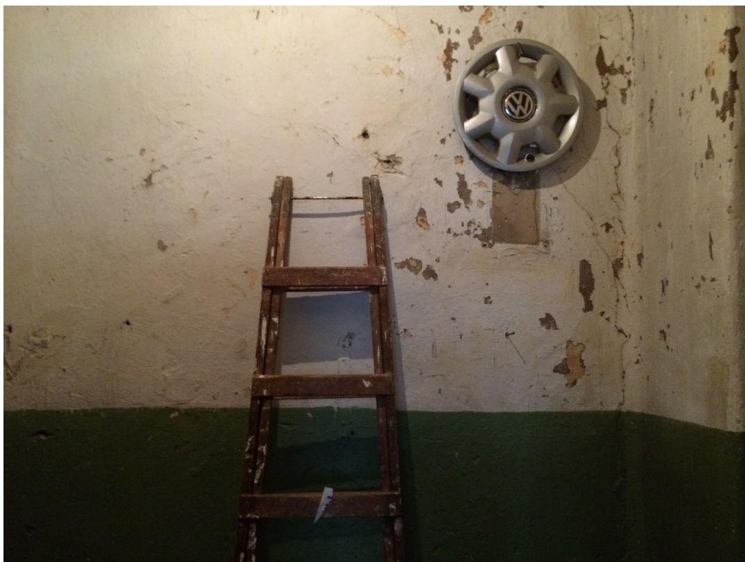
Фото 10 Общий вид на часть помещений квартиры № 50 (№ 4 по плану ПИБ).
