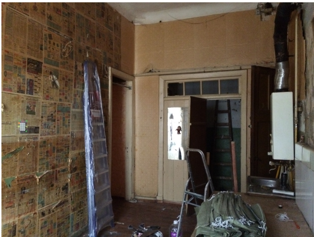
Фото 12 Общий вид на часть помещений квартиры № 50 (№ 6 по плану ПИБ).
