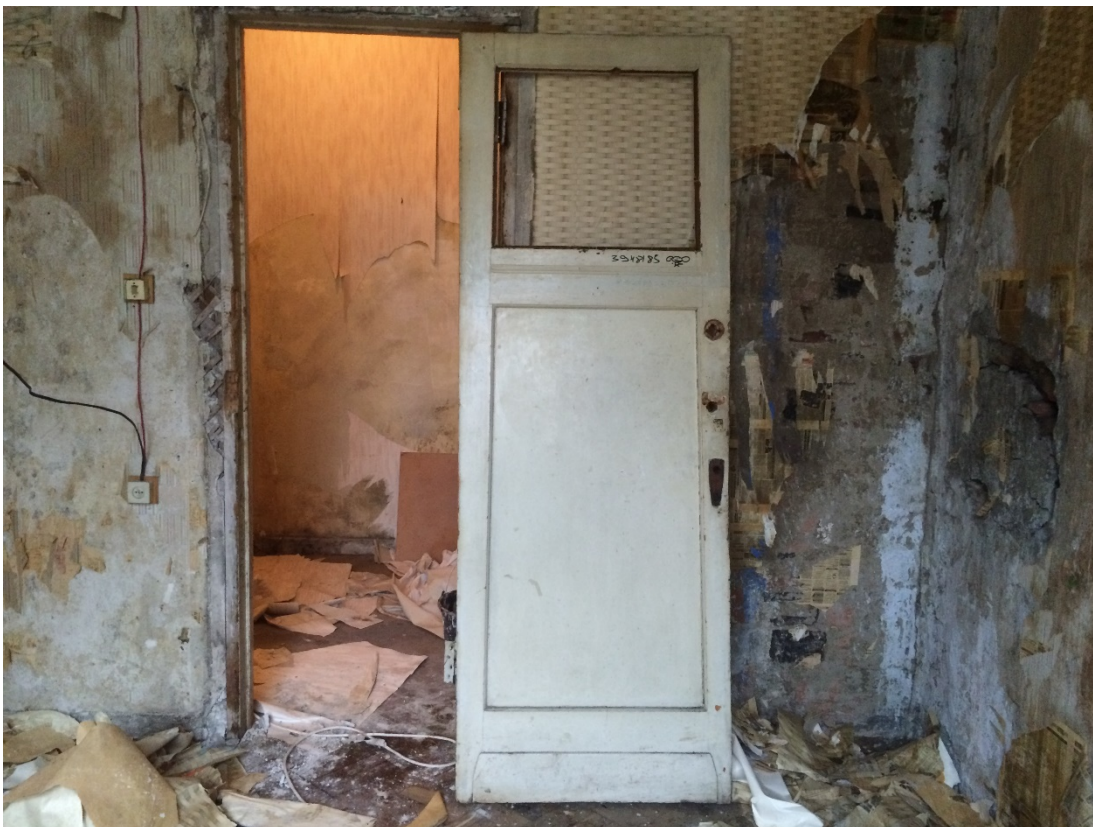
Фото 4 Общий вид на часть помещений квартиры № 50 (№ 2 по плану ПИБ).
