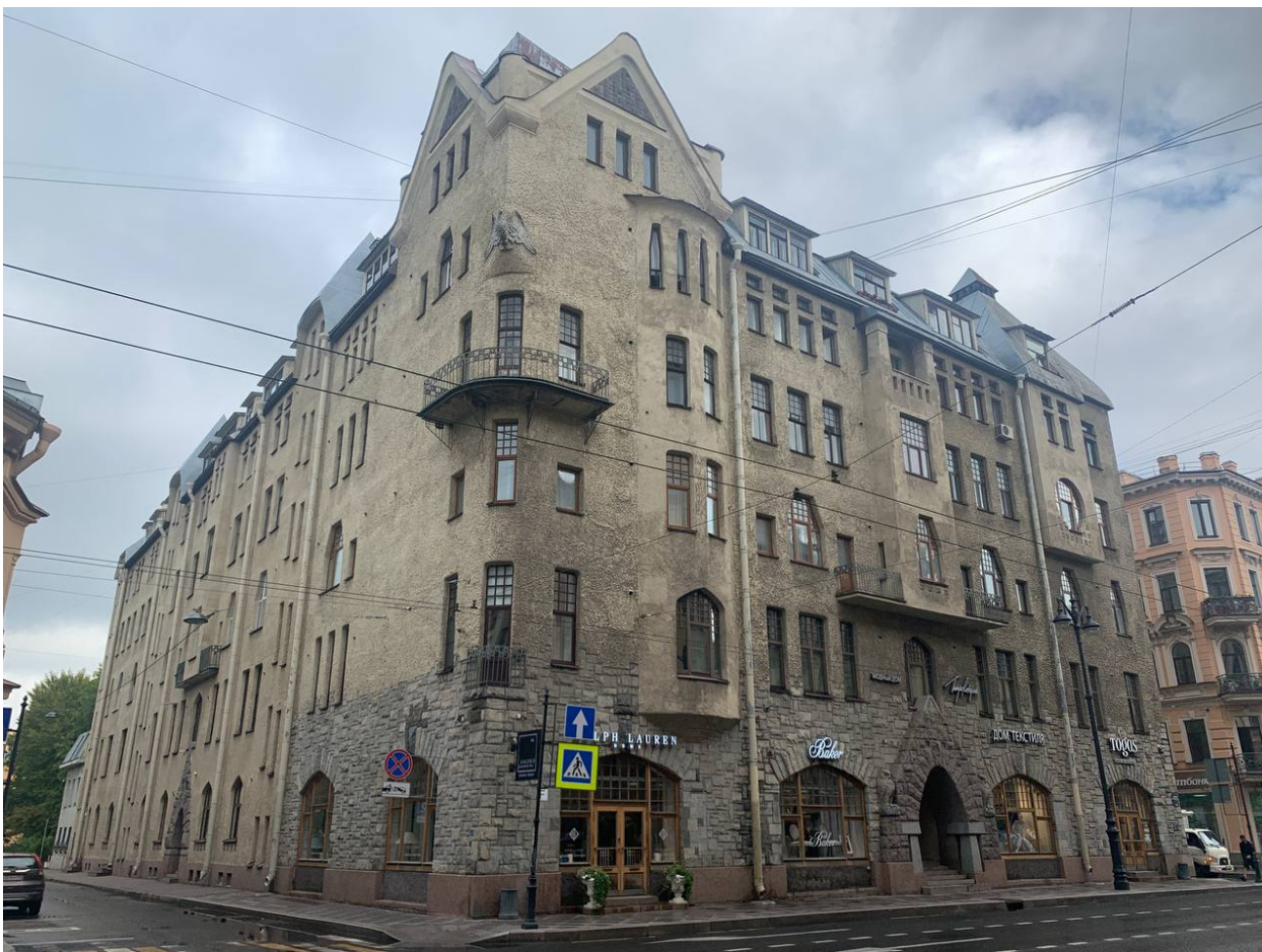
Фото 10 Общий вид на лицевые фасады здания со стороны Большого пр. П.С.
