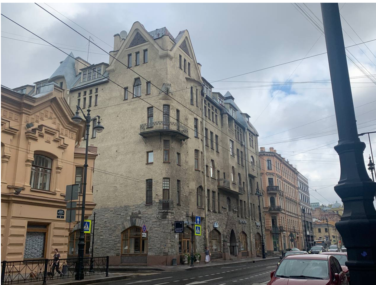
Фото 11 Общий вид на лицевые фасады здания со стороны Большого пр. П.С.
