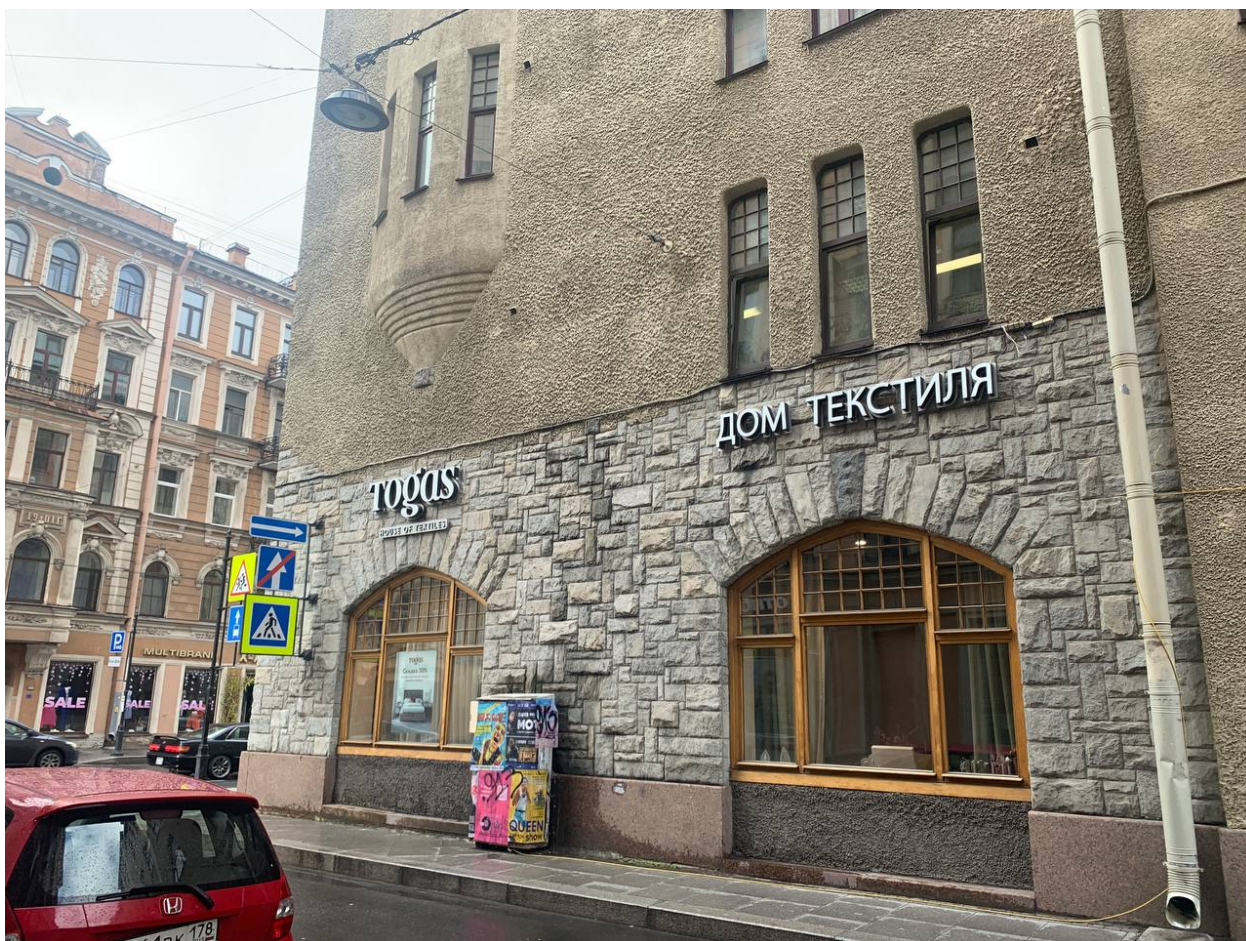
Фото 6 Общий вид на фрагмент лицевого фасада здания со стороны Ораниенбаумской ул.
