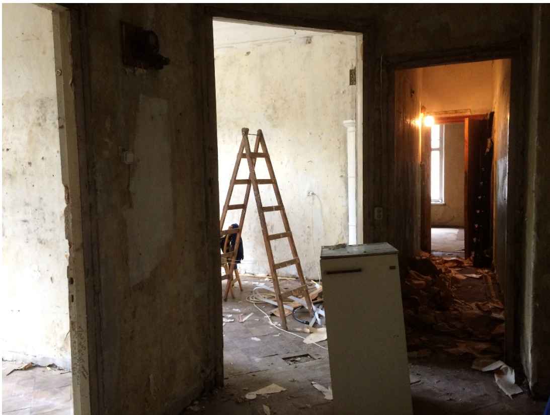
Фото 2 Общий вид на часть помещений квартиры № 50 (№ 1 по плану ПИБ).
