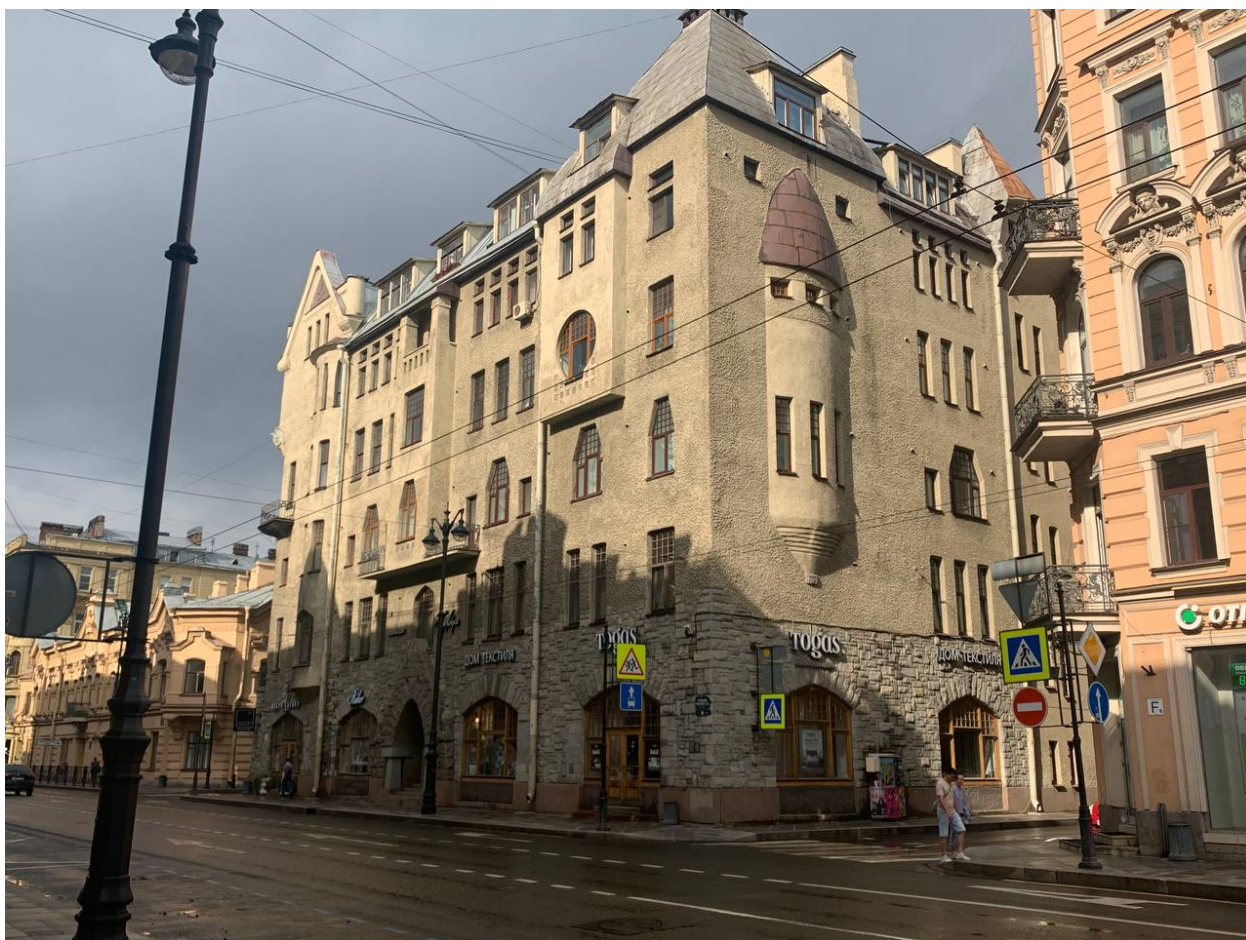
Фото 7 Общий вид на лицевые фасады здания со стороны Большого пр. П.С.
