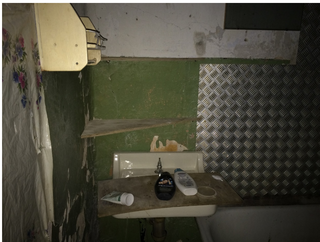
Фото 11 Общий вид на часть помещений квартиры № 50 (№ 5 по плану ПИБ).
