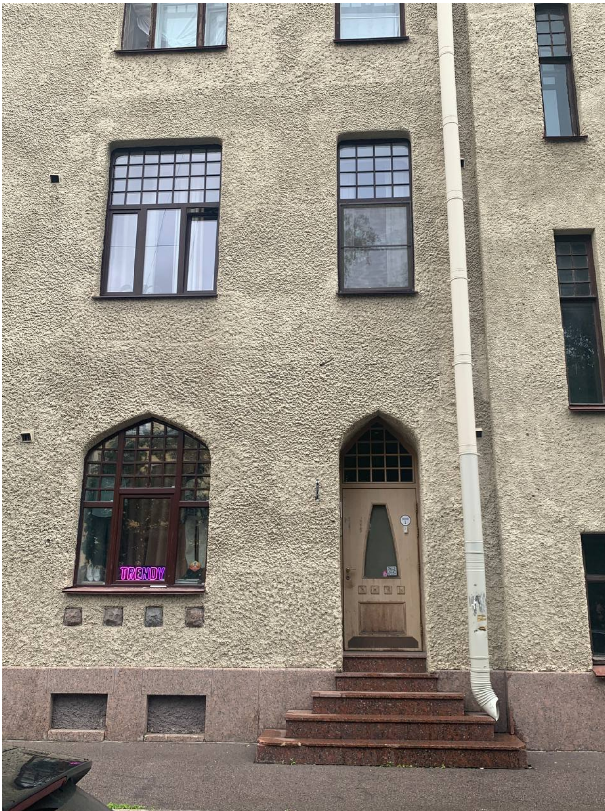
Фото 14 Общий вид на фрагмент лицевого фасада здания со стороны Стрельнинской ул.
