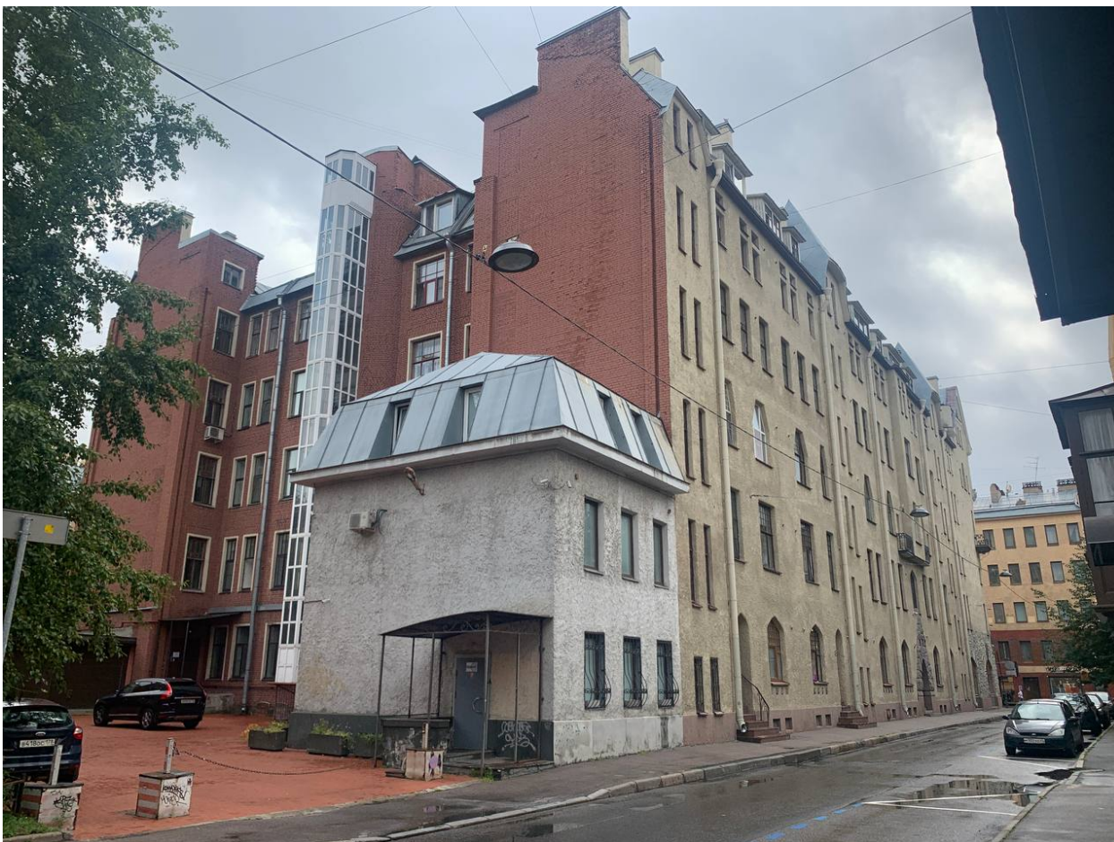
Фото 16 Общий вид на дворовой и лицевой фасады здания со стороны Стрельнинской ул.
