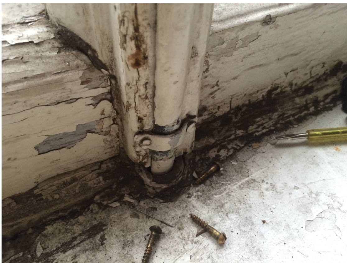
Фото 7 Вид на фурнитуру оконного заполнения квартиры № 50 (№ 3 по плану ПИБ).
