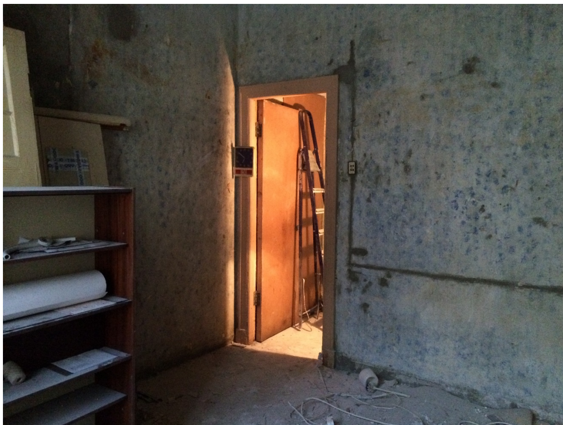
Фото 20 Общий вид на часть помещений квартиры № 50 (№ 8 по плану ПИБ).
