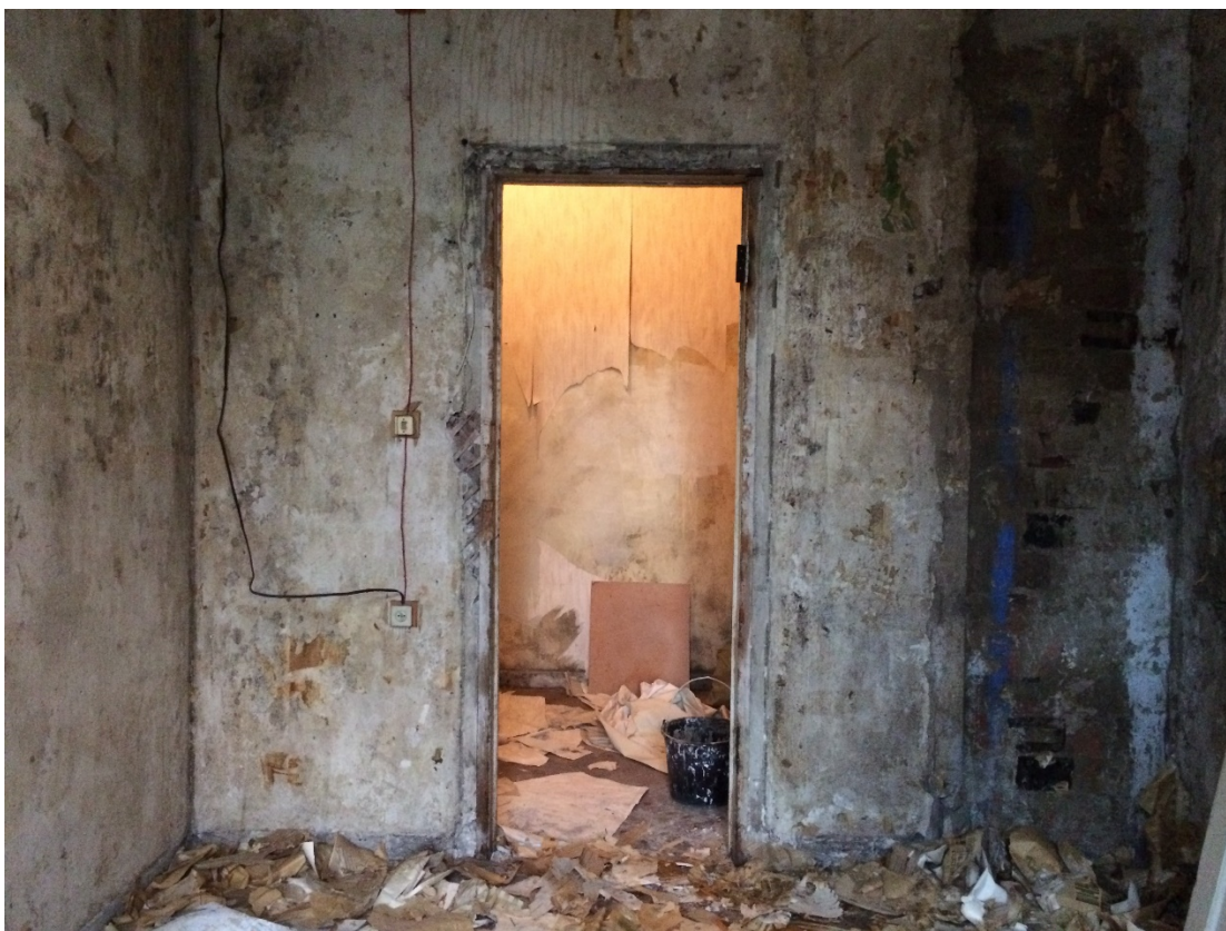
Фото 5 Общий вид на часть помещений квартиры № 50 (№ 2 по плану ПИБ).
