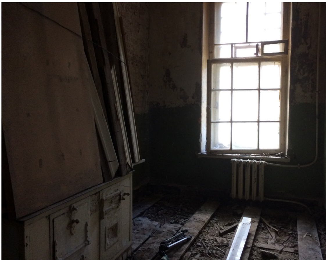
Фото 15 Общий вид на часть помещений квартиры № 50 (№ 6 по плану ПИБ). Наблюдается демонтированное напольное покрытие.
