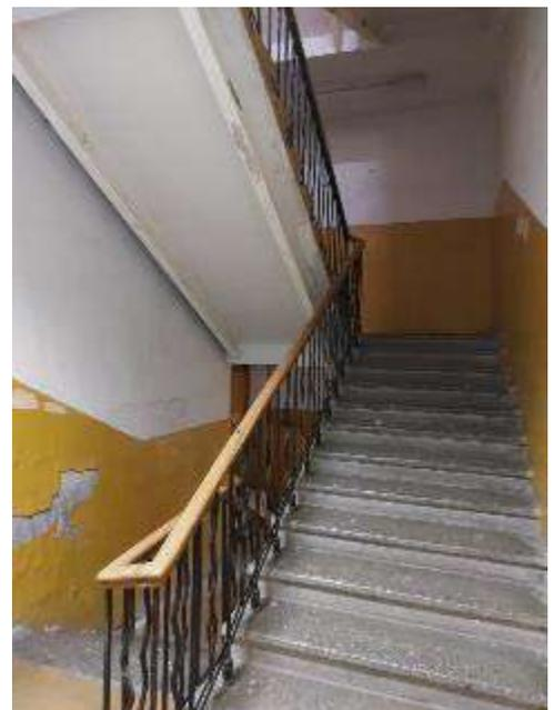
трехмаршевая межэтажная лестница в северо-западной части здания («Дом по Кабинетской улице») (8ЛК), на сводах, с известняковыми ступенями и ограждениями кованого железа (рисунок – вертикальные стойки с перехватами и арочными завершениями) и деревянными профилированными поручнями;
