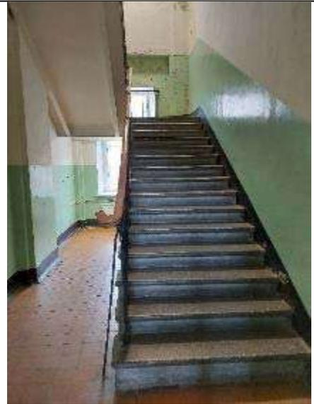
трехмаршевая межэтажная лестница в юго-западной части здания («Дом по Кабинетской улице») (4ЛК), на косоурах, и на сводах, с известняковыми ступенями и ограждениями кованого железа (рисунок – вертикальные стойки, горизонтальные тяги, волотообразные завитки);
