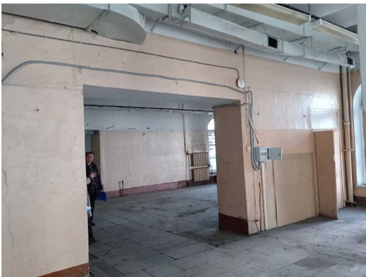
Фото 63. Выявленный объект культурного наследия «Здание детского приюта вел. кн. Александры Николаевны (со служебными постройками)» по адресу: г. Санкт-Петербург, Лермонтовский пр. 51, 12-я Красноармейская б/№
