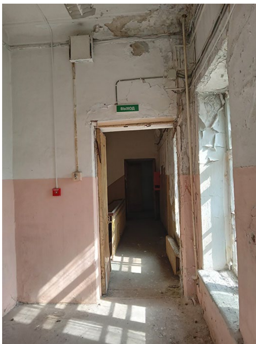
Фото 84. Выявленный объект культурного наследия «Здание детского приюта вел. кн. Александры Николаевны (со служебными постройками)» по адресу: г. Санкт-Петербург, Лермонтовский пр. 51, 12-я Красноармейская б/№
