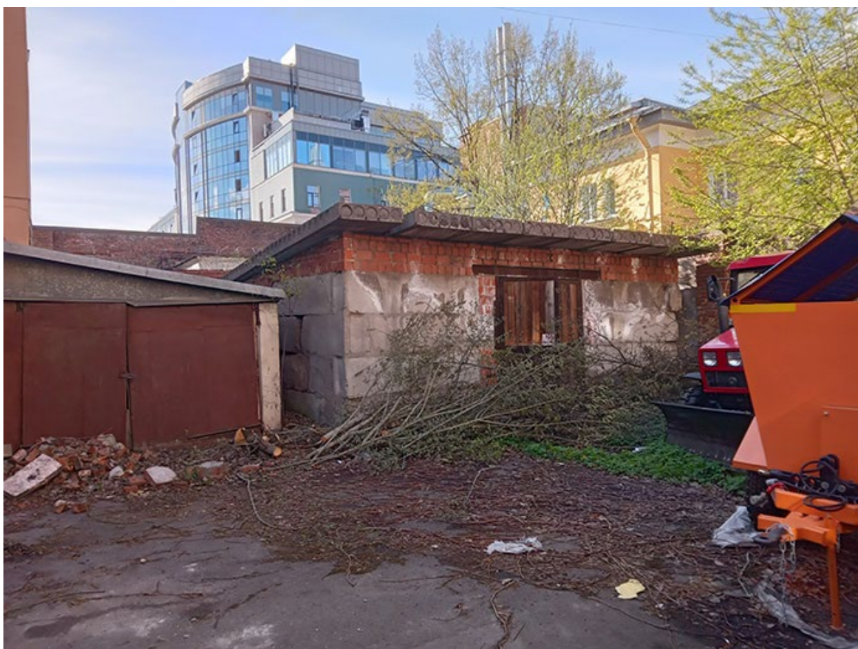
Фото 32. Выявленный объект культурного наследия «Здание детского приюта вел. кн. Александры Николаевны (со служебными постройками)» по адресу: г. Санкт-Петербург, Лермонтовский пр. 51, 12-я Красноармейская б/№
