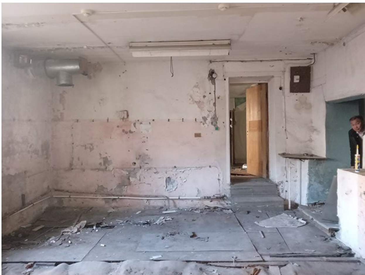
Фото 51. Выявленный объект культурного наследия «Здание детского приюта вел. кн. Александры Николаевны (со служебными постройками)» по адресу: г. Санкт-Петербург, Лермонтовский пр. 51, 12-я Красноармейская б/№
