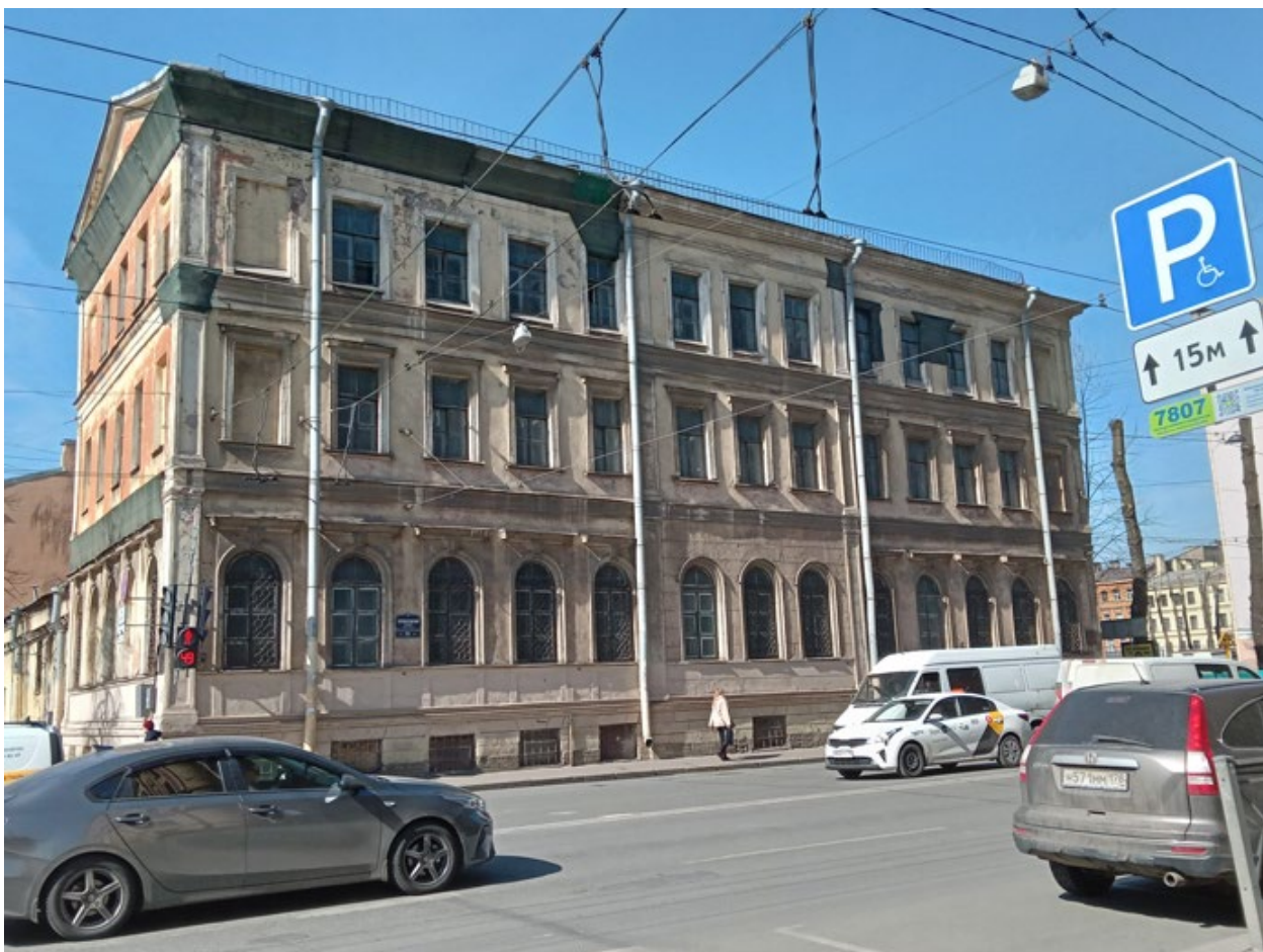
Фото 2. Выявленный объект культурного наследия «Здание детского приюта вел. кн. Александры Николаевны (со служебными постройками)» по адресу: г. Санкт-Петербург, Лермонтовский пр. 51, 12-я Красноармейская б/№
