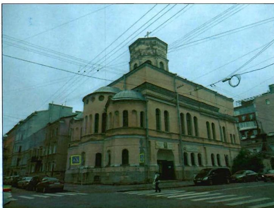
1. Общий вид с северо-востока.
