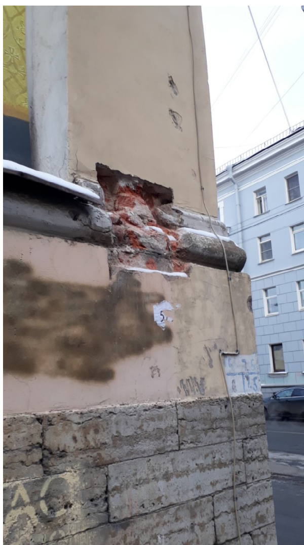
Фото 2. Объект культурного наследия регионального значения «Подворье Старо-Афонского Свято-Андреевского мужского скита» по адресу: Санкт-Петербург, 5-я Советская ул., д. 31-33, лит. А — церковь Благовещения Пресвятой Богородицы. В процессе проведения натурных исследований выполнены зондажи для подтверждения срубленных декоративных элементов фасада. Здание имеет высокий цоколь из плит известняка.
