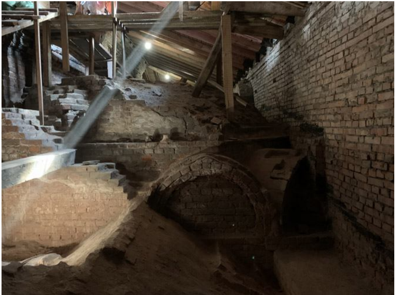
Фото 22. Объект культурного наследия регионального значения «Подворье Старо-Афонского Свято-Андреевского мужского скита» по адресу: Санкт-Петербург, 5-я Советская ул., д. 31-33, лит. А — церковь Благовещения Пресвятой Богородицы. Пространство чердака (надстроенный третий этаж). Вид со стороны юго-западного среднего барабана на центральный восьмерик и закомары. Кирпичная стена возведена в 1960-е гг.
