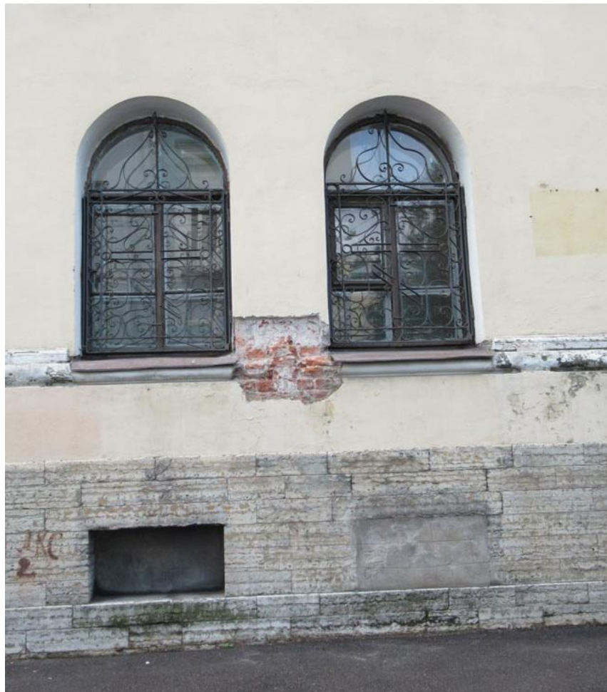
Фото 9. Объект культурного наследия регионального значения «Подворье Старо-Афонского Свято-Андреевского мужского скита» по адресу: Санкт-Петербург, 5-я Советская ул., д. 31-33, лит. А — церковь Благовещения Пресвятой Богородицы. Вход с 5-й Советской улицы. Цоколь выложен из известняка. Видны восемь рядов камня. В цоколе были выполнены оконные проемы прямоугольной формы по световым осям верхних этажей — большинство в настоящее время заложены.
