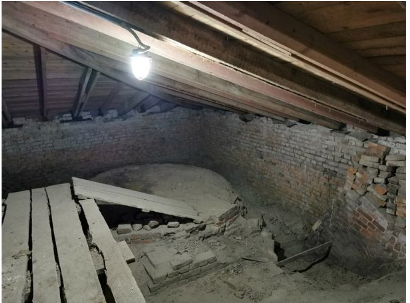
Фото 21. Объект культурного наследия регионального значения «Подворье Старо-Афонского Свято-Андреевского мужского скита» по адресу: Санкт-Петербург, 5-я Советская ул., д. 31-33, лит. А — церковь Благовещения Пресвятой Богородицы. Пространство чердака (надстроенный третий этаж). Вид на основание северо-восточного среднего барабана. Кирпичная стена возведена в 1960-е гг.
