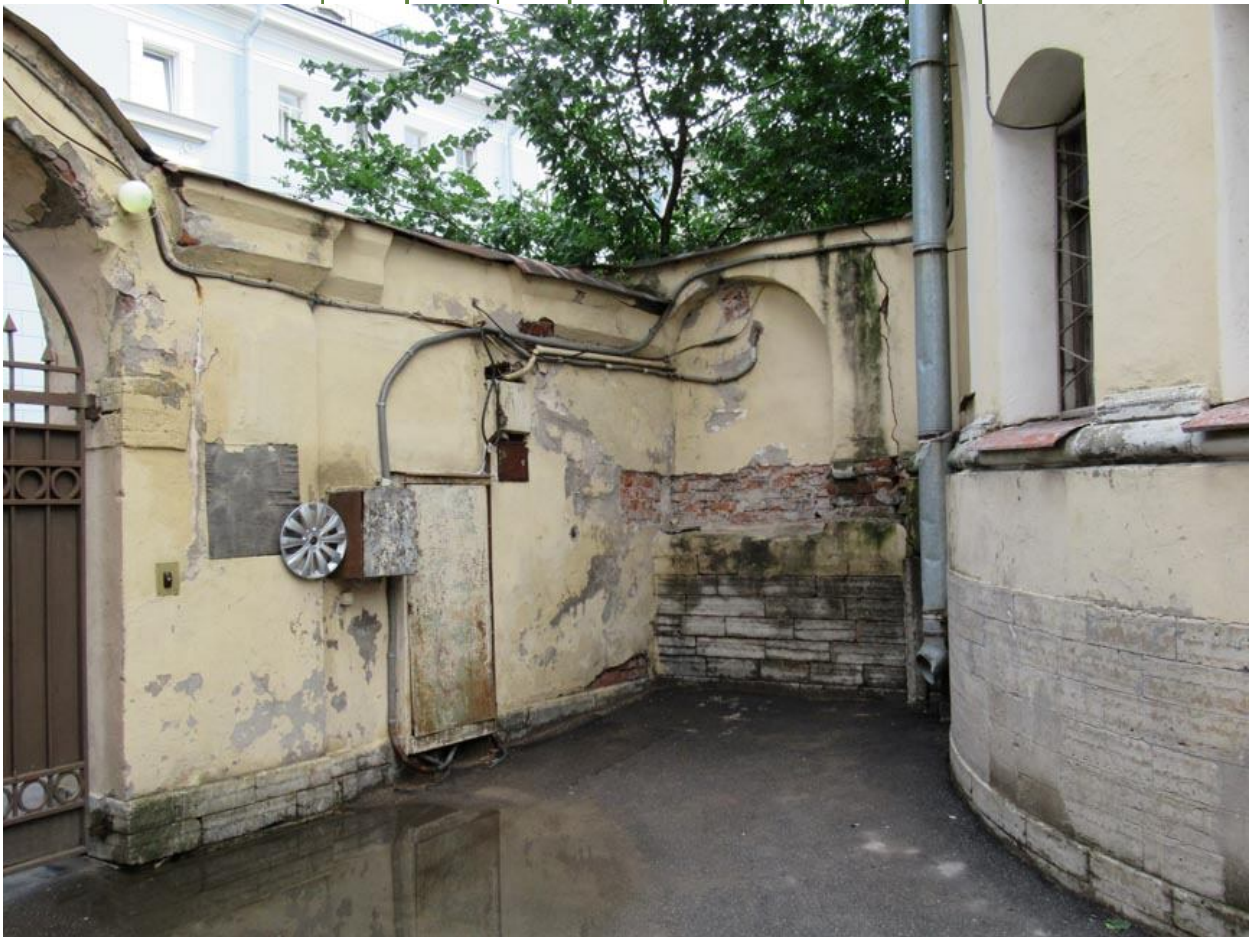
Фото 12. Объект культурного наследия регионального значения «Подворье Старо-Афонского Свято-Андреевского мужского скита» по адресу: Санкт-Петербург, 5-я Советская ул., д. 31-33, лит. А — церковь Благовещения Пресвятой Богородицы. Вид со стороны двора на ограду и стенку утраченного крыльца. На стенке крыльца сохранился заложный проем. На ограде — частично срубленный проем с полуциркулярным завершением.
