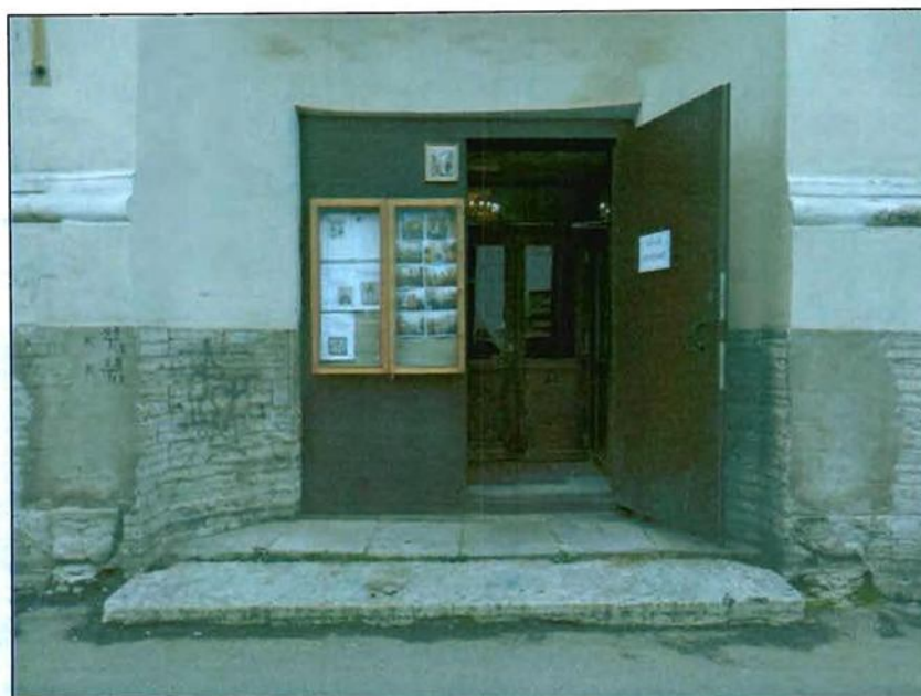
4. Северный фасад. Крыльцо.
