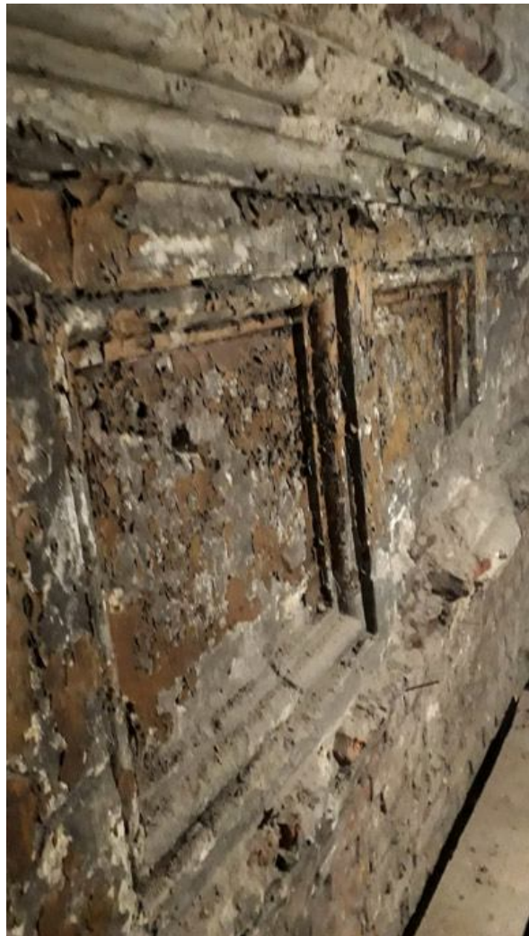
Фото 20. Объект культурного наследия регионального значения «Подворье Старо-Афонского Свято-Андреевского мужского скита» по адресу: Санкт-Петербург, 5-я Советская ул., д. 31-33, лит. А— церковь Благовещения Пресвятой Богородицы. Пространство чердака (надстроенный третий этаж). Вид на центральный восьмигранник с сохранившимися фрагментами филея и профилированной тяги.
