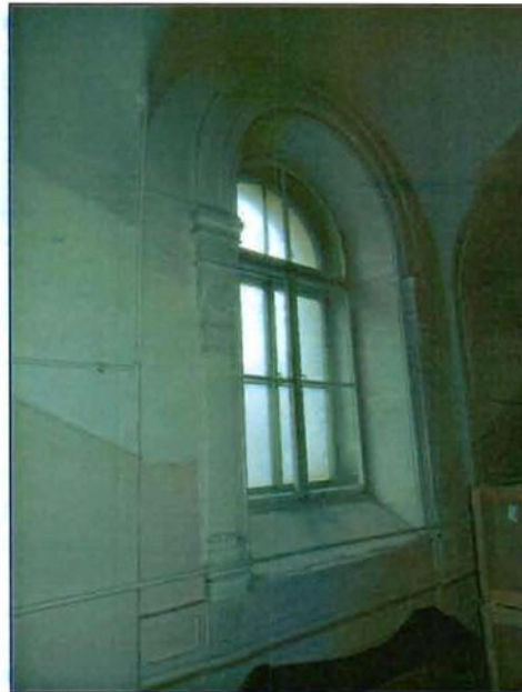
7. Центральный оконный проем парадной лестницы.
