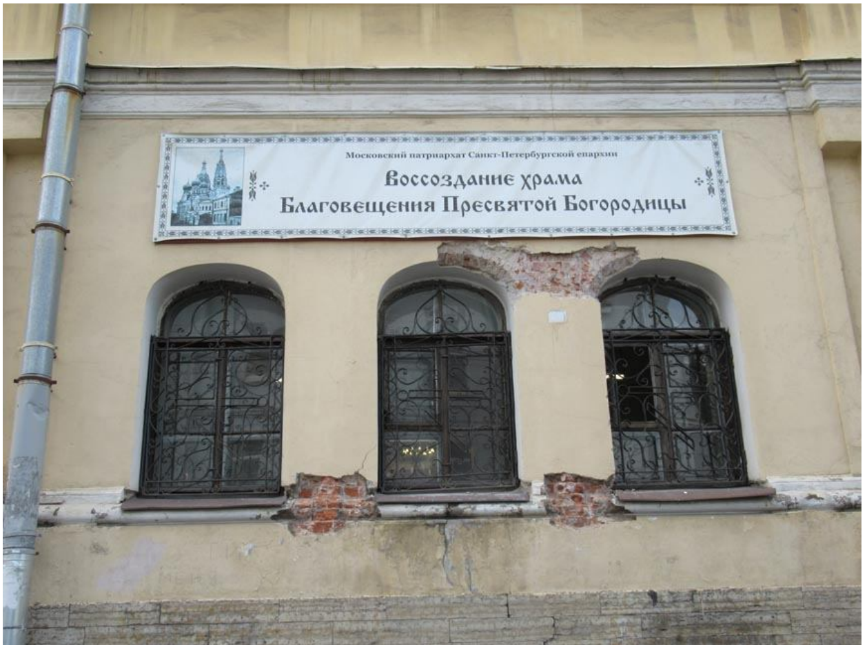
Фото 8. Объект культурного наследия регионального значения «Подворье Старо-Афонского Свято-Андреевского мужского скита» по адресу: Санкт-Петербург, 5-я Советская ул., д. 31-33, лит. А — церковь Благовещения Пресвятой Богородицы. Вход с 5-й Советской улицы. Оконные проемы с полуциркульными завершениями. Выполненные зондажи показывают стесанные полуколонки.
