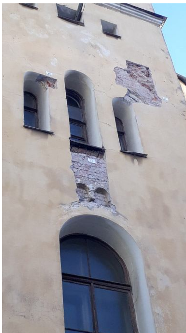
Фото 16. Объект культурного наследия регионального значения «Подворье Старо-Афонского Свято-Андреевского мужского скита» по адресу: Санкт-Петербург, 5-я Советская ул., д. 31-33, лит. А — церковь Благовещения Пресвятой Богородицы. Вид со стороны двора на фрагмент западного фасада здания — объем колокольни. Над окном обнаружен заштукатуренный аркатурный пояс, над окнами второго этажа видны следы стесанных декоративных элементов.
