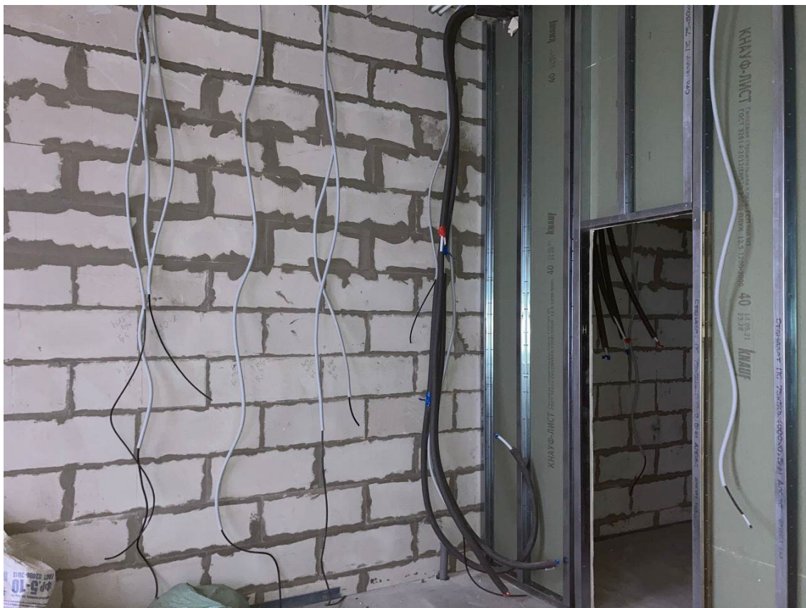
Фото 20. Помещение 4. Вид на вход во вспомогательное помещение.
