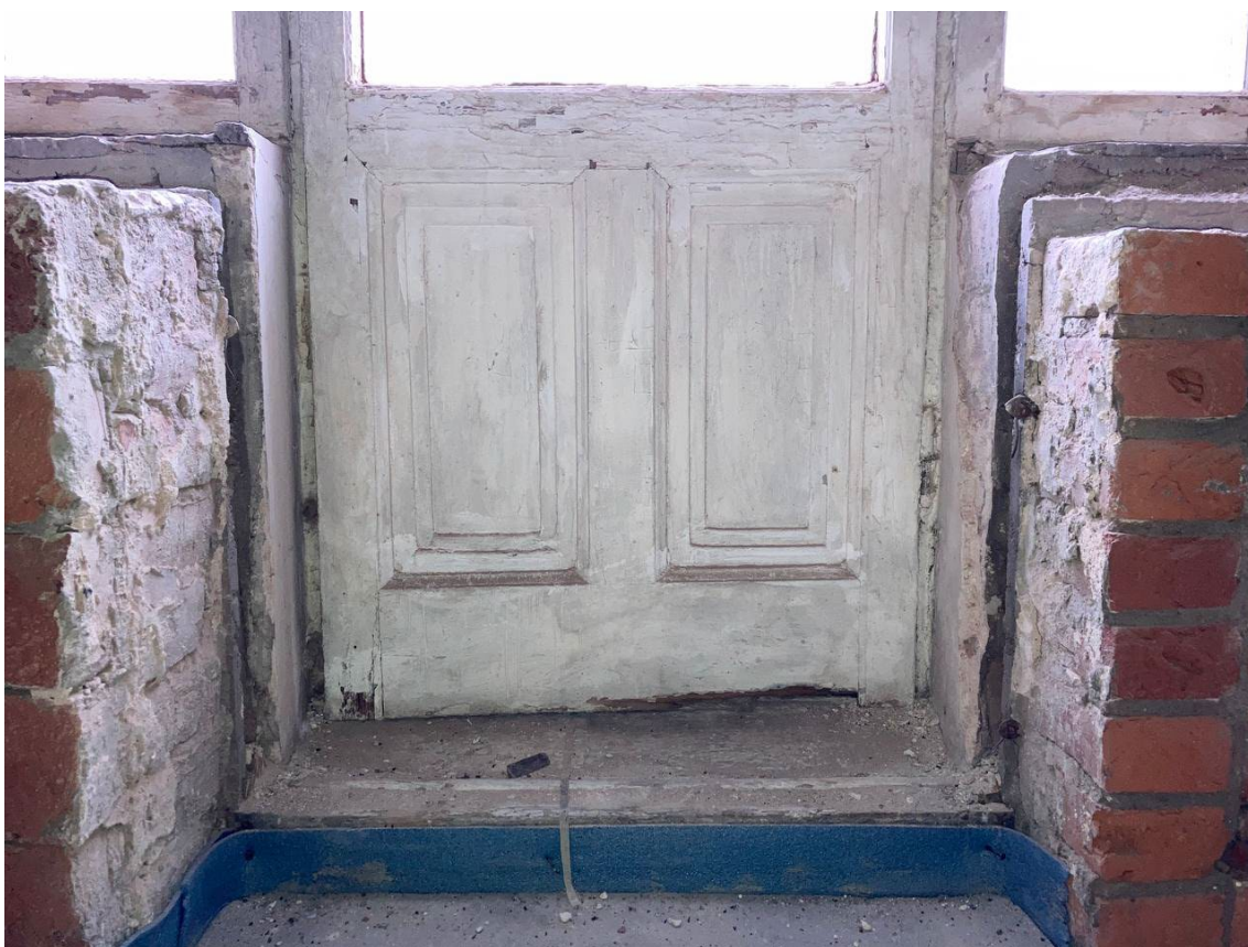
Фото 25. Помещение 5. Фрагмент балконной двери.
