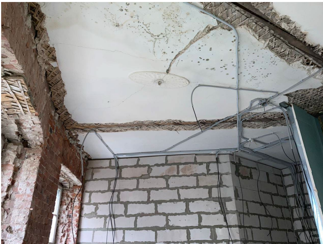
Фото 29. Помещение 6. Перегородка и фрагмент потолка.
