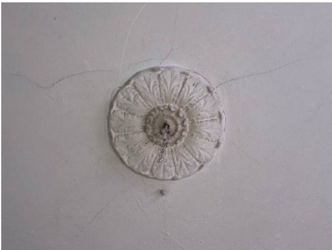
Фото 10. Помещение 1. Потолочная розетка.
