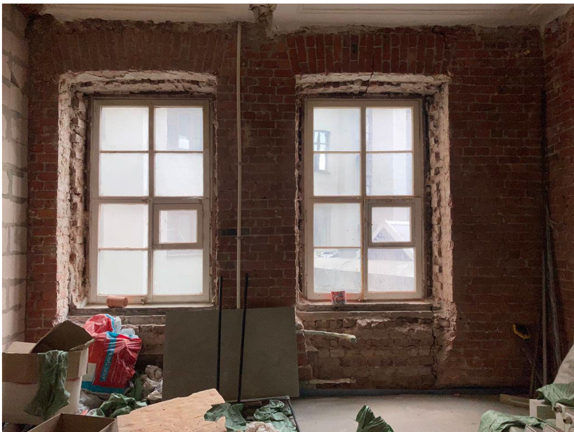
Фото 7. Помещение 1. Вид на стену с окнами.
