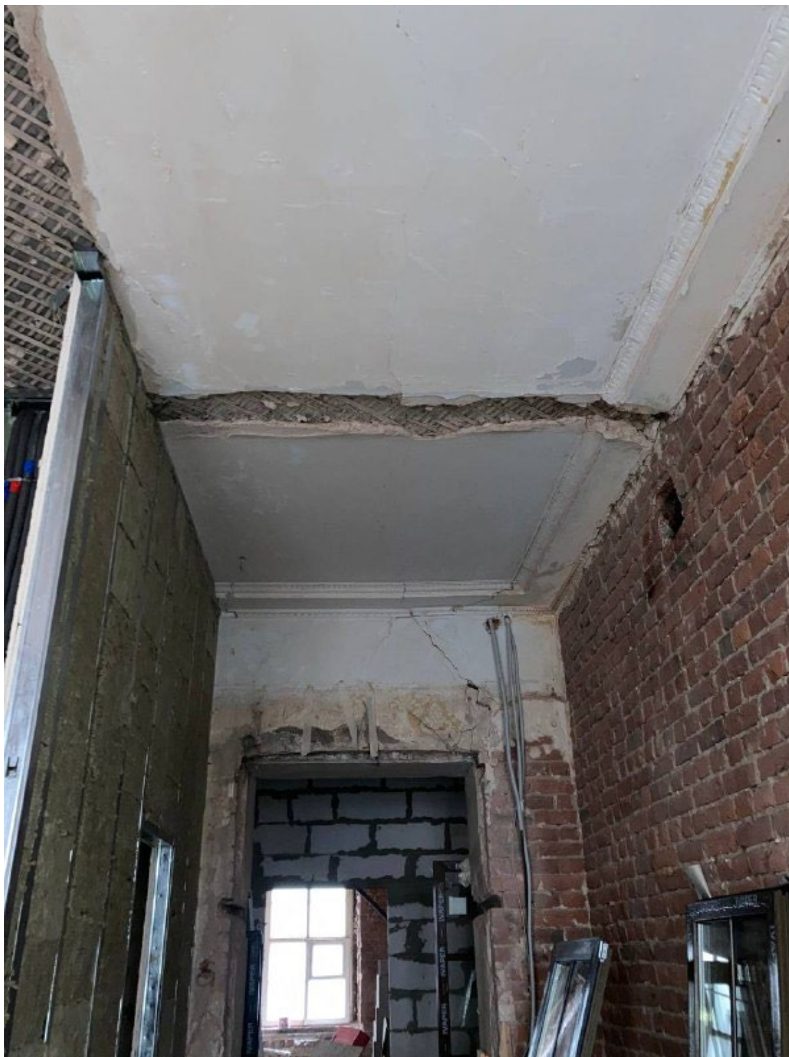
Фото 13. Помещение 2. Выход из помещения.
