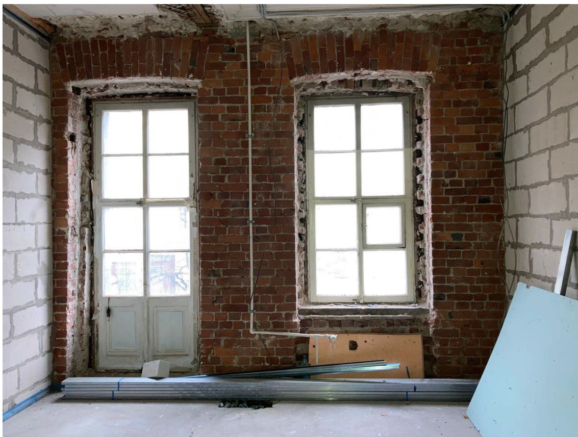
Фото 15. Помещение 3. Вид на стену с окнами.
