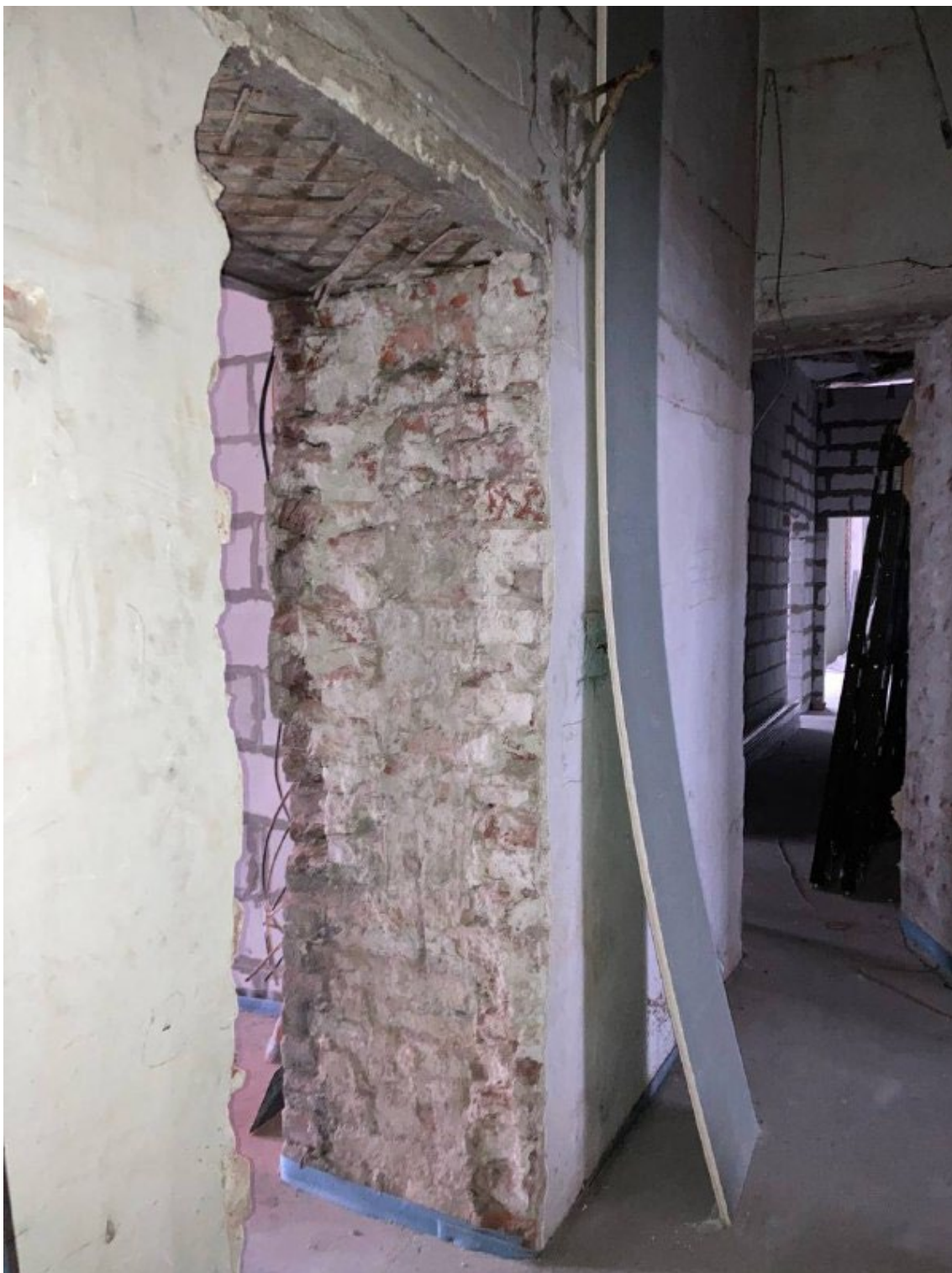
Фото 5. Несущая стена. Пром в помещение 3
