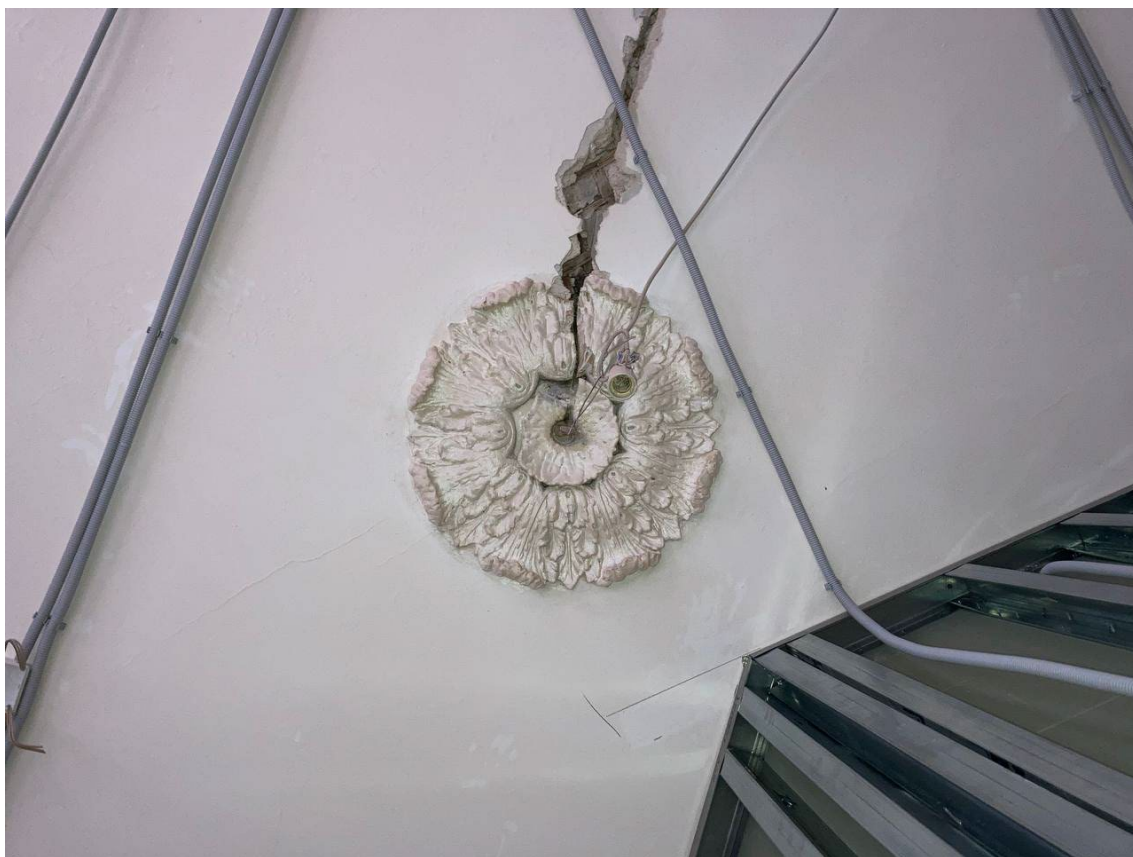
Фото 34. Помещение 7. Потолочная розетка.
