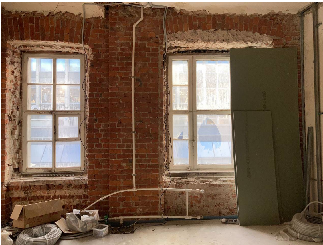
Фото 32. Помещение 7. Вид на стену с окнами.
