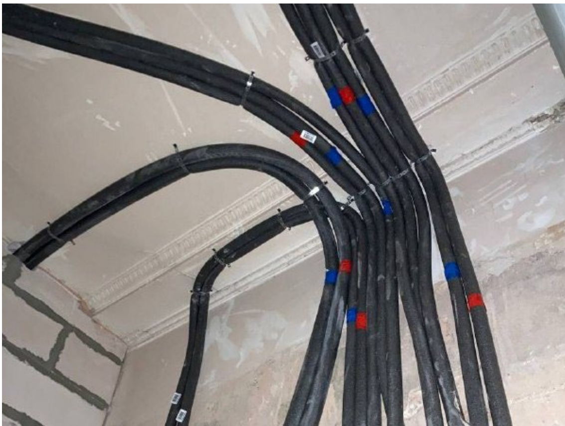
Фото 14. Помещение 2. Фрагмент потолка вспомогательного помещения.
