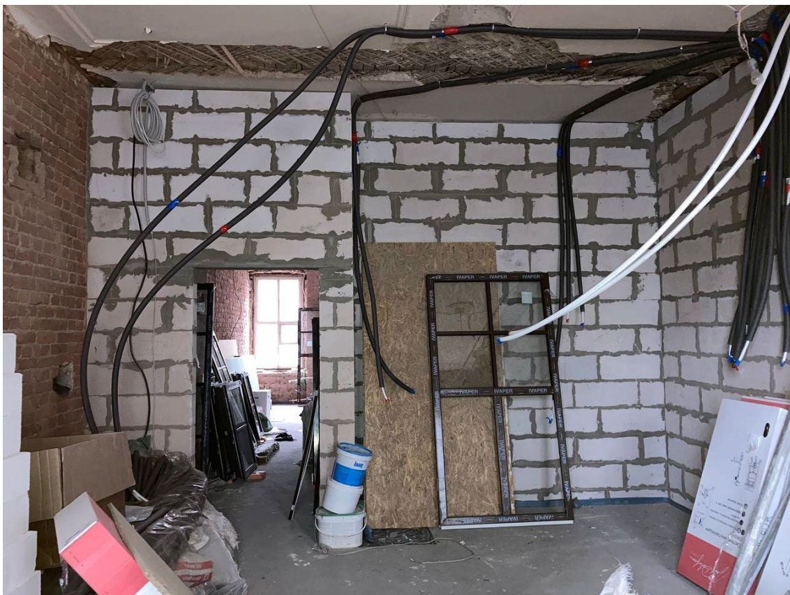
Фото 9. Помещение 1. Вид на вход в помещение.
