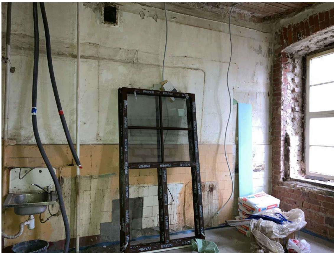
Фото 21. Помещение 4. Вид на несущую стену и фрагмент окна.
