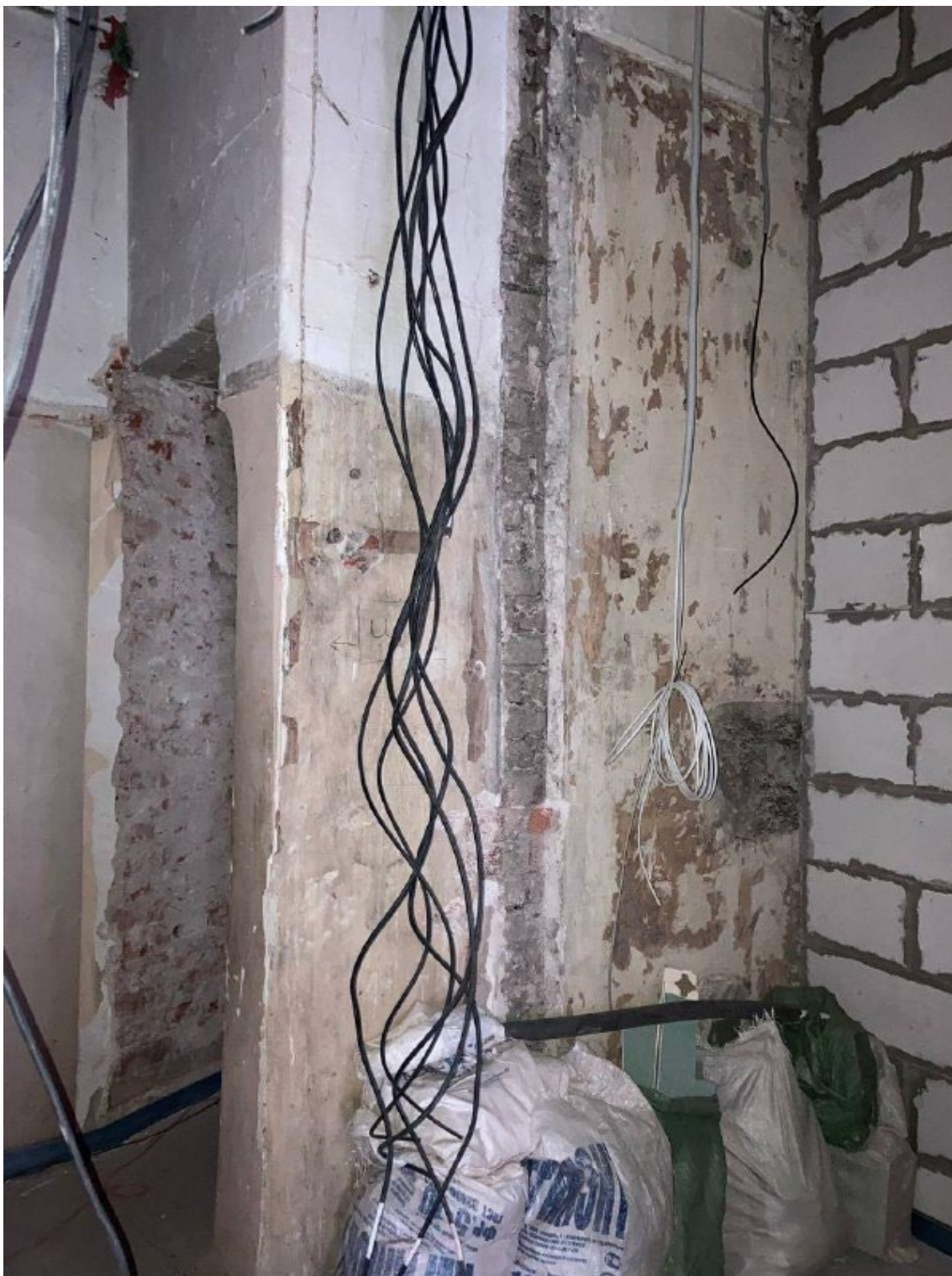
Фото 26. Вид из помещения 5 на несущие стены (коридор).
