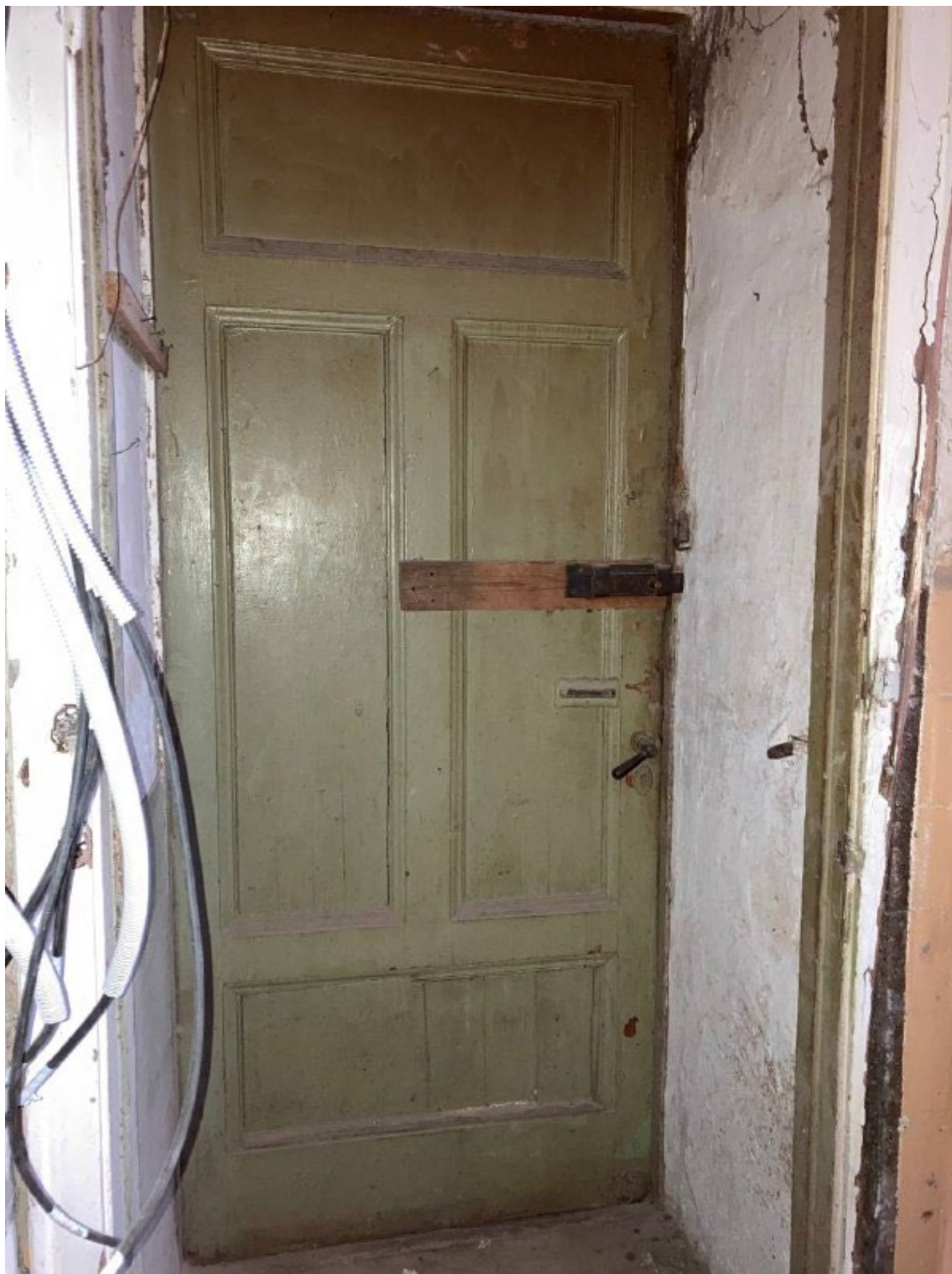
Фото 22. Помещение 4. Дверь на черную лестницу.
