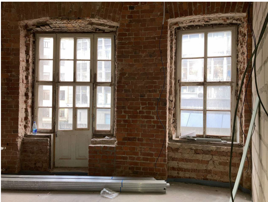
Фото 27. Помещение 6. Вид на стену с окнами.
