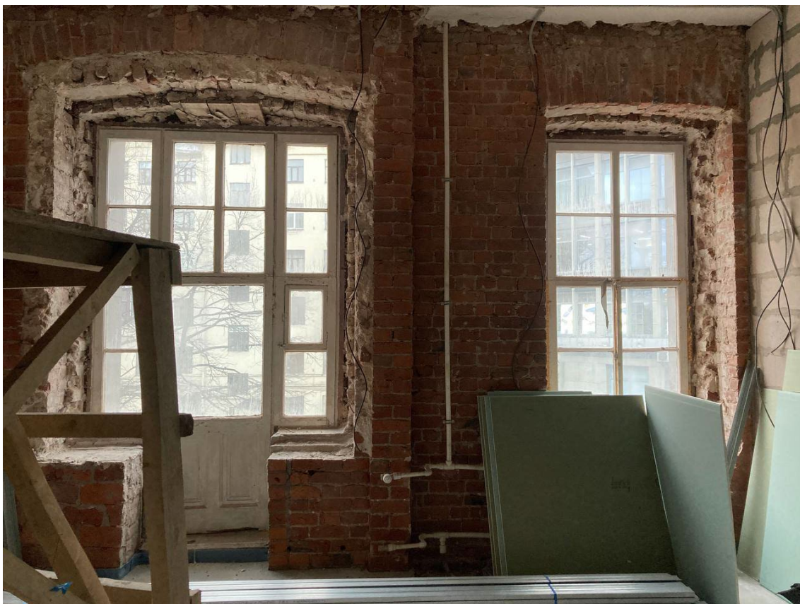
Фото 24. Помещение 5. Вид на стену с окнами.
