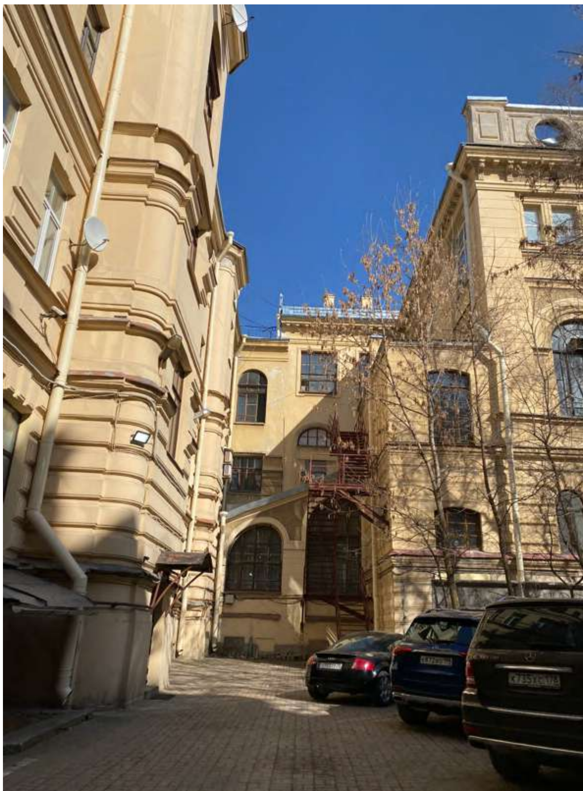
10. Фрагмент дворового фасада
