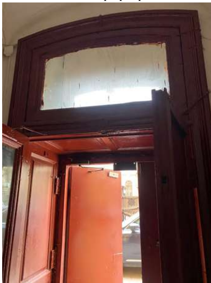
30. Тамбур лестницы 12ЛК
