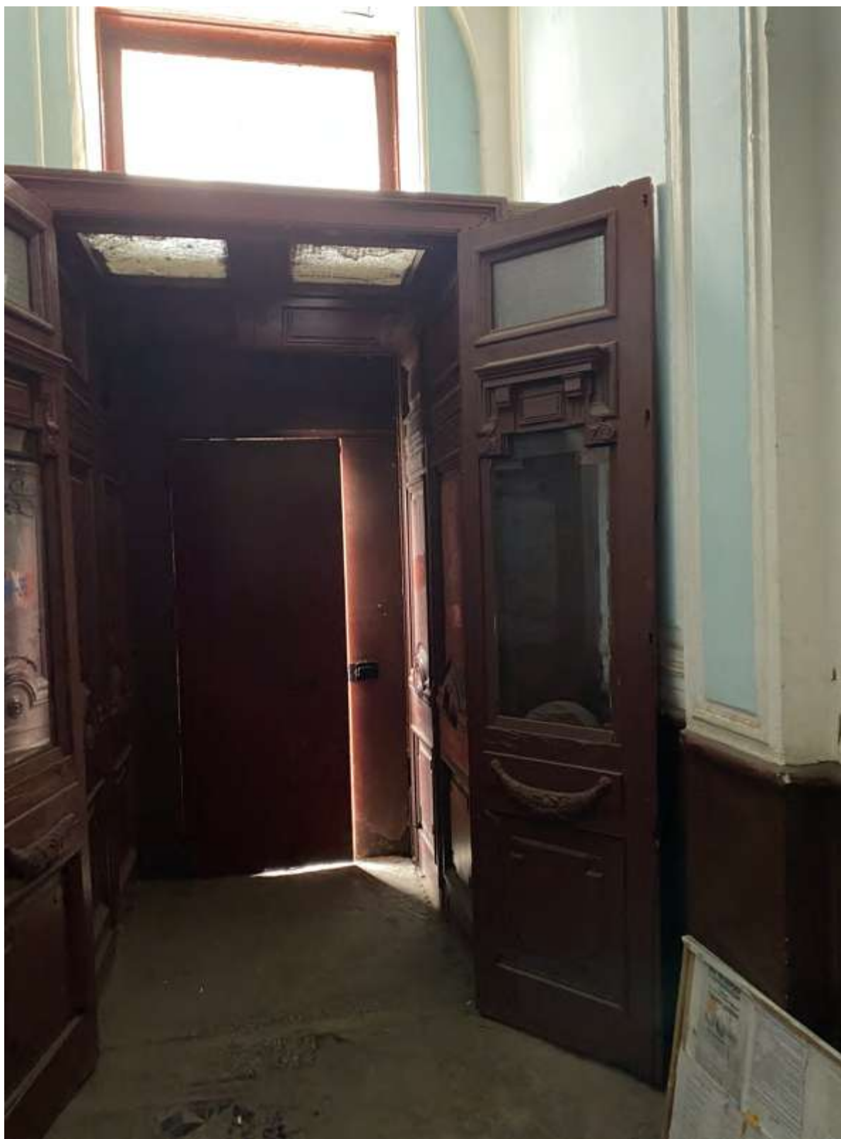
17. Тамбур лестницы 1 ЛК
