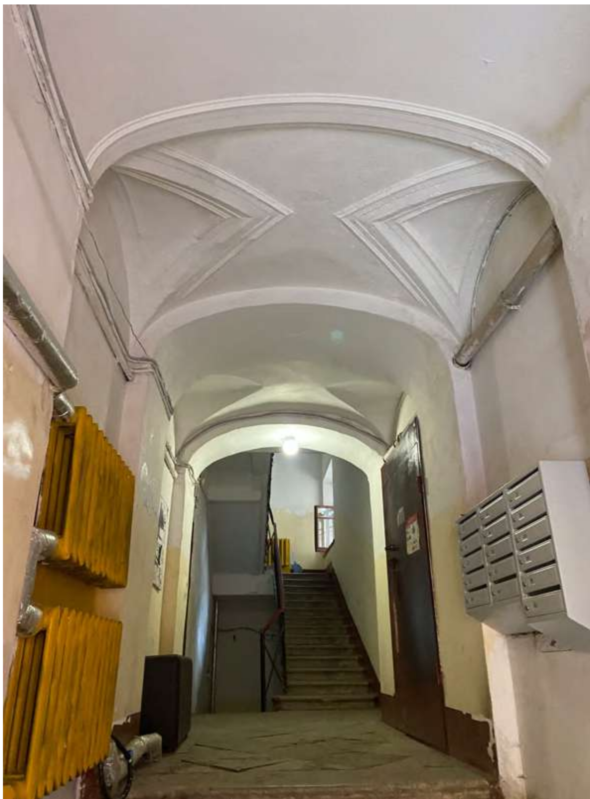
22. Вестибюль лестницы 11ЛК
