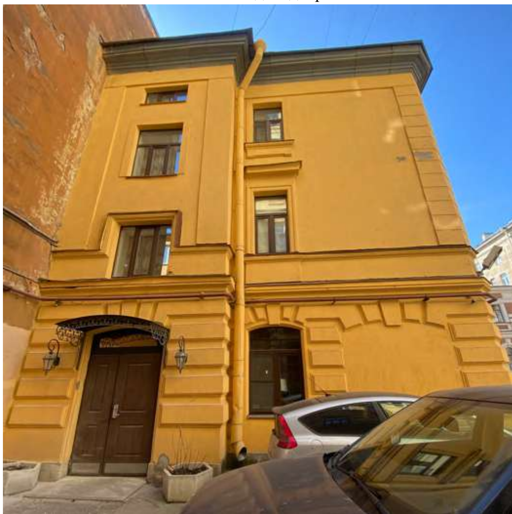
6. Торцевой фасад флигеля
