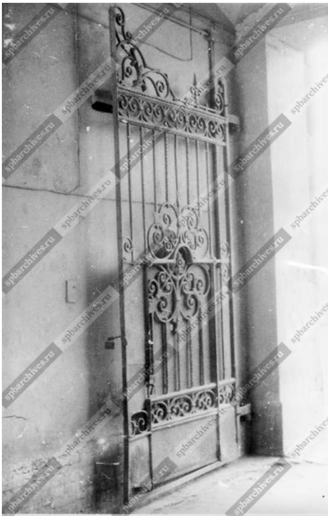
129. Вид решетки створки ворот жилого дома № 48/27 по Среднему проспекту Васильевского острова ( бывший дом В.Н.фон Дервиз, архитектор А.Ф.Красовский, 1891-1892 гг., 1897- 1898 гг.). 1999 г. ЦГАКФФД СПб Ар 225912
