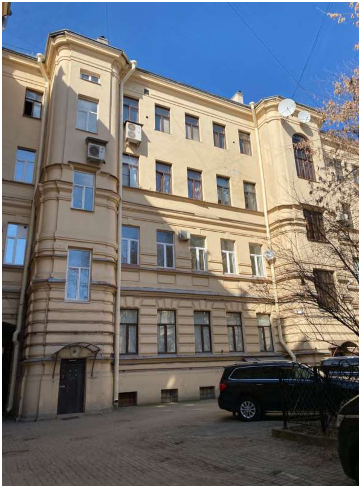
11. Фрагмент дворового фасада
