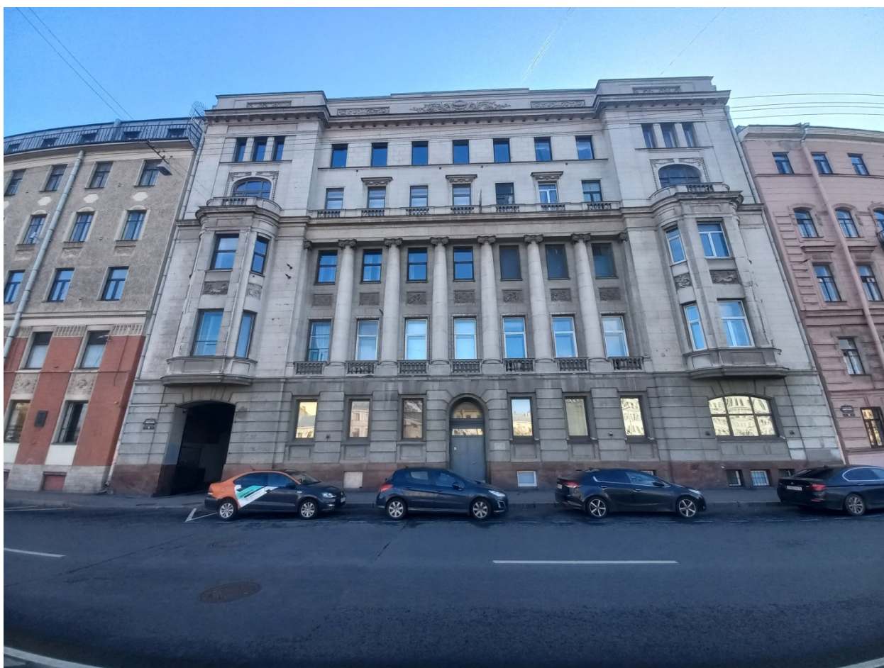
Фото 1. Главный фасад Здания. Вид с набережной р. Фонтанки.
