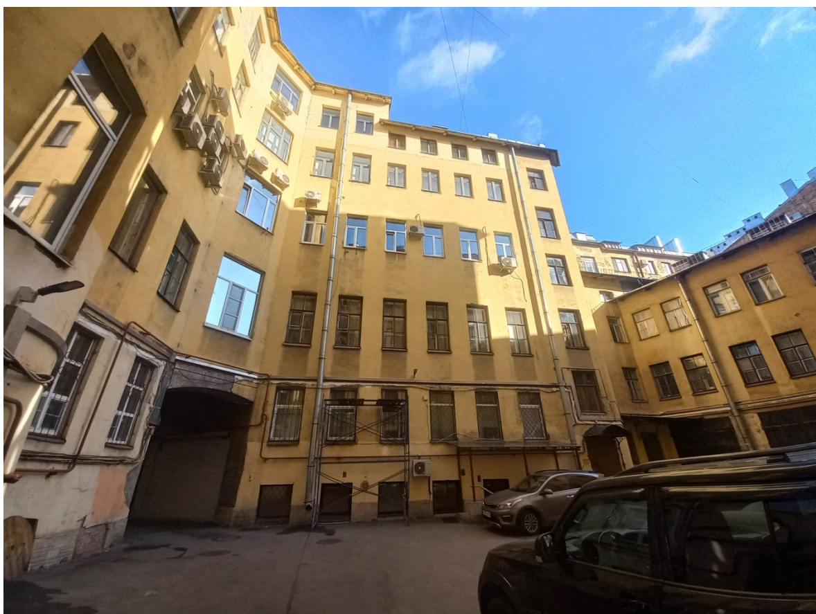
Фото 3. Дворовый фасад. Северный флигель.
