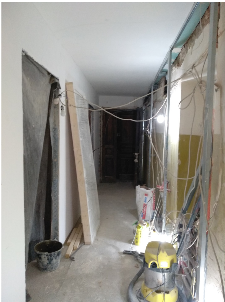
Фото 6. Коридор. Вид на входную дверь.
