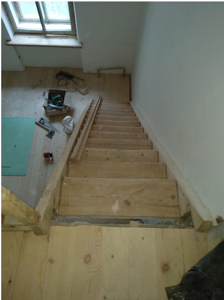
Фото 13. Кухня-столовая (помещение №4 по проектной экспликацией). Лестница.
